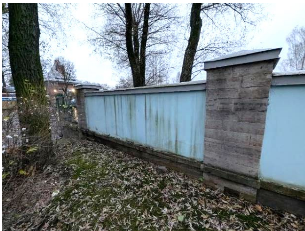
16. Ограждение вдоль северо-западной границы земельного участка, кадастровый номер 78:07:0323601:1, с внутренней стороны. 08.04.2025
