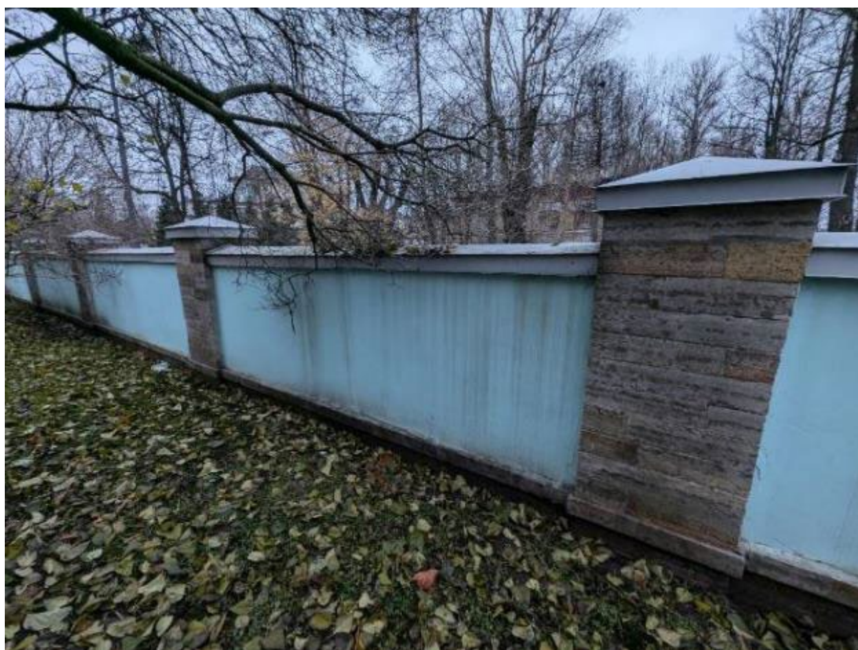
13. Ограждение вдоль северо-восточной границы территории объекта культурного наследия регионального значения «Парк «Тихий отдых». Дом Вургафта с участком парка» с внутренней стороны. 08.04.2025
