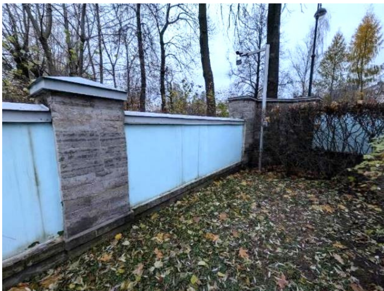
15. Ограждение вдоль северо-западной границы земельного участка, кадастровый номер 78:07:0323601:1, с внутренней стороны. 08.04.2025
