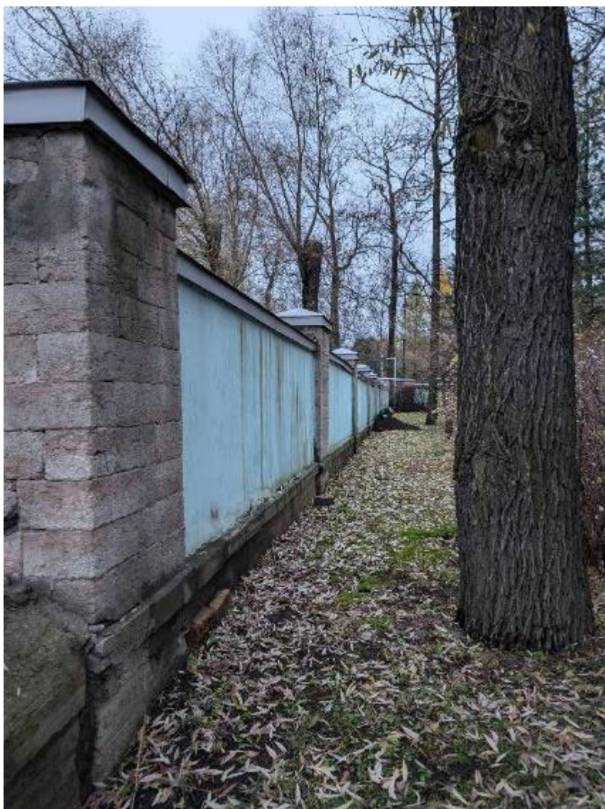
17. Ограждение вдоль северо-западной границы земельного участка, кадастровый номер 78:07:0323601:1, с внутренней стороны. 08.04.2025
