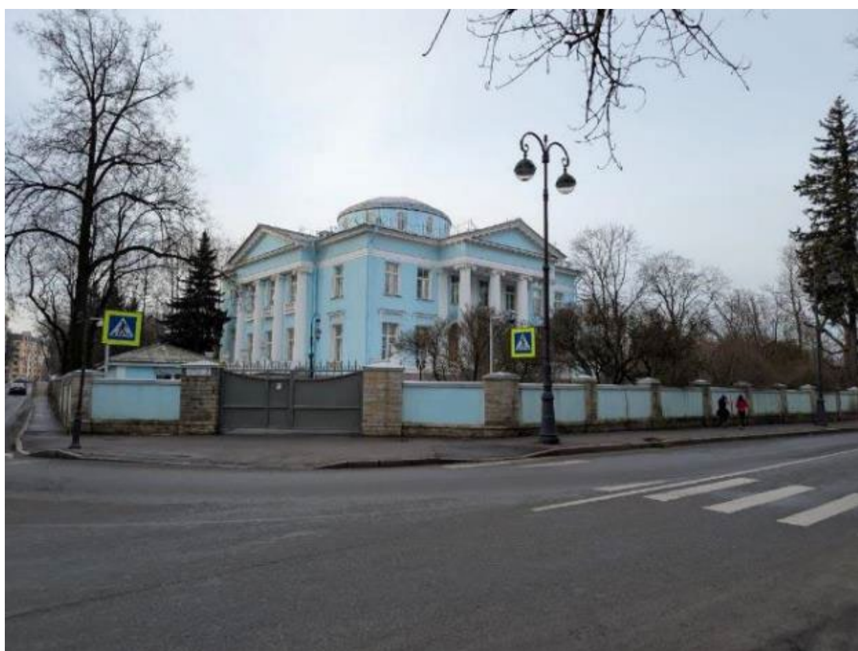
1. Северо-западный и северо-восточный фасады объекта культурного наследия регионального значения «Парк «Тихий отдых». Дом Вургафта с участком парка», расположенного по адресу: г. Санкт-Петербург, набережная р. Крестовки, дом 2, литера А. Ограждение территории. 08.04.2025
