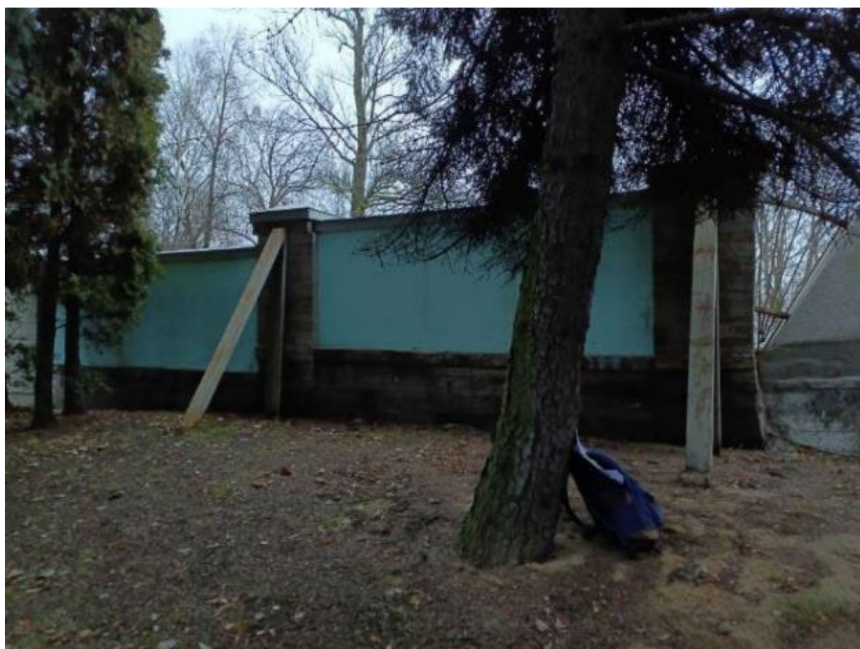
10. Ограждение вдоль юго-восточной границы территории объекта культурного наследия регионального значения «Парк «Тихий отдых». Дом Вургафта с участком парка» с внутренней стороны. 08.04.2025
