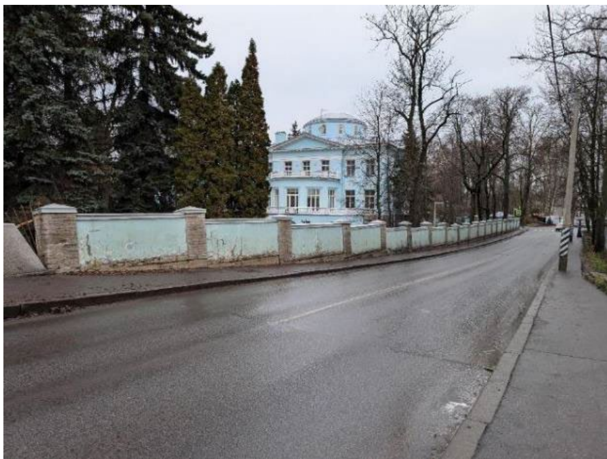
8. Ограждение вдоль юго-восточной границы территории объекта культурного наследия регионального значения «Парк «Тихий отдых». Дом Вургафта с участком парка». 08.04.2025
