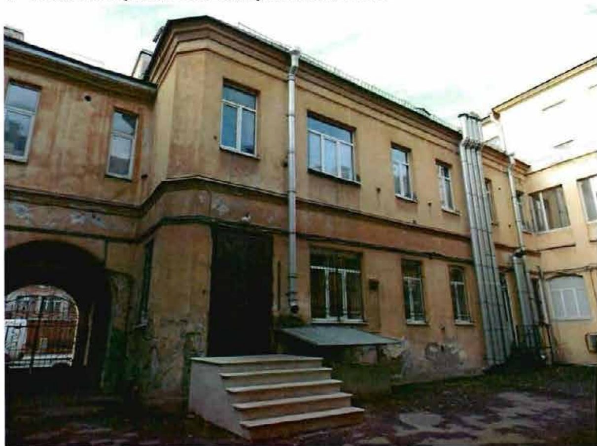
4. Западный дворовый фасад
