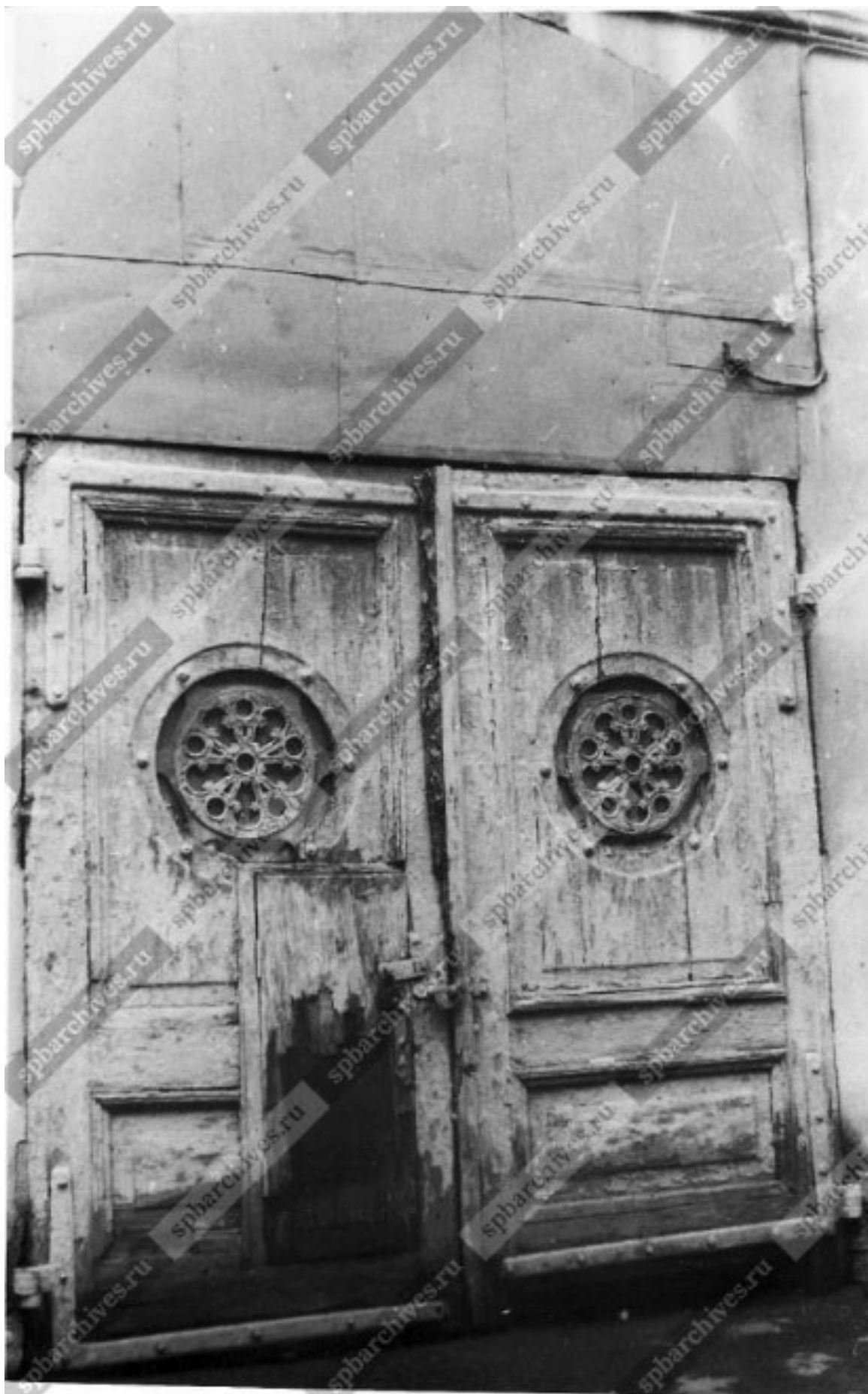
16. Вид створок ворот, вытесанных из дерева в арочном проезде дома № 11 на улице Миллионной. Фото 2001 г.
