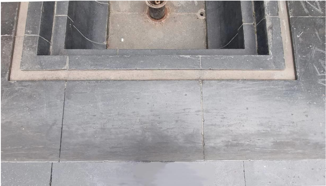
Фото 14. Царапины полированной поверхности.
