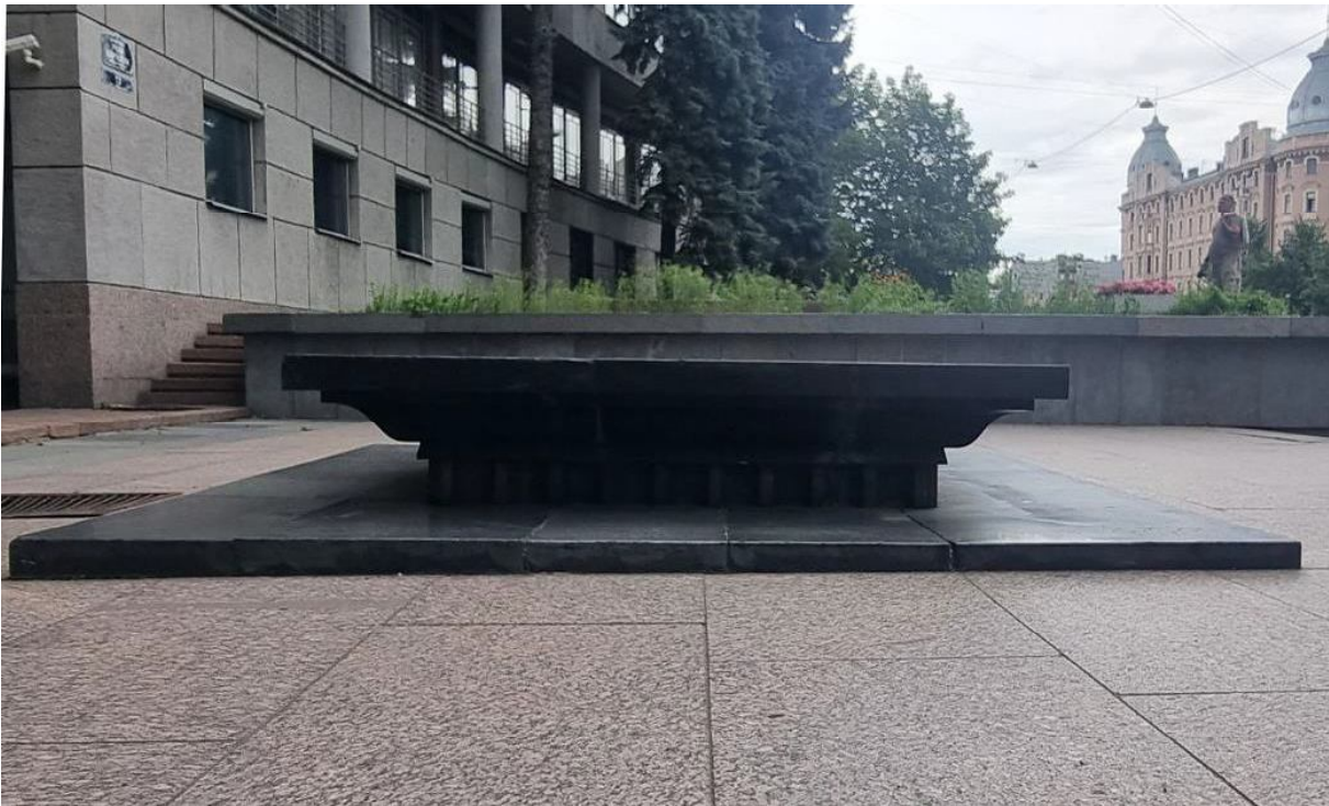
Фото 4. Чаша фонтана. Общий вид с западной стороны.
