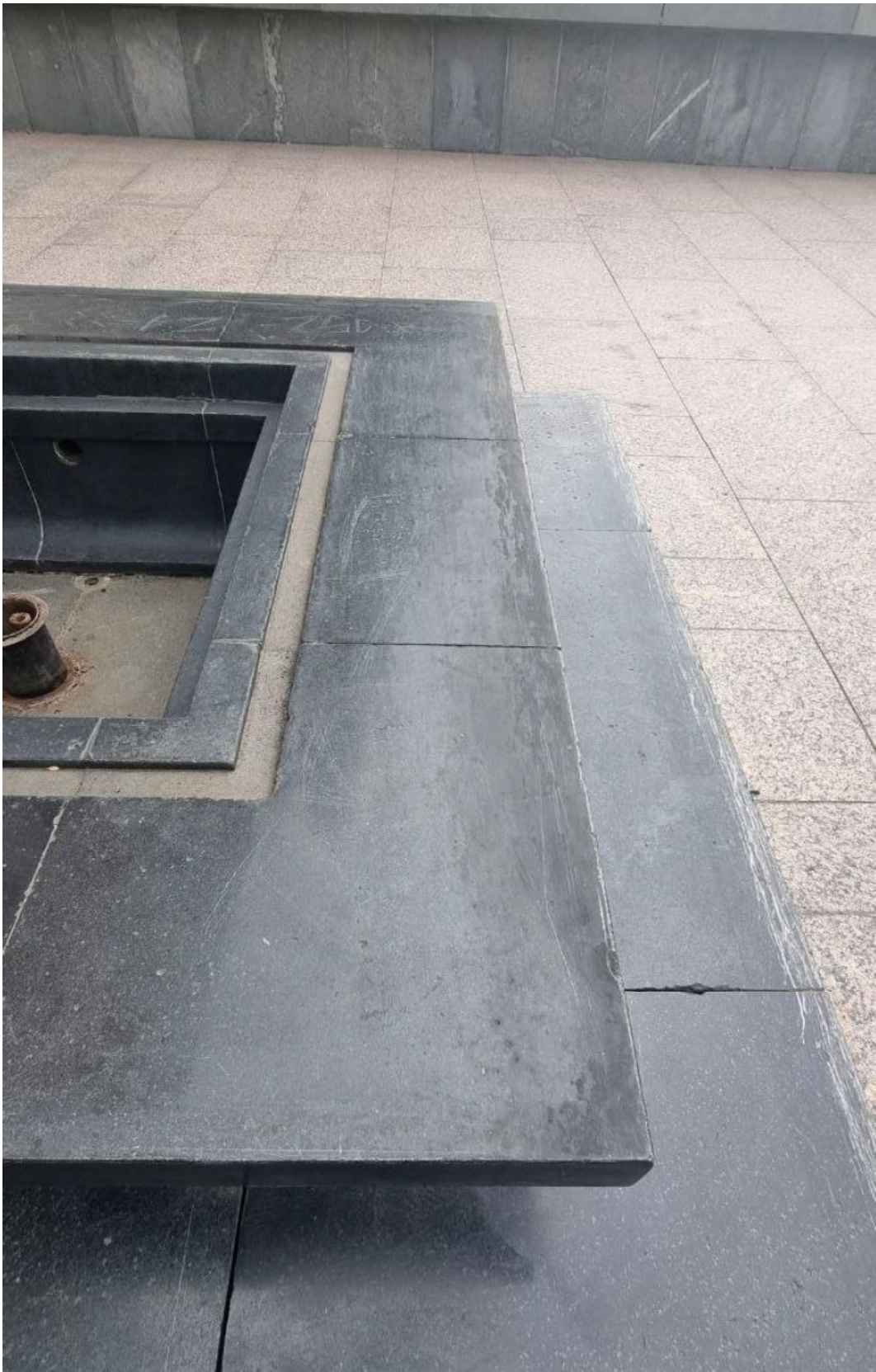
Фото 13. Царапины полированной поверхности, места утрат шовного заполнителя.
