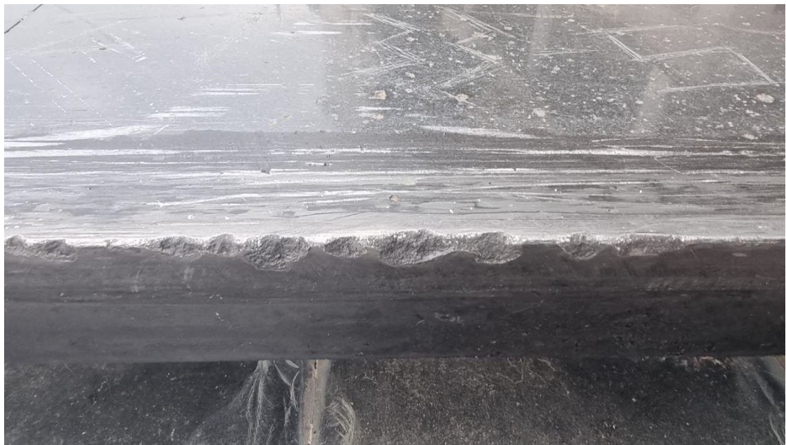
Фото 18. Царапины полированной поверхности, сколы и выбоины.
