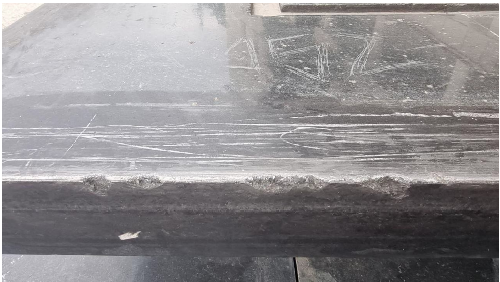
Фото 23. Царапины полированной поверхности, сколы и выбоины.
