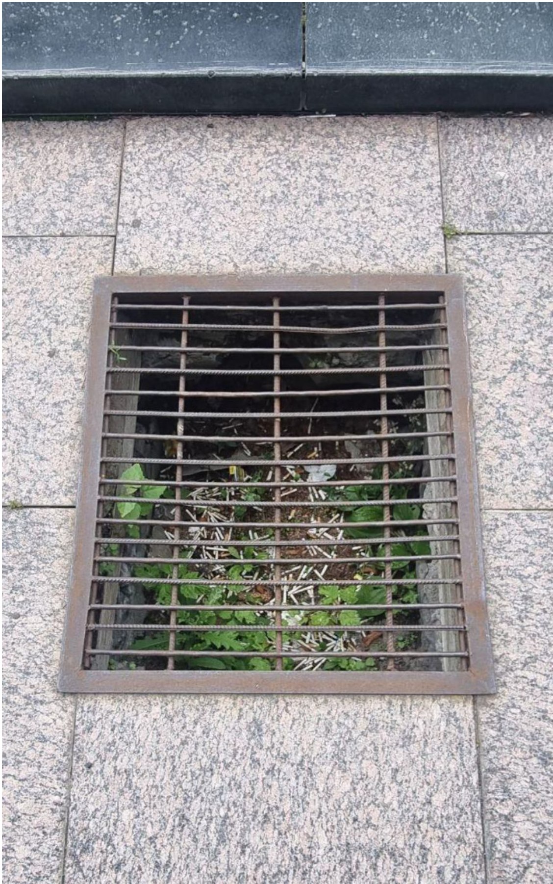
Фото 35. Смотровой приямок накрытый металлической решеткой. Общий вид.
