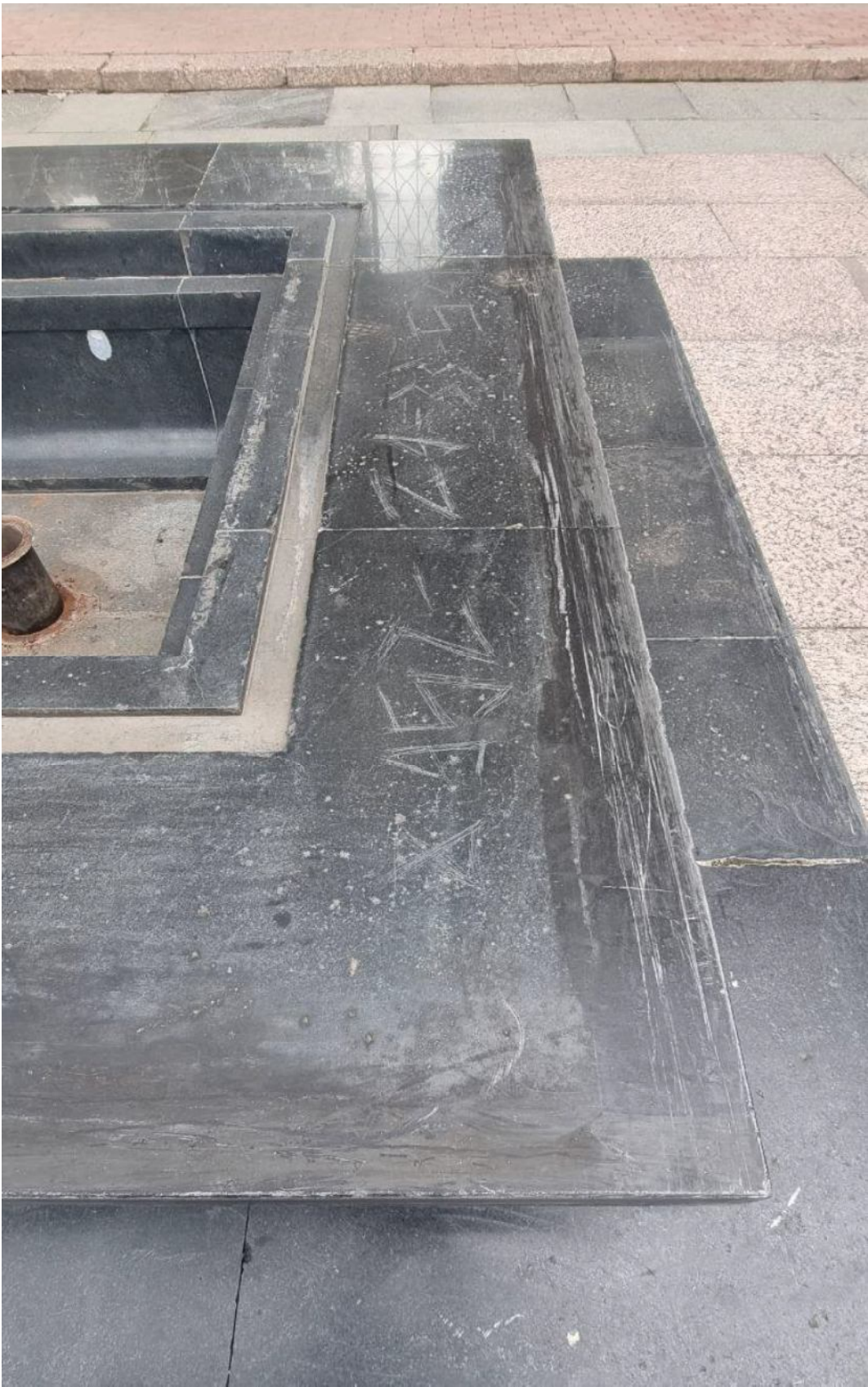
Фото 9. Царапины полированной поверхности.
