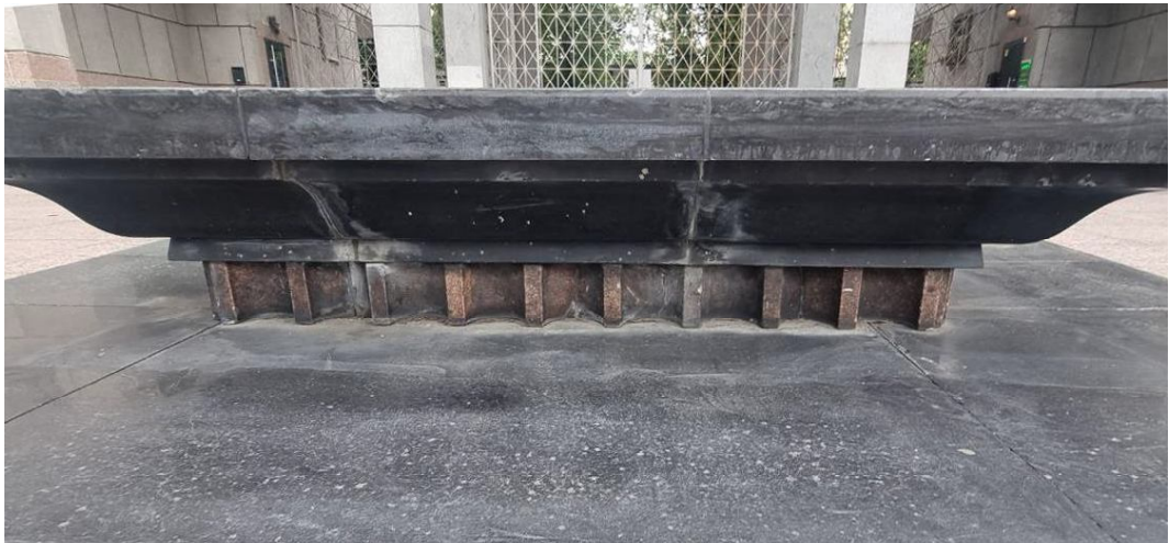
Фото 28. Биопоражения, места утрат шовного заполнителя.
