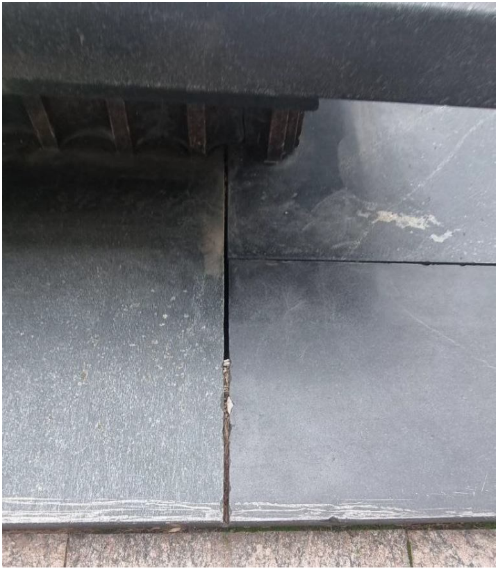
Фото 24. Царапины полированной поверхности, места утрат шовного заполнителя.
