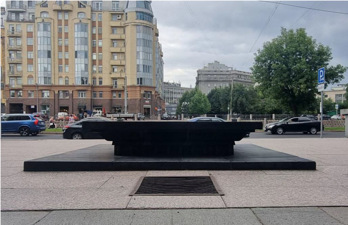
Фото 5. Чаша фонтана. Общий вид с северной стороны.
