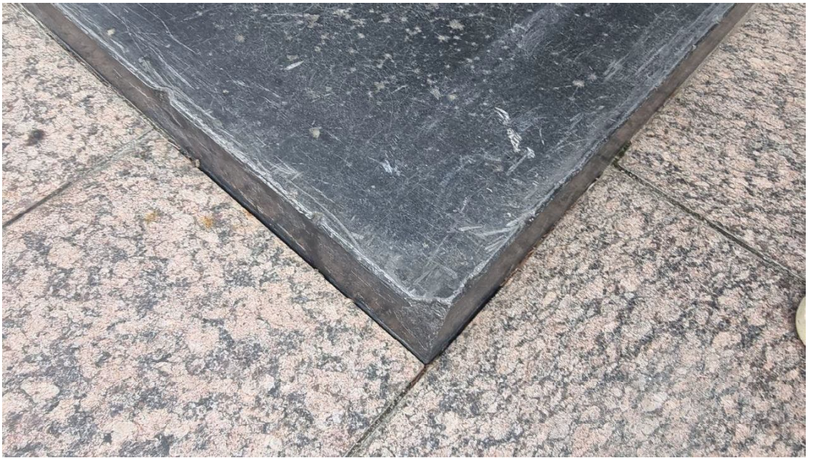
Фото 20. Царапины полированной поверхности.
