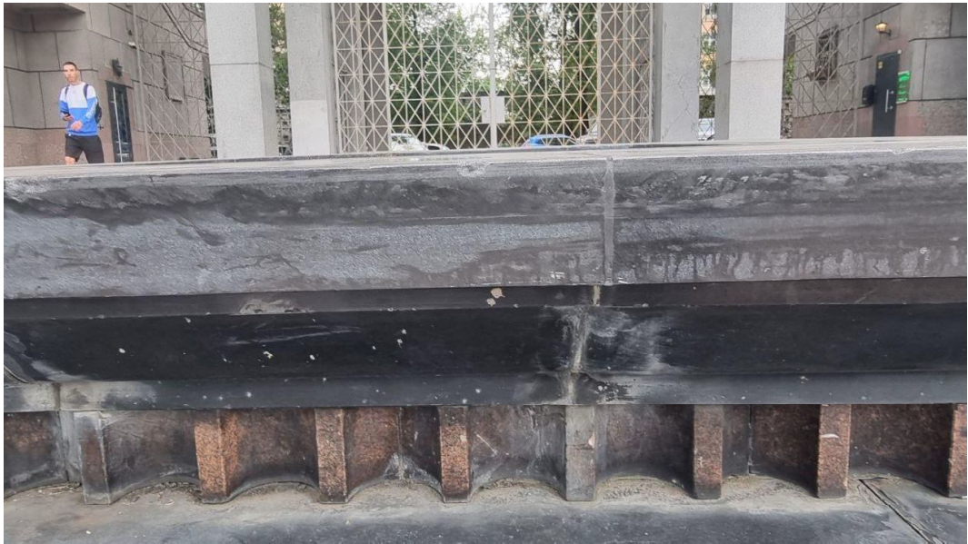
Фото 28. Биопоражения, места утрат шовного заполнителя.
