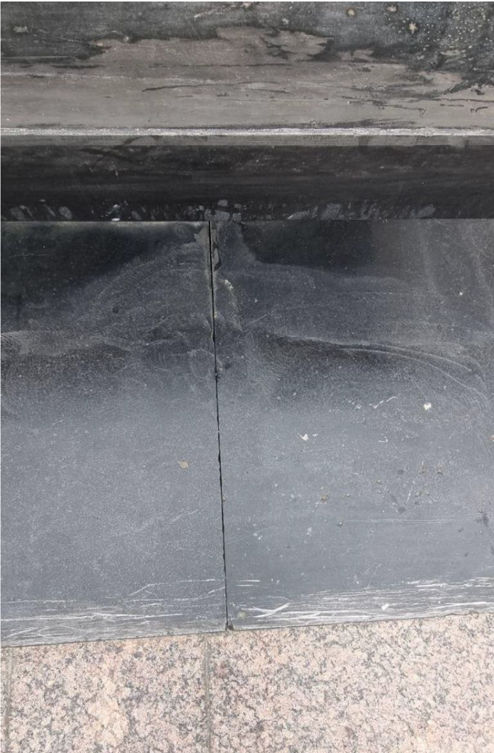
Фото 22. Царапины полированной поверхности.
