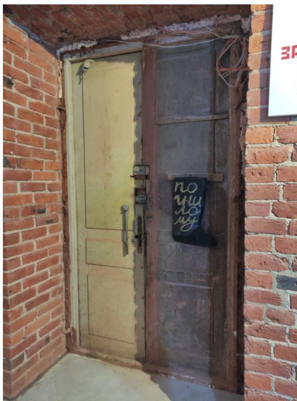
Фото 19. Интерьер квартиры №4, ч.п. 5, дверное заполнение
