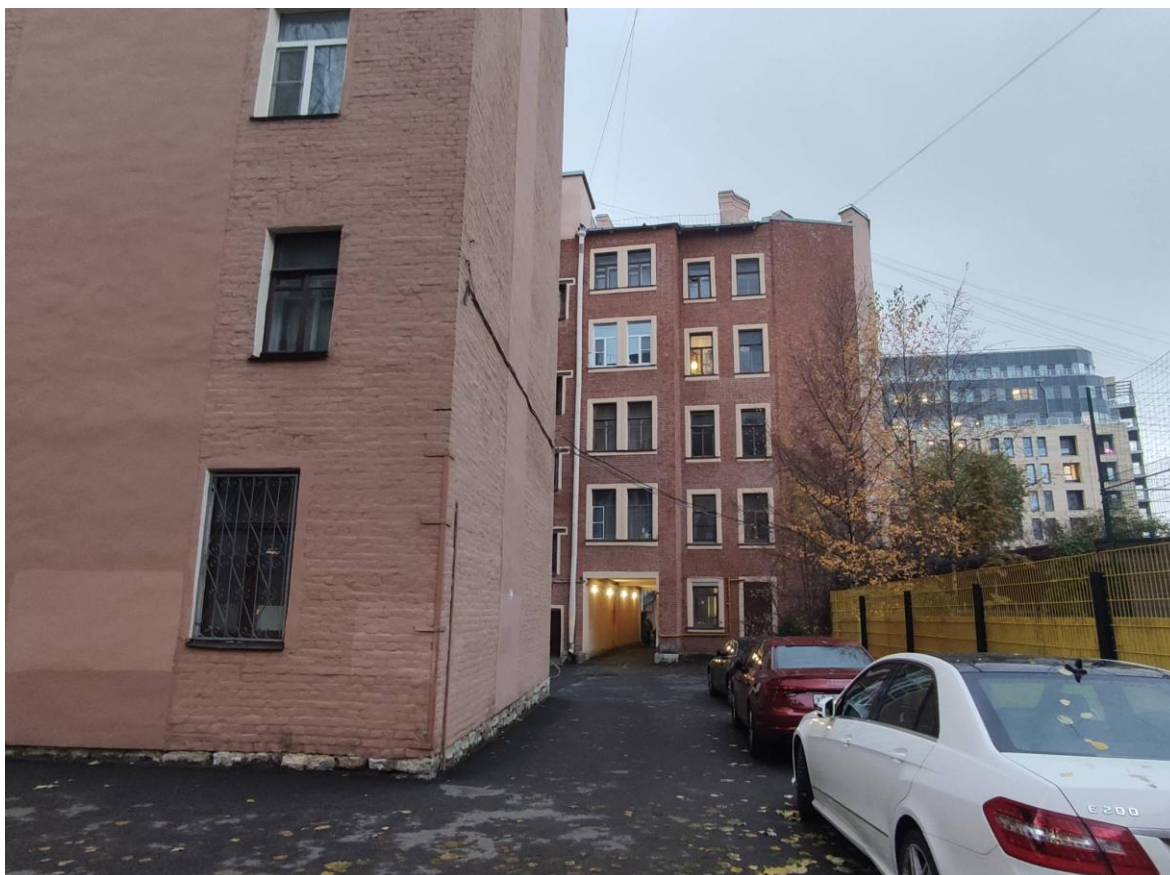
Фото 8. Фрагмент дворового фасада выявленного объекта культурного наследия «Дом В.Е. и Г.Е. Овчинниковых»
