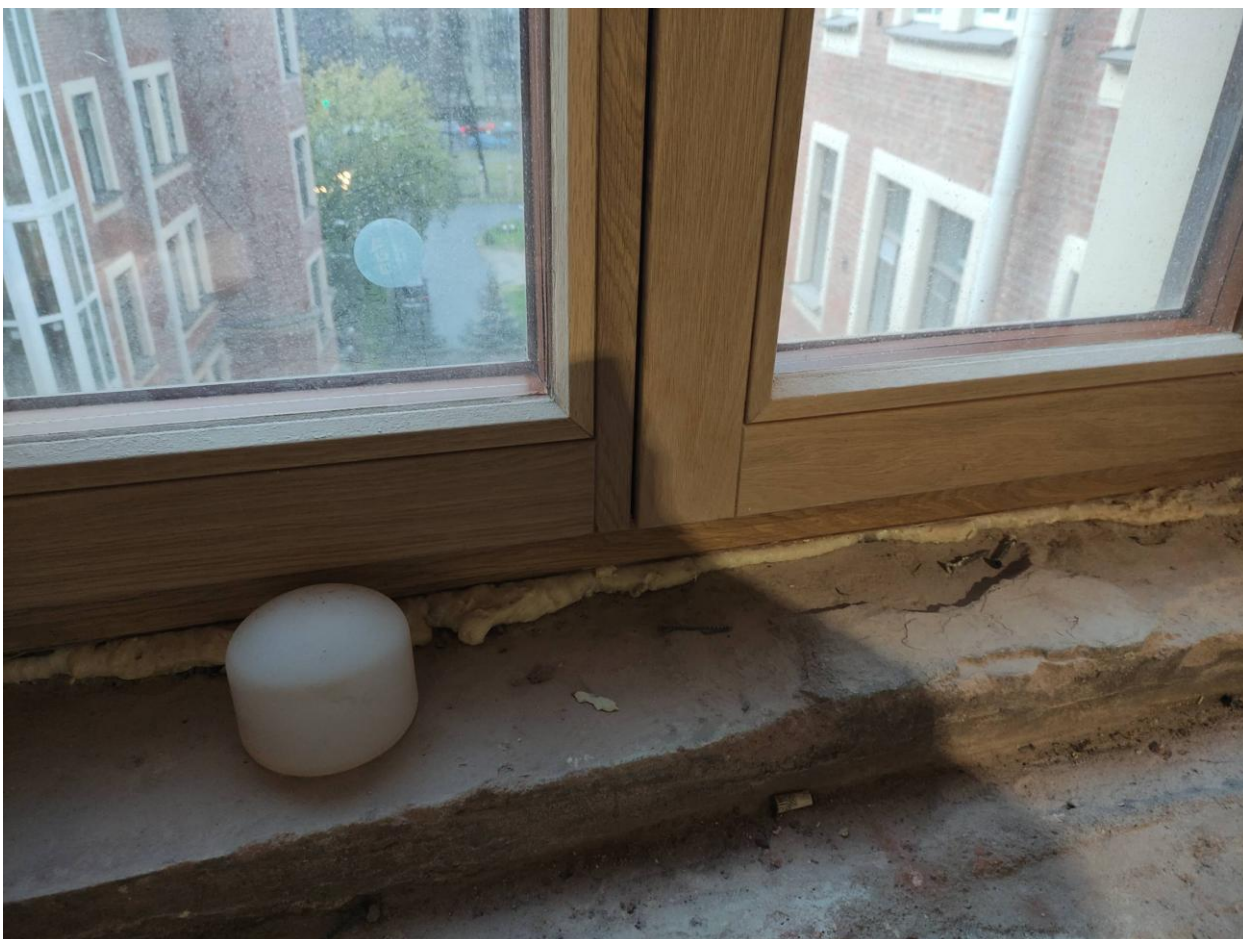
Фото 12. Интерьер квартиры №4, ч.п. 2, оконные заполнения
