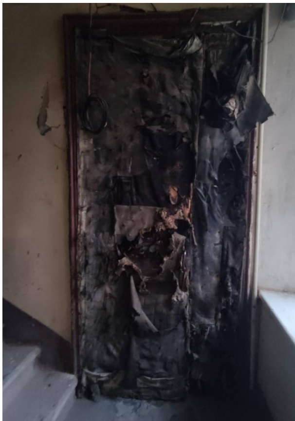
Фото 9. Входное дверное заполнение кв.№4
