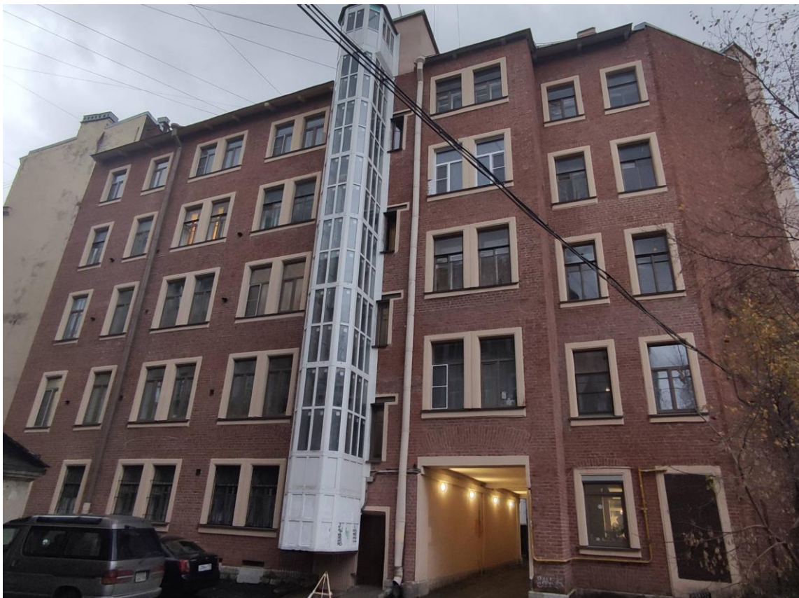
Фото 7. Фрагмент дворового фасада выявленного объекта культурного наследия «Дом В.Е. и Г.Е. Овчинниковых»
