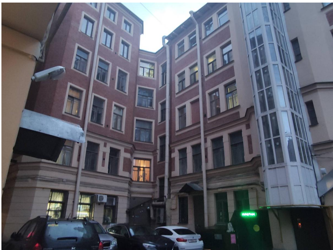
Фото 5. Фрагмент дворового фасада выявленного объекта культурного наследия «Дом В.Е. и Г.Е. Овчинниковых»
