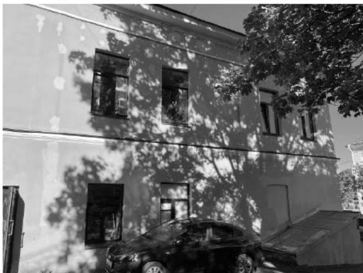
Фото 20. Юго-восточный дворовый фасад.
