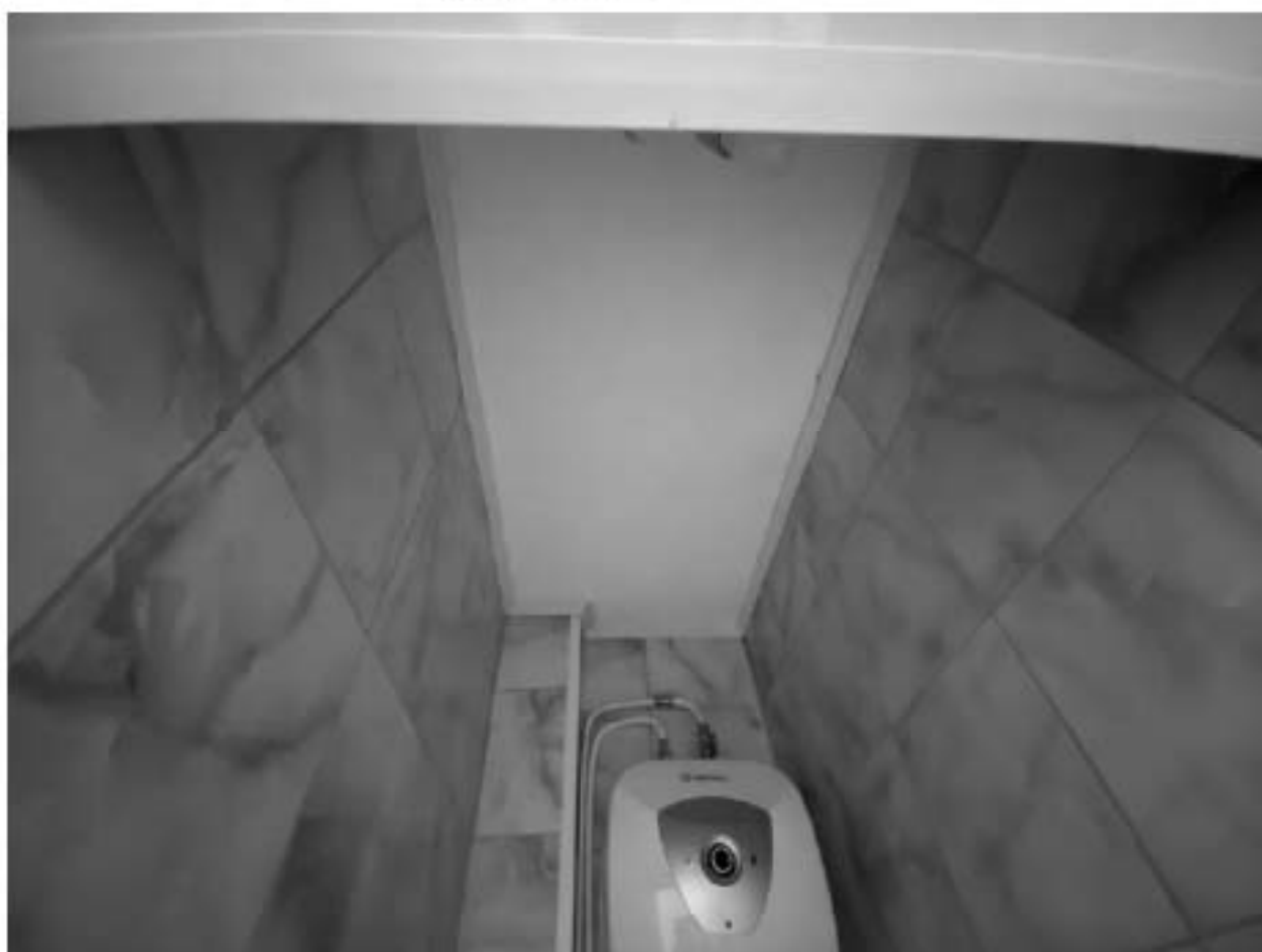
Фото 123. 2 этаж. Помещение 1-Н(29)
