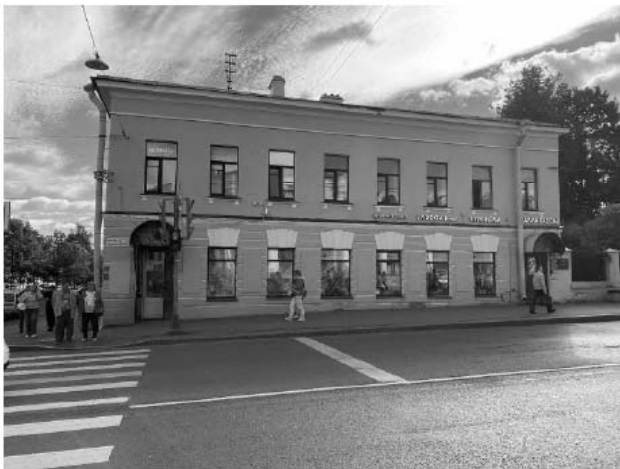
Фото 1. Северо-западный лицевой фасад здания со стороны Оранжерейной улицы
