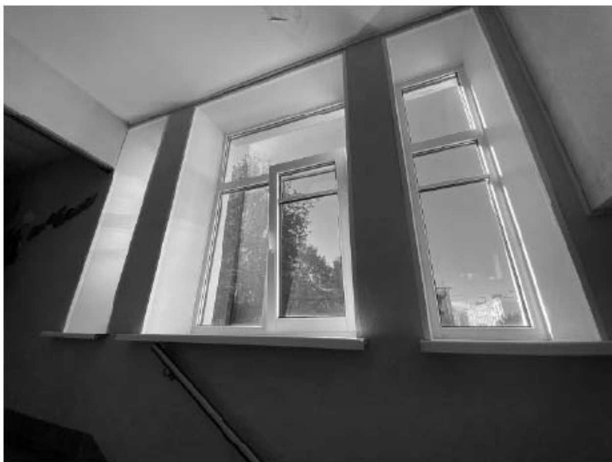
Фото 105. Лестница 2 этаж, окна юго-западной части фасада
