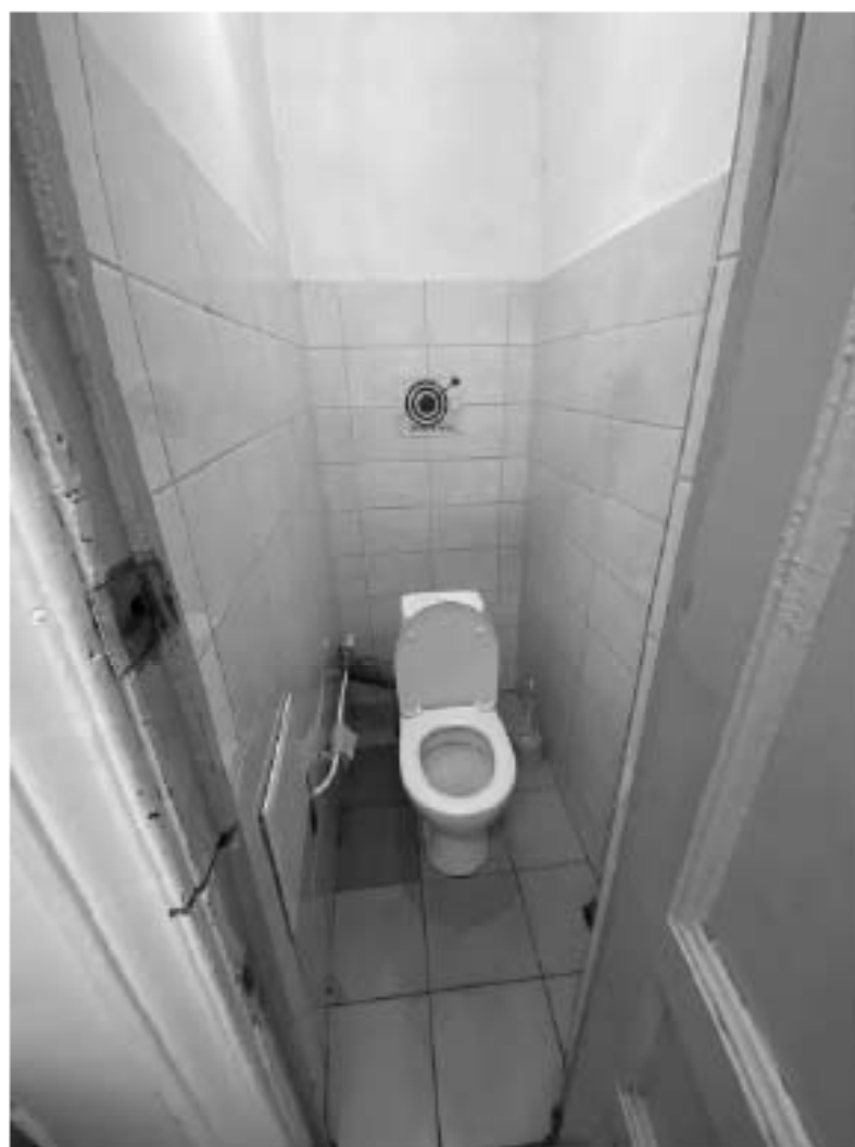
Фото 81. 1 этаж. Помещение 1-Н(12)
