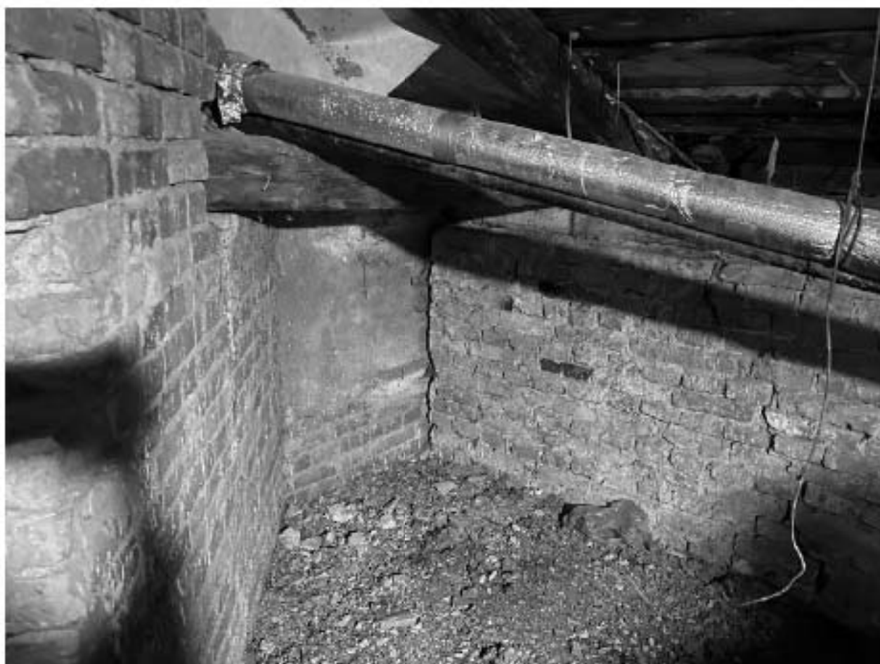
Фото 196. Чердак. Угловое примыкание дощатых стропил и перекрытия к стене. Узел. Примыкание водопроводной трубы к стене.
