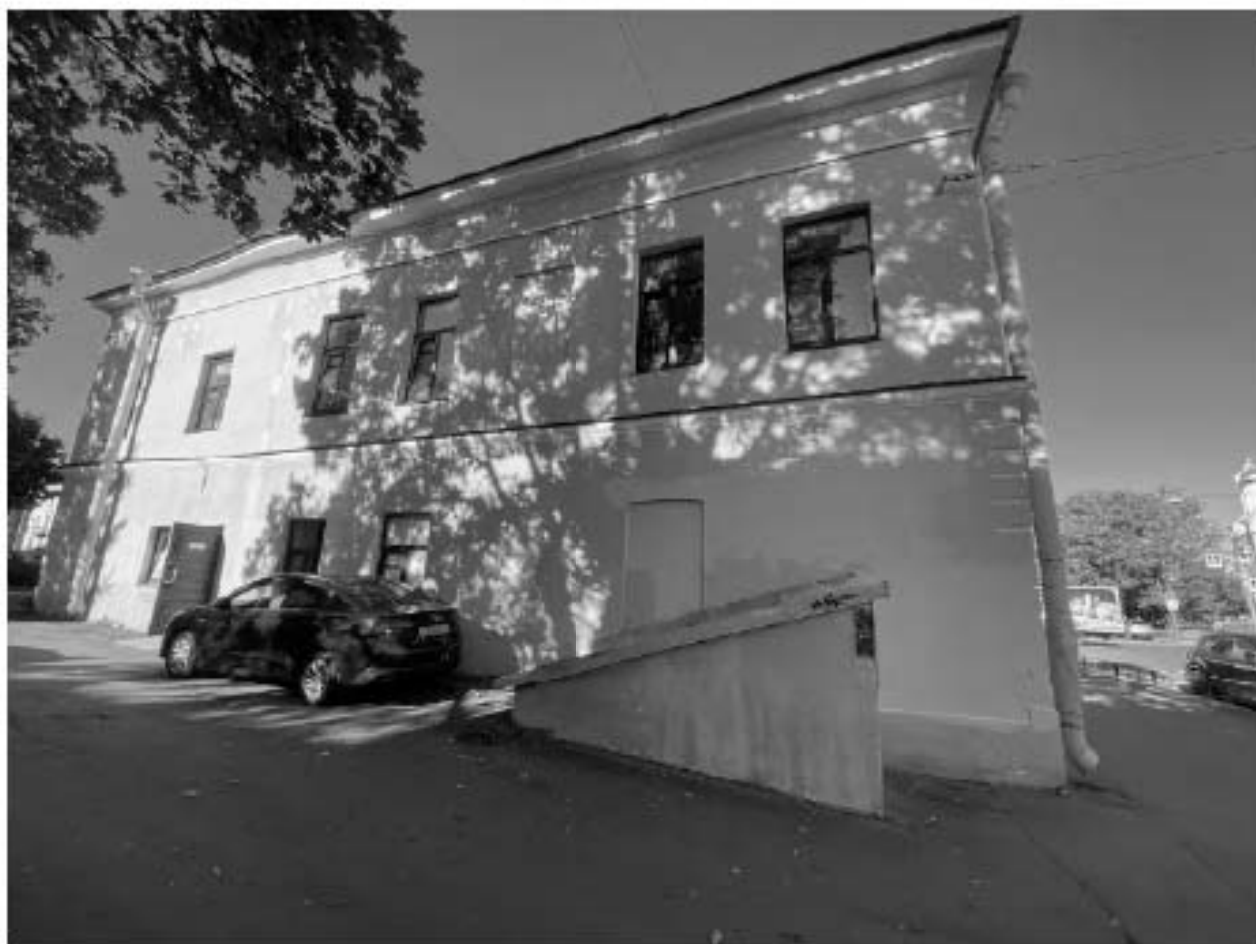
Фото 22. Юго-восточная часть тыльного фасада.
