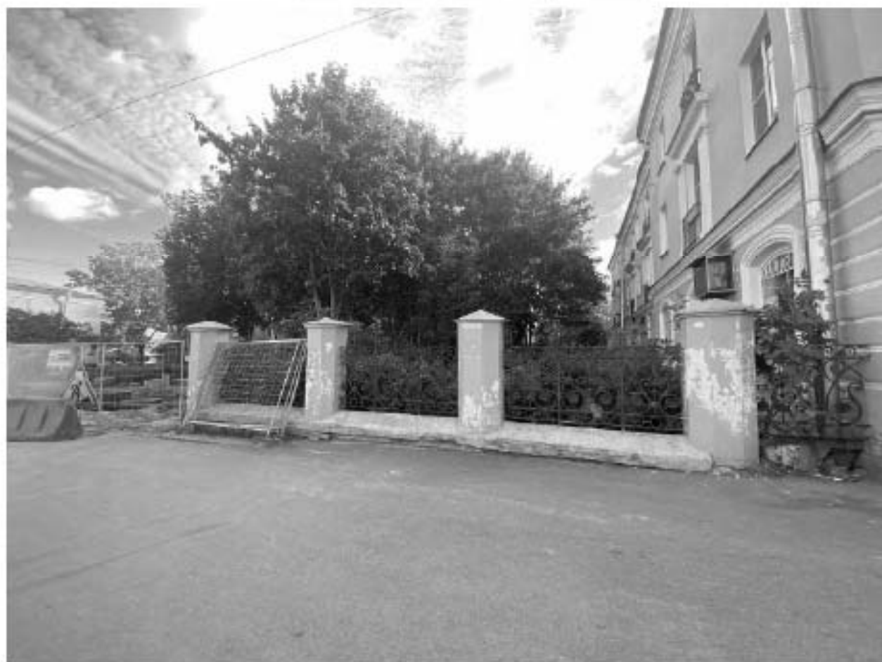
Фото 34. Часть садового ограждения со стороны Оранжерейной улицы
