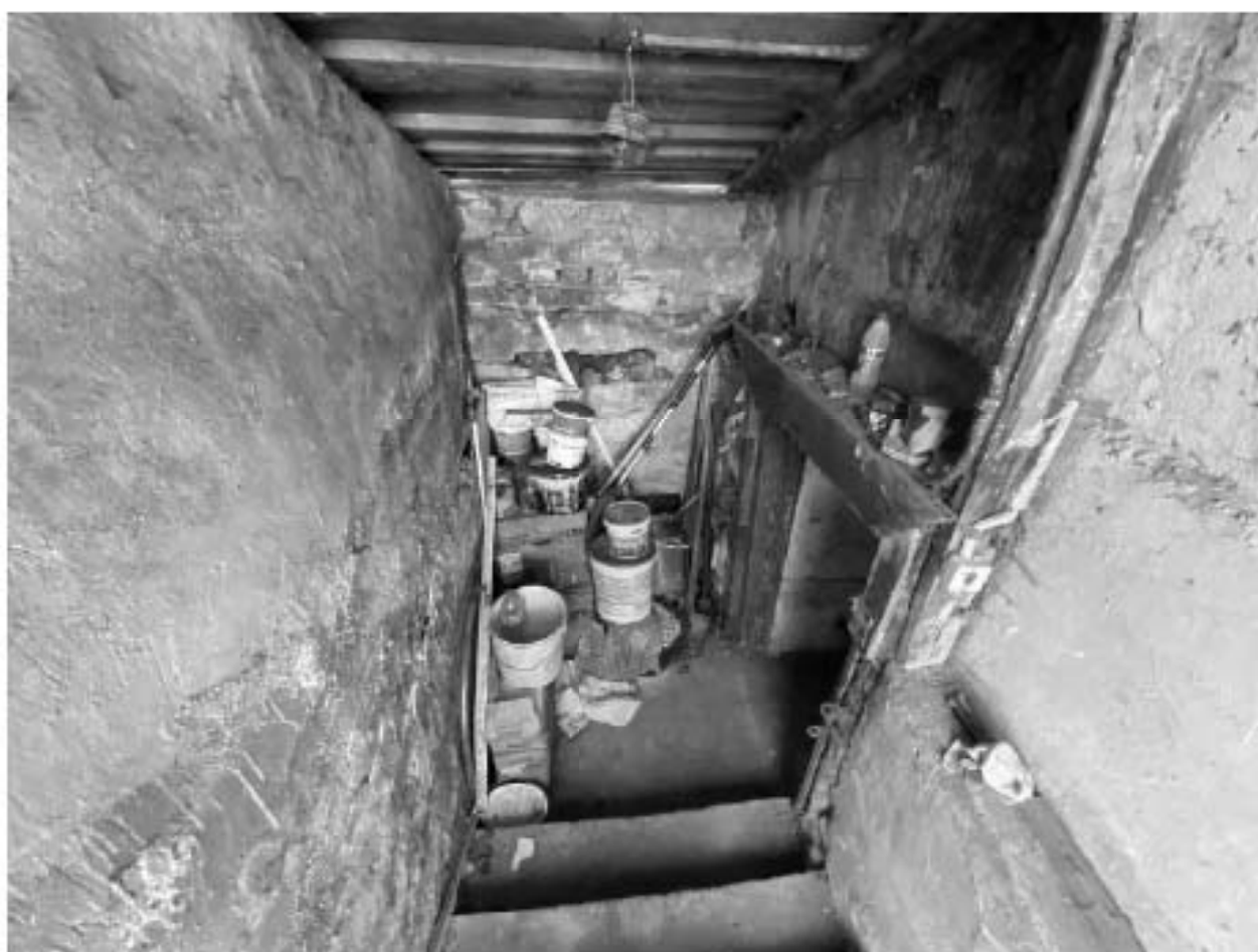
Фото 180. Лестница в подвал со стороны юго-восточного фасада
