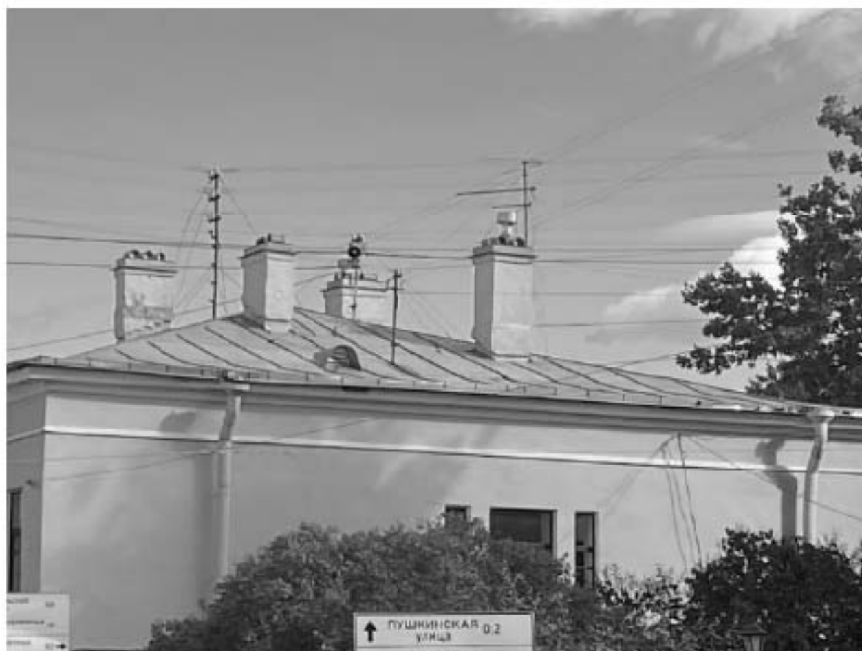
Фото 3. Крыша со стороны Оранжерейной улицы
