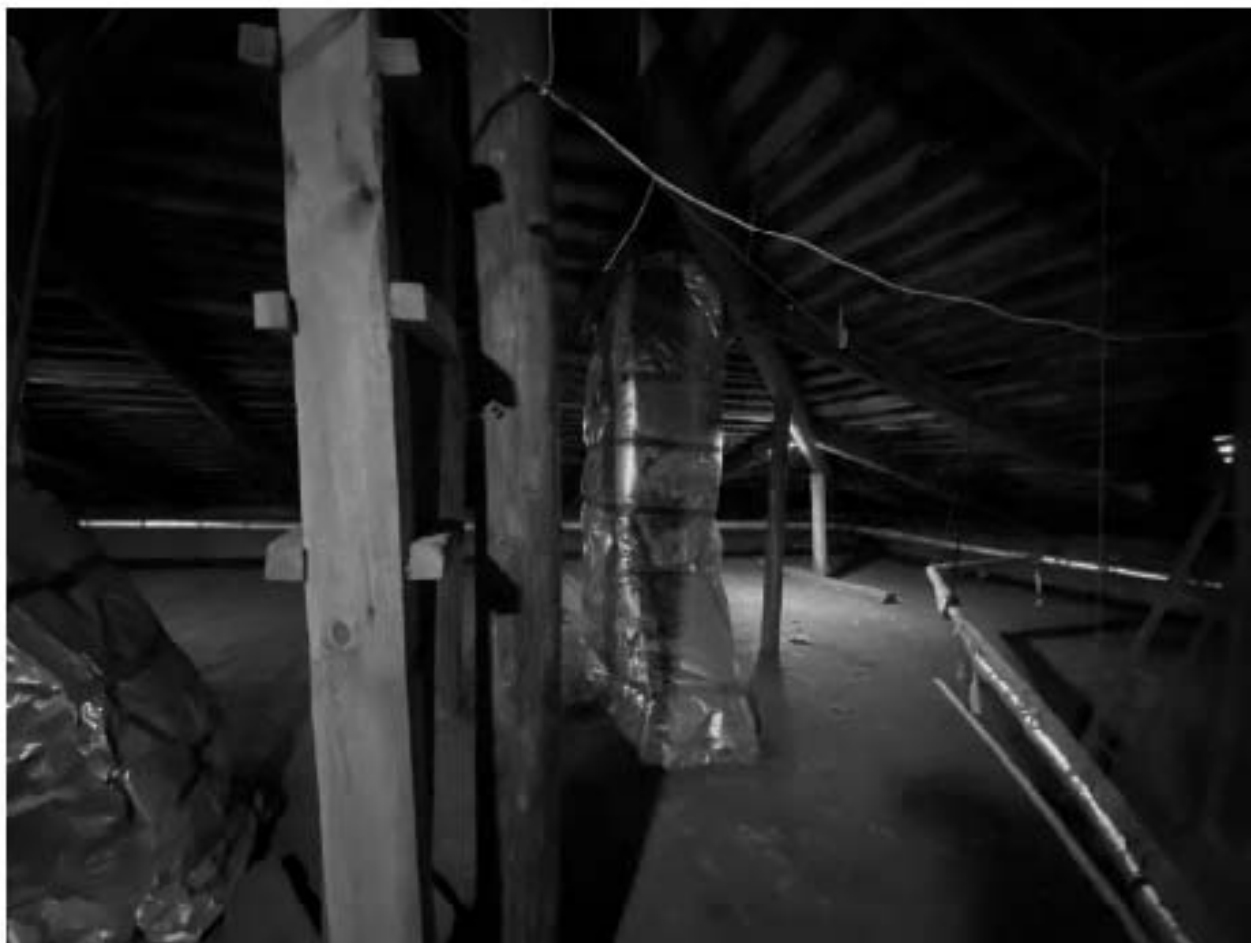
Фото 216. Чердак. Вертикальные подпорные стойки.
