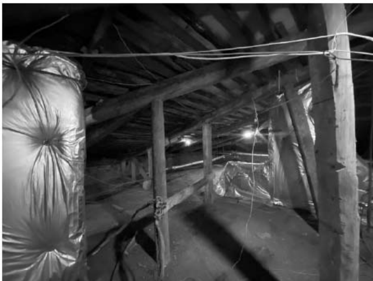
Фото 214. Чердак. Наклонная стропильная конструкция.
