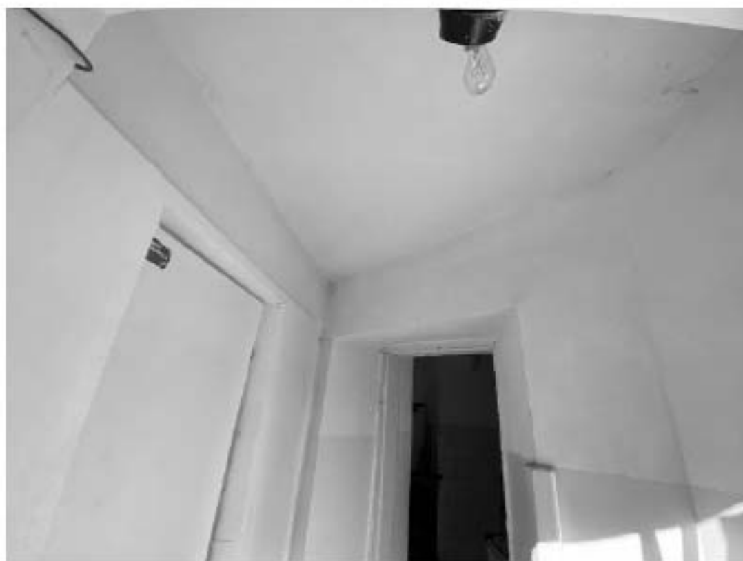
Фото 86. 1 этаж. Помещение 1-Н(11)
