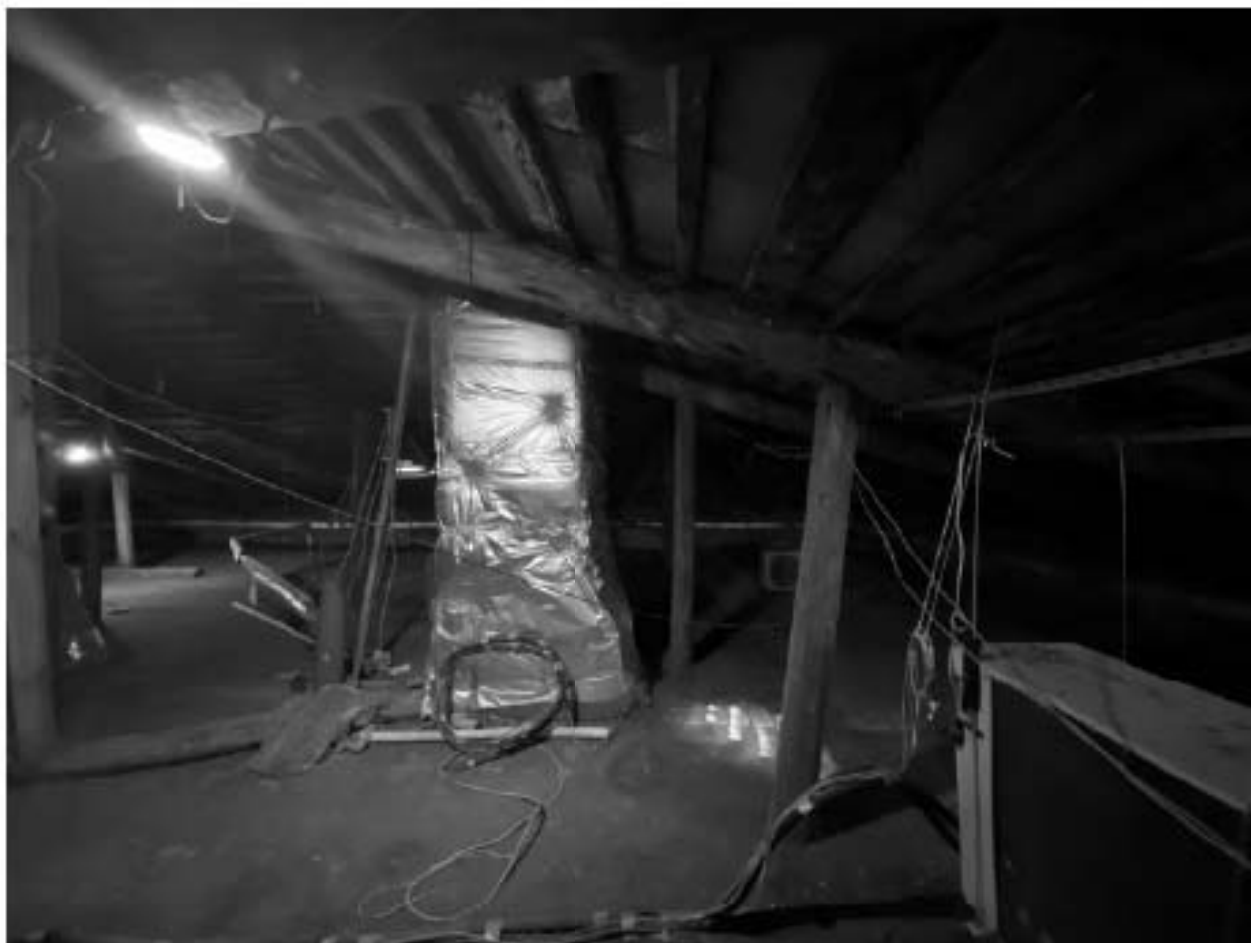
Фото 212. Чердак. Наклонная стропильная подпорка.
