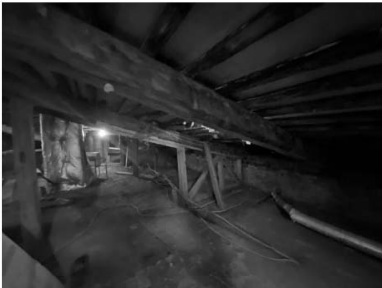
Фото 222. Чердак. Угловая опора чердачного перекрытия.
