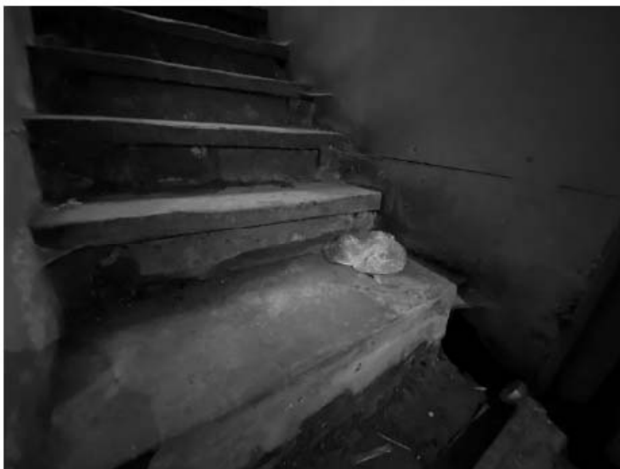
Фото 178. Подвал. Лестница с помещение 1-Н(34)
