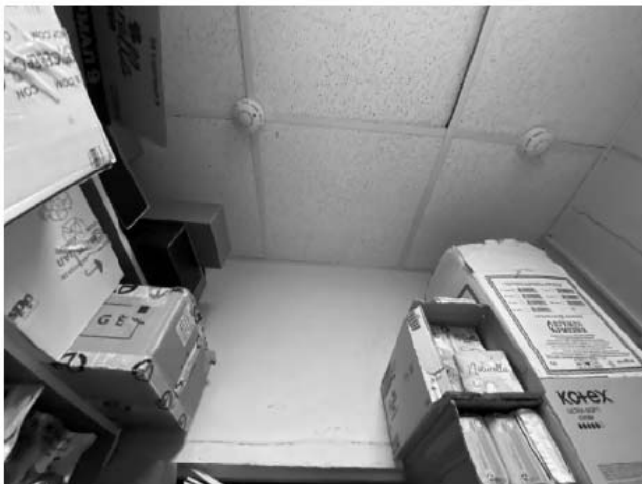
Фото 65. 1этаж. Помещение 1-Н(4)
