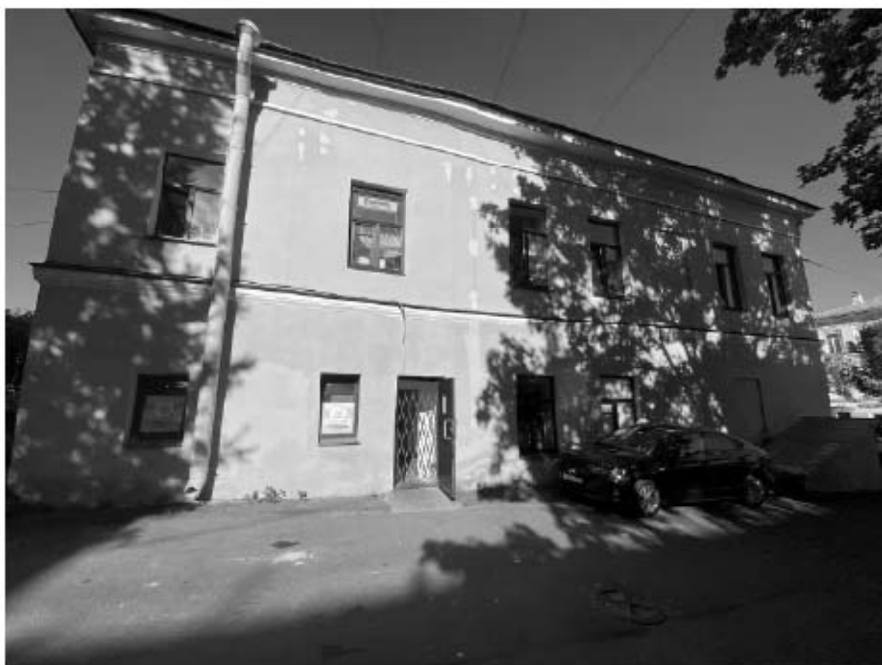
Фото 18. Юго-восточный дворовый фасад.
