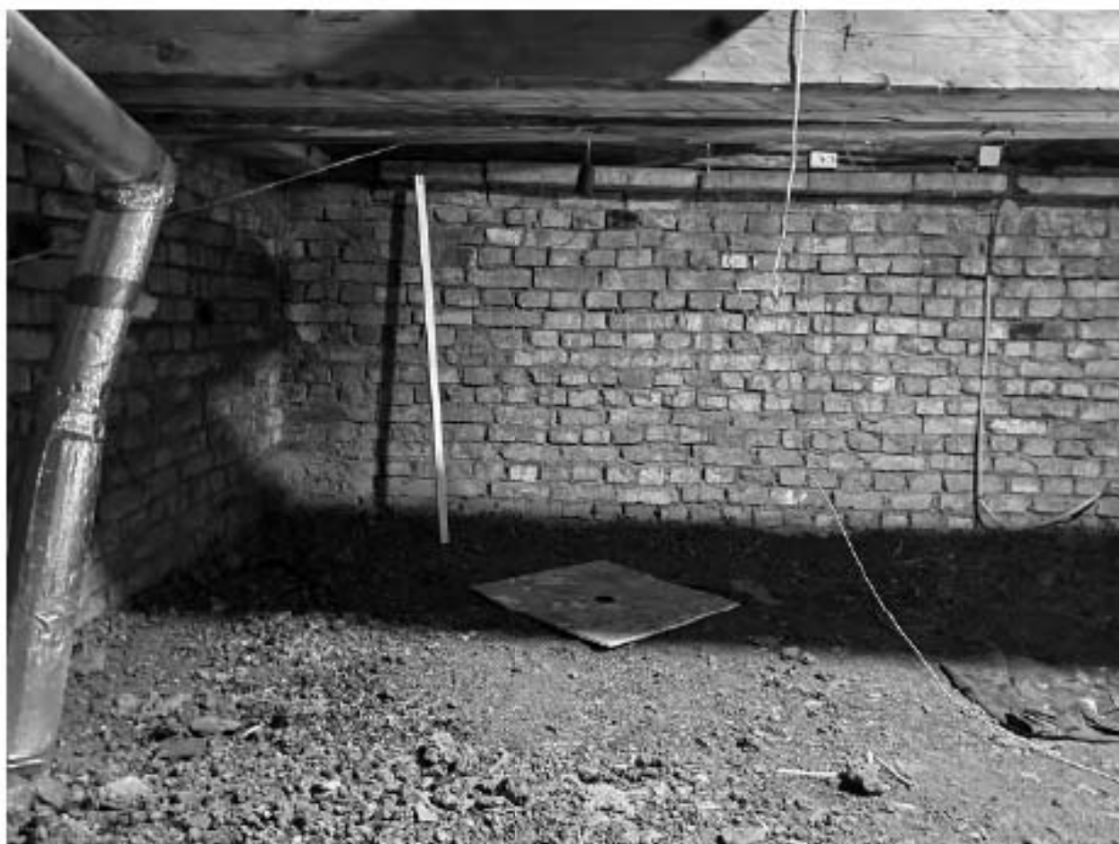
Фото 199. Чердак. Дощатый мауэрлат. Вертикальный фрагмент водопроводной трубы.
