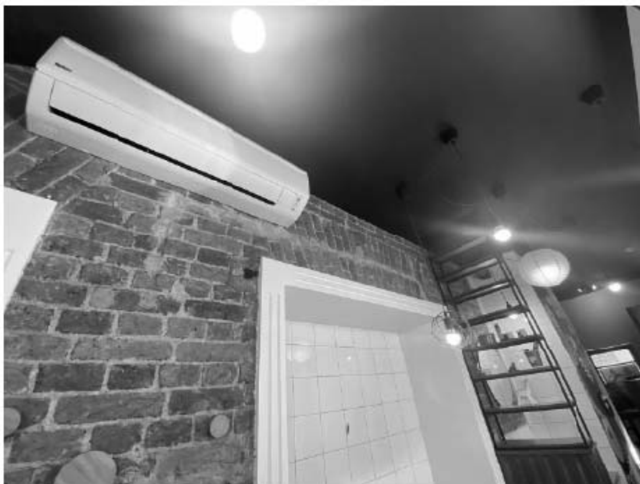
Фото 45. 1 этаж. Помещение 1-Н(15).
