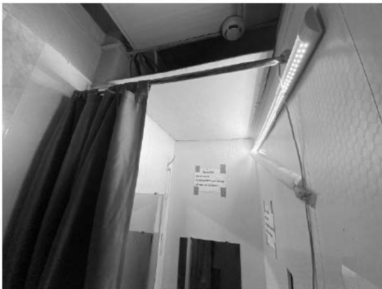
Фото 166. 2 этаж. Помещение 1-Н(33)
