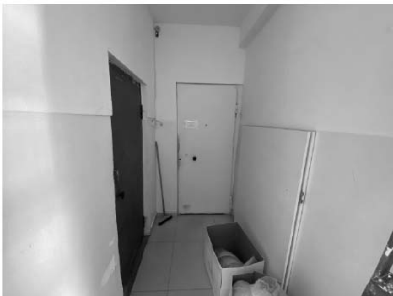
Фото 75. 1этаж. Помещение 1-Н(11)
