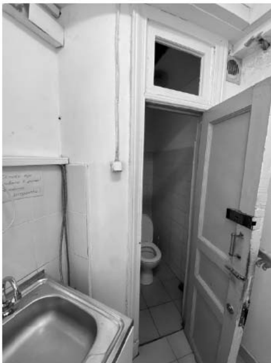
Фото 80. 1этаж. Помещение 1-Н(11) 1-Н(12)
