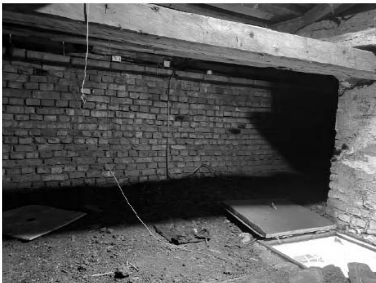
Фото 200. Чердак. Сдвоенный дощатый мауэрлат.
