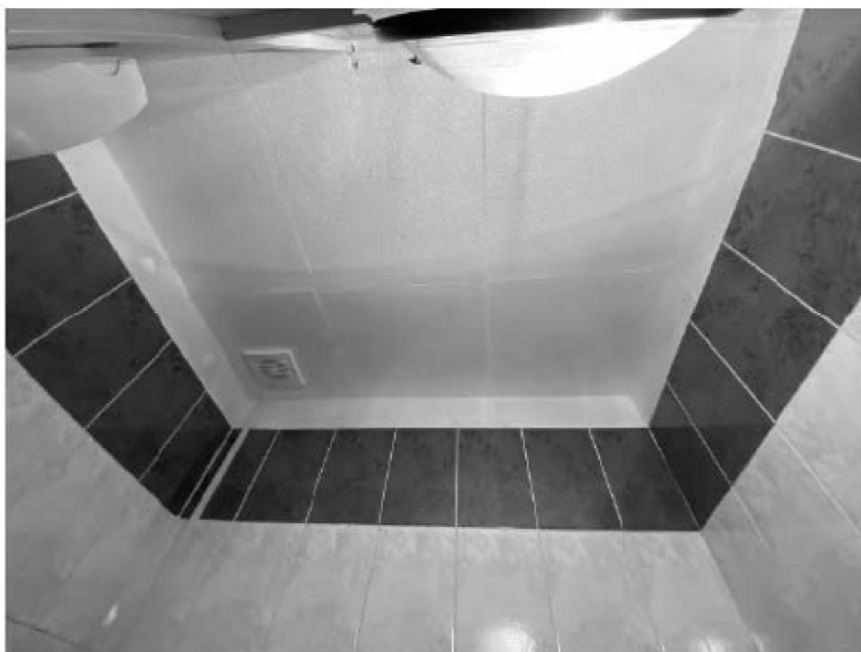
Фото 132. 2 этаж. Помещение 1-Н(30)
