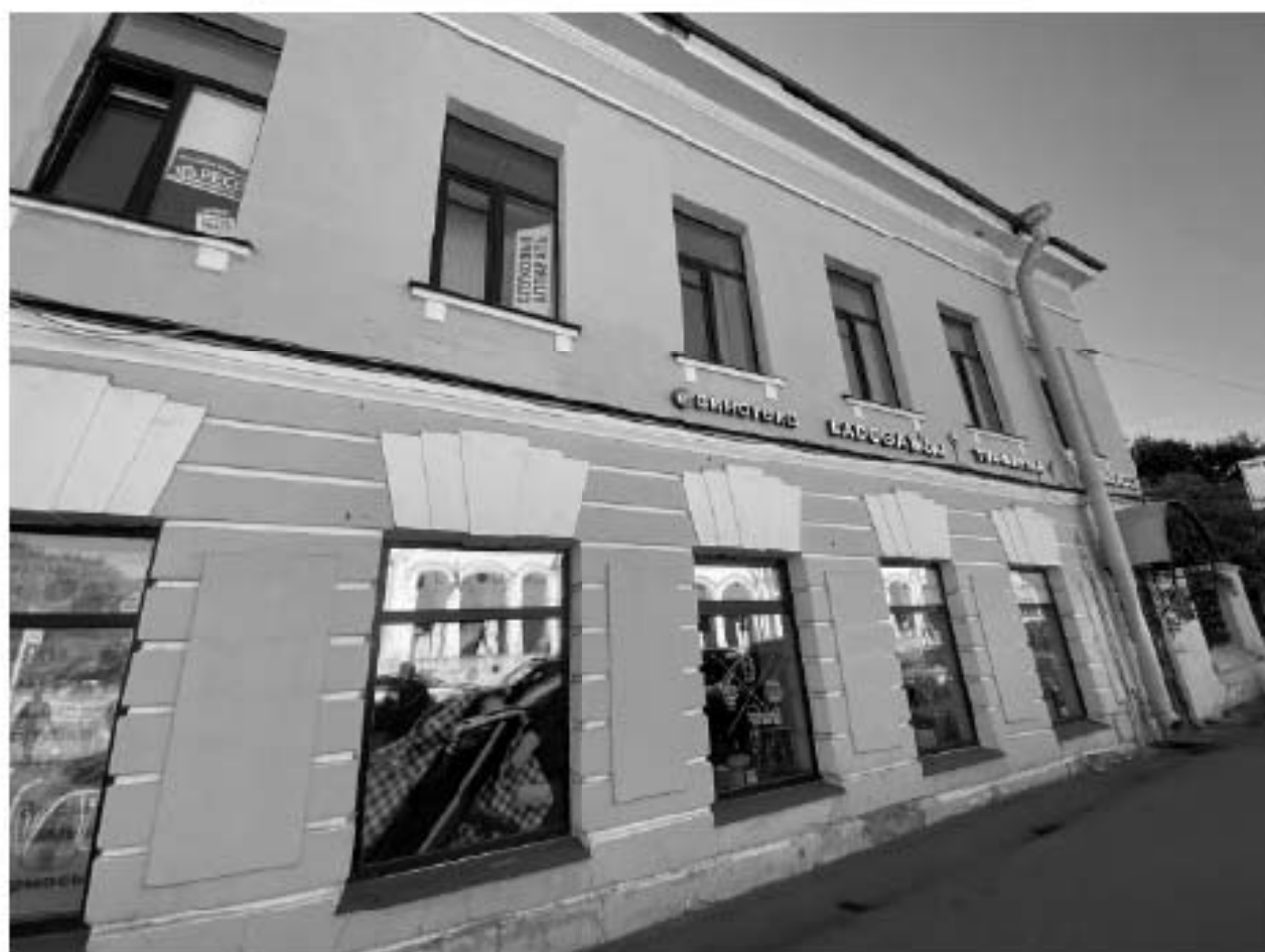
Фото 30. Северо-западный лицевой фасад со стороны Оранжевой улицы
