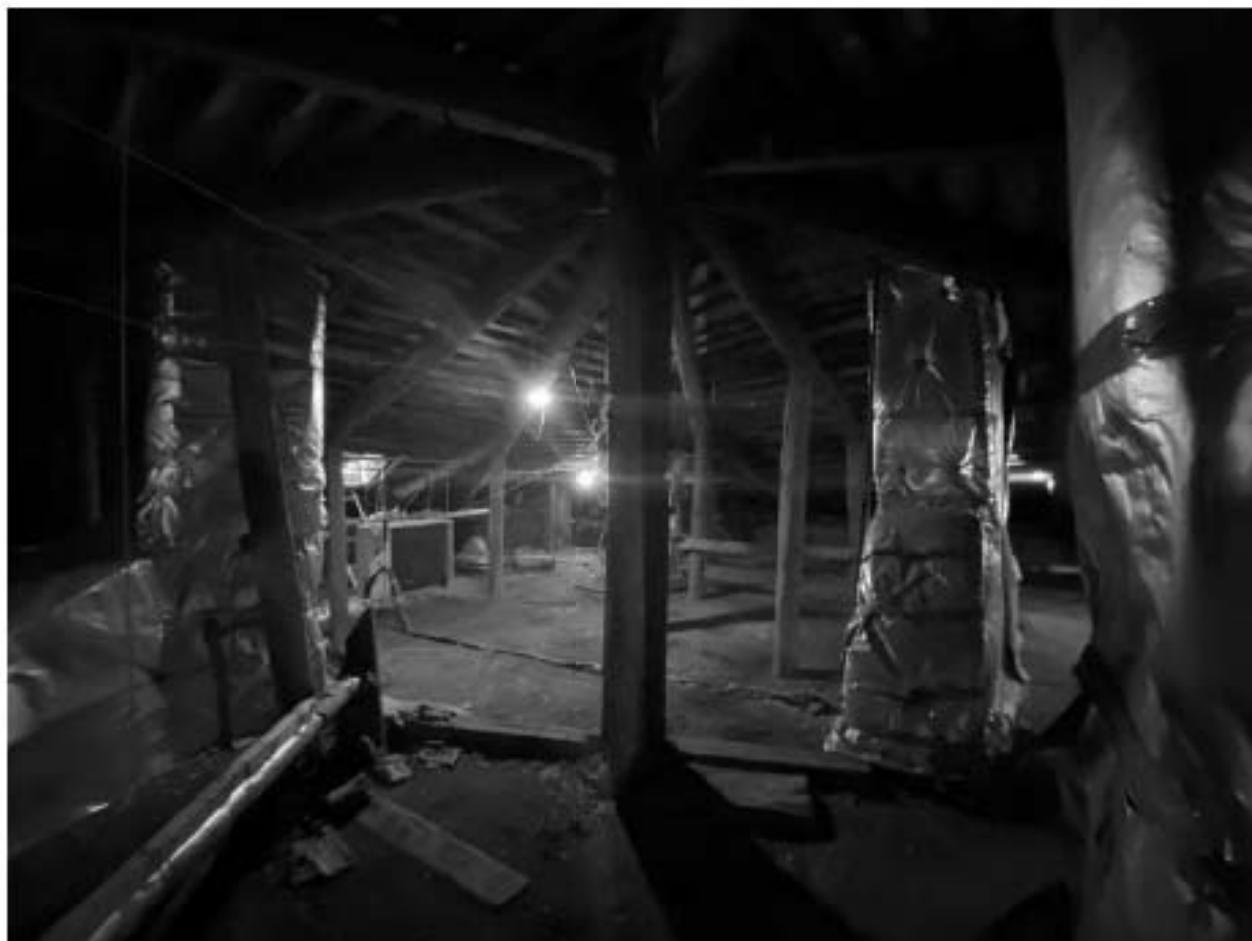
Фото 220. Чердак. Угловая наклонная конструкция деревянных стропил кровли.
