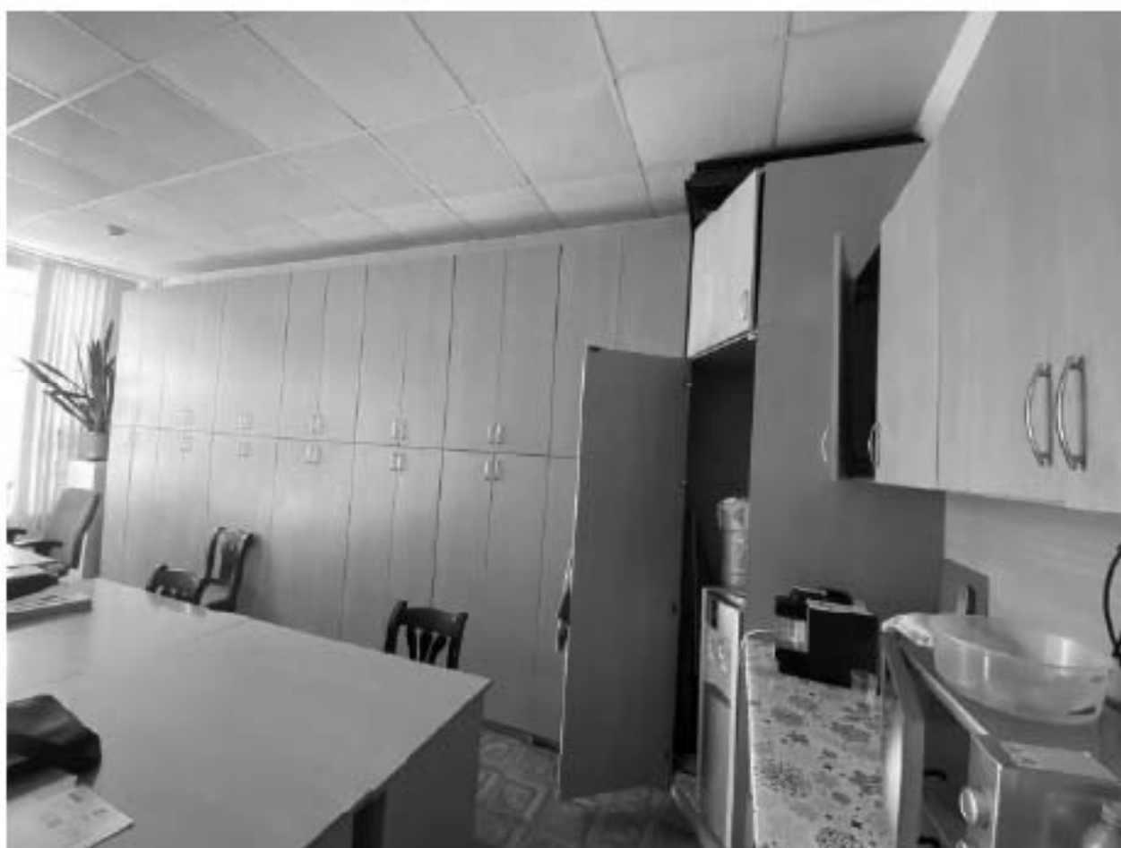
Фото 137. 2 этаж. Помещение 1-Н(28)
