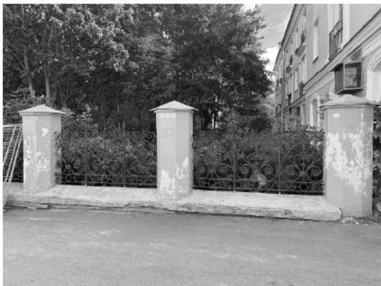
Фото 35. Часть садового ограждения со стороны Оранжерейной улицы
