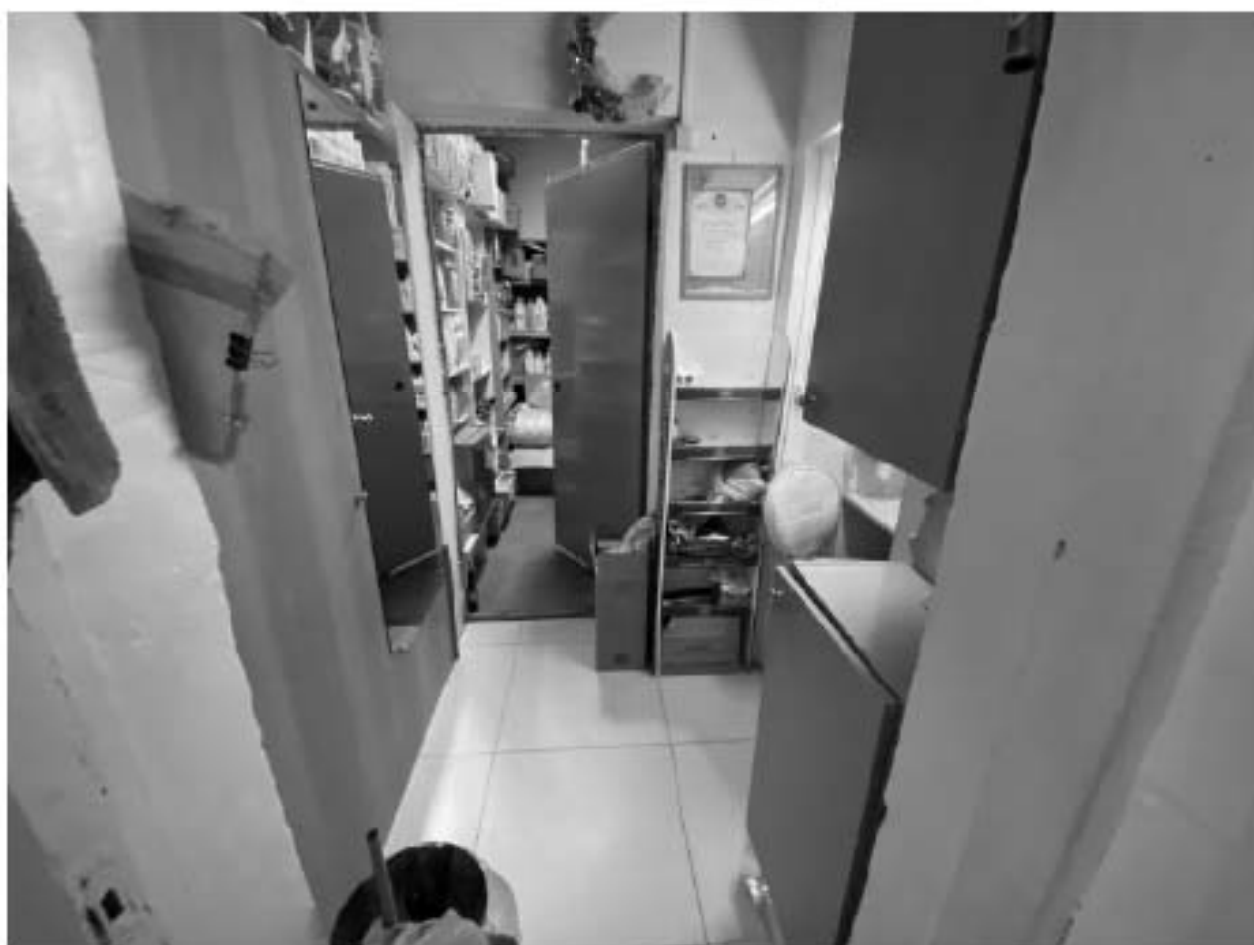
Фото 59. 1этаж. Помещение 1-Н(5)
