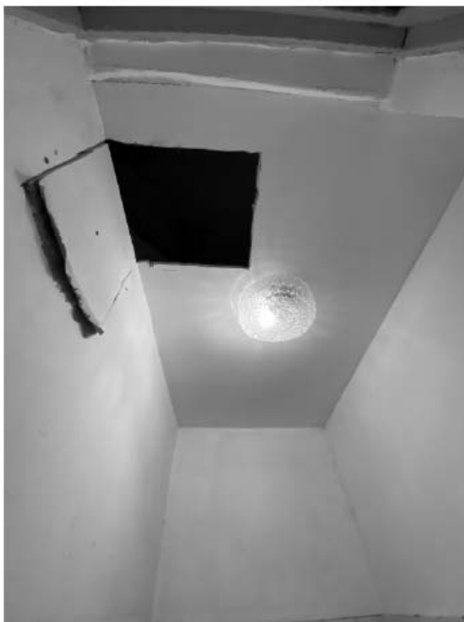
Фото 82. 1 этаж. Помещение 1-Н(12)
