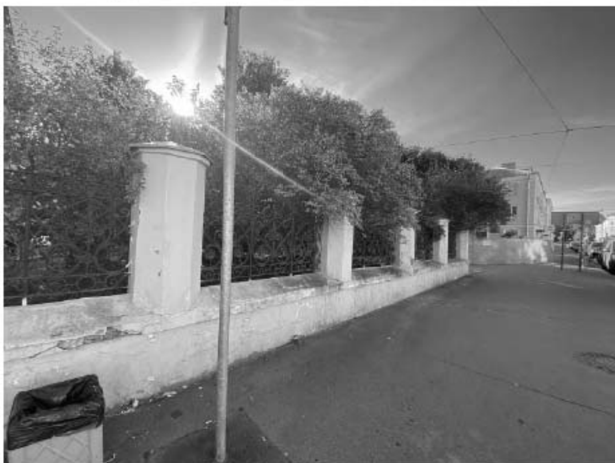
Фото 5. Часть садового ограждения со стороны Оранжерейной улицы
