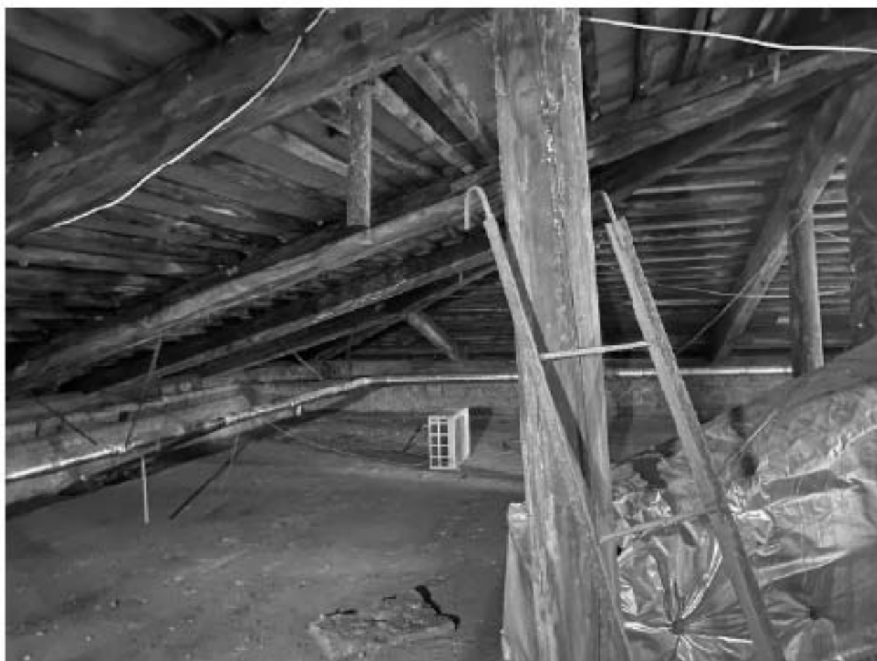
Фото 219. Чердак. Угловая наклонная конструкция деревянных стропил кровли.
