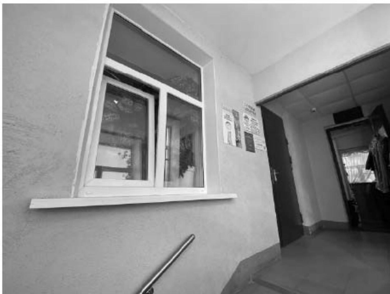
Фото 106. Лестница 2 этаж, окно в помещение 1-Н(16)
