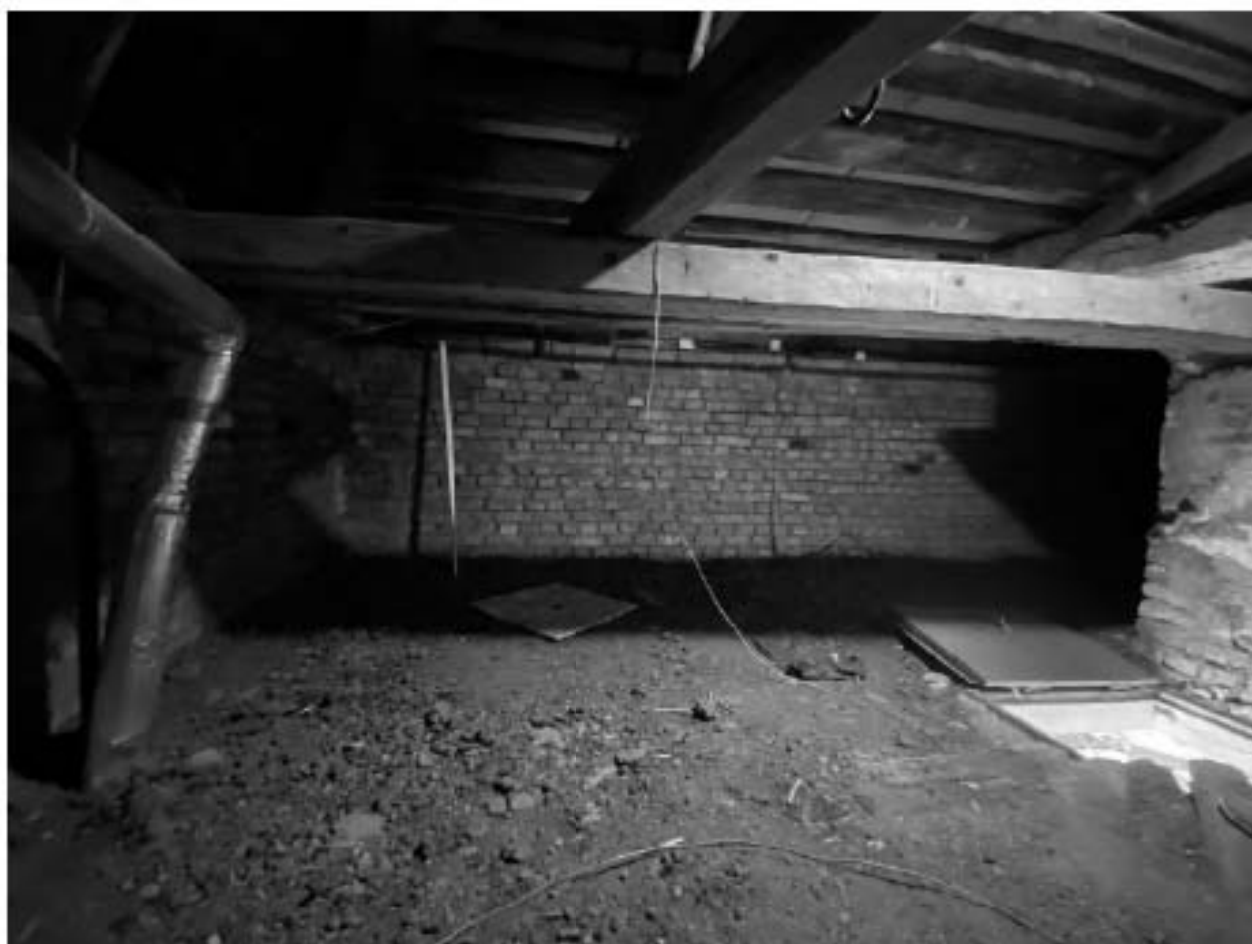
Фото 198. Чердак. Крепление дощатого перекрытия. Опорный узел.
