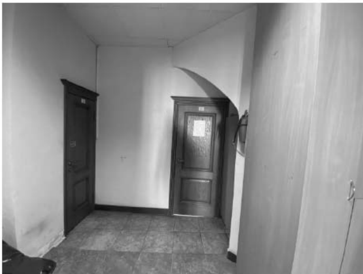
Фото 110. 2 этаж. Помещение 1-Н(16)
