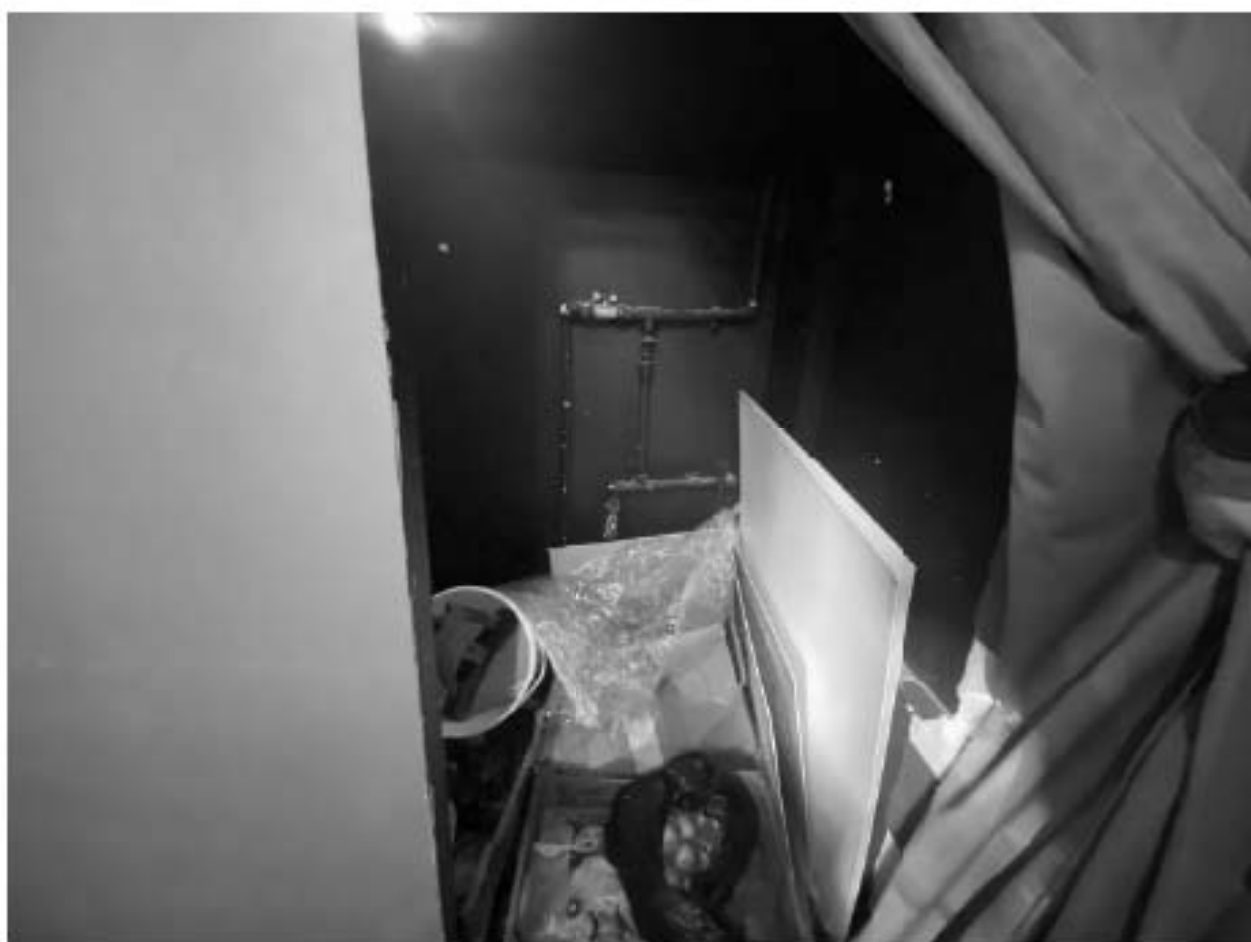
Фото 46. 1этаж. Помещение 1-Н(15)
