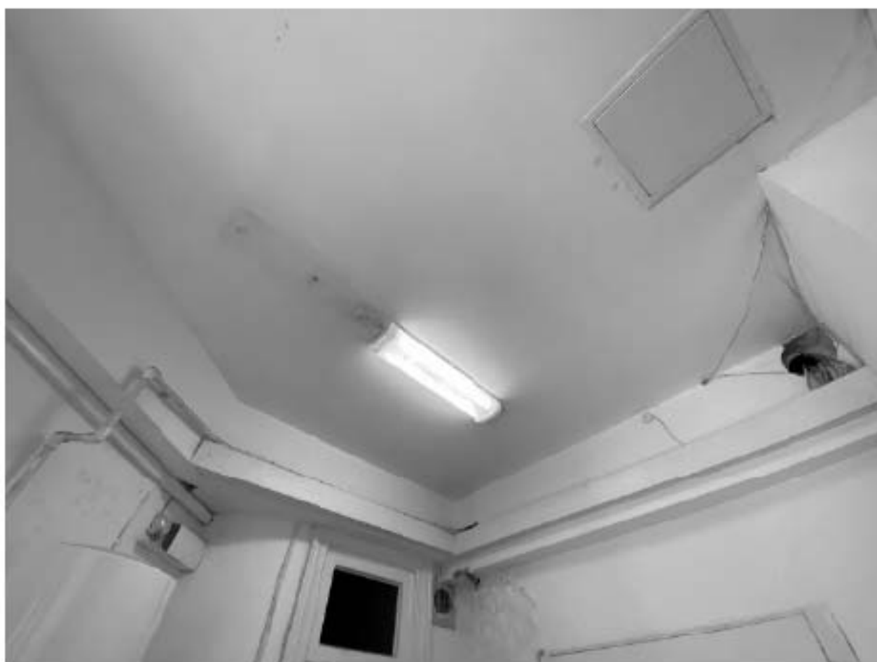
Фото 79. 1этаж. Помещение 1-Н(11)
