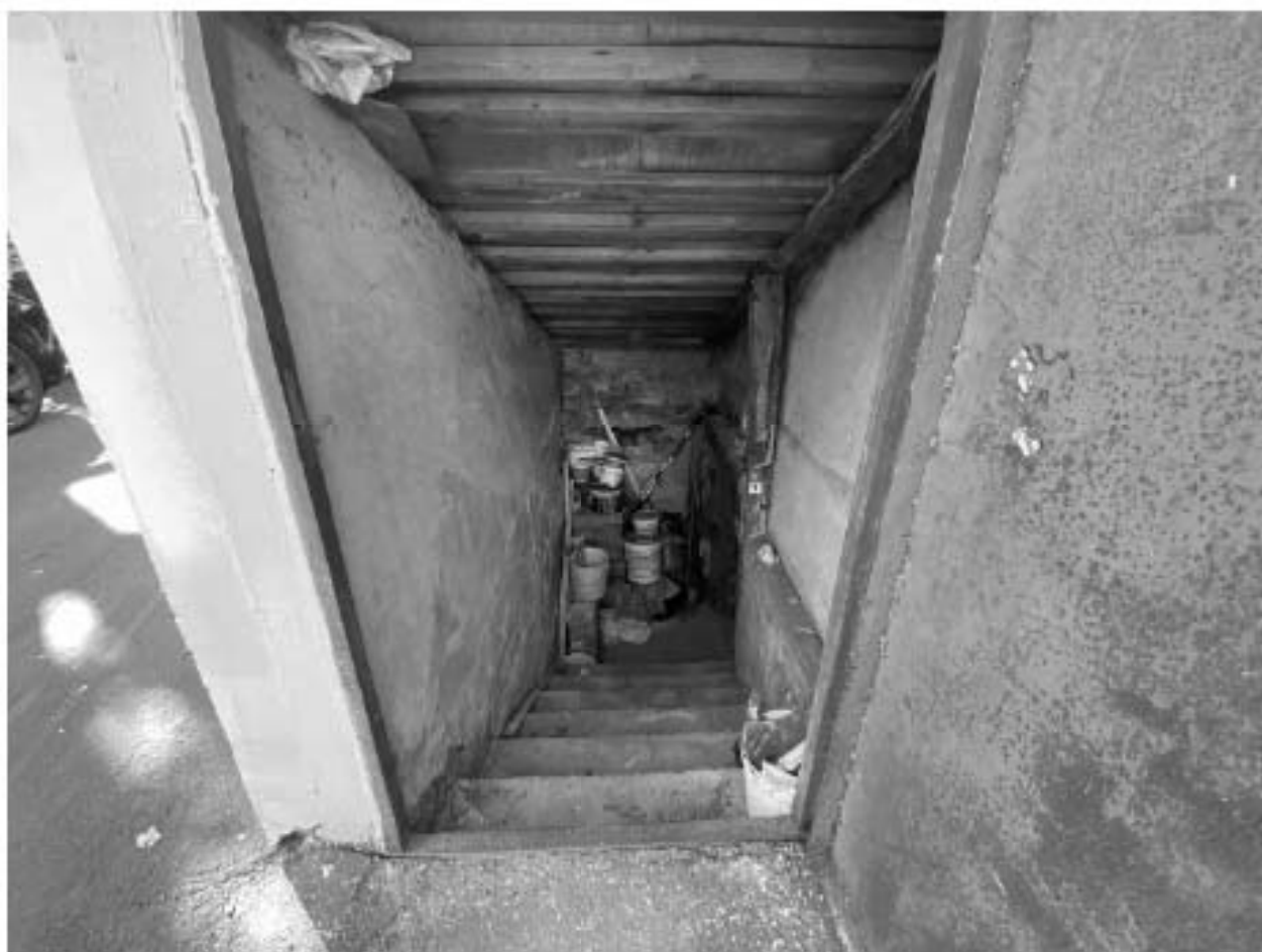
Фото 179. Лестница в подвал со стороны юго-восточного фасада
