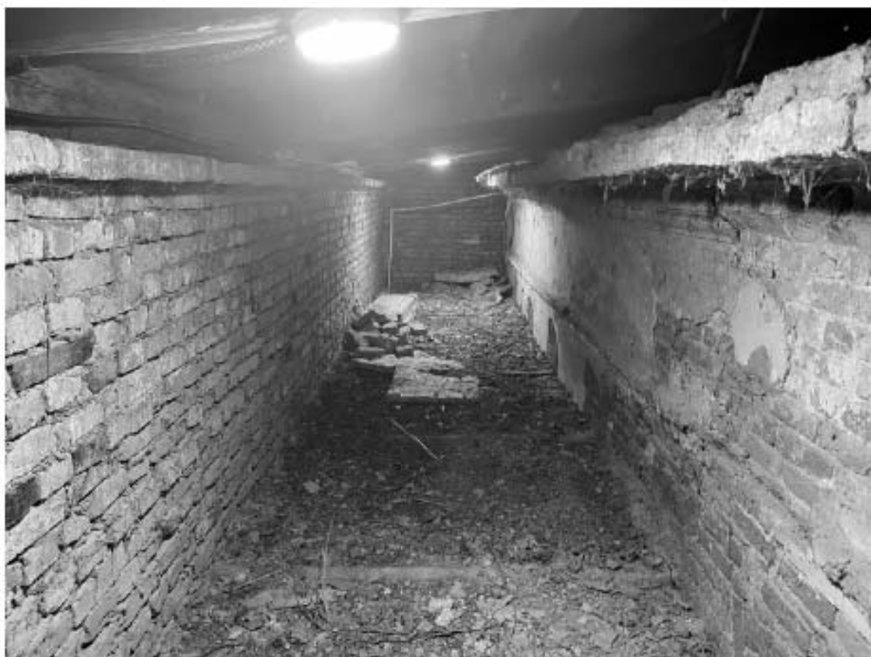
Фото 205. Чердак в объеме пристроенной лестницы. Фрагмент исторического лицевого фасада.
