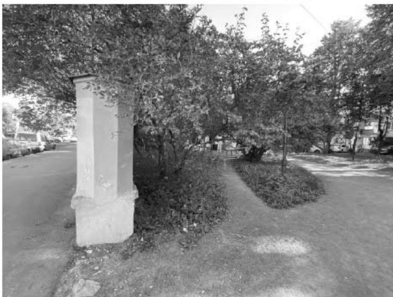
Фото 11. Часть садового ограждения со стороны Оранжерейной улицы
