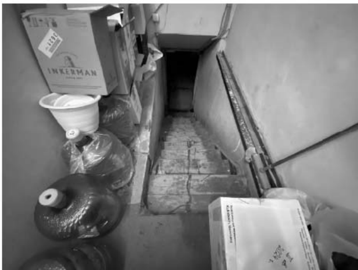
Фото 89. 1этаж. Помещение 1-Н(10)
