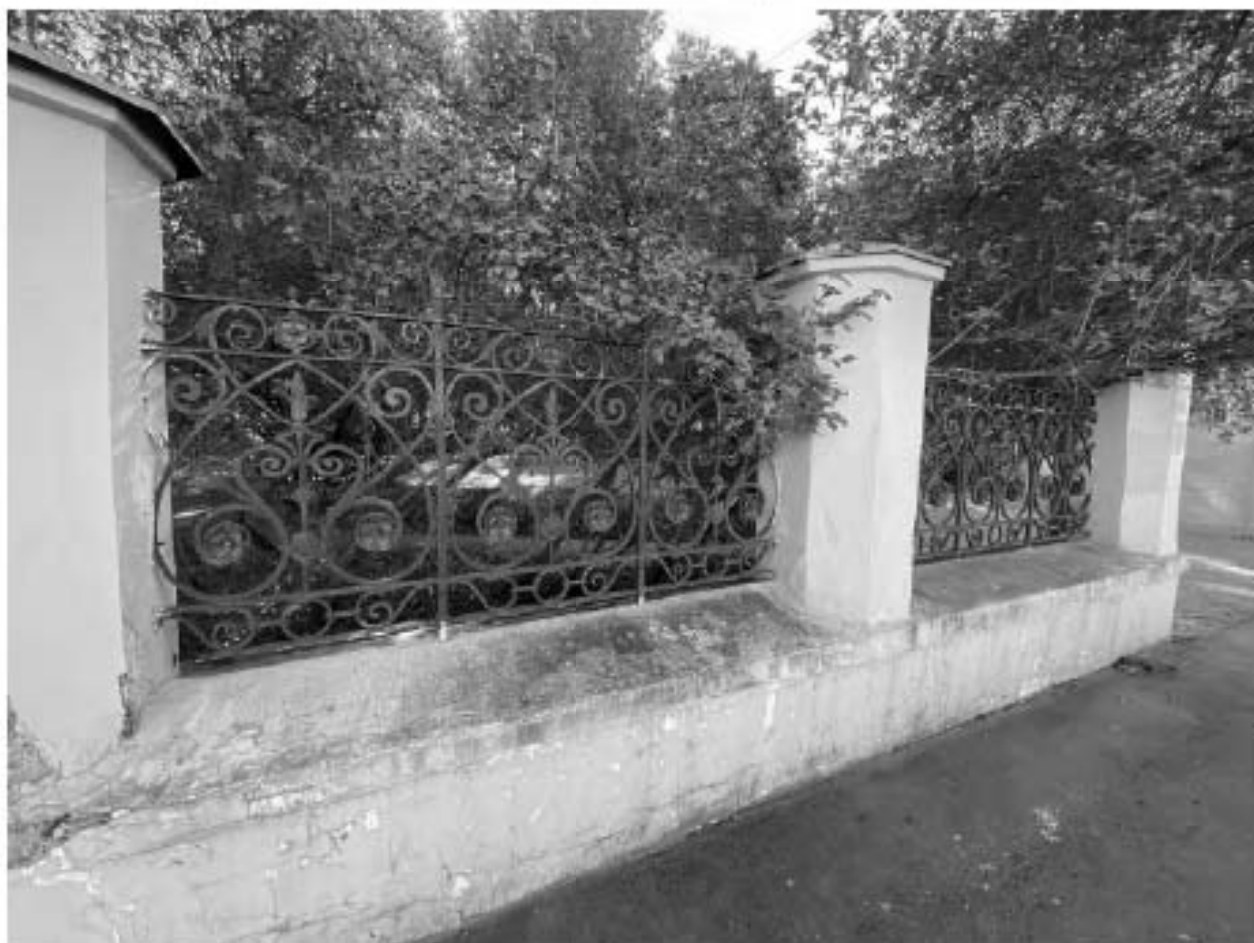
Фото 9. Часть садового ограждения со стороны Оранжерейной улицы
