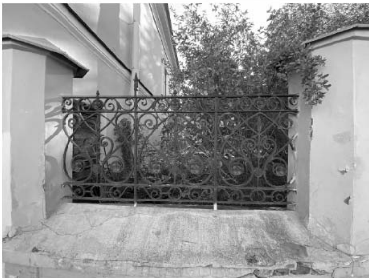
Фото 6. Часть садового ограждения со стороны Оранжерейной улицы
