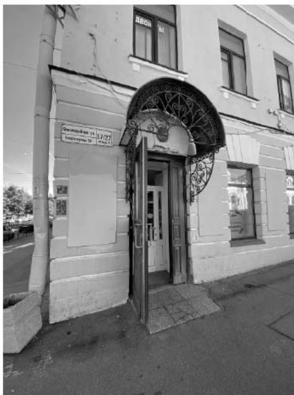
Фото 27. Фрагмент северо-западного лицевого фасада. Вход в здание со стороны Оранжевой улицы.
