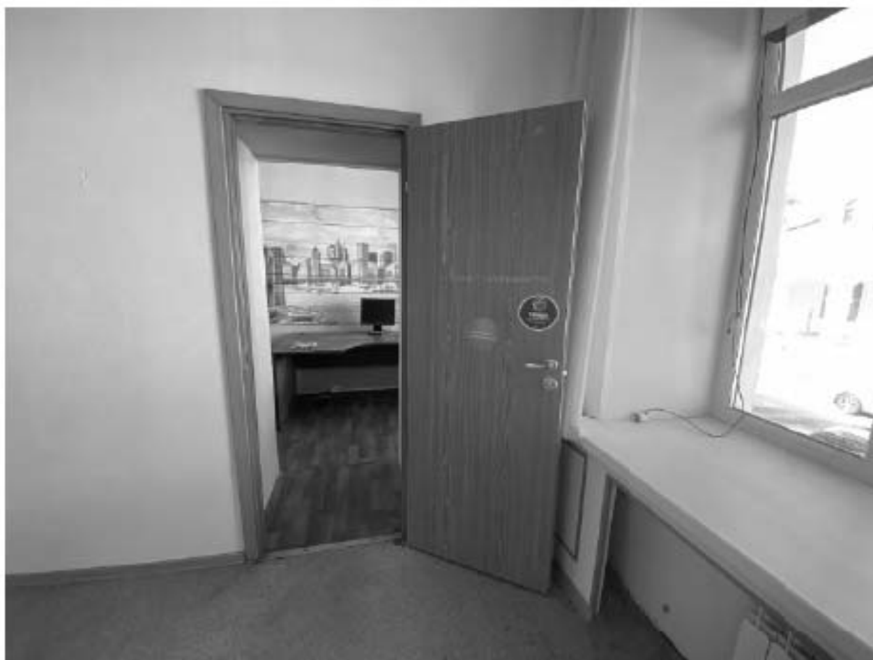
Фото 117. 2 этаж. Помещение 1-Н(18)
