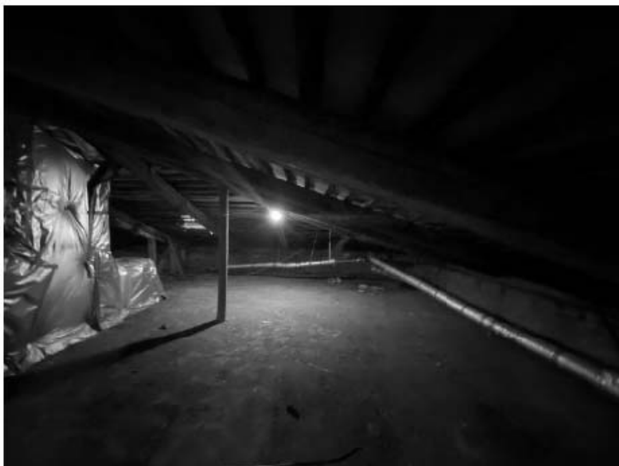
Фото 221. Чердак. Угловой фрагмент.
