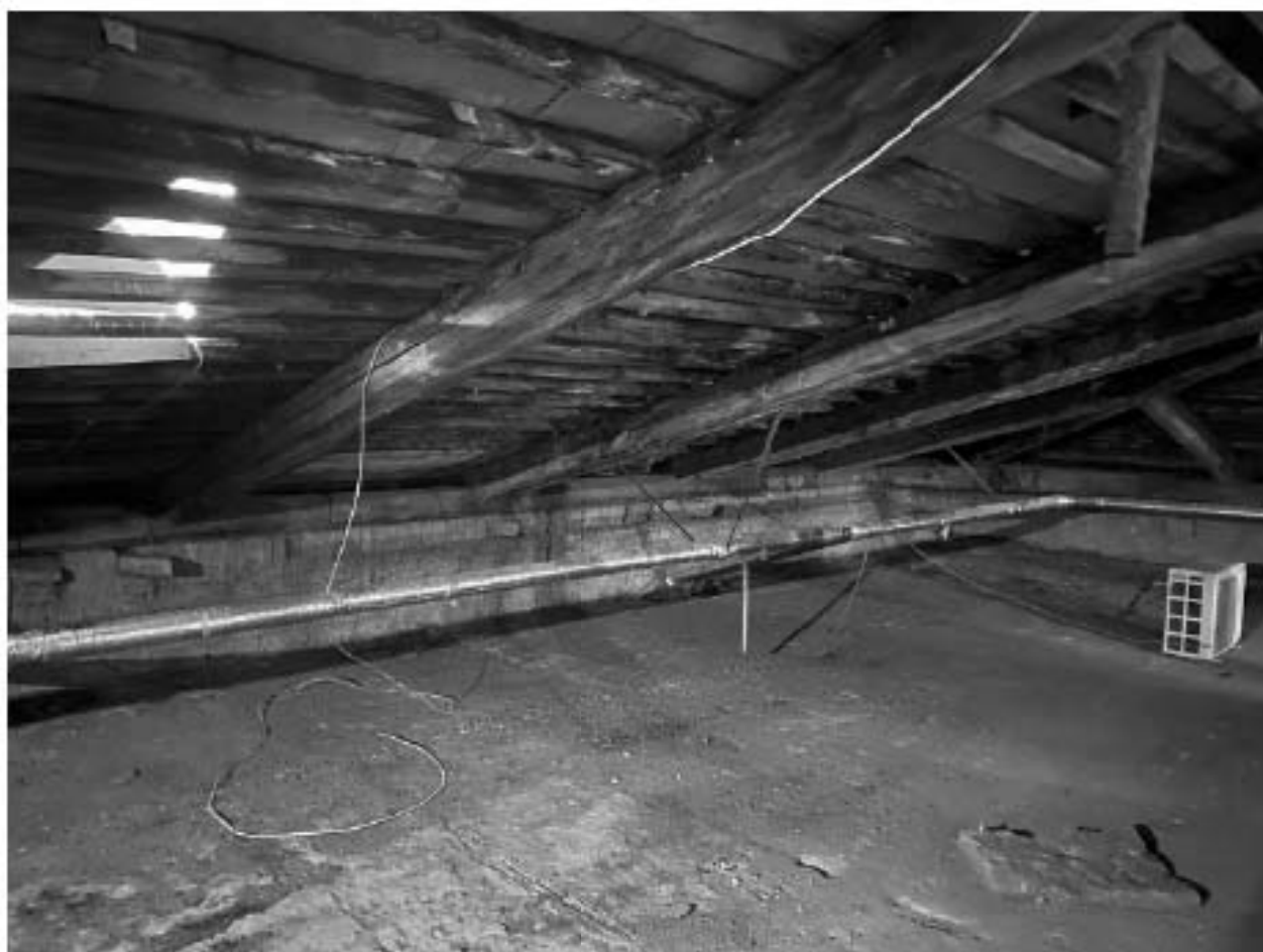
Фото 218. Чердак. Слуховое окно по фасаду кровли.
