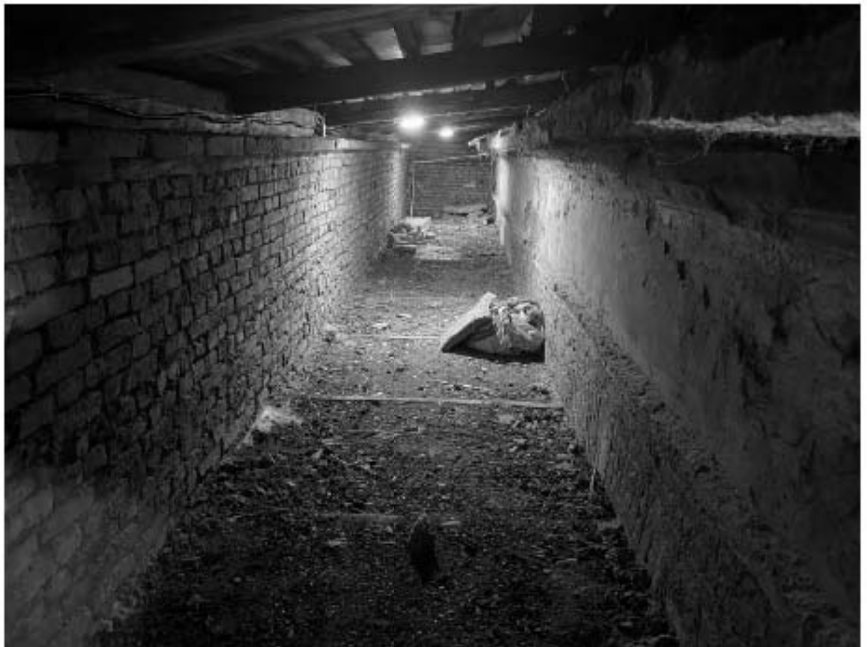
Фото 202. Чердак в объеме пристроенной лестницы. Фрагмент исторического лицевого фасада.
