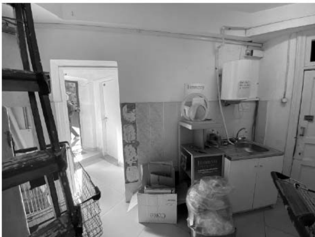
Фото 84. 1-этаж. Помещение 1-Н(11) и 1-Н(13)
