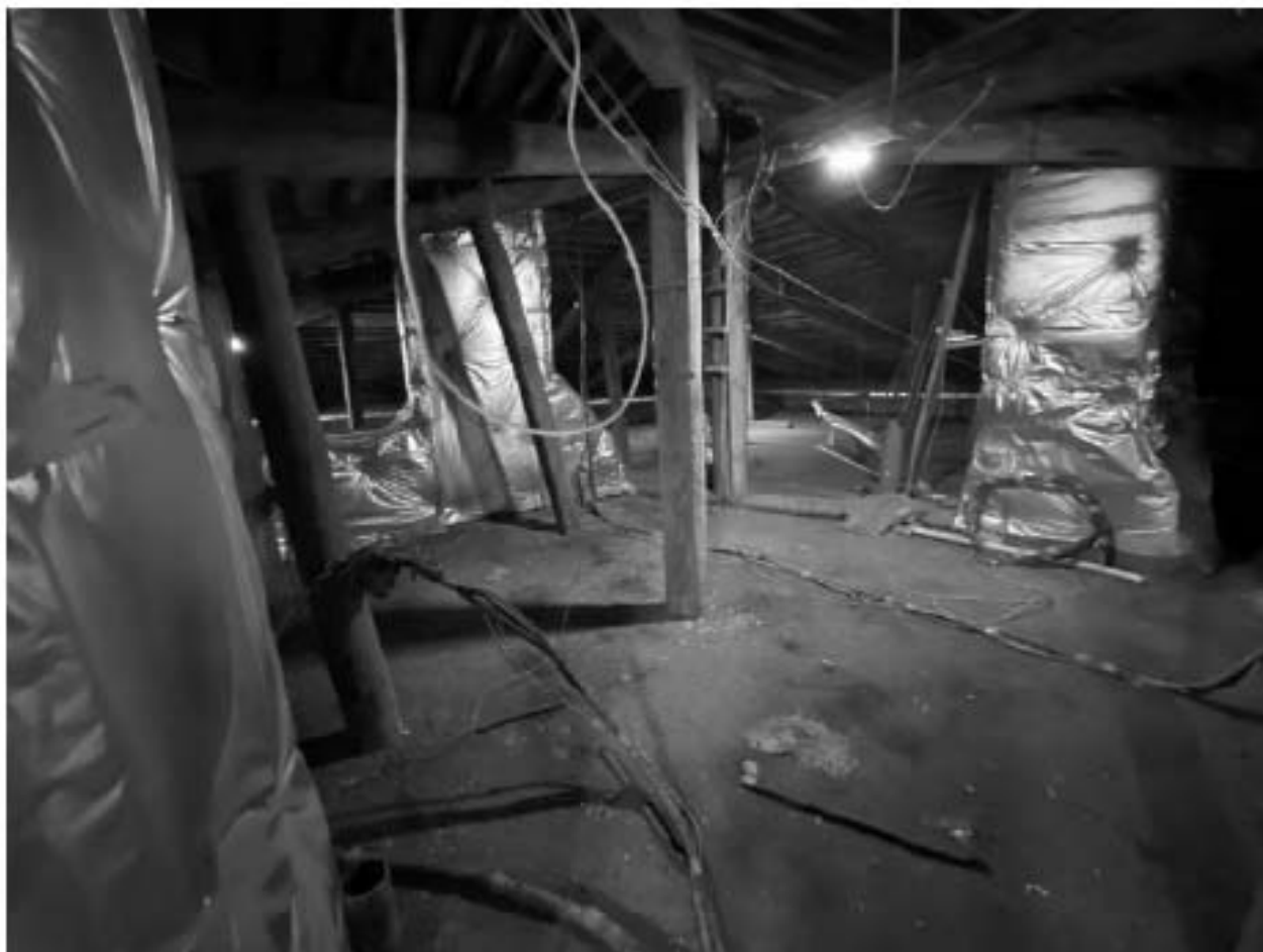
Фото 211. Чердак. Горизонтальная стропильная подпорка.
