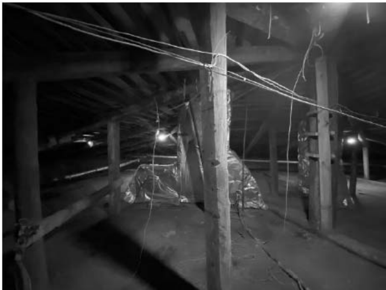
Фото 213. Чердак. Конструкция горизонтальной стропильной подпорки.
