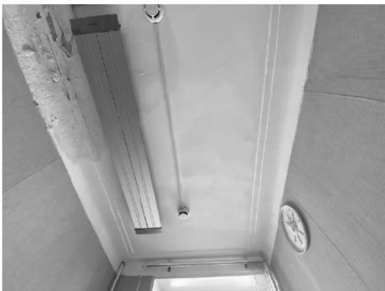
Фото 121. 2 этаж. Помещение 1-Н(17)
