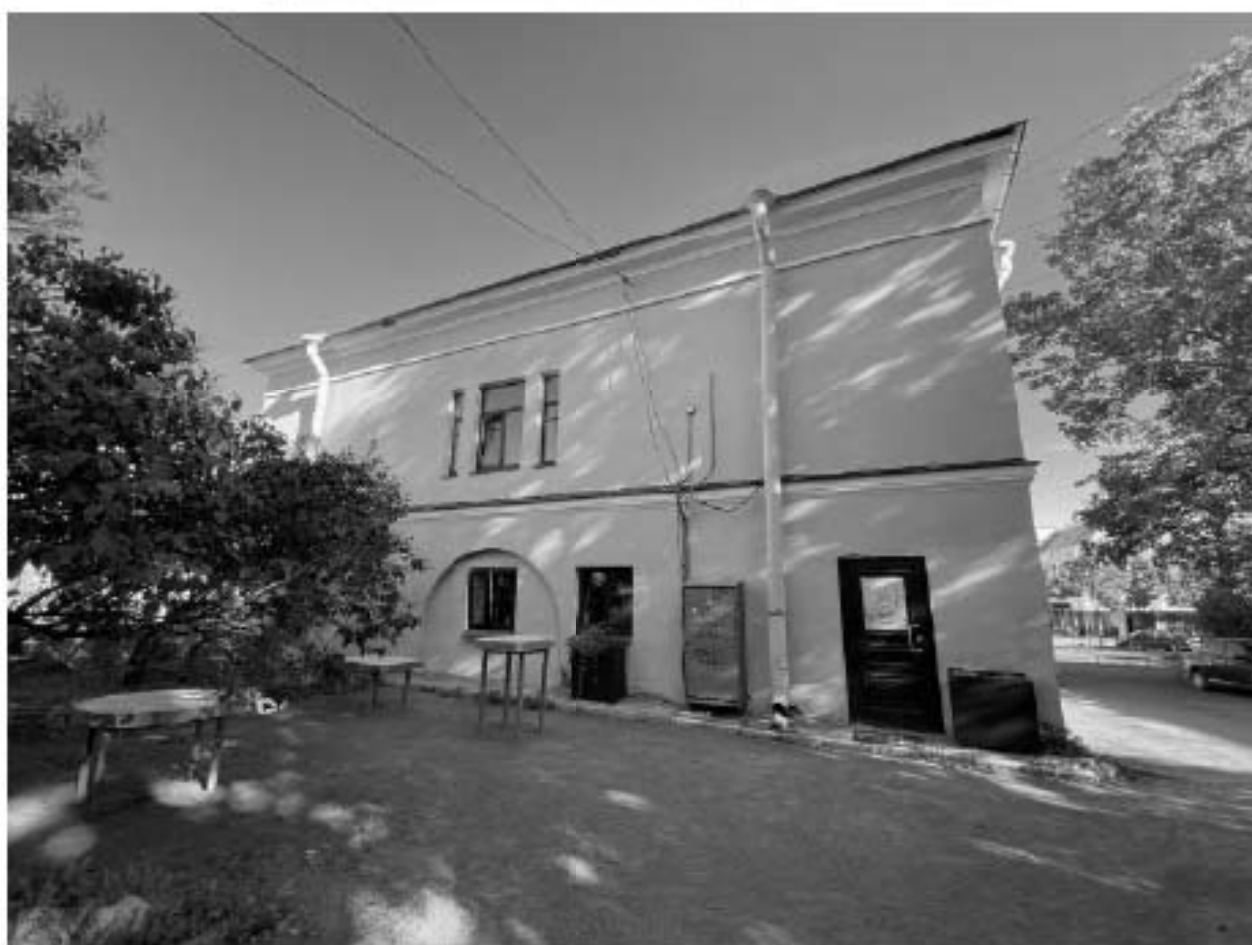
Фото 17. Юго-западный фасад со стороны городского сквера.
