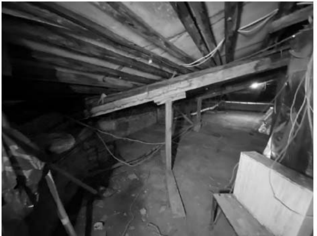
Фото 209. Чердак. Наклонная стропильная подпорка.
