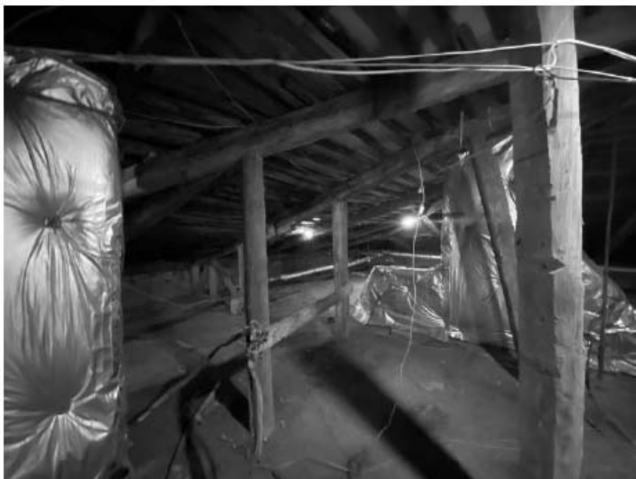
Фото 215. Чердак. Наклонная стропильная конструкция.
