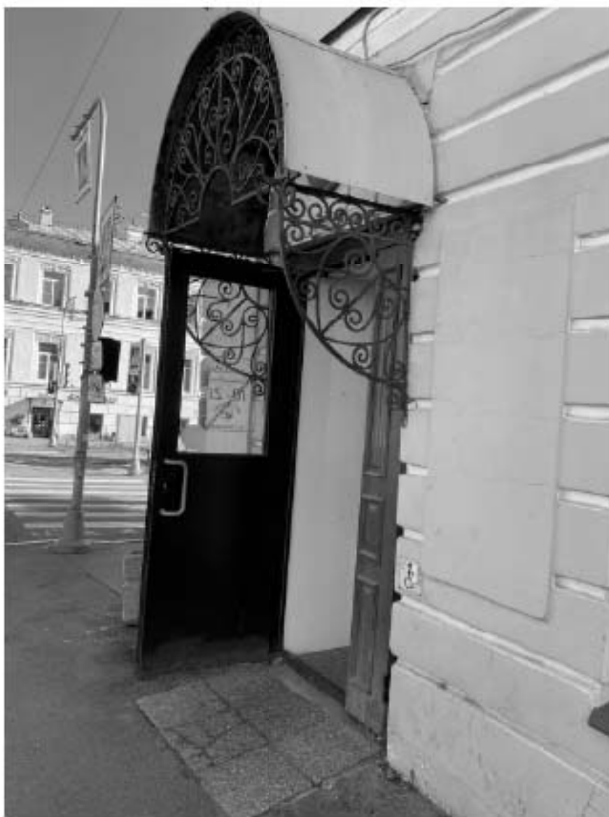
Фото 32. Вход со стороны Оранжерейной улицы.
