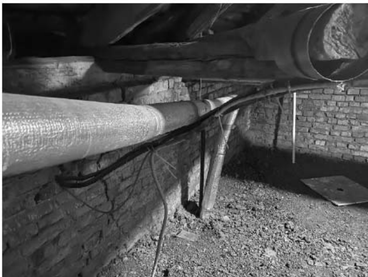
Фото 197. Чердак. Примыкание дощатого перекрытия и стропил к прямому углу кирпичной кладки стен. Водопроводная труба в теплоизоляции.
