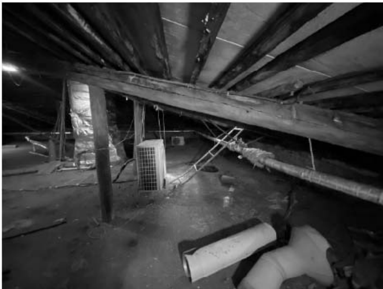
Фото 210. Чердак. Наклонная стропильная подпорка.
