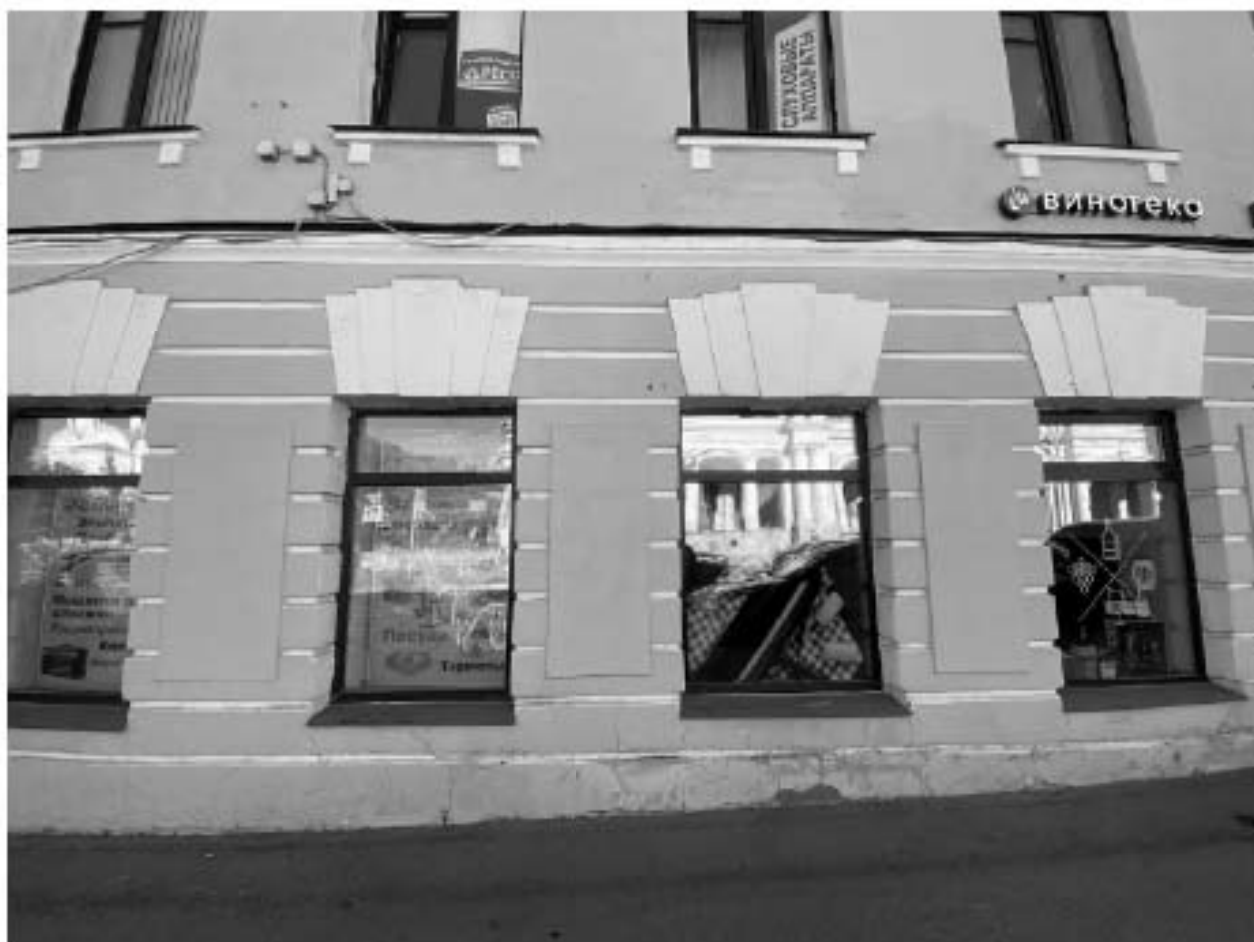
Фото 29. Северо-западный фасад со стороны улицы Оранжерейная
