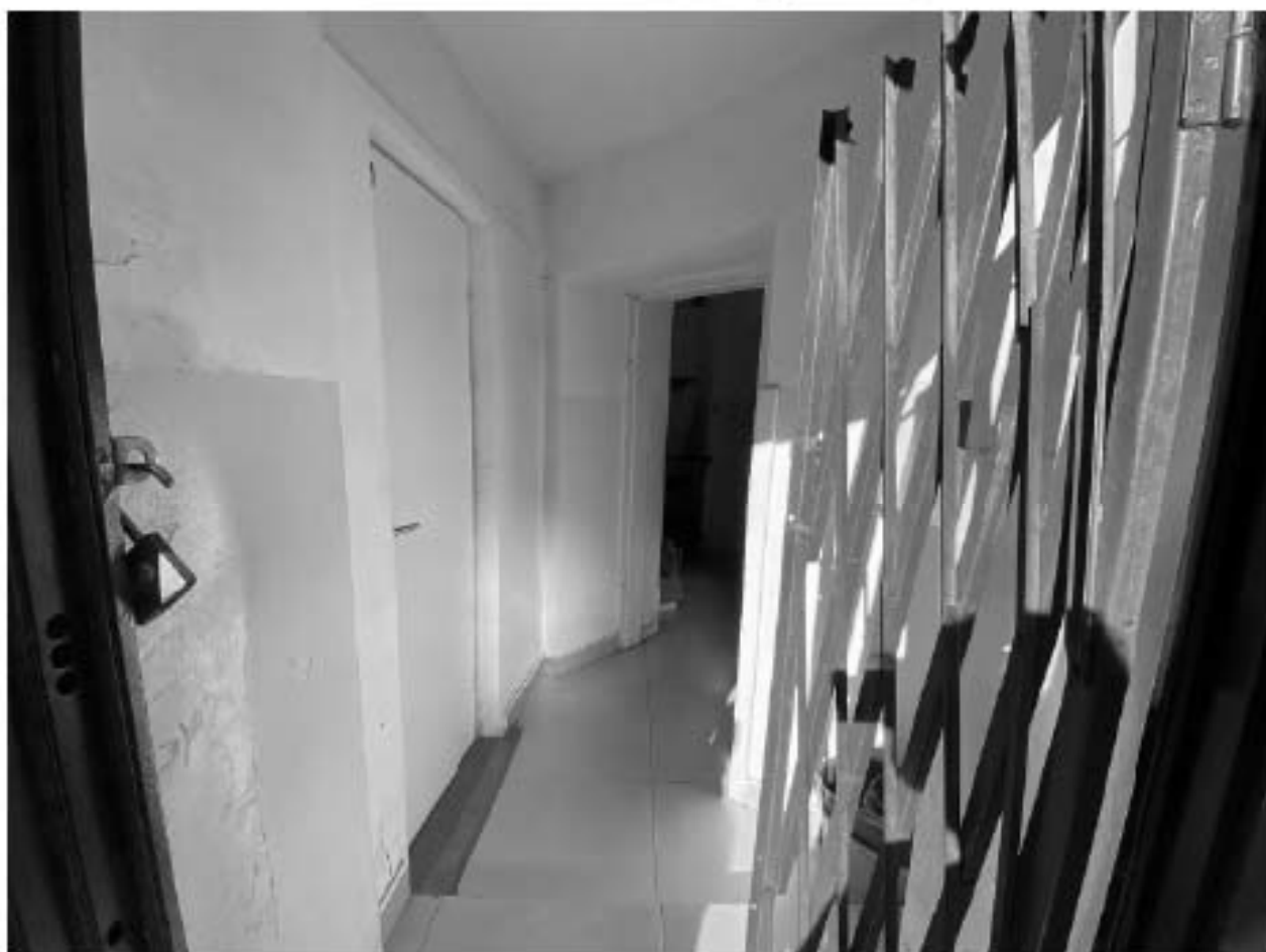
Фото 85. 1этаж. Помещение 1-Н(11)
