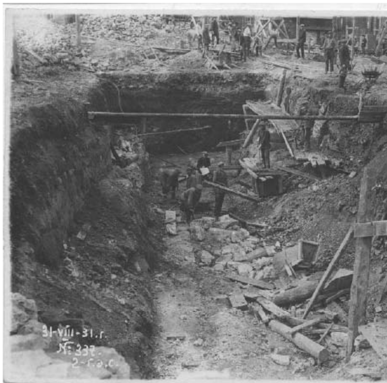
111. Строительство новой котельной. Дата съемки: 31.08.1931 г. // Исто
