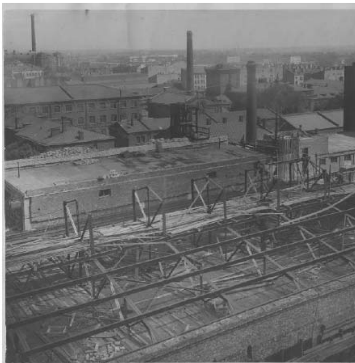
123. Строительство новой котельной. Дата съемки: 1930-е гг. // Ист
