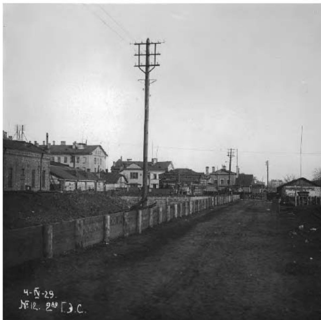
68. Территория электростанции. Дата съемки: 04.04.1929 г. // Источн
