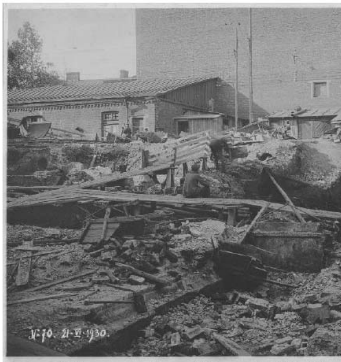
87.Строительство новой котельной. Дата съемки: 21.06.1930 г. // Источ
