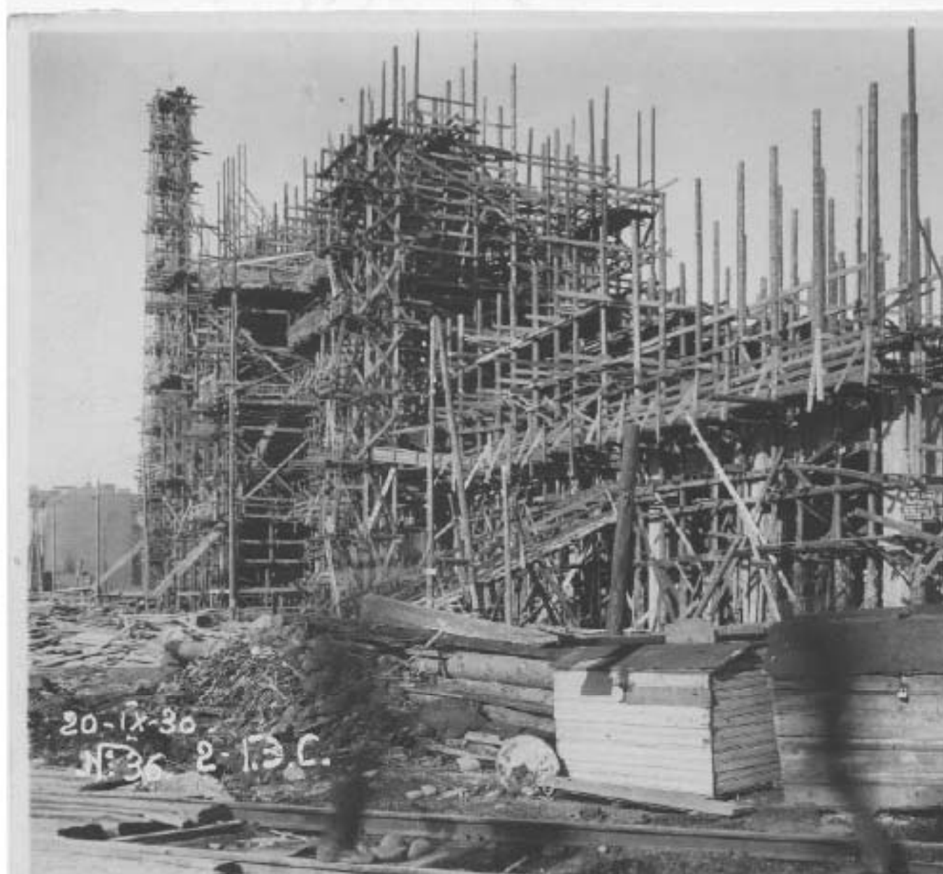
92. Строительство новой котельной. Дата съемки: 20.09.1930 г. // Источник:
