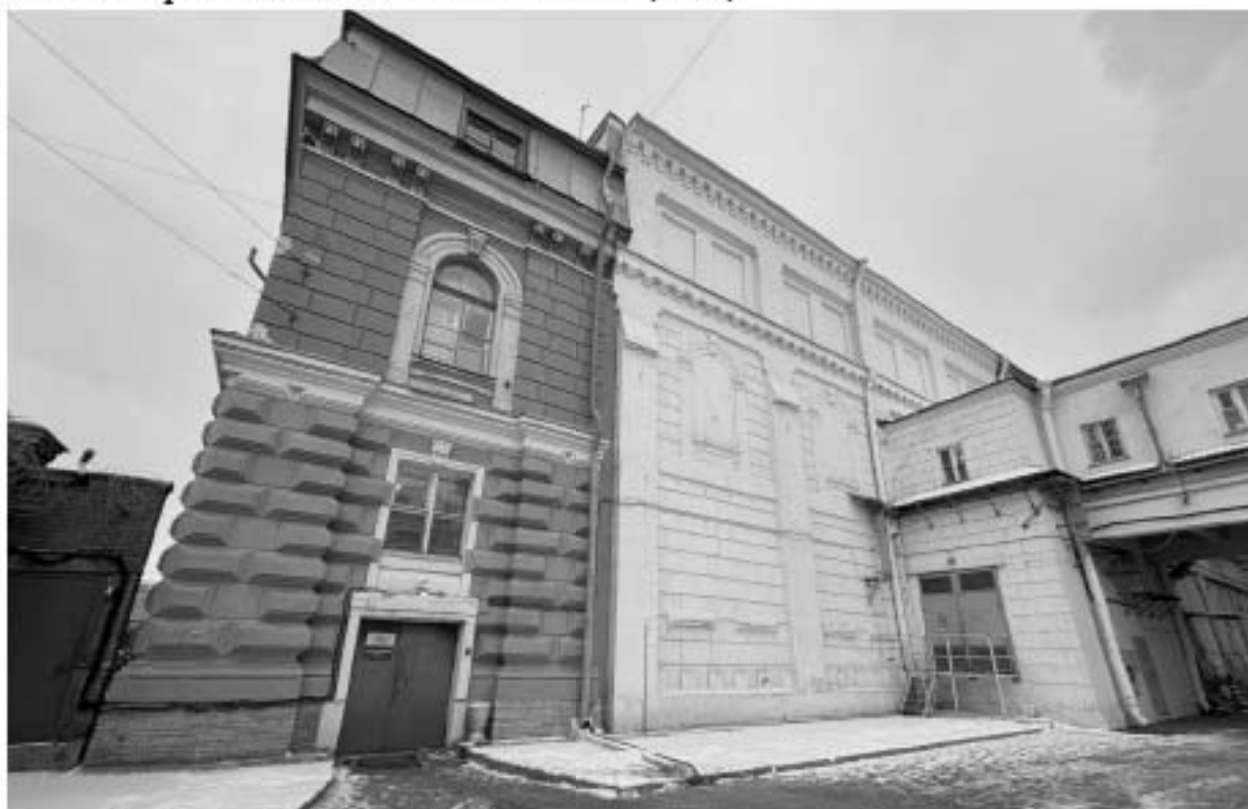
Фото 10. Дворовой фасад объекта культурного наследия «Административное здание и машинный зал».
