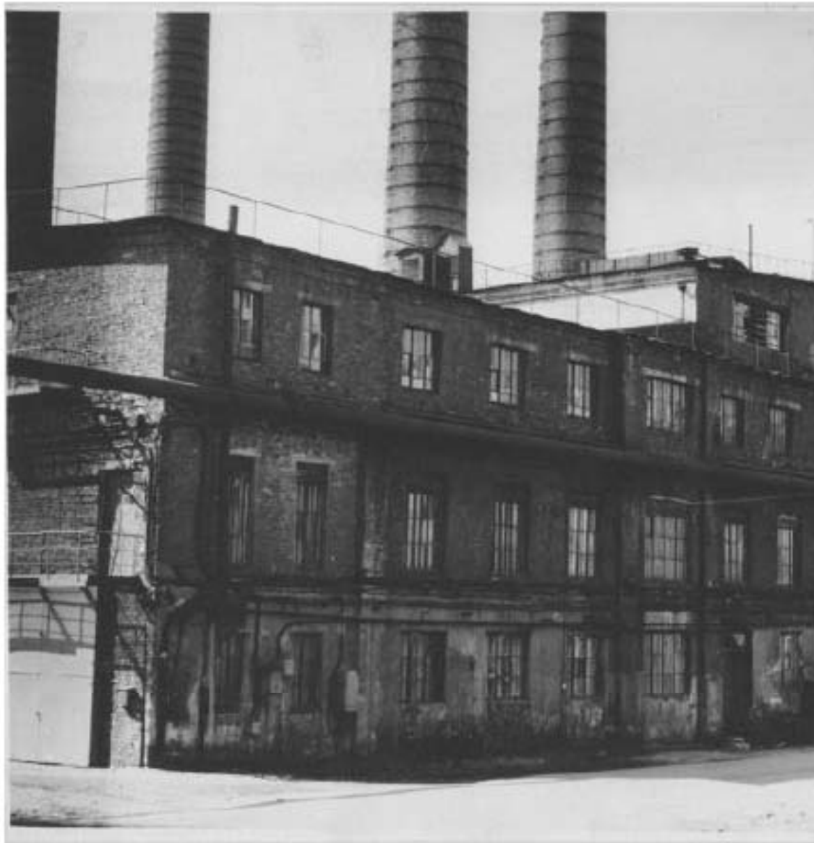
129. Строительство новой котельной. Дата съемки: 1930-е гг. // Ист
