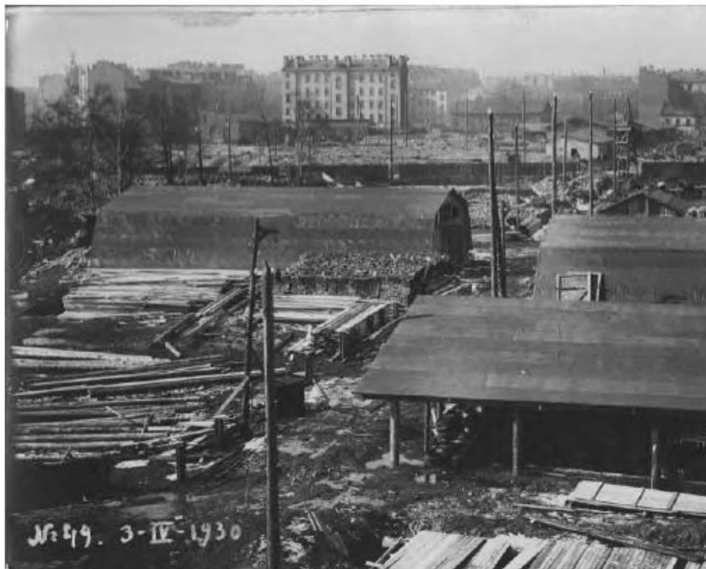
85. Территория электростанции. Дата съемки: 03.04.1930 г. // Источник: Архив
