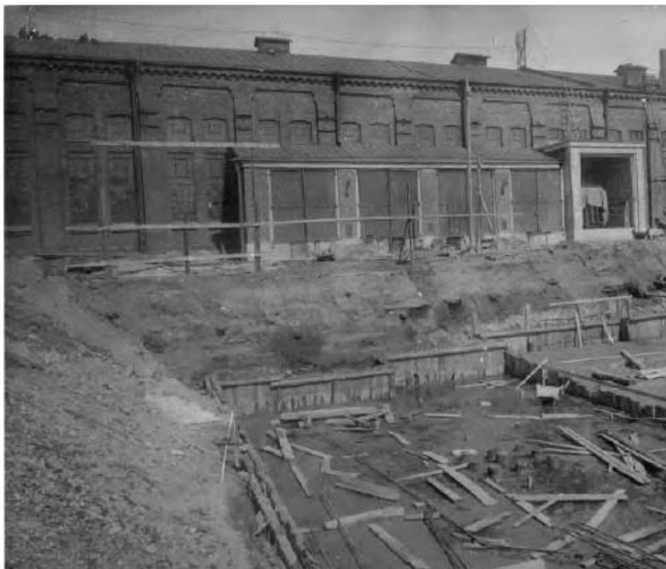
99. Начало строительства новой котельной. Вид на здание машинного отделения Источник: Архив ТЭЦ-2.
