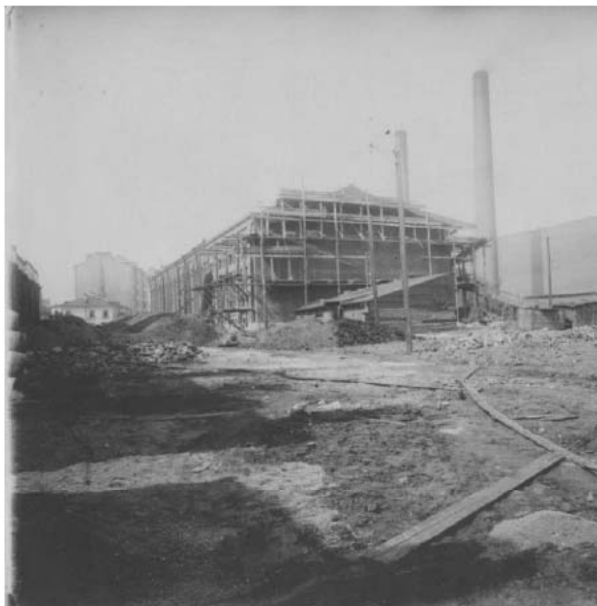
120. Строительство новой котельной. Дата съемки: 1930-е гг. // Исто
