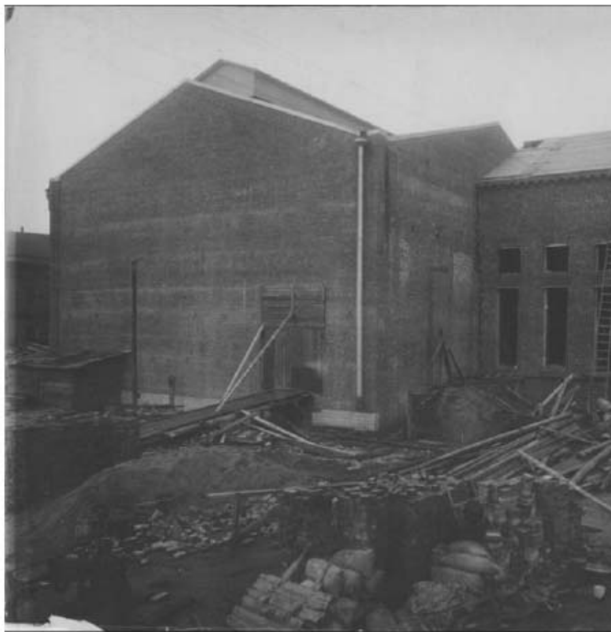
121. Строительство новой котельной. Дата съемки: 1930-е гг. // Исто
