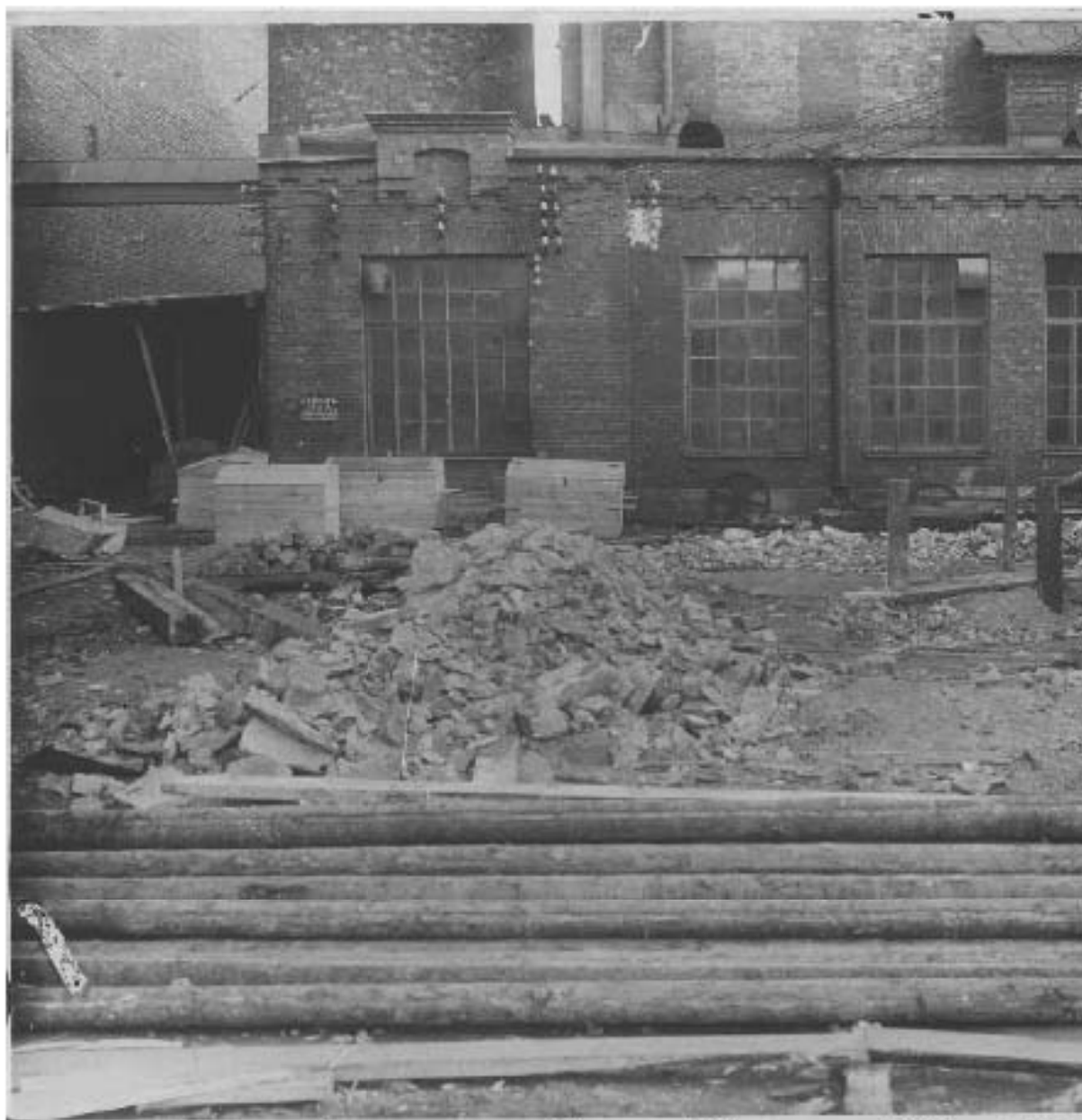
126. Стронтельство новой котельной. Дата съемки: 1930-е гг. // Ист
