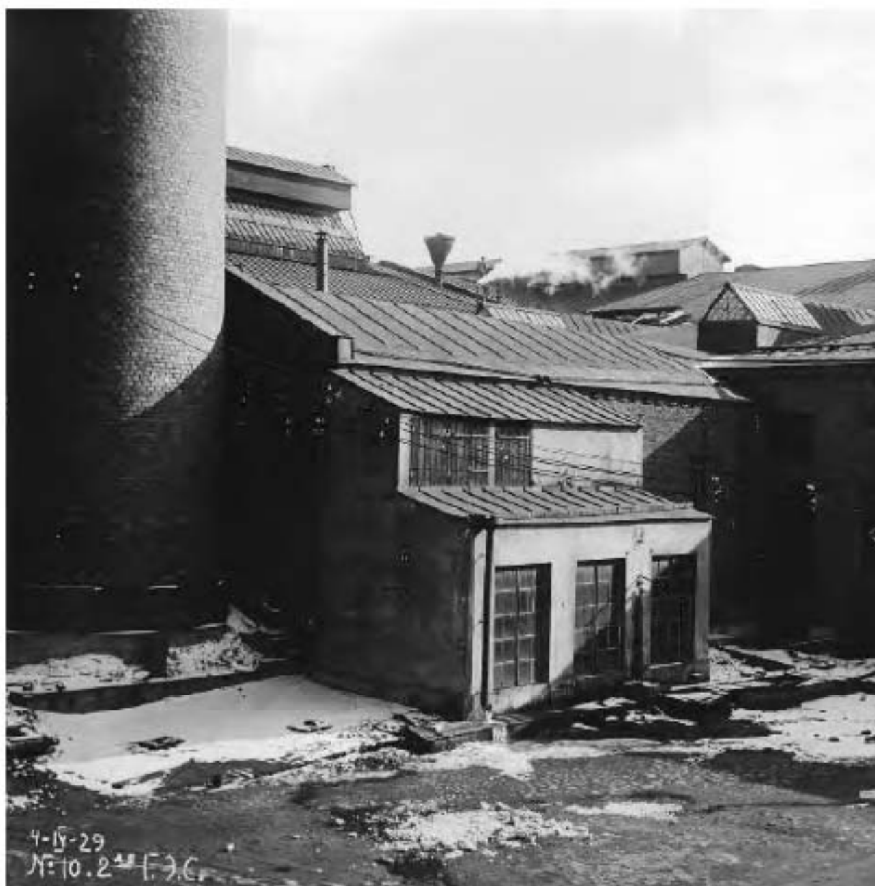
67. Территория электростанции. Дата съемки: 04.04.1929 г. // Источн
