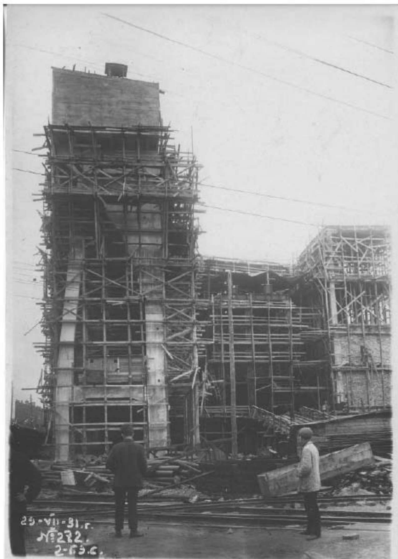
110. Строительство новой котельной. Дата съемки: 29.07.1931 г. // Источник: Архив ТЭЦ-2.
