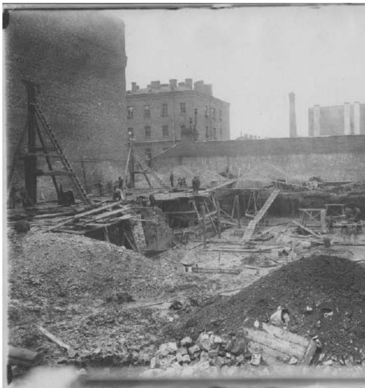
125. Строительство новой котельной. Дата съемки: 1930-е гг. // Ист
