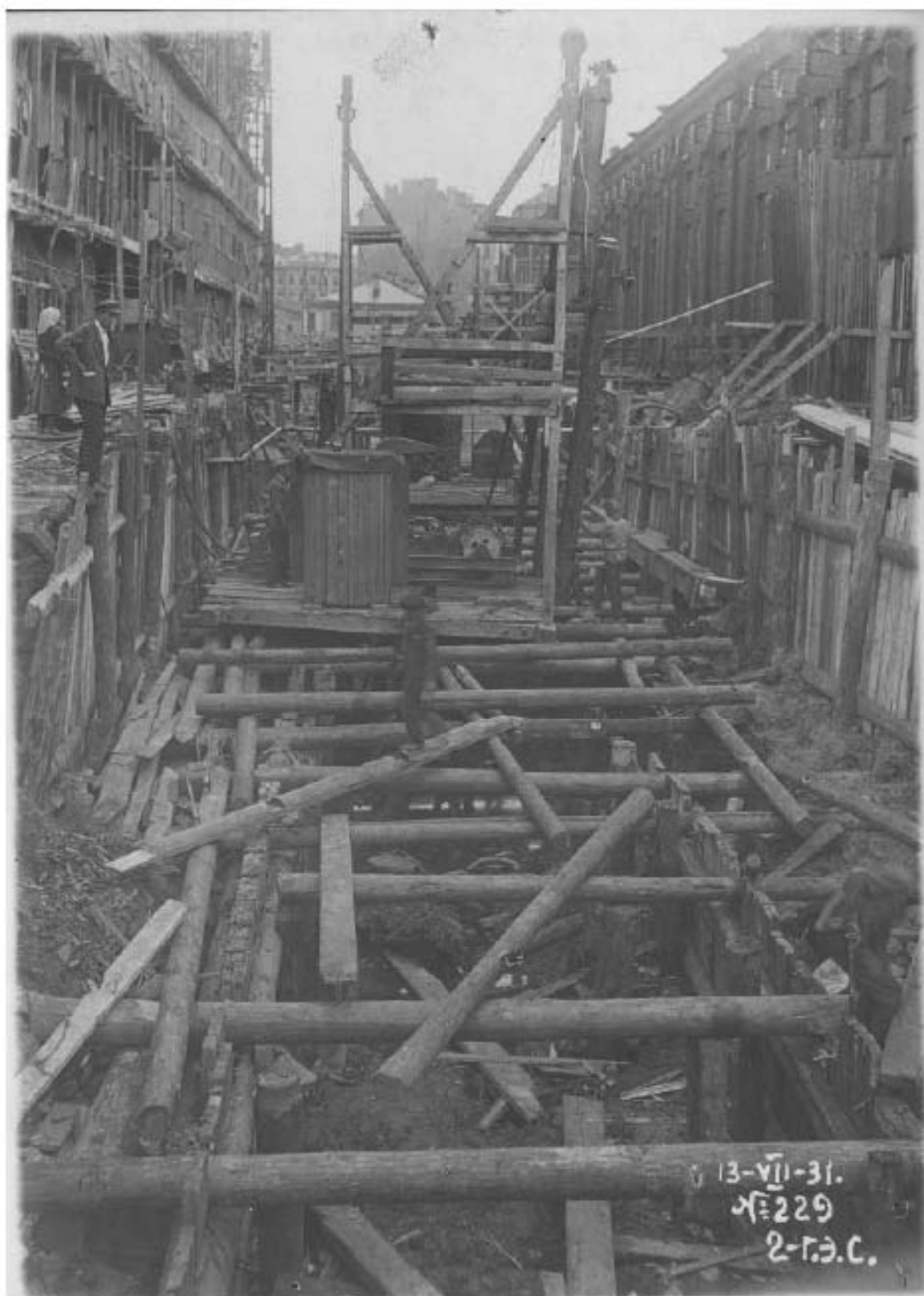
106. Строительство новой котельной. Дата съемки: 13.07.1931 г. // Источник: Архив ТЭЦ-2.
