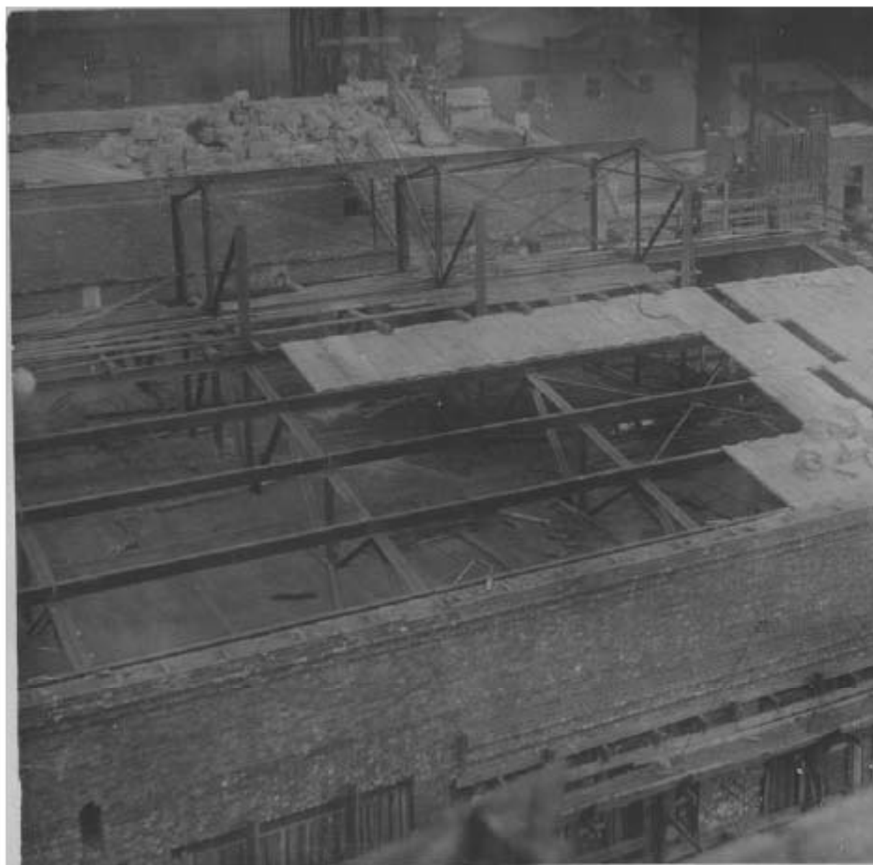
122. Строительство новой котельной. Дата съемки: 1930-е гг. // Источ
