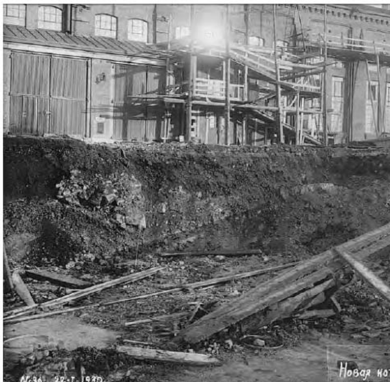
84. Строительство новой котельной 2-й ГЭС. Дата съемки: 28.01.1930 г. // Источник: И
