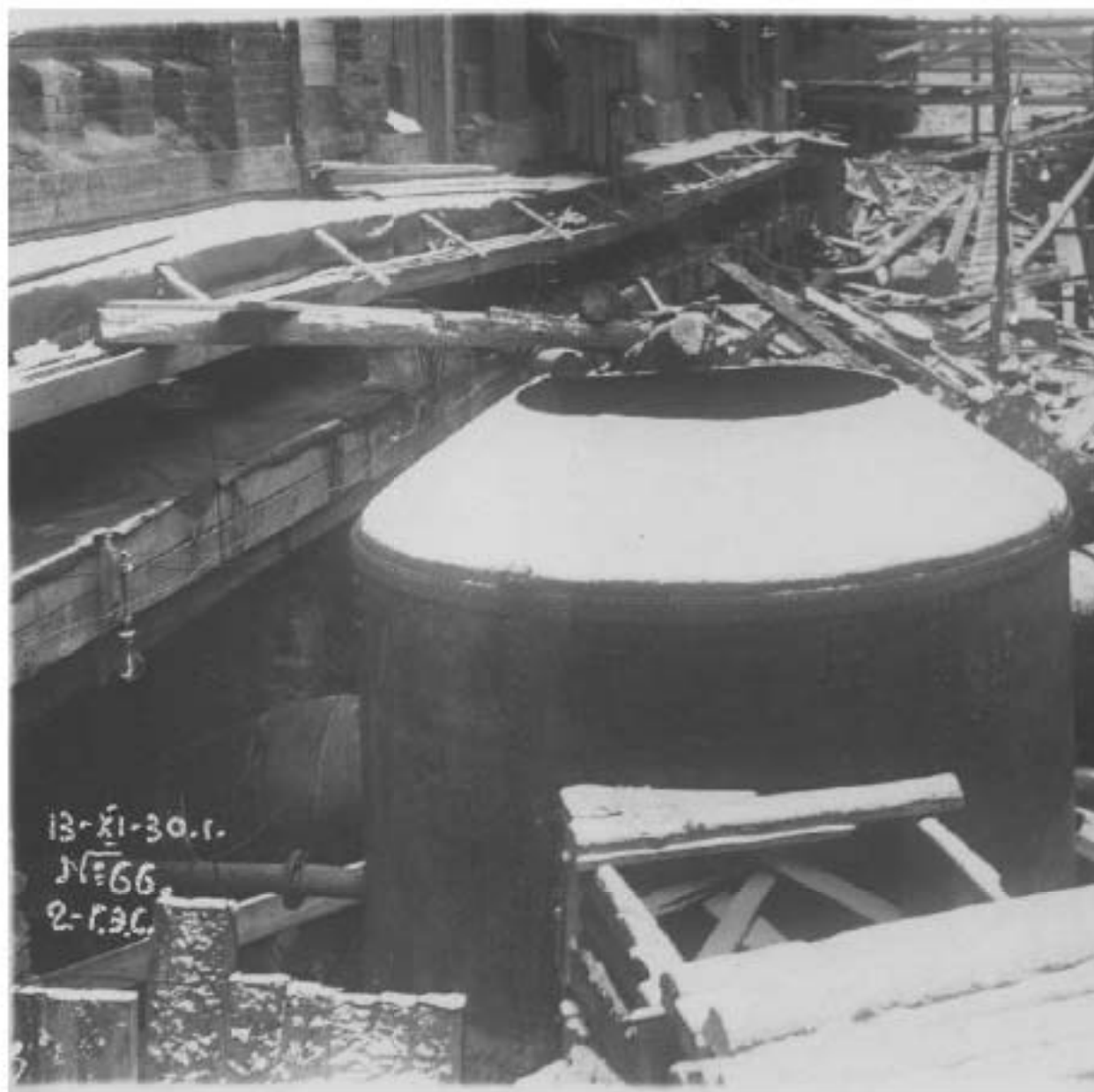
101. Строительство новой котельной. Дата съемки: 13.11.1930 г. // Исто
