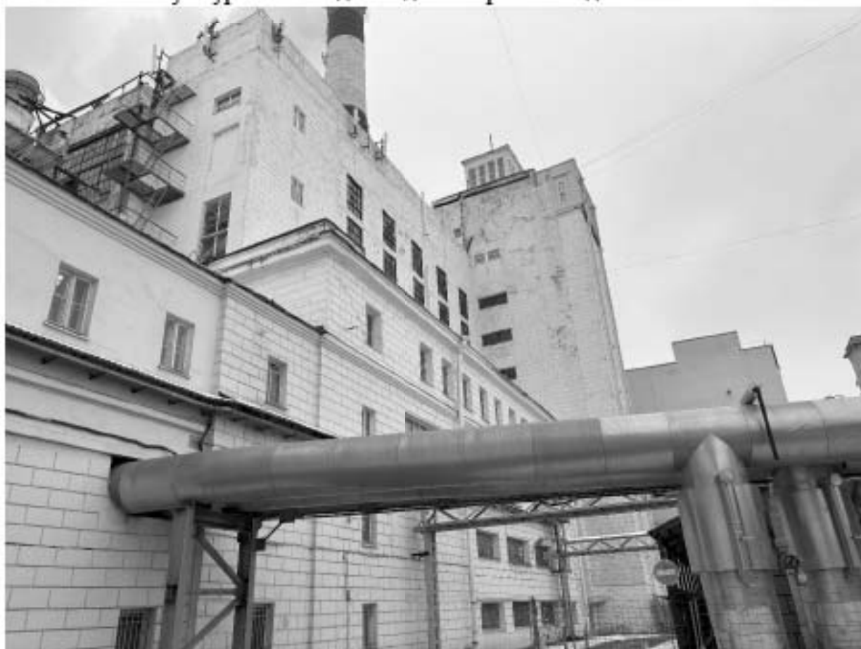
Фото 8. Лицевой фасад объекта культурного наследия «Котельная ТЭЦ».
