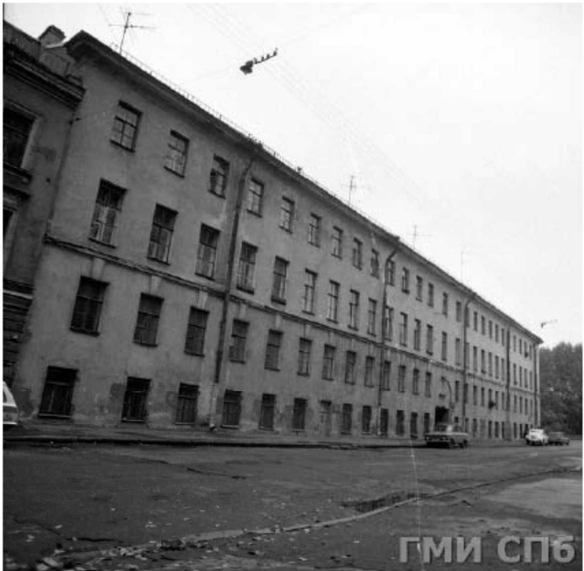
Илл. 34. Дома, идущие на капитальный ремонт по Генеральному плану реконструкции города. Мясная улица. 1990 г. СПб ГБУК «Государственный музей истории Санкт-Петербурга». ГМИ СПб Инв. №-П-Б-20645 н.
