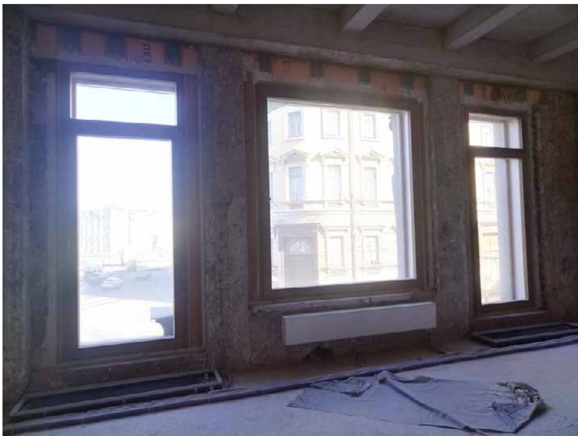
6. Помещение 39/63,1. Дата съемки: 20.05.2025 г.
