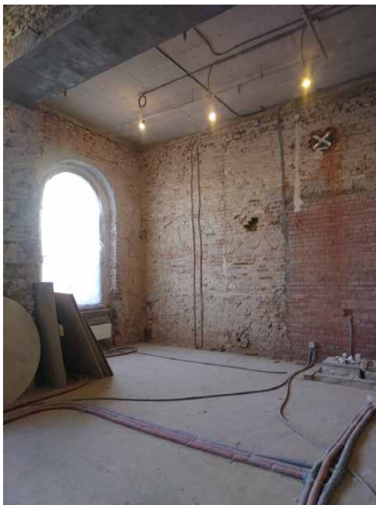
19. Помещение 23/107.7. Дата съемки: 20.04.2025 г.
