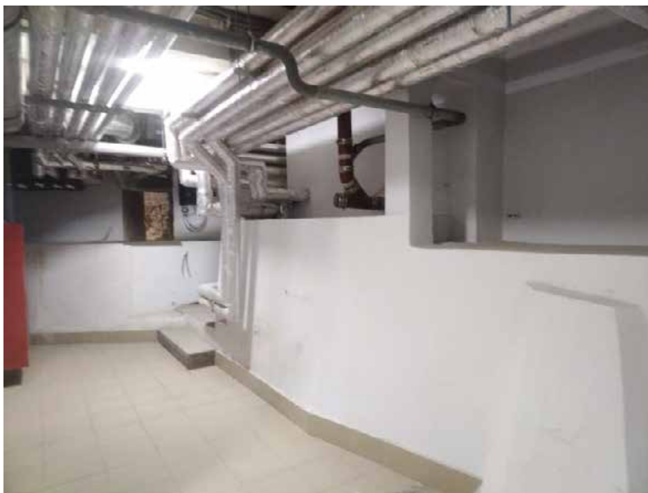
5. Помещение 1нч/104, 0. Коридор. Дата съемки: 20.04.2025 г.
