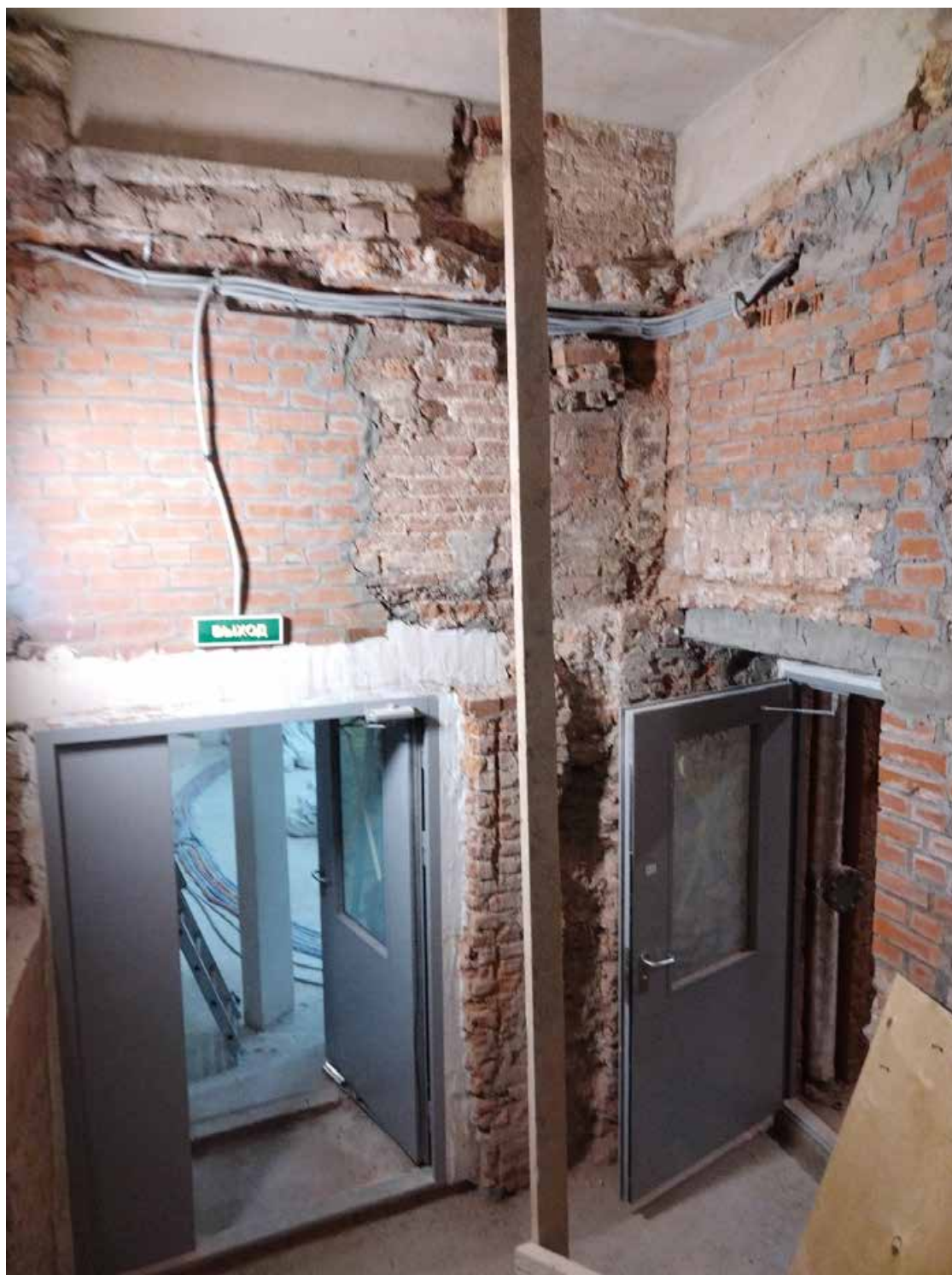
1. Площадка 1 этажа. Дата съемки: 20.04.2025 г.
