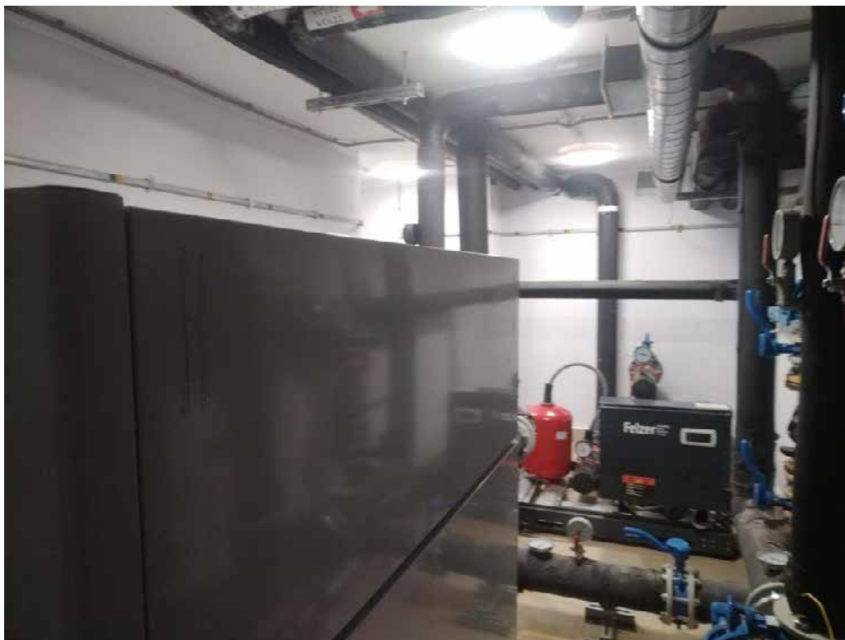
23. Помещение 1/15,6. Дата съемки: 20.04.2025 г.
