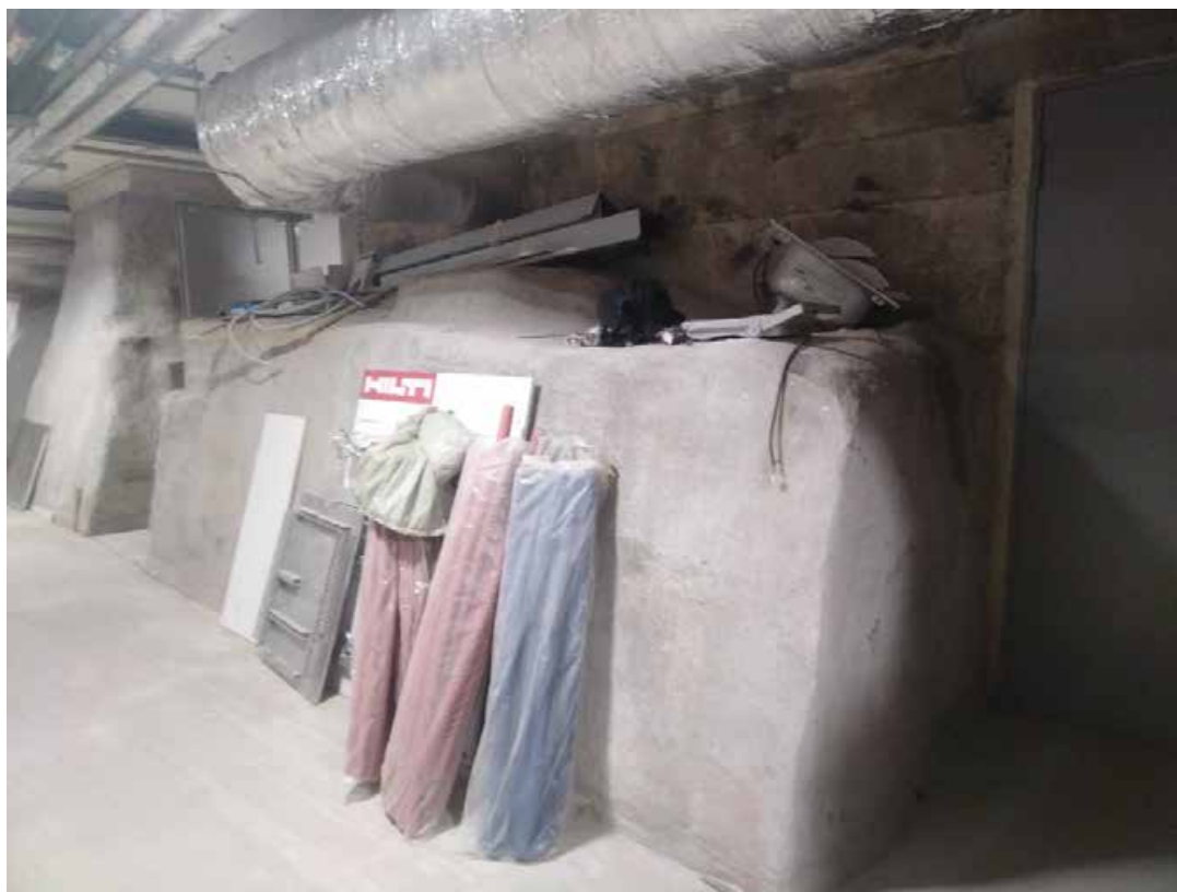
10. Помещение 1нч/104, 0. Коридор. Дата съемки: 20.04.2025 г.
