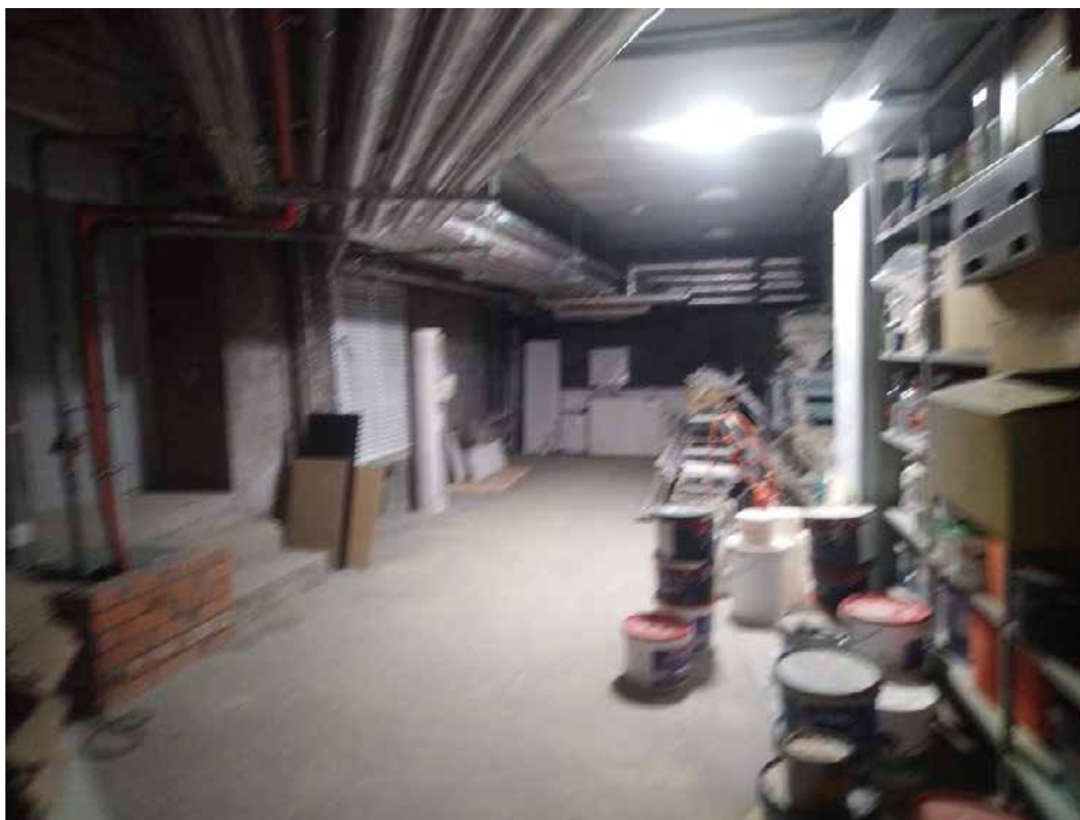
16. Помещение 7нч/37,1. Коридор. Дата съемки: 20.04.2025 г.
