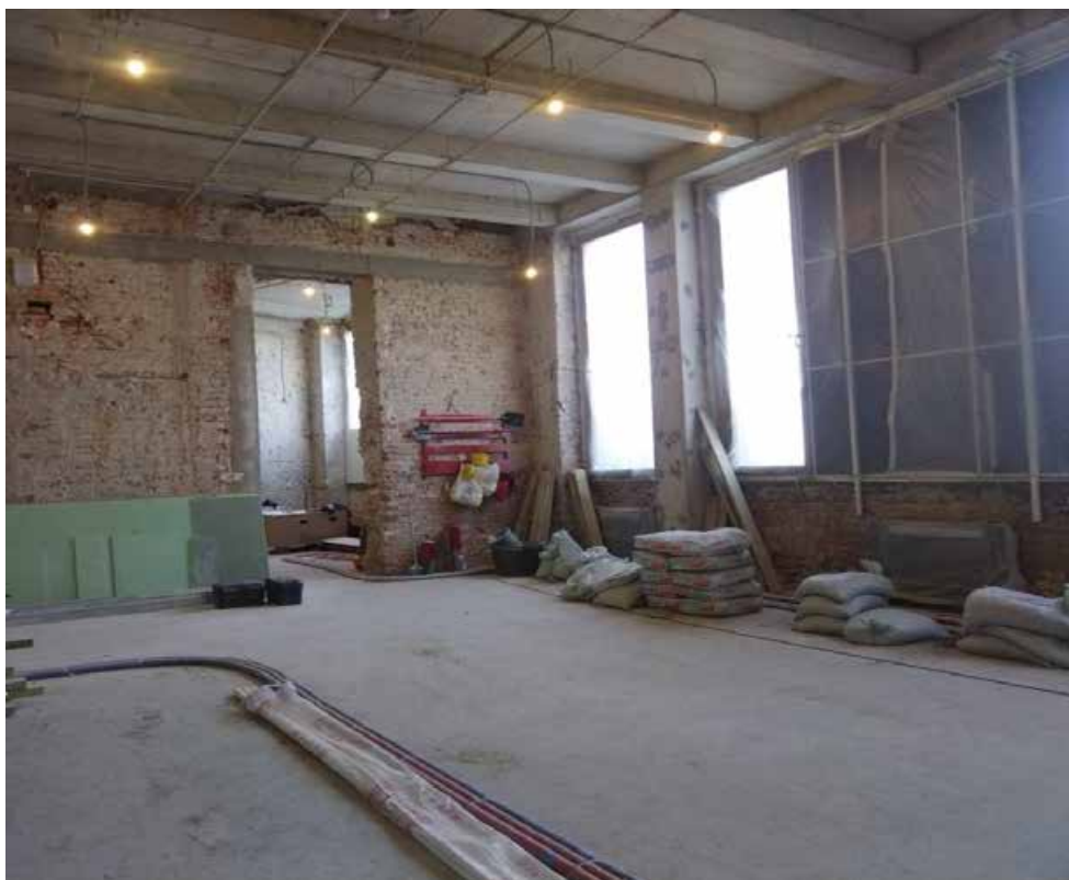
18. Помещение 23/107.7. Дата съемки: 20.04.2025 г.
