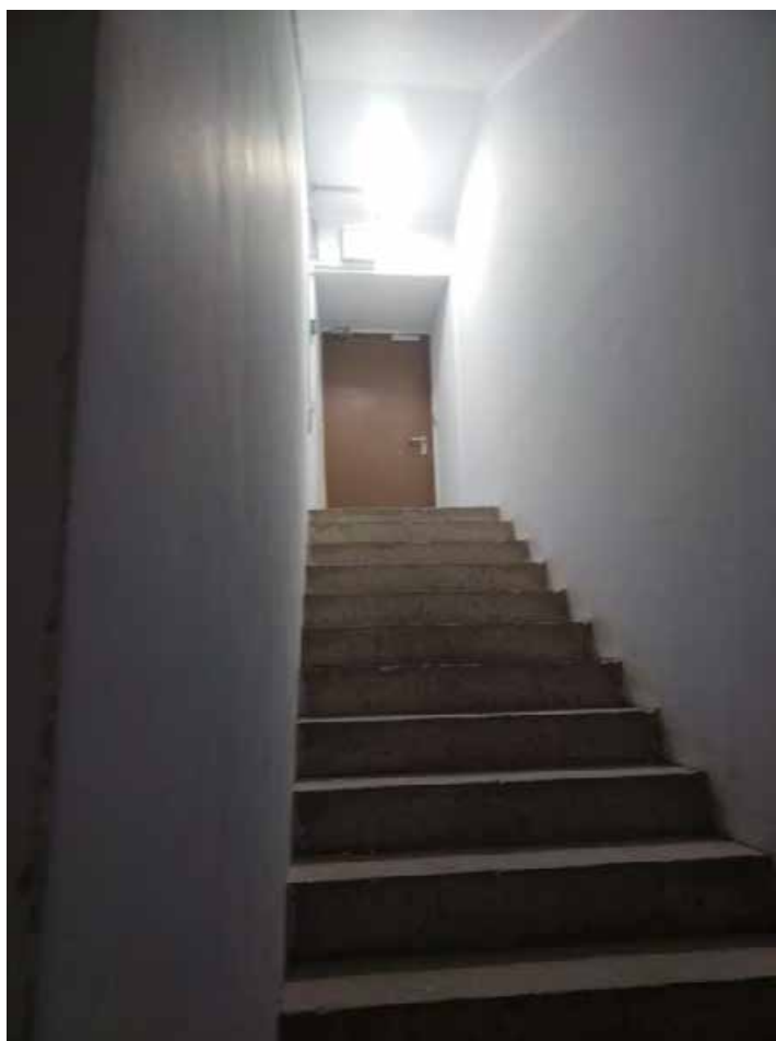
28. Лестница. Дата съемки: 20.04.2025 г.
