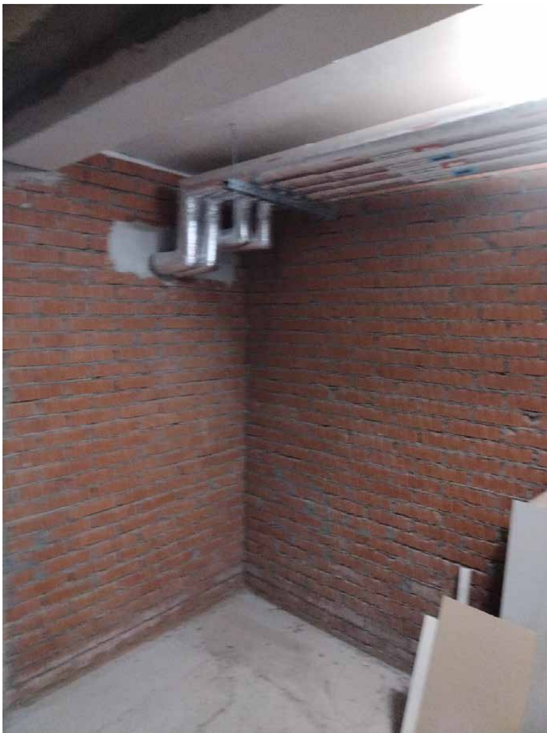
29. Помещение 1/20,2. Дата съемки: 20.04.2025 г.
