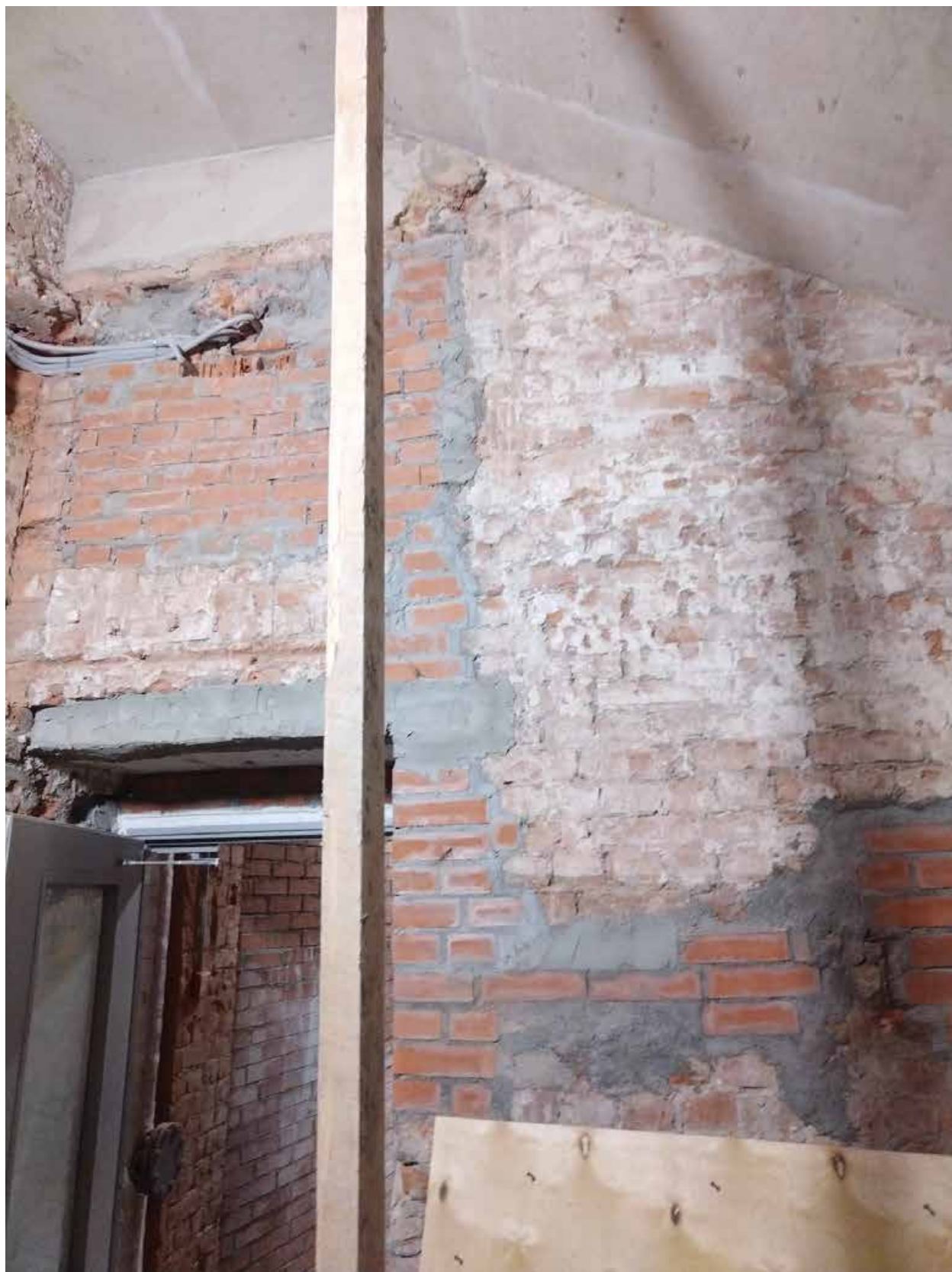
4. Проем в уровне 2 этажа.
