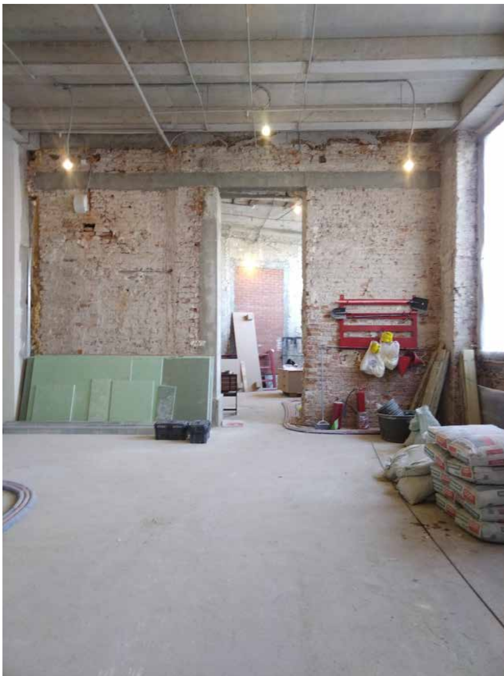
21. Помещение 24/41, 3. Дата съемки: 20.04.2025 г.
