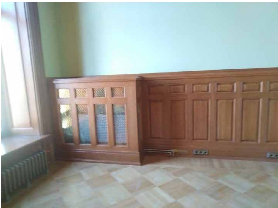
5. Помещение 66/58,0. Обшивка стен деревянными панелями. Дата съемки: 20.04.2025 г.
