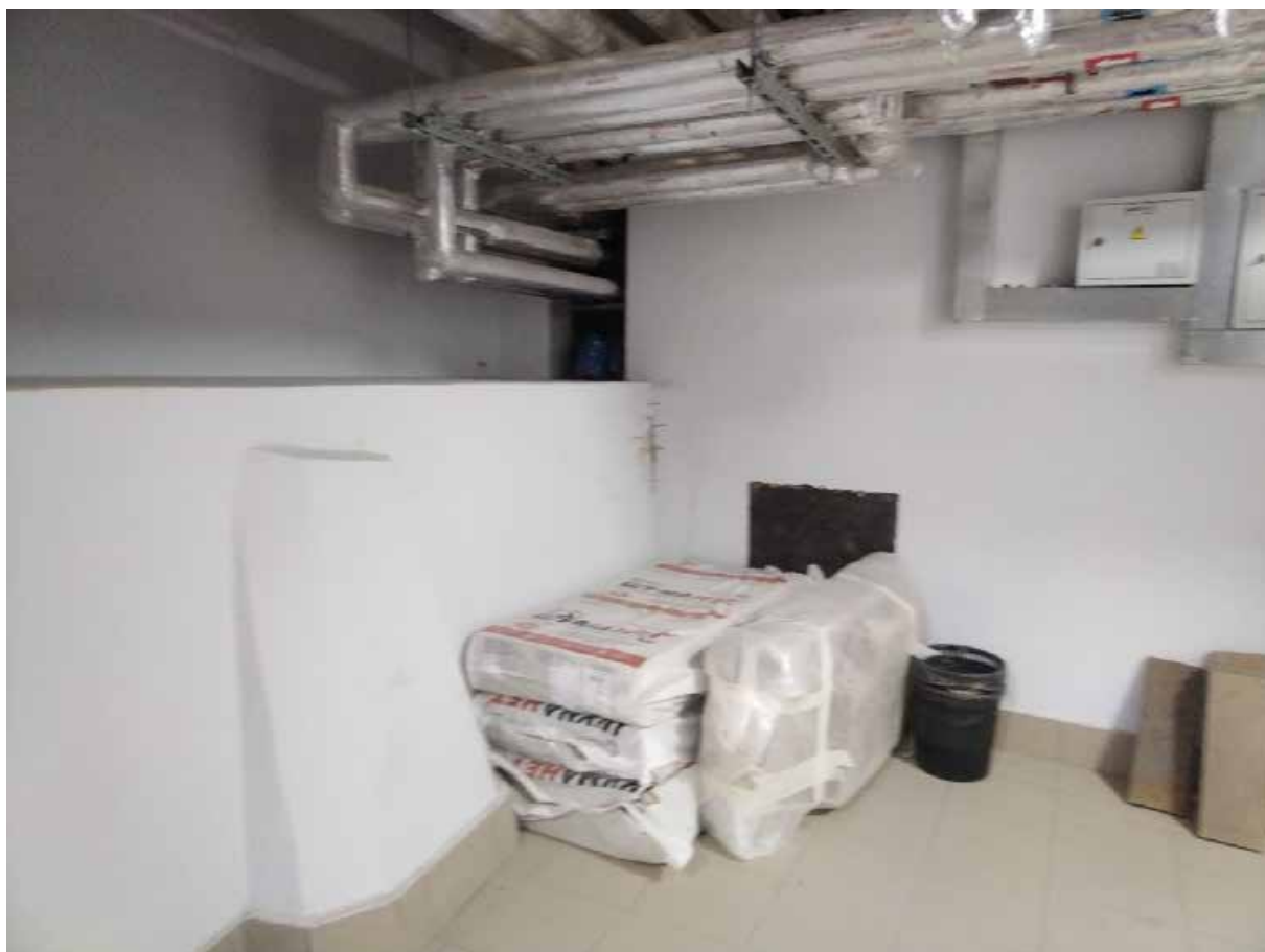
8. Помещение 1нч/104, 0. Коридор. Дата съемки: 20.04.2025 г.
