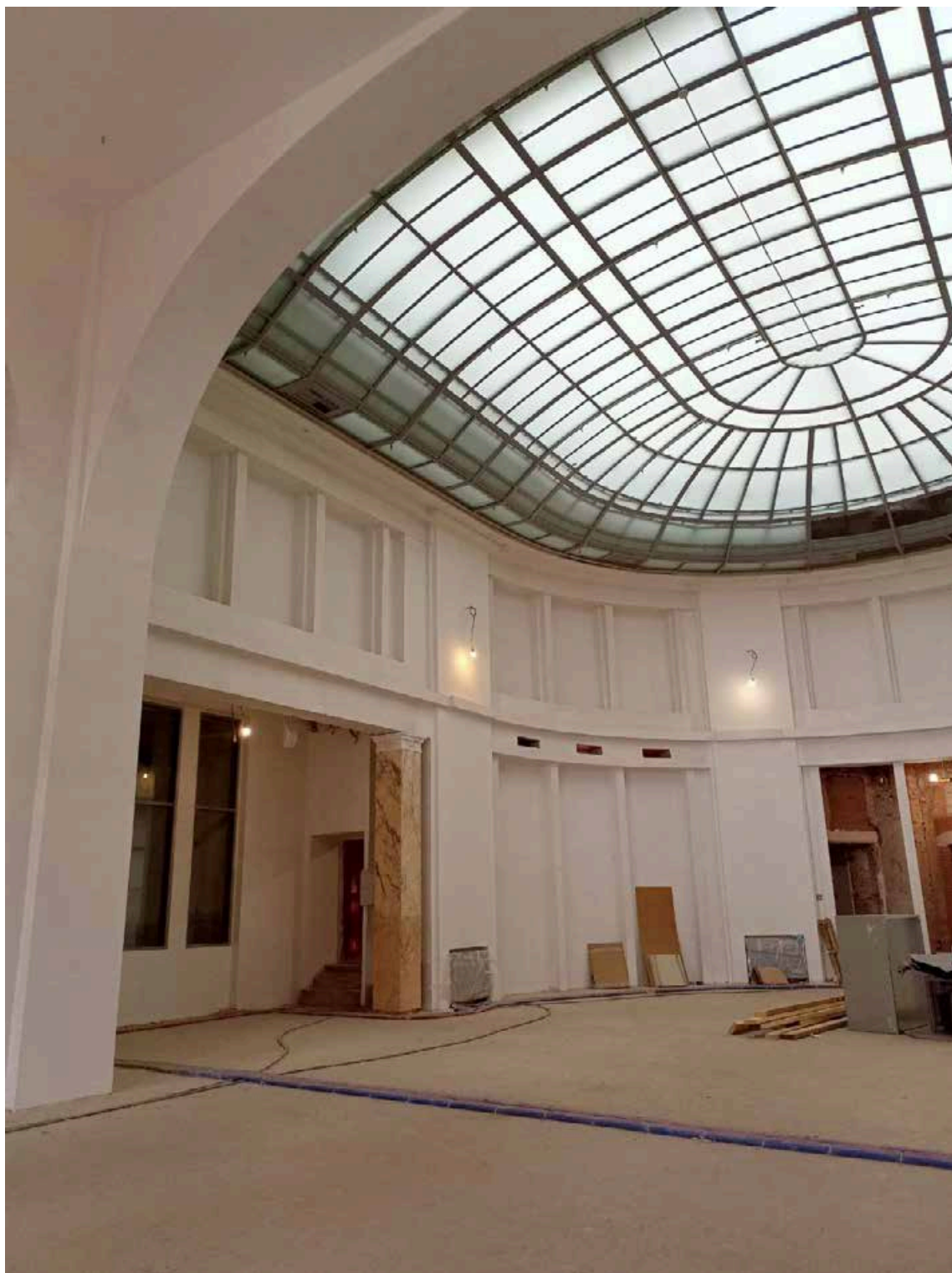
4. «Операционный зал». Помещение № 10/184.5. Дата съемки: 11.02.2025 г.
