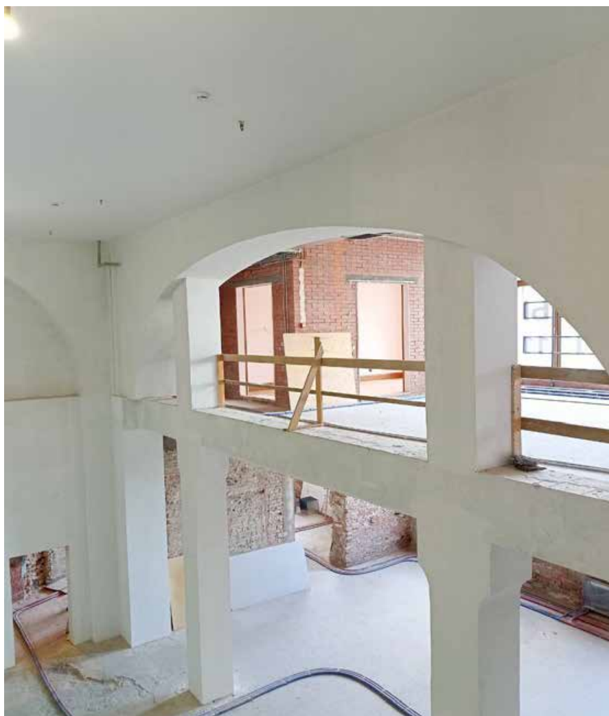
2. Помещение 27/21,2. Вид в сторону «Операционного зала». Дата съемки: 20.05.2025 г.
