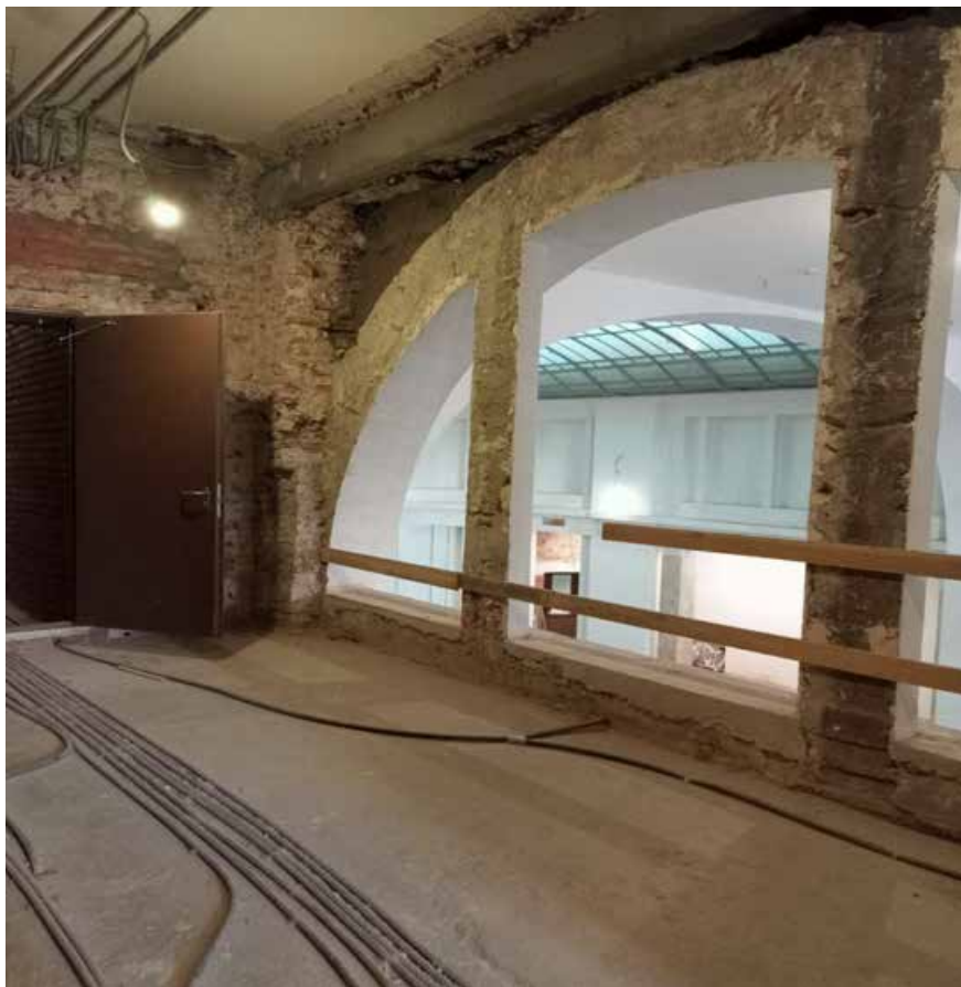
1. Помещение 27/21,2. Дата съемки: 20.05.2025 г.
