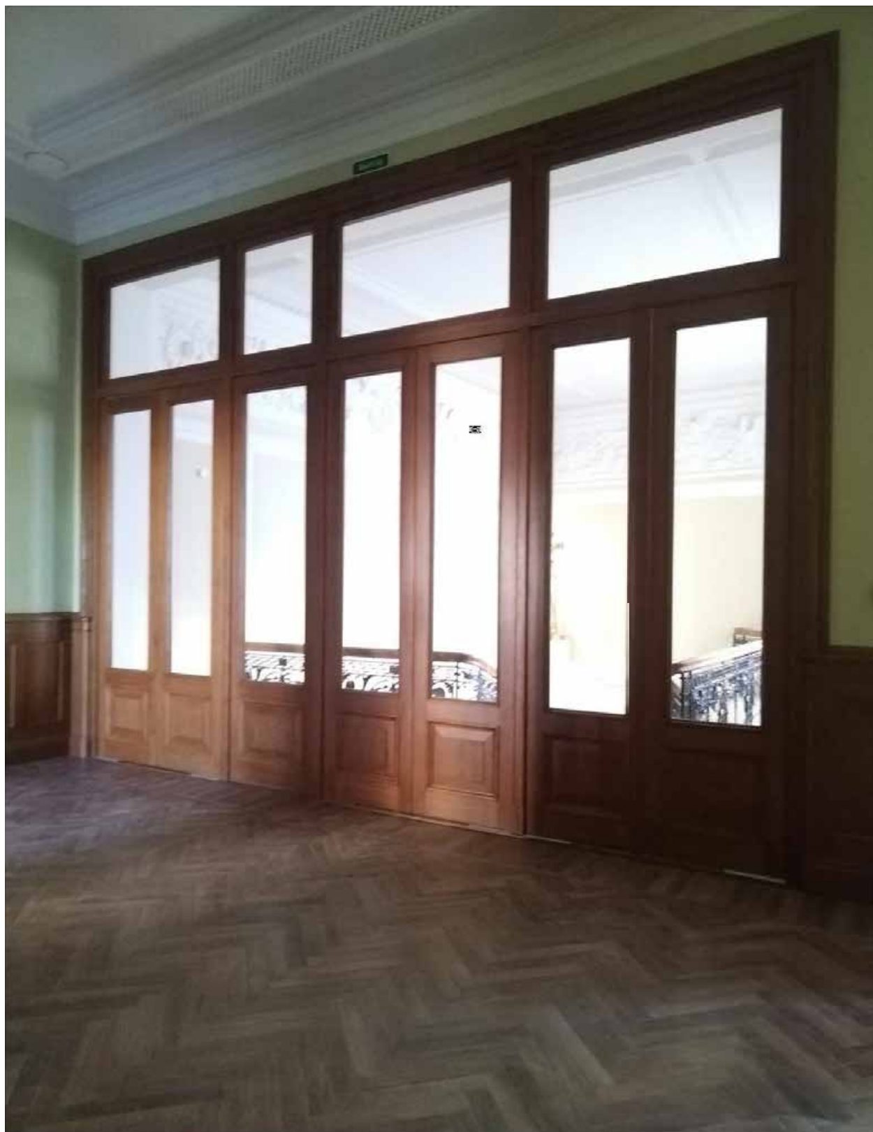
2. Помещение 53/65,7. Перегородка. Дата съемки: 20.04.2025 г.
