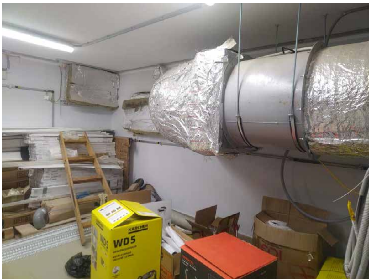
20. Помещение 1/33,9. Дата съемки: 20.04.2025 г.
