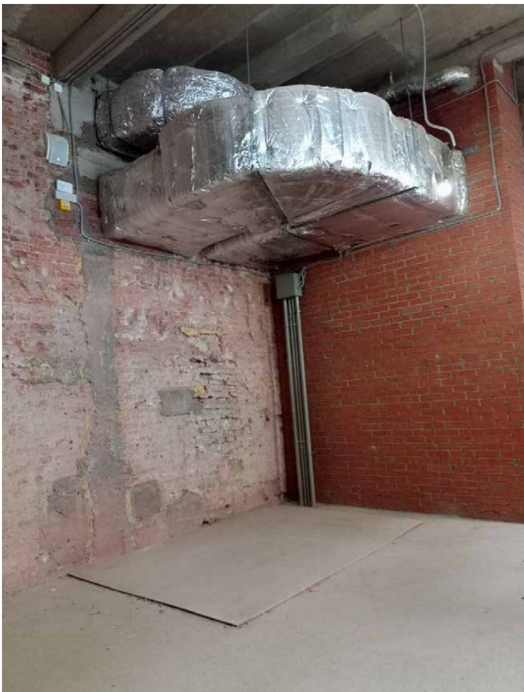
9. Помещение 69/46, 1. Дата съемки: 20.04.2025 г.
