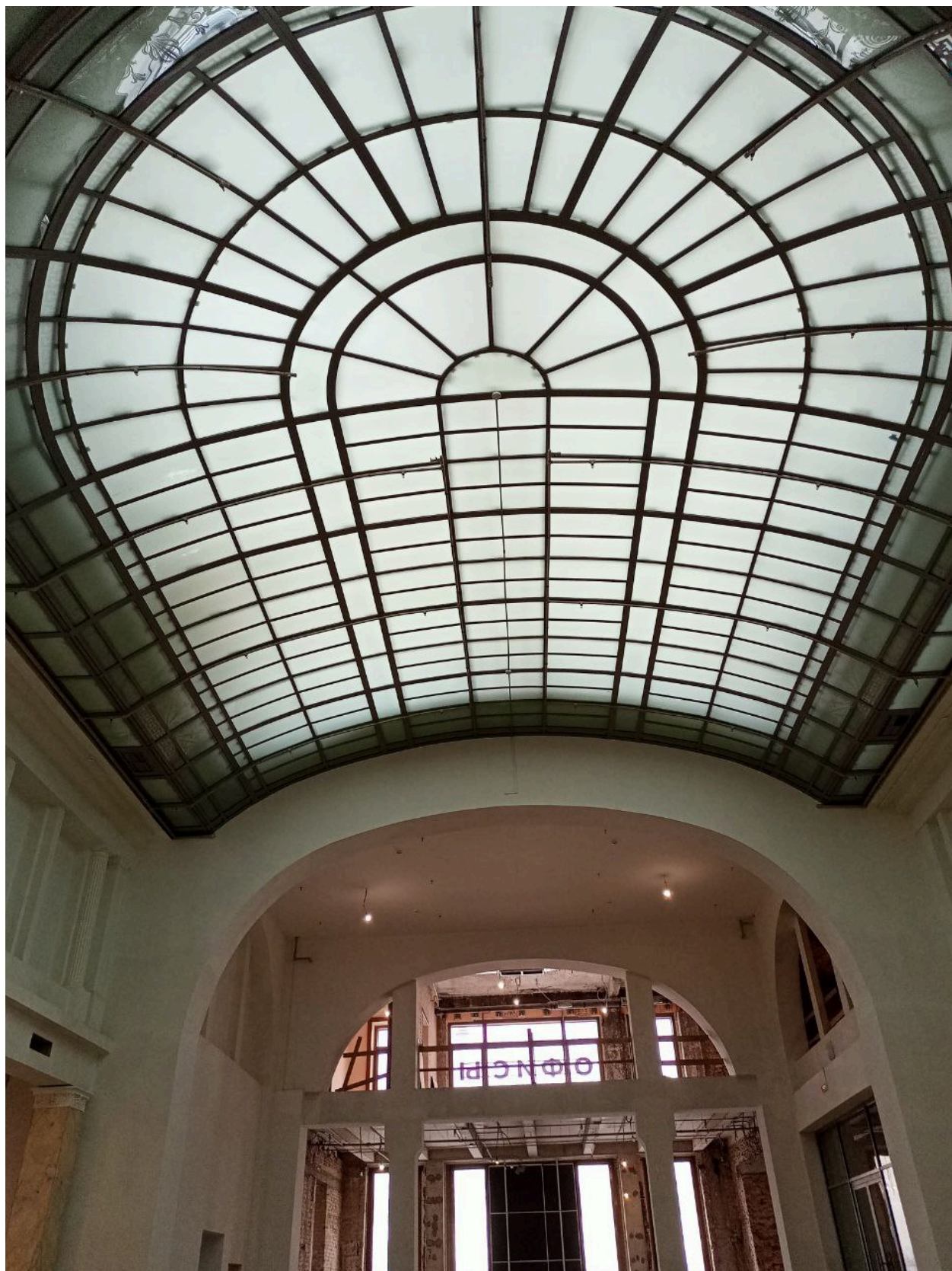
6. «Операционный зал». Помещение № 10/184.5. Дата съемки: 11.02.2025
