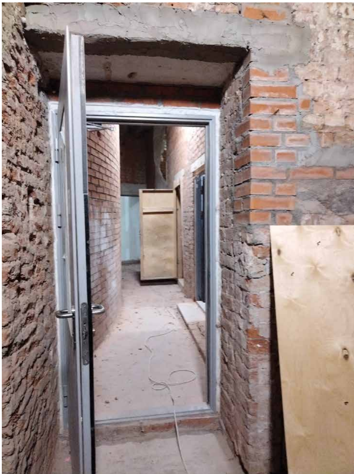
1. Вид из помещения Л-4 в сторону пом. 15/14,1. Дата съемки: 20.04.2025 г.
