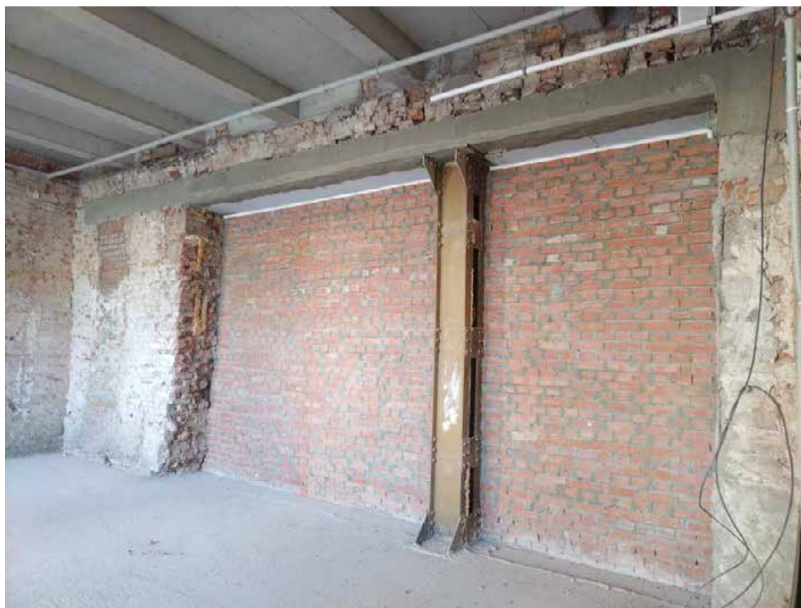
5. Помещение 39/63,1. Дата съемки: 20.05.2025 г.
