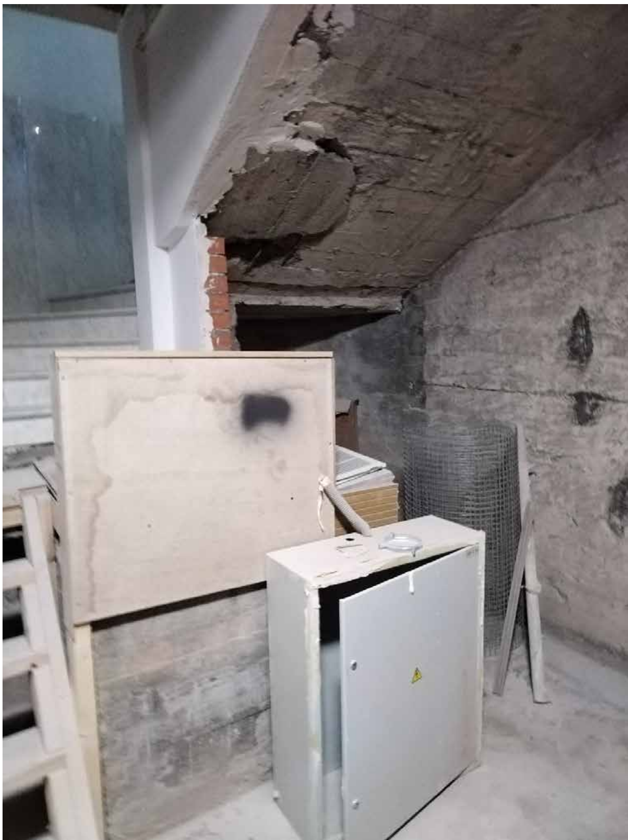
31. Помещение 1/20,2. Дата съемки: 20.04.2025 г.
