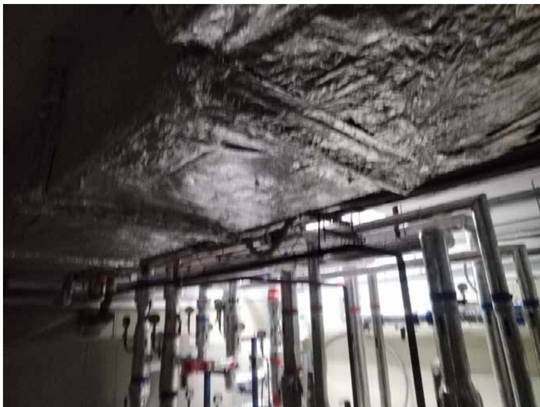
27. Помещение 1/23,6. Дата съемки: 20.04.2025 г.
