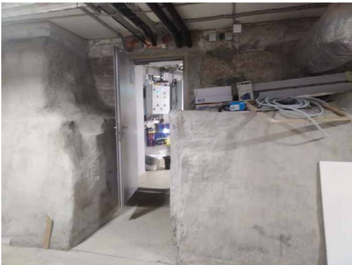
25. Помещение 1нч/104,0. Коридор. Дата съемки: 20.04.2025 г.
