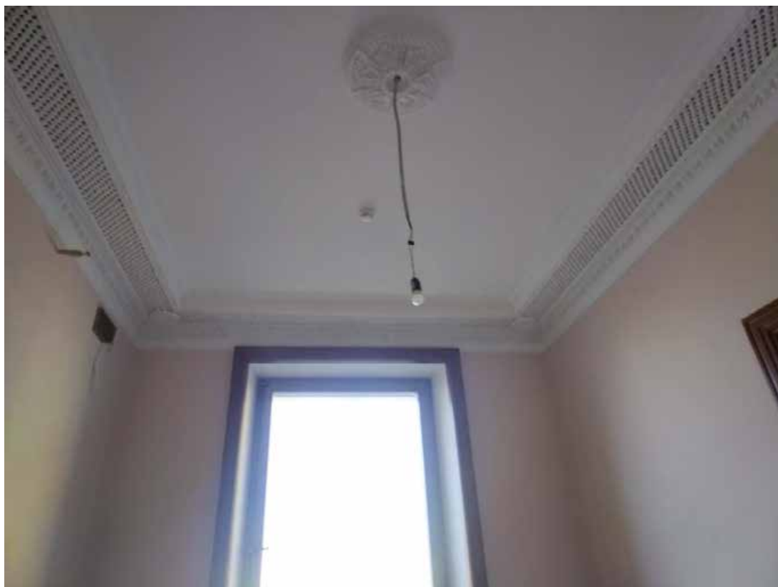
4. Помещение 37/19,9. Оконный проем. Дата съемки: 20.05.2025 г.
