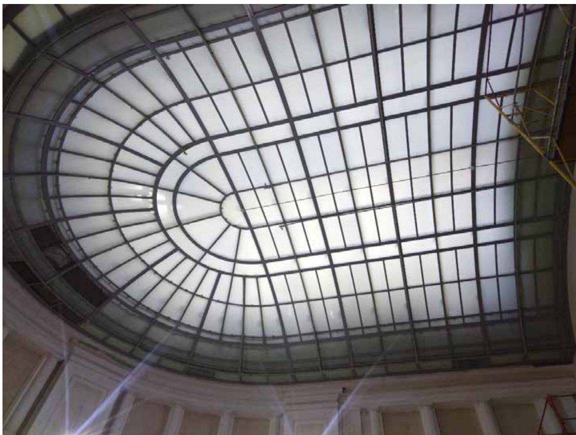
3. «Операционный зал». Помещение № 10/184.5. Фонарь. Дата съемки: 20.04.2025
