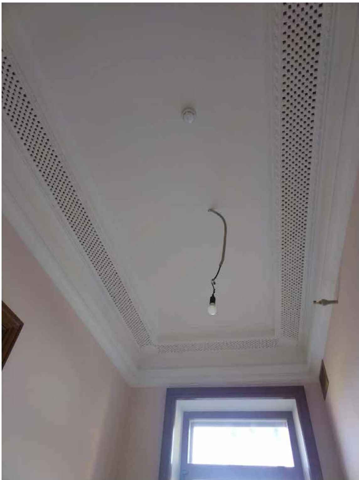
10. Помещение 40/12,5. Дата съемки: 20.05.2025 г.
