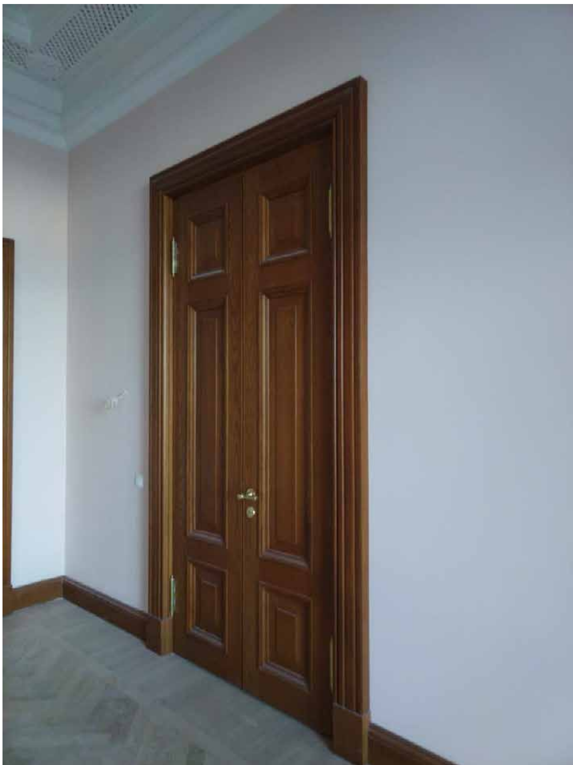
14. Помещение 40/12,5. Дата съемки: 20.05.2025 г.
