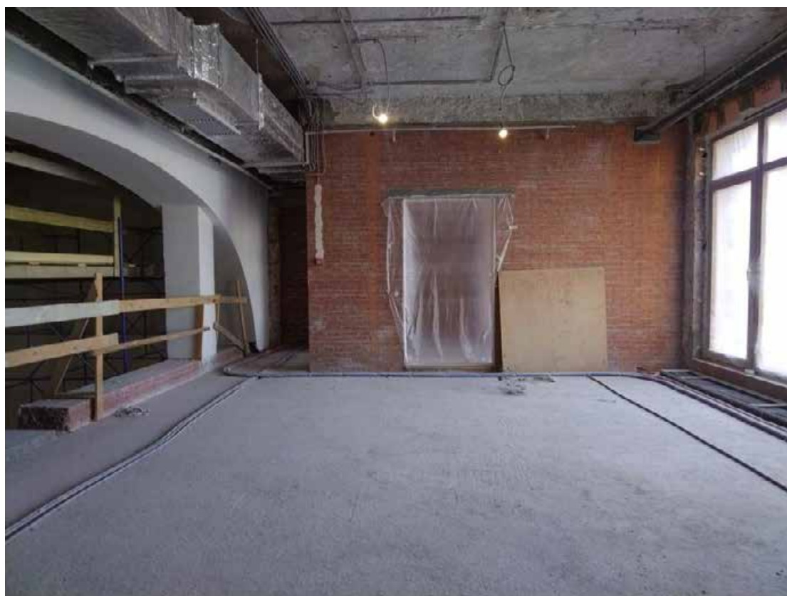
7. Помещение 39/63,1. Дата съемки: 20.05.2025 г.
