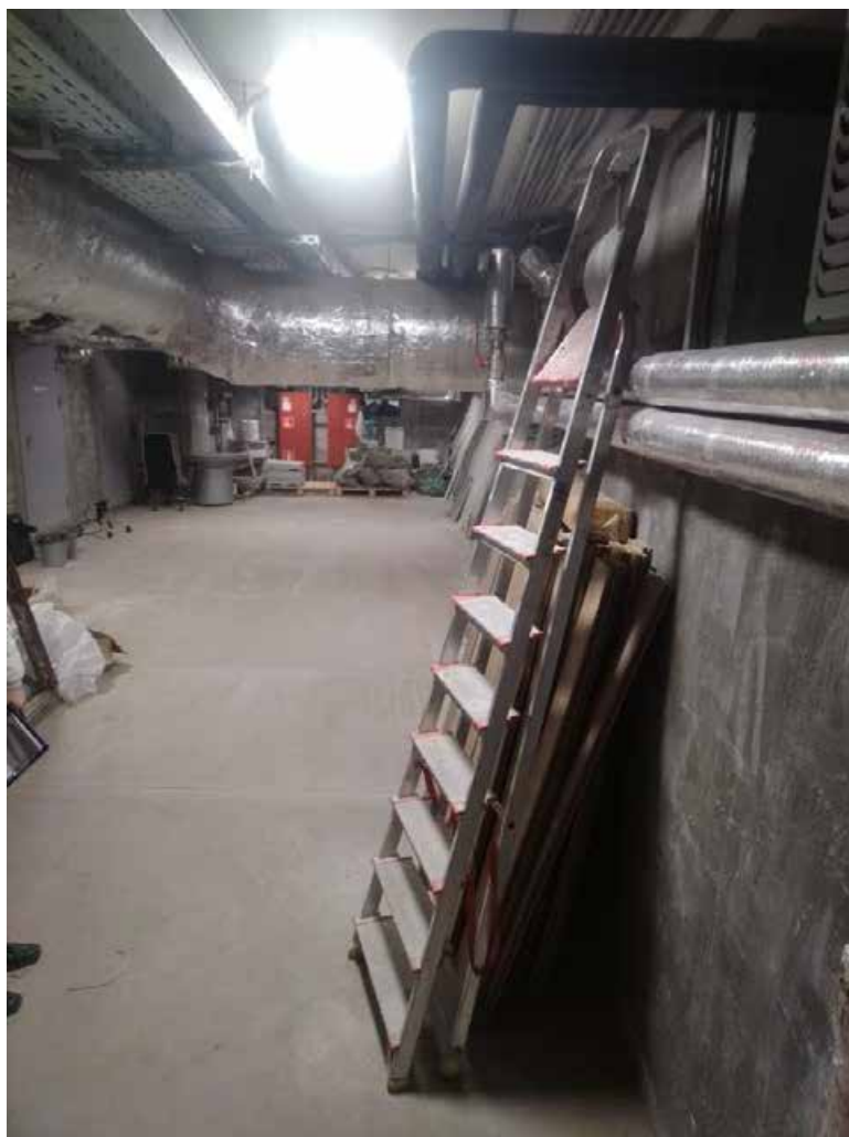
11. Помещение 1нч/104, 0. Коридор. Дата съемки: 20.04.2025 г.
