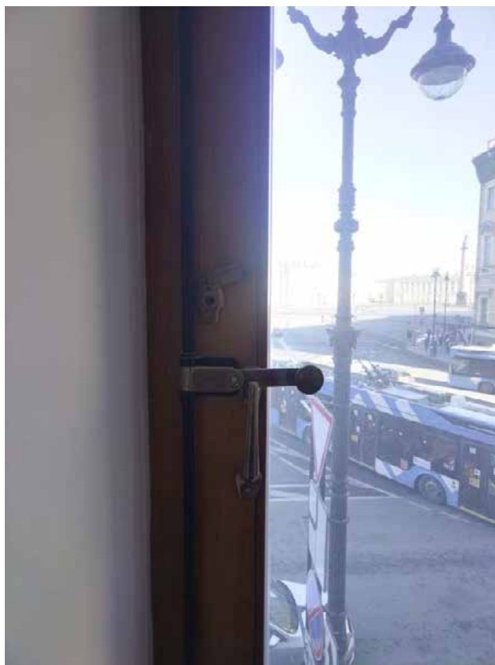
12. Помещение 40/12,5. Дата съемки: 20.05.2025 г.
