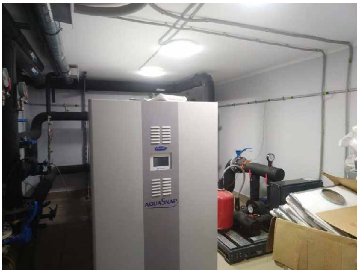
22. Помещение 1/17,7. Дата съемки: 20.04.2025 г.
