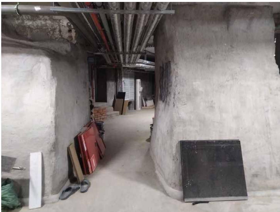
15. Помещение 1нч/104, 0. Коридор. Дата съемки: 20.04.2025 г.
