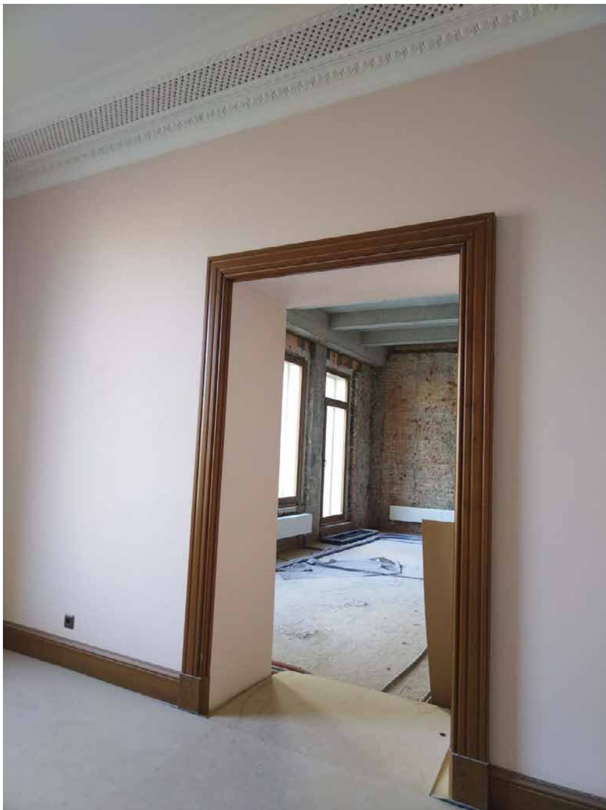
3. Помещение 37/19,9. Проем с помещением 39/63,1. Дата съемки: 20.05.2025 г.
