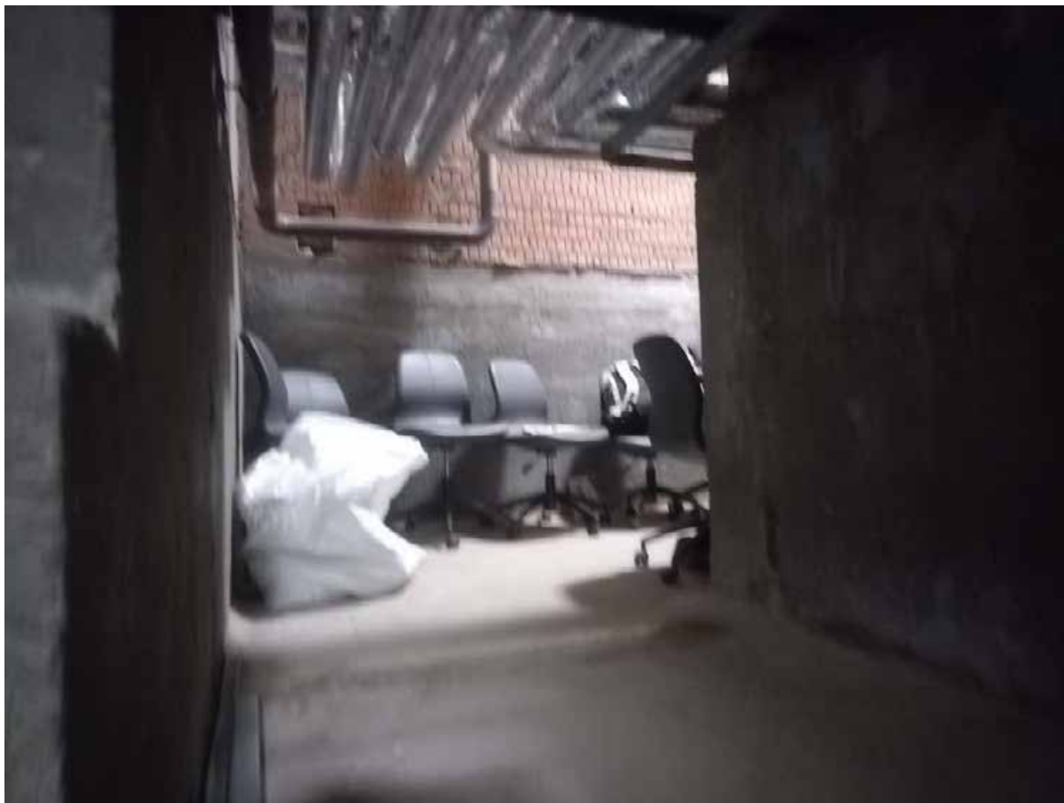
17. Помещение 7нч/37,1. Коридор. Дата съемки: 20.04.2025 г.
