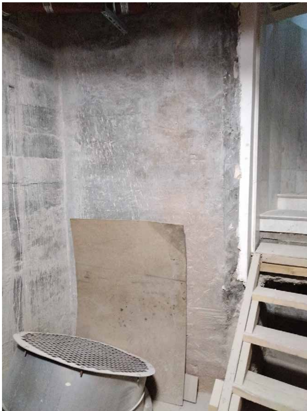
30. Помещение 1/20,2. Дата съемки: 20.04.2025 г.
