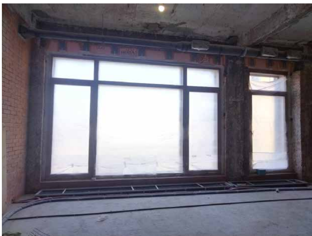
9. Помещение 39/63,1. Дата съемки: 20.05.2025 г.
