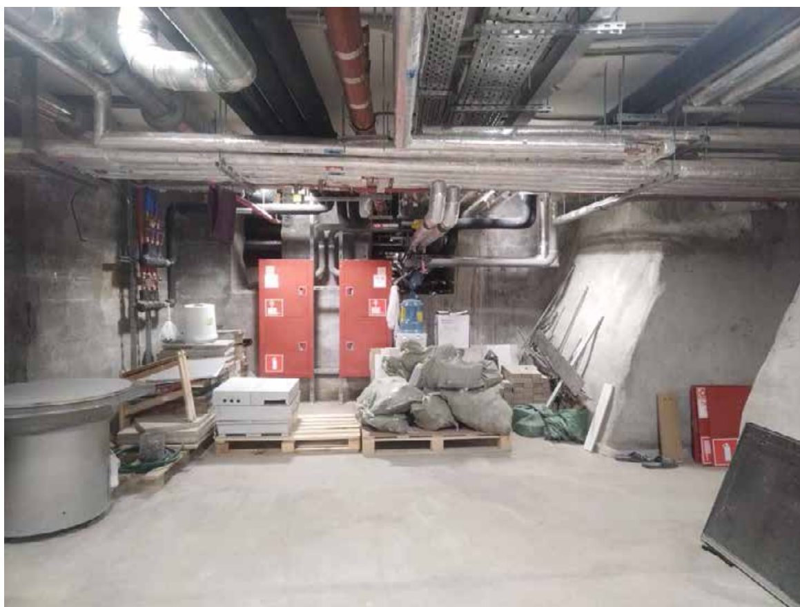
14. Помещение 1нч/104, 0. Коридор. Дата съемки: 20.04.2025 г.
