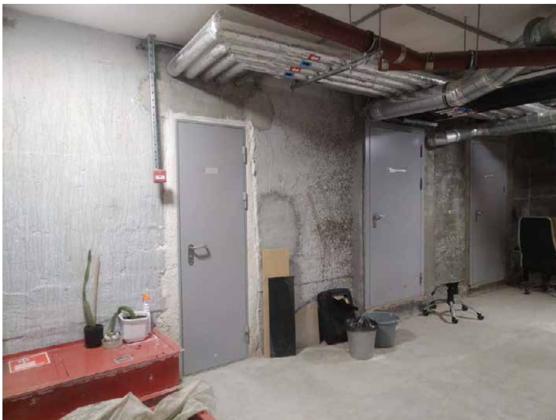
13. Помещение 1нч/104, 0. Коридор. Дата съемки: 20.04.2025 г.
