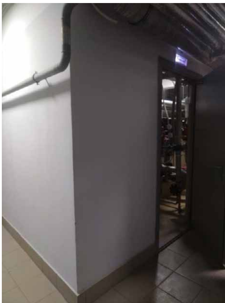
6. Помещение 1нч/104, 0. Коридор. Дата съемки: 20.04.2025 г.
