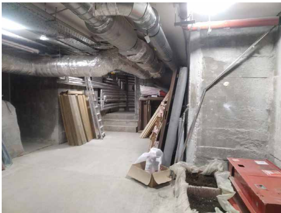
24. Помещение 1нч/104,0. Коридор. Дата съемки: 20.04.2025 г.
