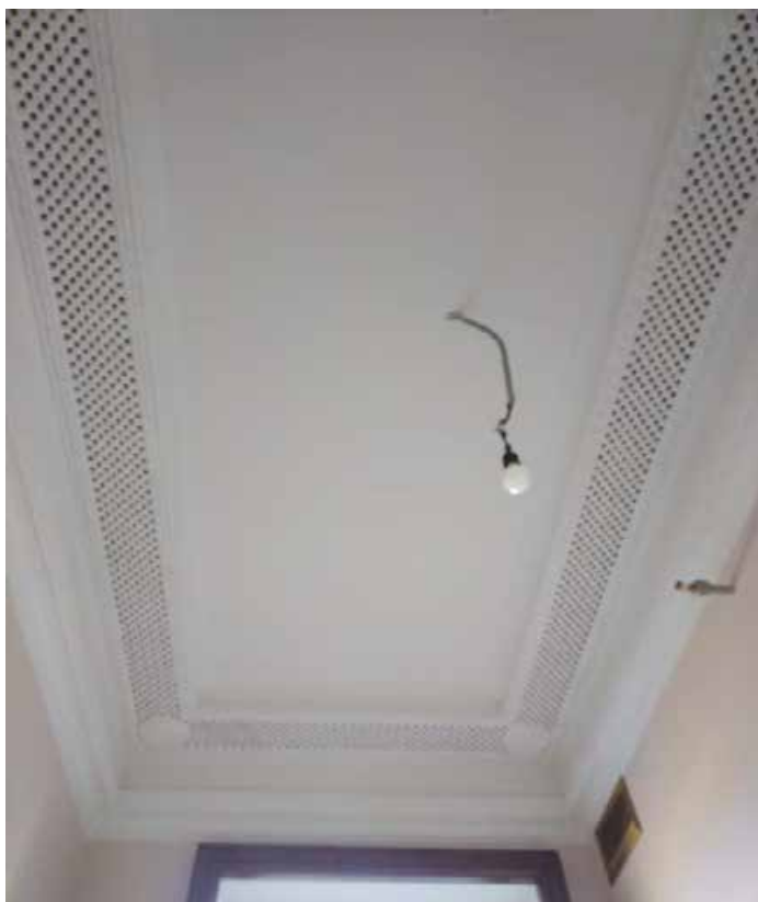
11. Помещение 40/12,5. Дата съемки: 20.05.2025 г.
