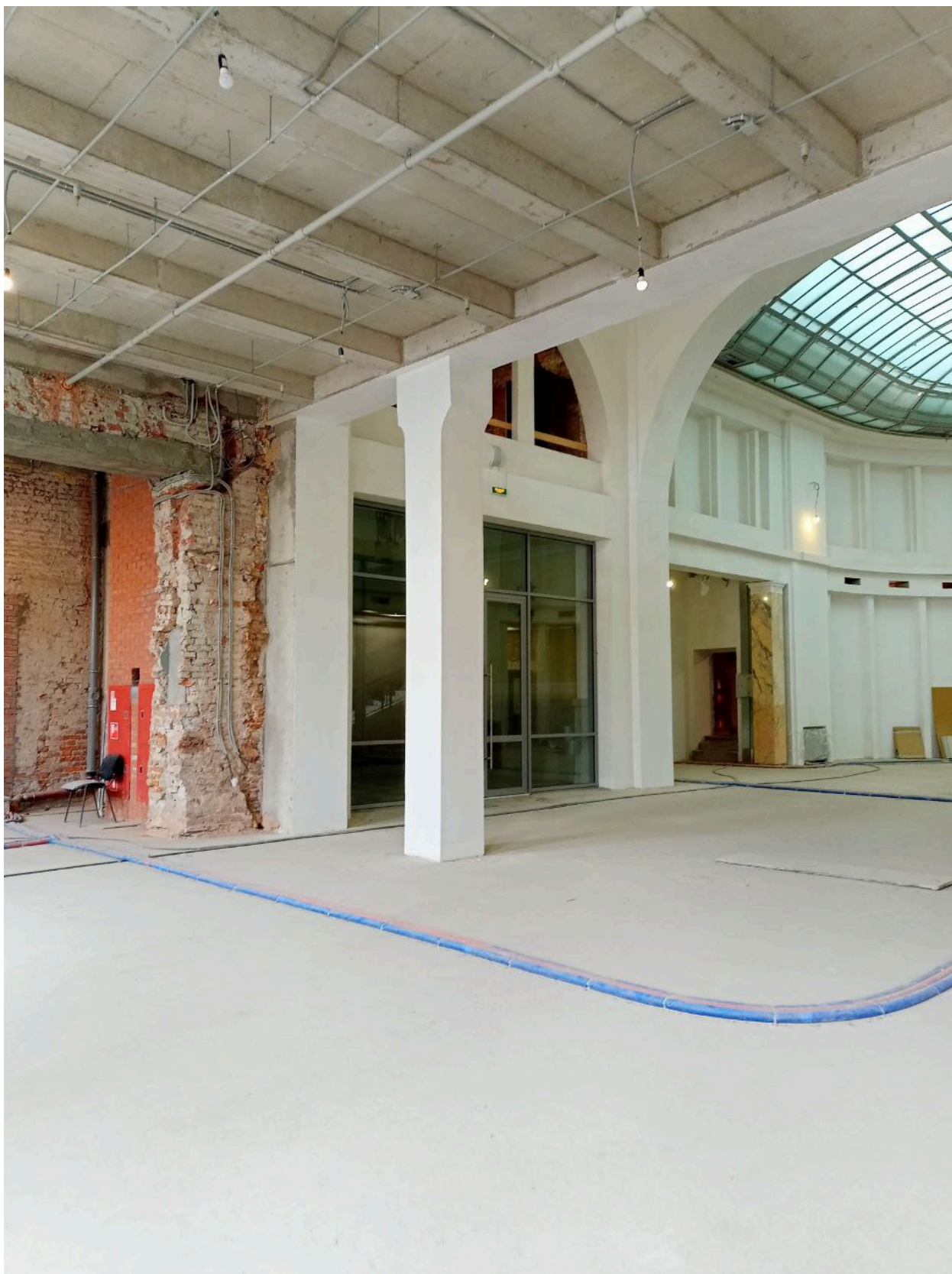
14. Вид из помещения 23/107,7, смежного с «Операционным залом». Дата съемки: 11.02.2025 г.
