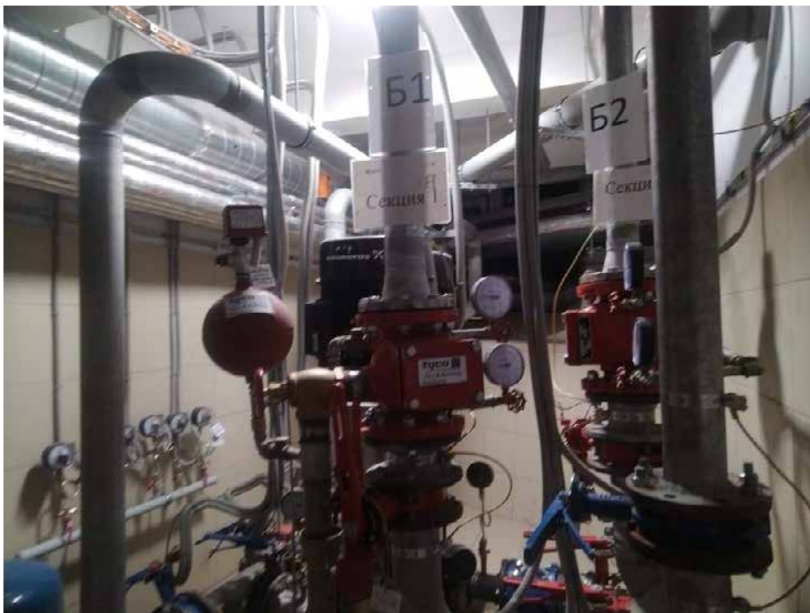
7. Помещение 1/13,6. Дата съемки: 20.04.2025 г.
