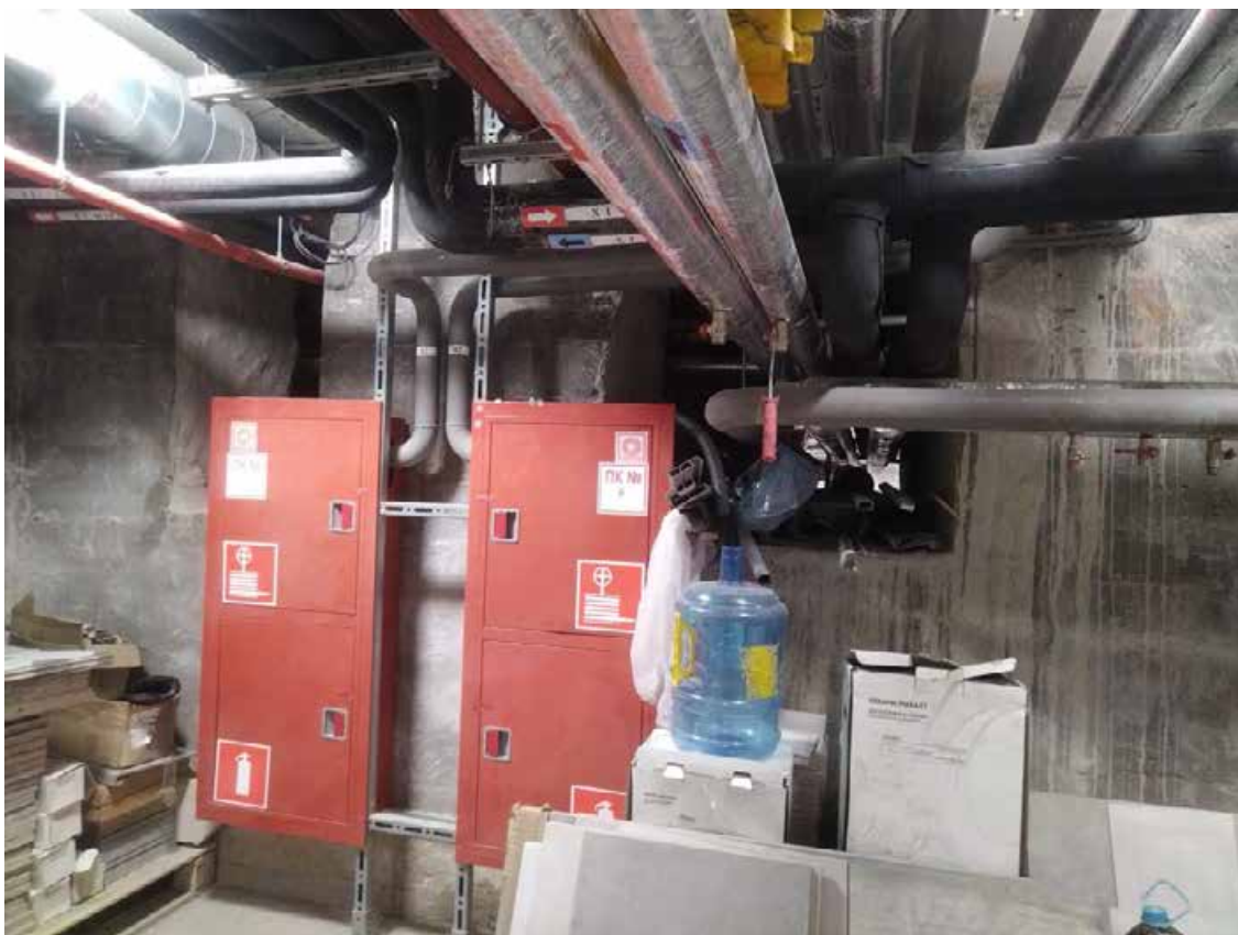
21. Помещение 1нч/104,0. Коридор. Дата съемки: 20.04.2025 г.
