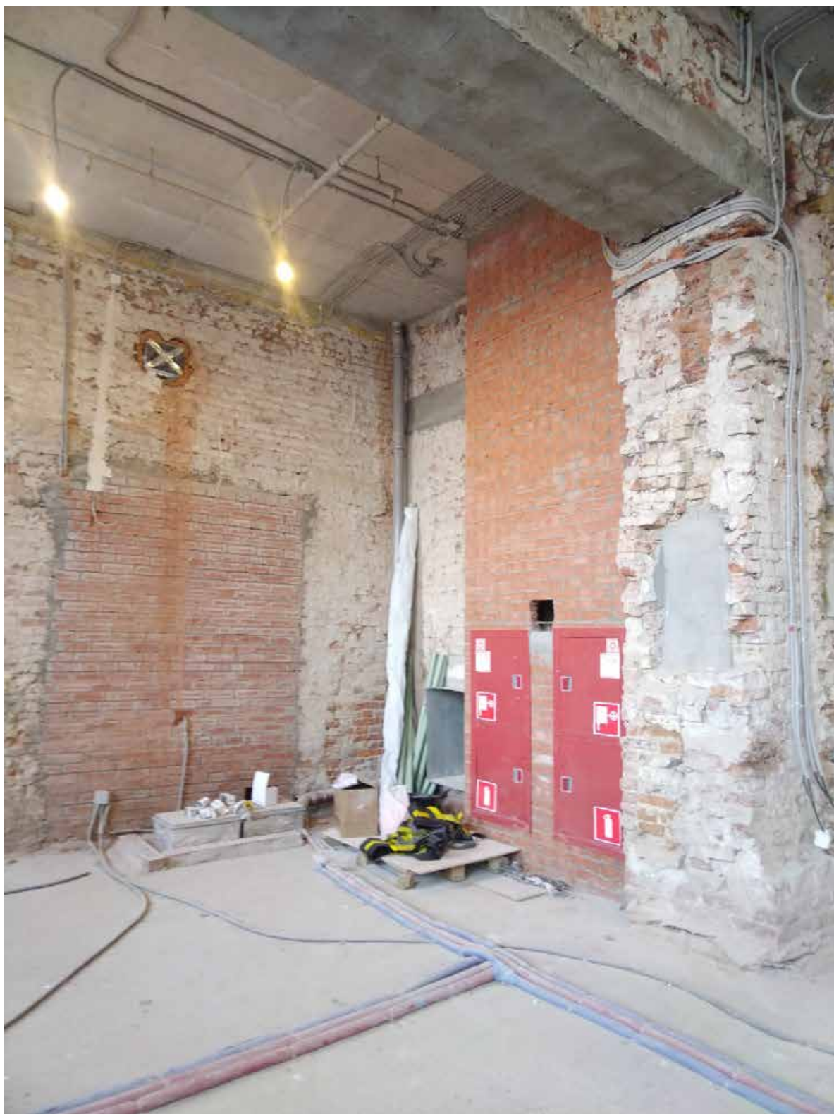
22. Помещение 24/41, 3. Дата съемки: 20.04.2025 г.
