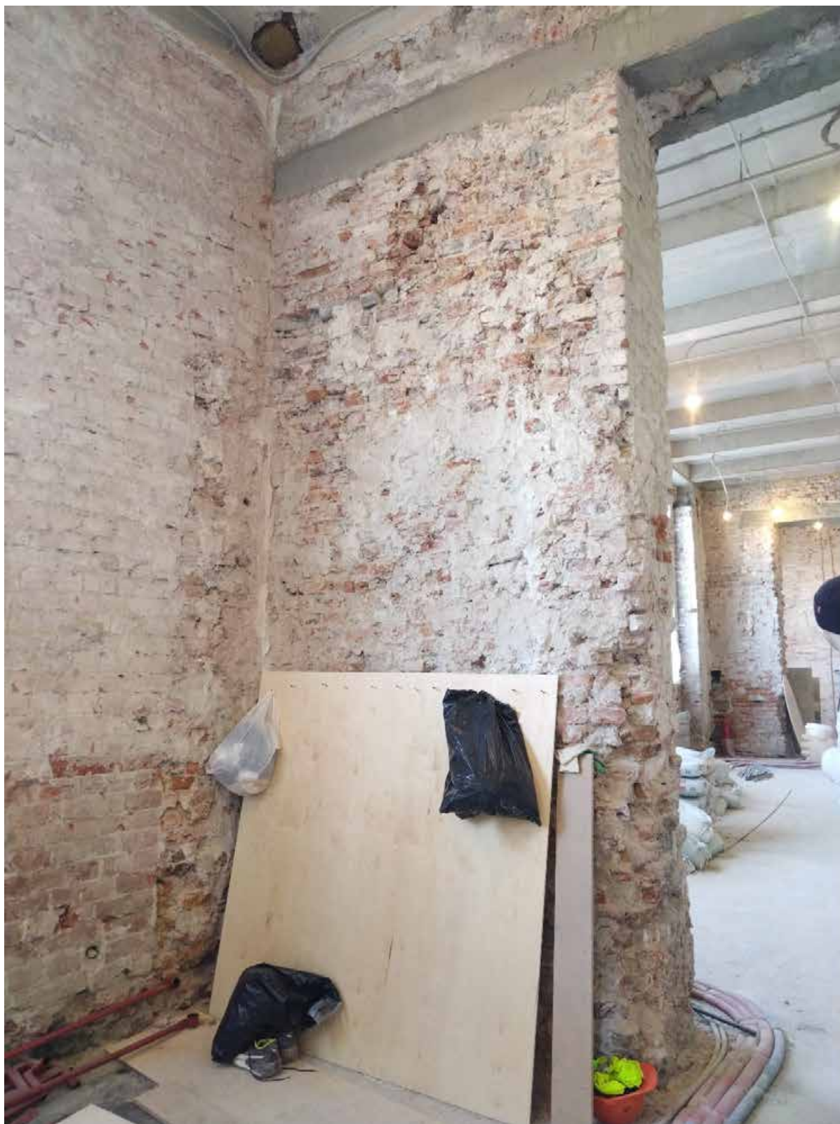
20. Помещение 24/41, 3. Дата съемки: 20.04.2025 г.
