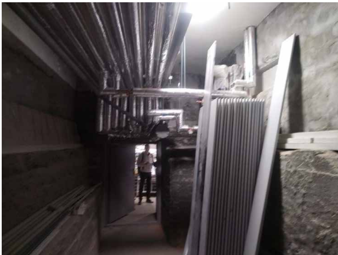
18. Помещение 7нч/37,1. Коридор. Дата съемки: 20.04.2025 г.
