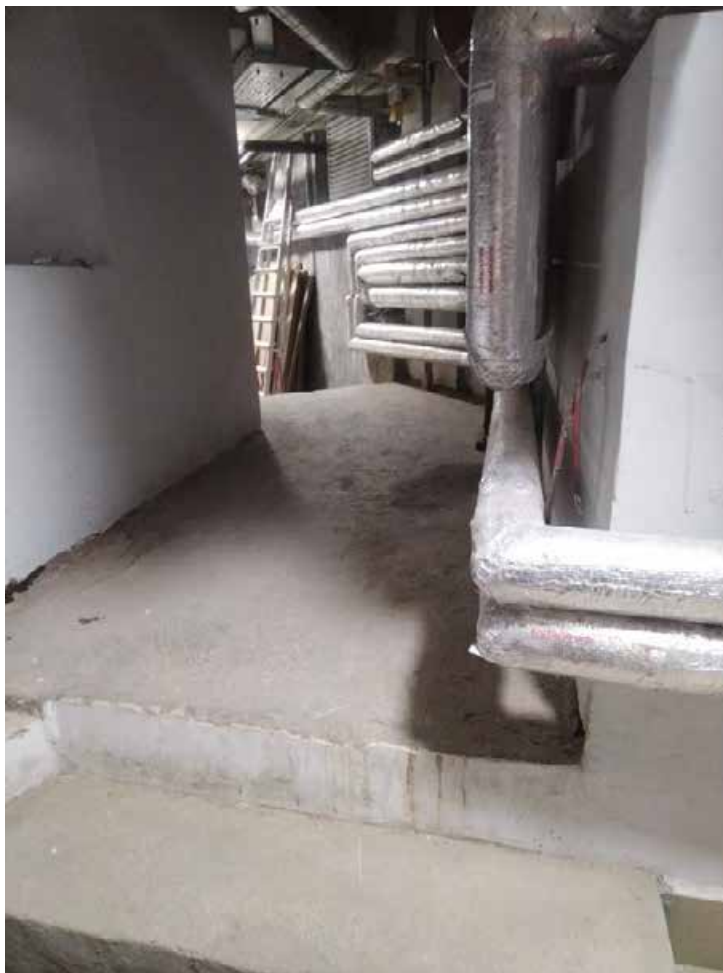
9. Помещение 1нч/104, 0. Коридор. Дата съемки: 20.04.2025 г.
