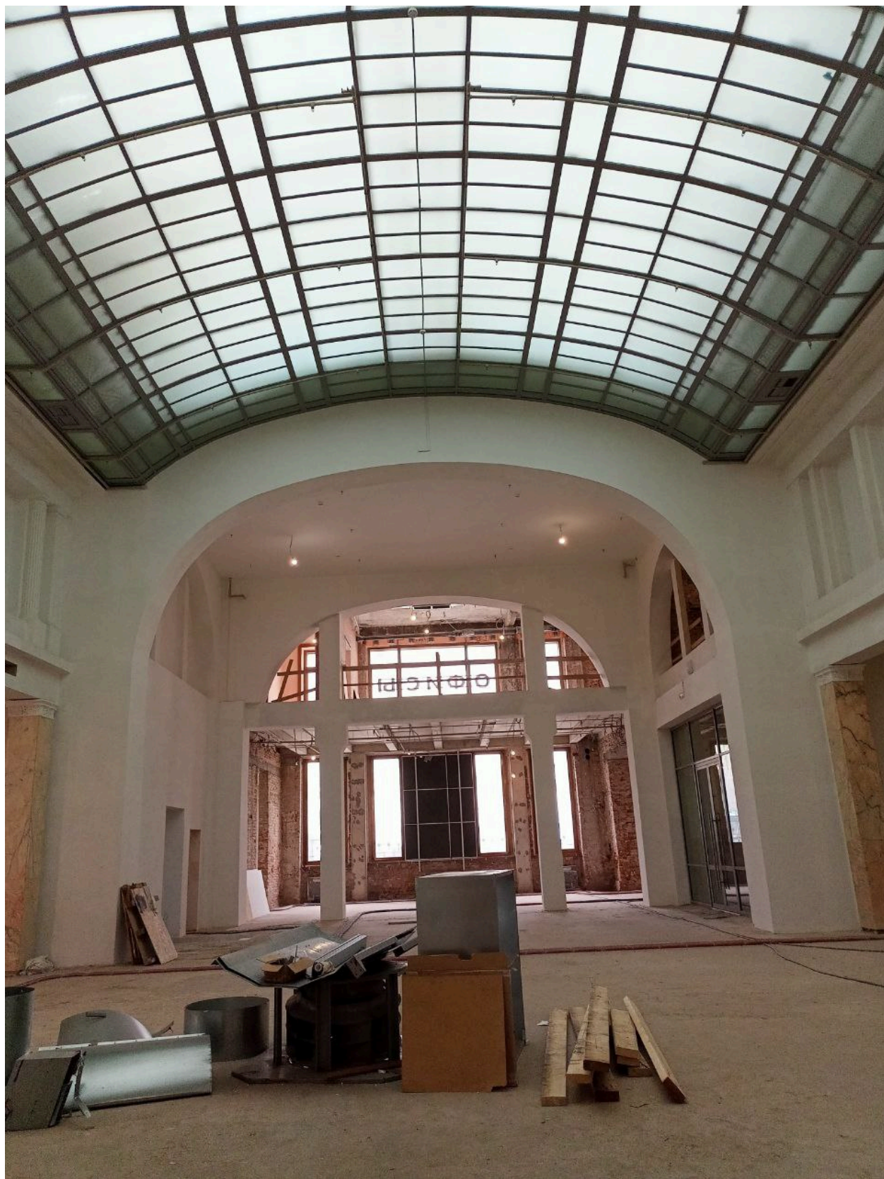
5. «Операционный зал». Помещение № 10/184.5. Дата съемки: 11.02.2025 г.
