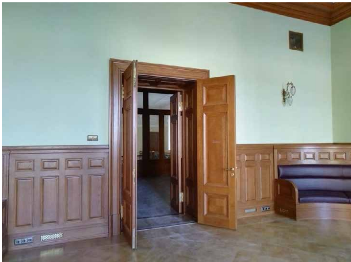
7. Помещение 66/58,0. Дверные заполнения проема. Дата съемки: 20.04.2025 г.
