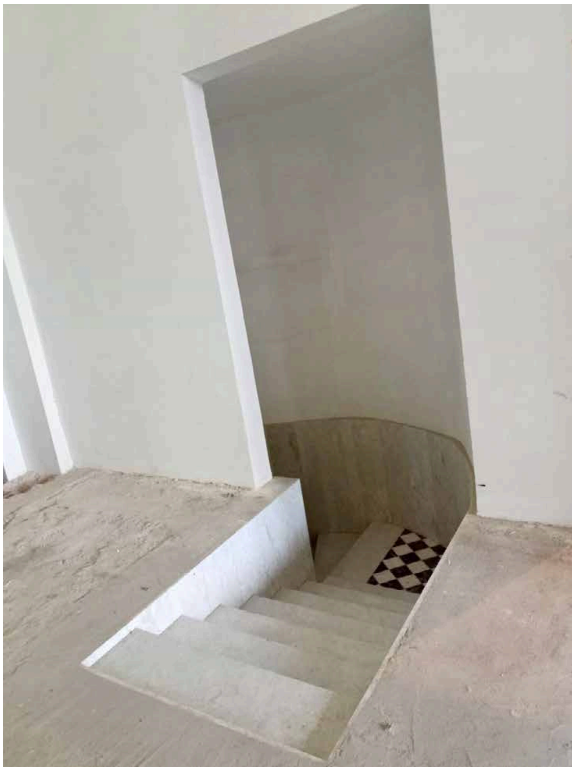
12. «Операционный зал». Помещение № 9/69,1. Фрагмент. Лестница, ведущая в подвал, облицованная мрамором. Дата съемки: 11.02.2025 г.
