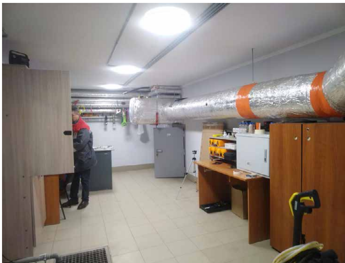
26. Помещение 1/22,3. Коридор. Дата съемки: 20.04.2025 г.
