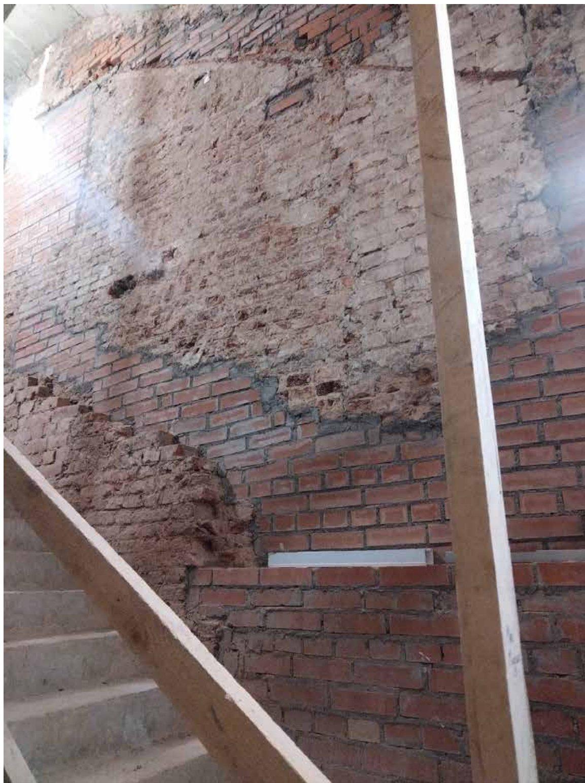
2. Кирпичная кладка стены. Дата съемки: 20.04.2025 г.
