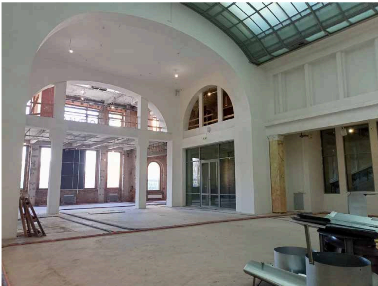
13. «Операционный зал». Помещение № 10/184.5. Дата съемки: 11.02.2025 г.
