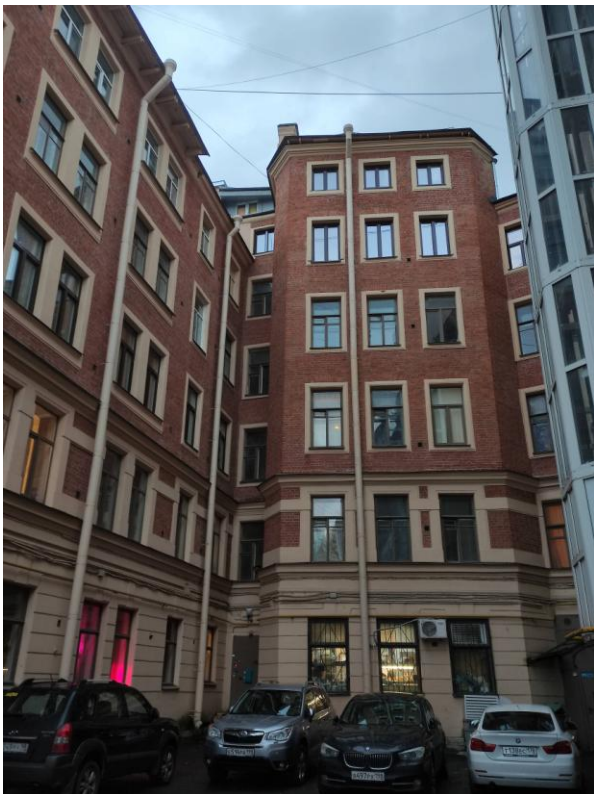
Фото 3. Фрагмент дворового фасада выявленного объекта культурного наследия «Дом В.Е. и Г.Е Овчинниковых»
