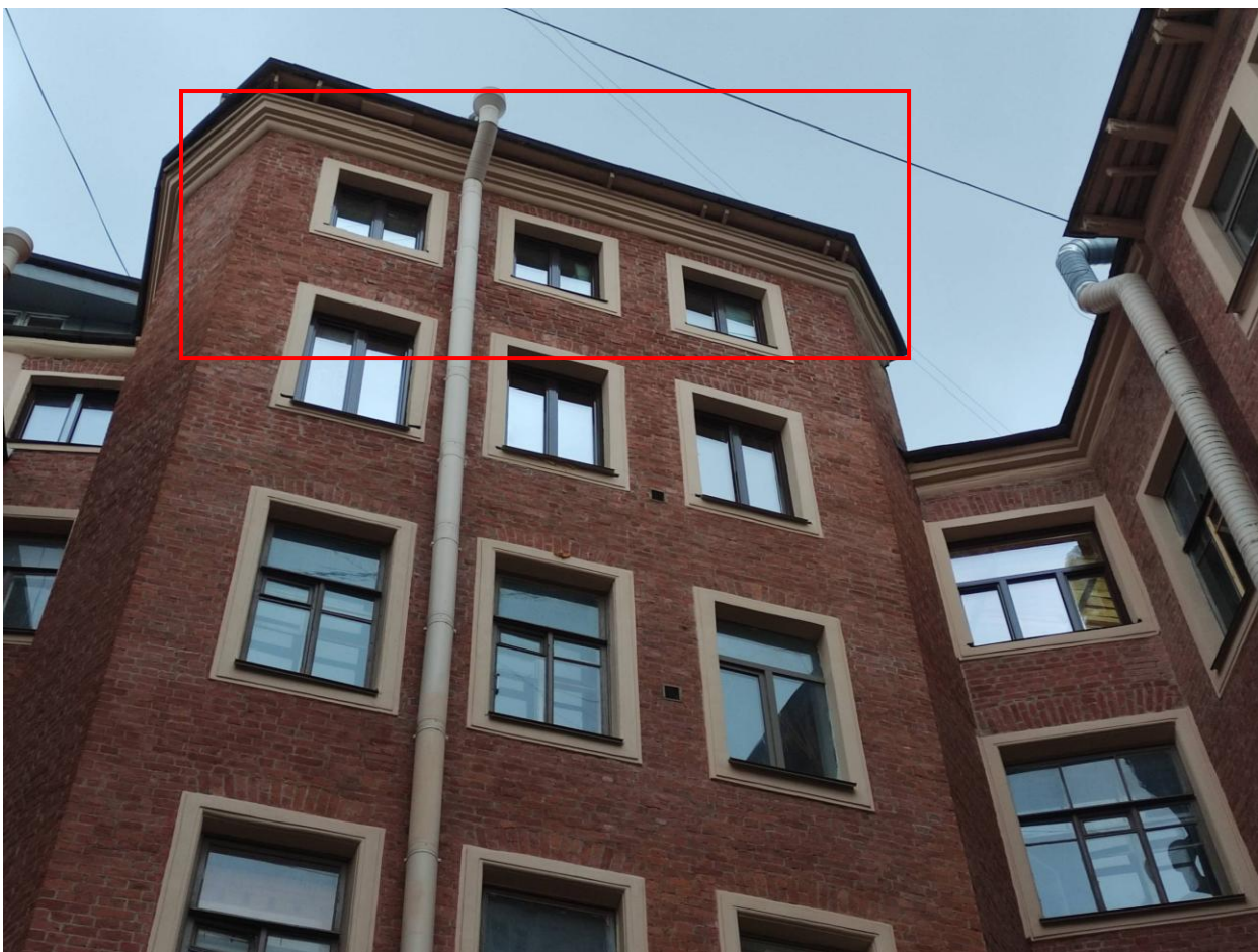
Фото 5. Фрагмент дворового фасада выявленного объекта культурного наследия «Дом В.Е. и Г.Е Овчинниковых», оконные заполнения кв.№ 14
