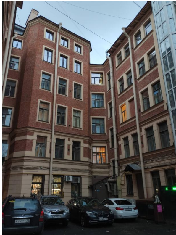
Фото 4. Фрагмент дворового фасада выявленного объекта культурного наследия «Дом В.Е. и Г.Е Овчинниковых»
