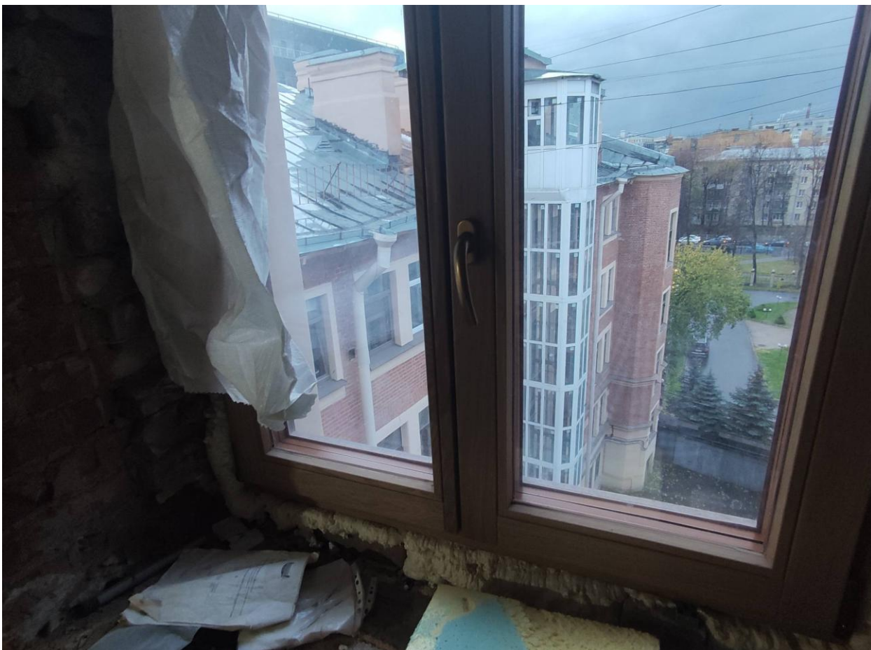
Фото 13. Интерьер кв.№ 14, ч.п.№4, оконное заполнение квартиры
