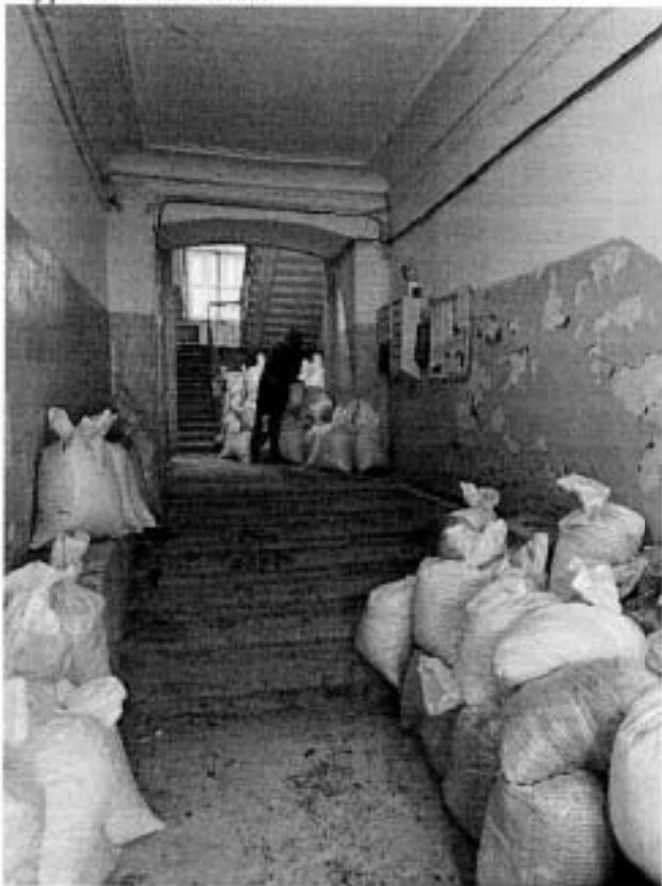
17. Лестница одномаршевая 1ЛК в уровне 1-го этажа.
