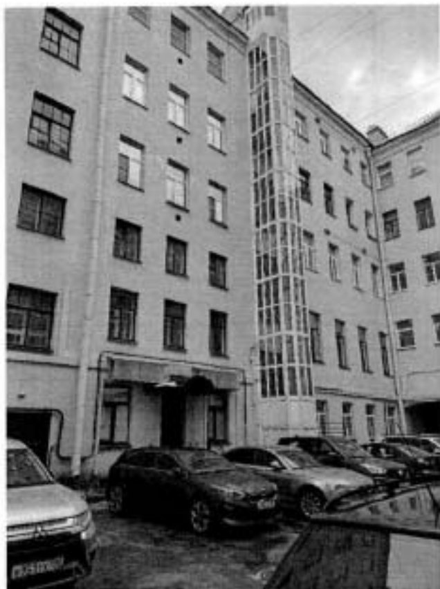
13. Фрагмент северного фасада. Металлопластиковая конструкция над приемком.
