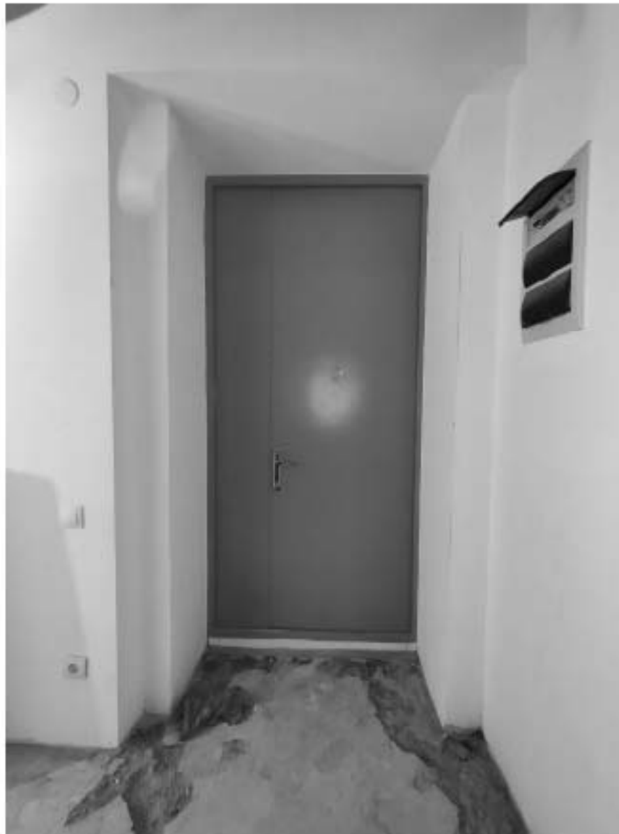
Фото №2. Квартира №82 (бывш. комната 1) (здесь и далее нумерация комнат согласно техническому паспорту).
