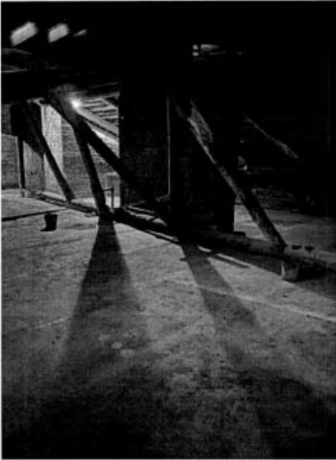
42. Устройство нового перекрытия над кв. 9.
