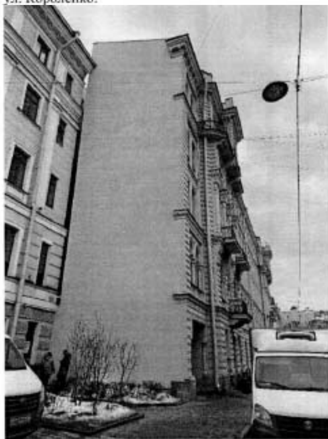
5. Брандмауэрный фасад со стороны ул. Короленко.
