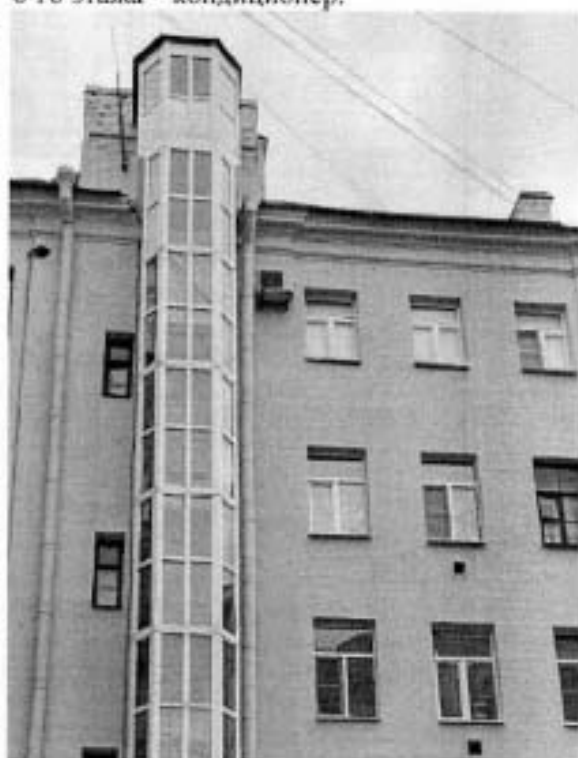
16. Фрагмент западного фасада. В уровне 6-го этажа – кондиционер.
