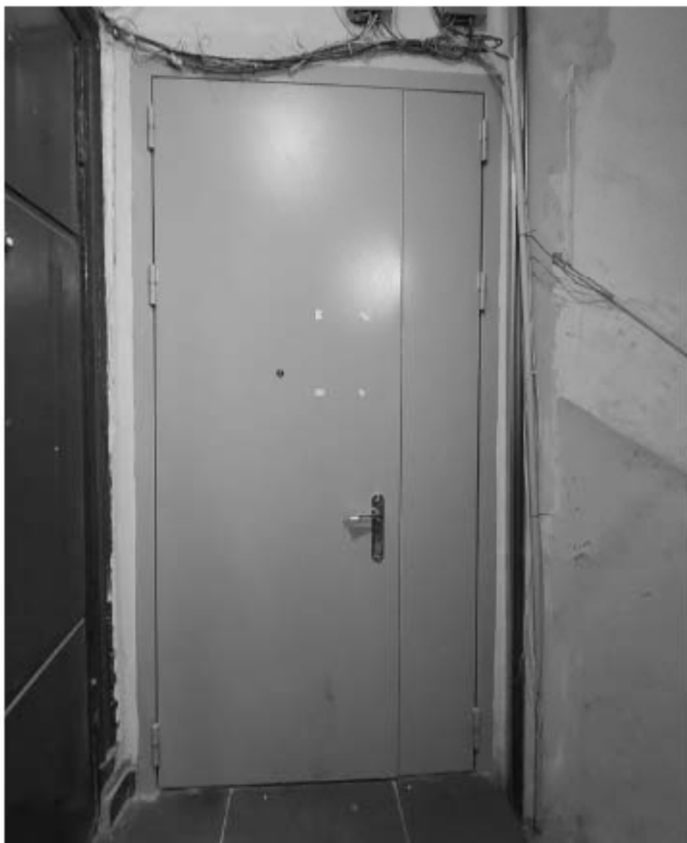
Фото №1. Лестничная площадка третьего этажа, вход в квартиру №82.
