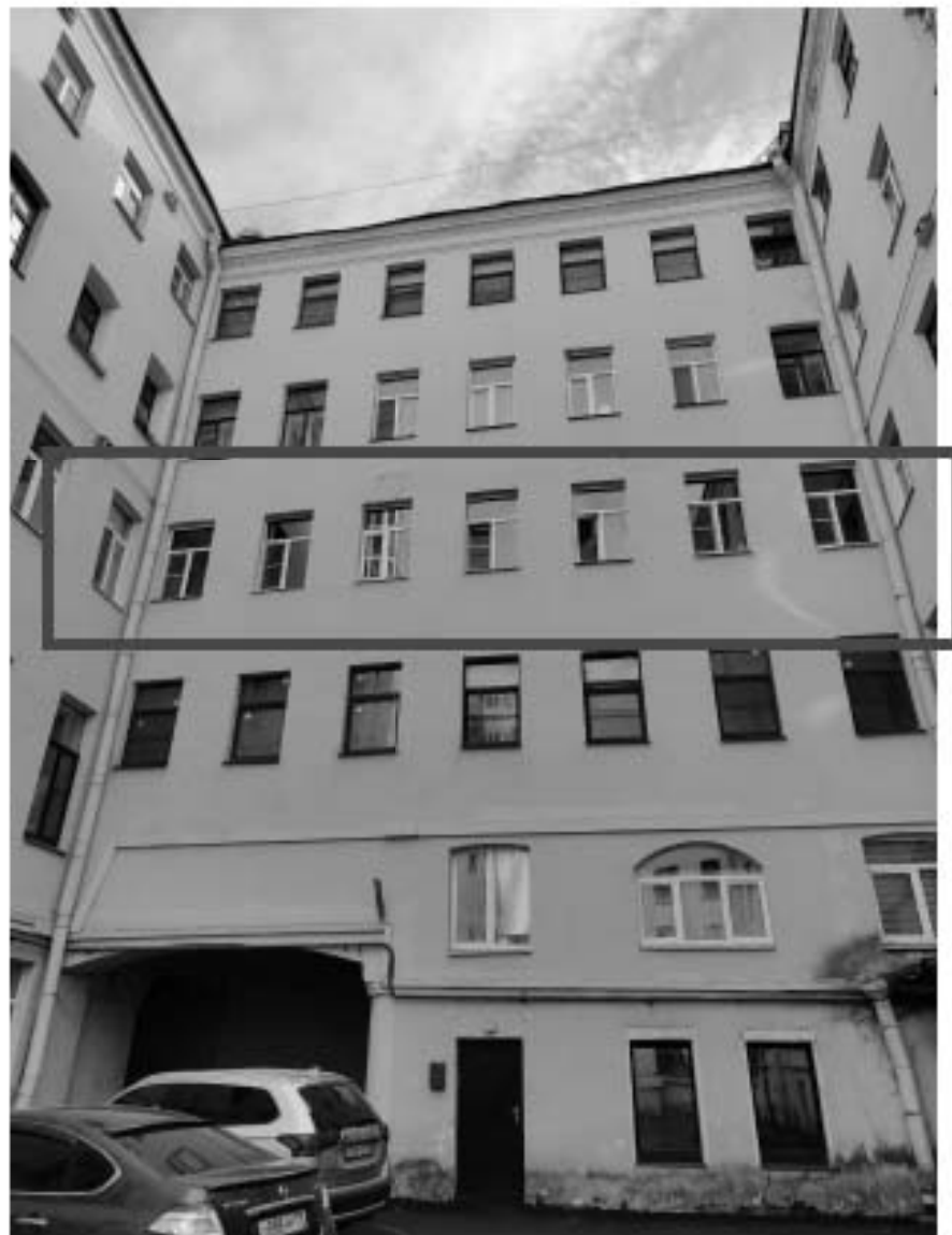
Фото №4. Южный фасад дворового корпуса, окна квартиры №82.
