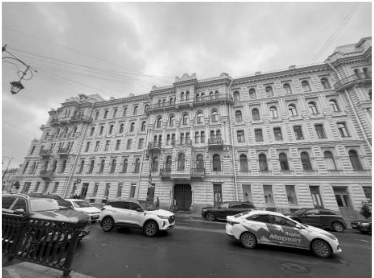
Фото №1. Лицевой северный фасад северного лицевого корпуса, общий вид.
