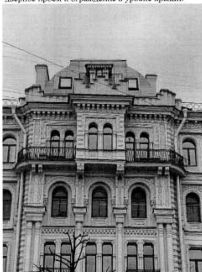
6. Лицевой фасад по ул. Короленко. Окна-velux, дверное проем и ограждение в уровне крыши.
