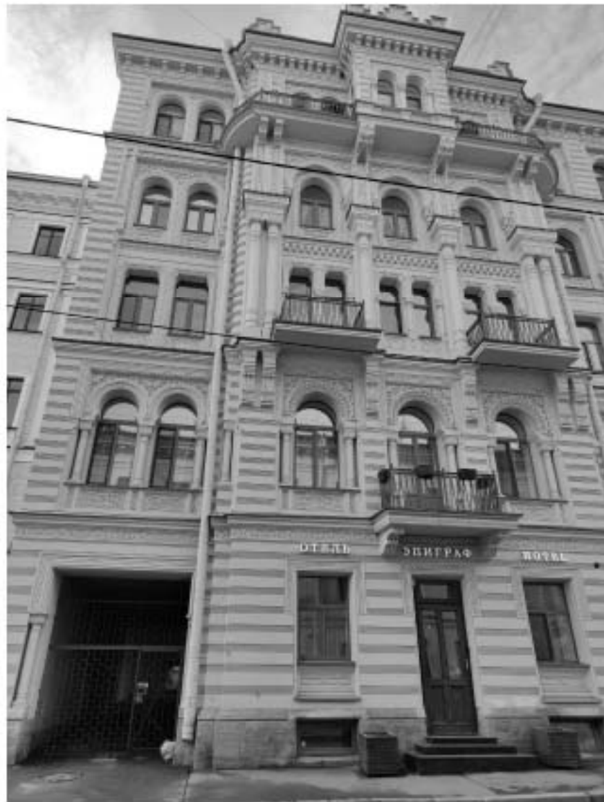
Фото №3. Лицевой восточный фасад восточного лицевого корпуса, общий вид.
