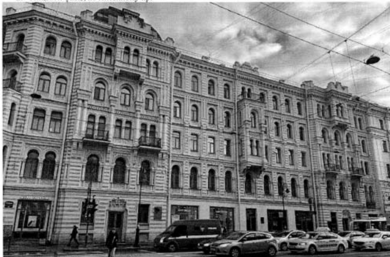
2. Лицевой фасад по Литейному пр.
