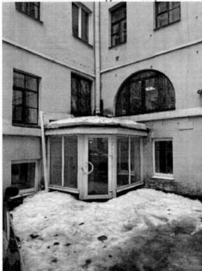
13. Фрагмент северного фасада. Металлопластиковая конструкция над приемком.
