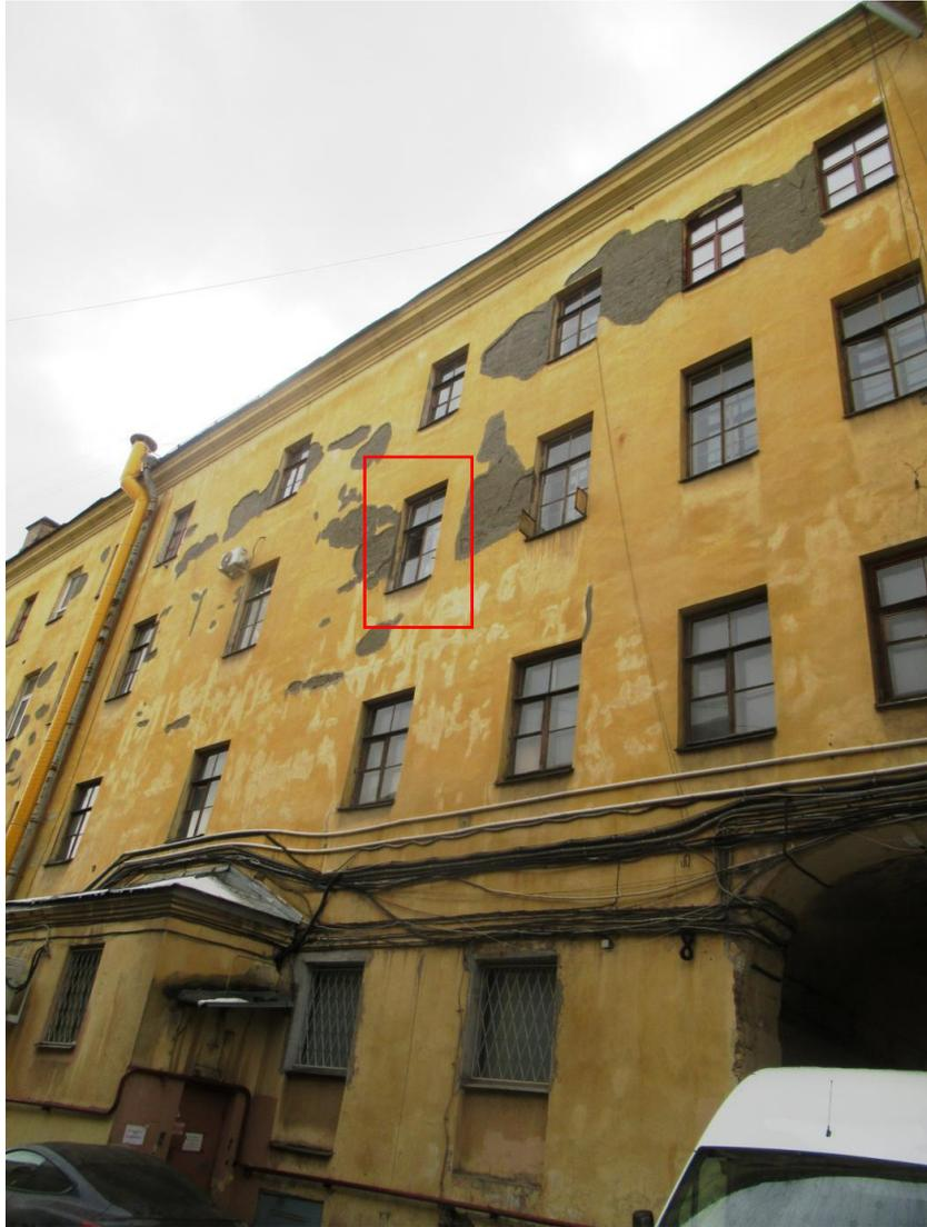
6. Фрагмент дворового (восточного) фасада здания. Выделен оконный проем, в верхней части которого предполагается установка блока кондиционера с жалюзийной решеткой.
