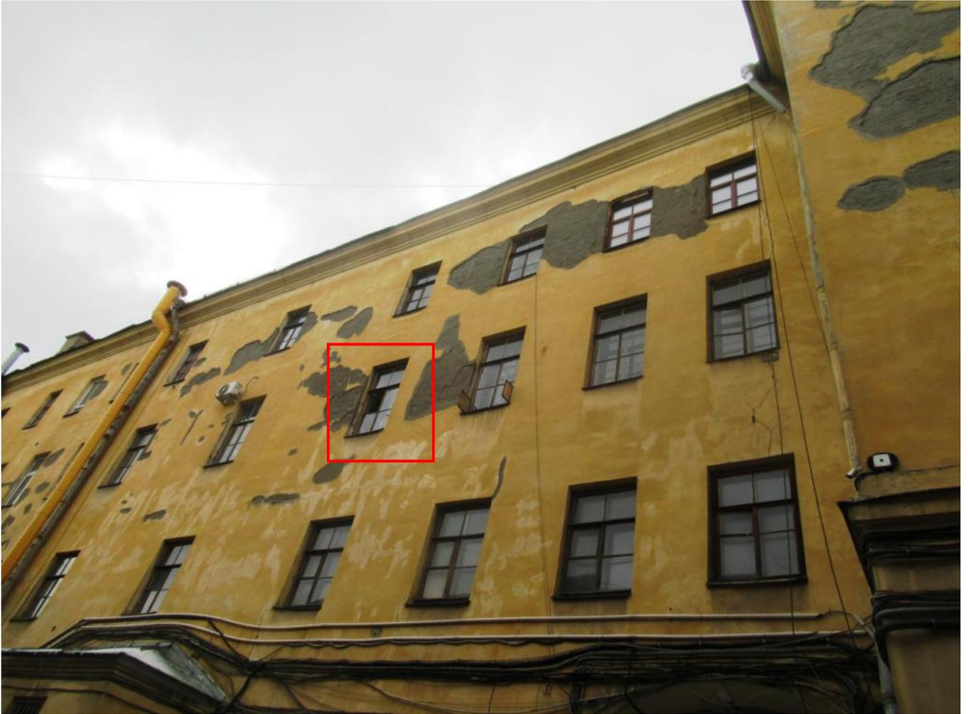
7. Фрагмент дворового (восточного) фасада здания. Выделен оконный проем, в верхней части которого предполагается установка блока кондиционера с жалюзийной решеткой.
