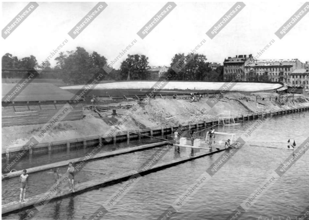
18. Фотография стадиона им. В. И. Ленина во время строительства. Укрепление береговой линии со стороны юго-востока у Тучкова моста. Автор фотографии неизвестен. Начало 1930-х. (Архивы Санкт-Петербурга: https://spbarchives.ru/ , дата обращения: 31.08.2022)
