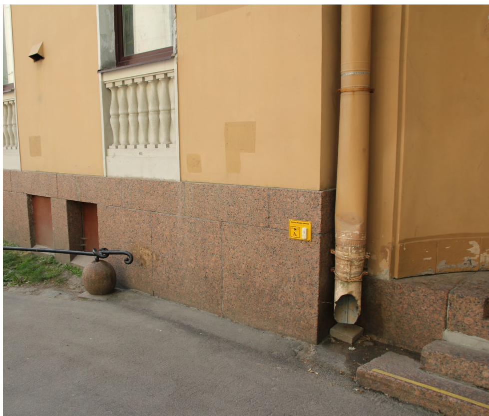
Фото №12 Фрагмент цоколя. Ограждение полисадника.
