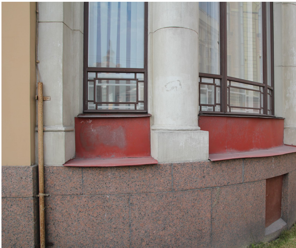
Фото №9 фрагмент цоколя веранды.
