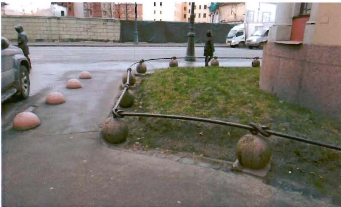
Фото №18. Вид со стороны Карповского переулка.
