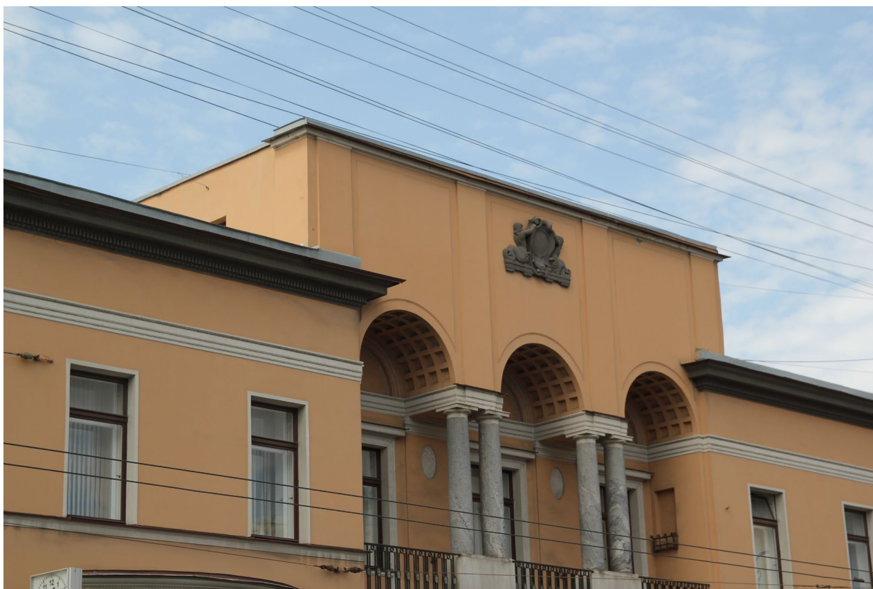
Фото №14 Фрагмент фасада. Лоджия второго этажа. Аттик.
