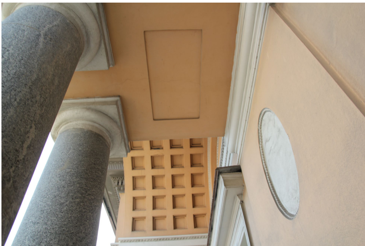
Фото №20 Фрагмент колонн. Потолок и свод лоджии.
