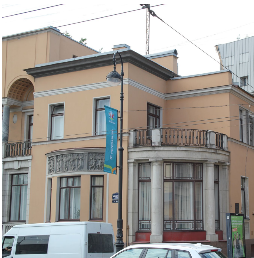
Фото №2 Общий вид здания с пересечения Каменноостровского проспекта и Карповского переулка.
