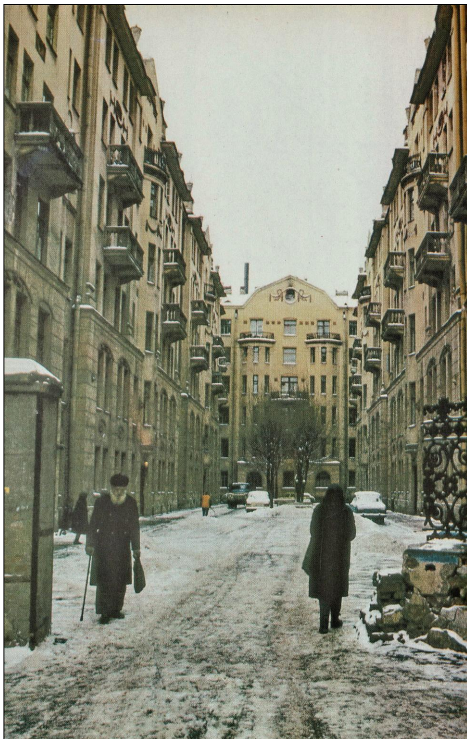
Илл. 26. Курдонер дома № 23 по улице Рубинштейна. Фотография. Автор съемки: Lothar Willmann. 1985 – 1987 гг.
