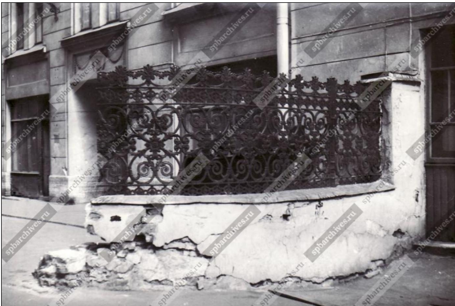
Илл. 27. Фрагмент ограды у дома № 23 по улице Рубинштейна (бывший дом Петербургской купеческой управы). Фотография. Автор съемки: К.В. Овчинников. 10 мая 1986 г. ЦГАКФФД СПб. Шифр: Ар 217850.
