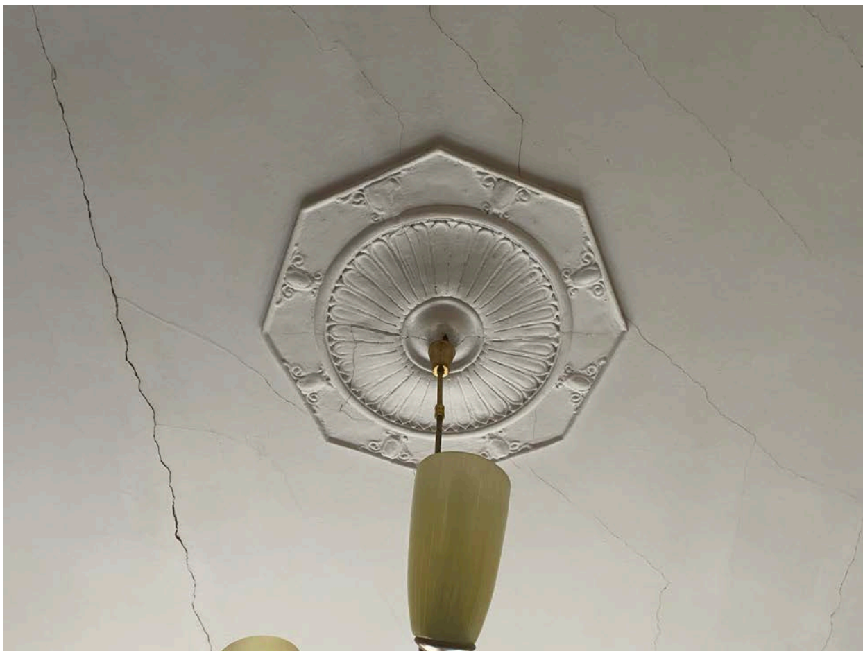
Фото 27. Помещение № 5. Комната. В центре потолка лепная розетка сложной конфигурации - центральная круглая розетка растительного характера, помещена в восьмигранную розетку, оформленную лепными элементами в виде овальных медальонов.
