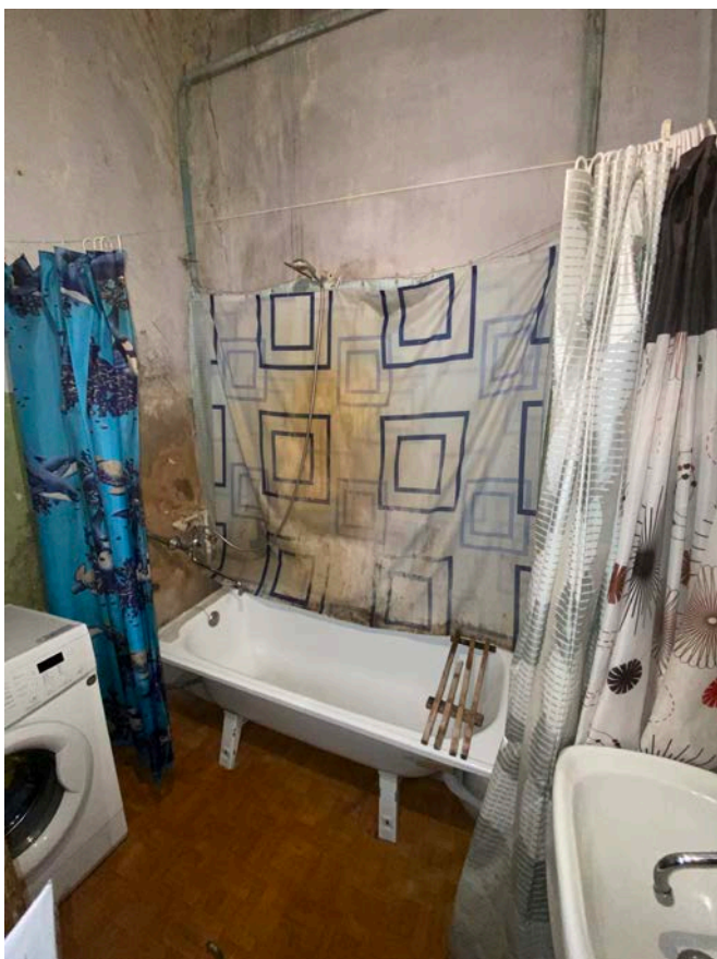
Фото 19. Помещение № 10. Кухня. Вид с юго-востока.
