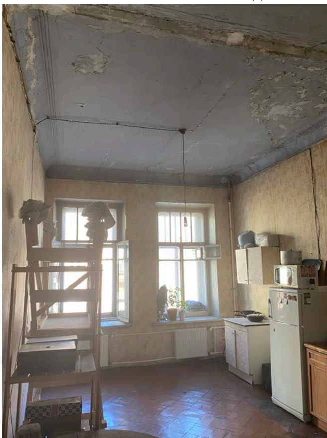
Фото 28. Помещение № 7. Кухня. Вид с юго-запада.
