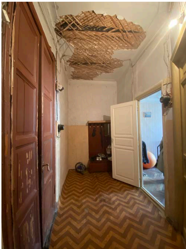
Фото 7. Помещение № 1. Коридор (нумерация и экспликация помещений указана в соответствии с техническим паспортом по состоянию на 01.11.2013 г.). Вид с юго-востока.
