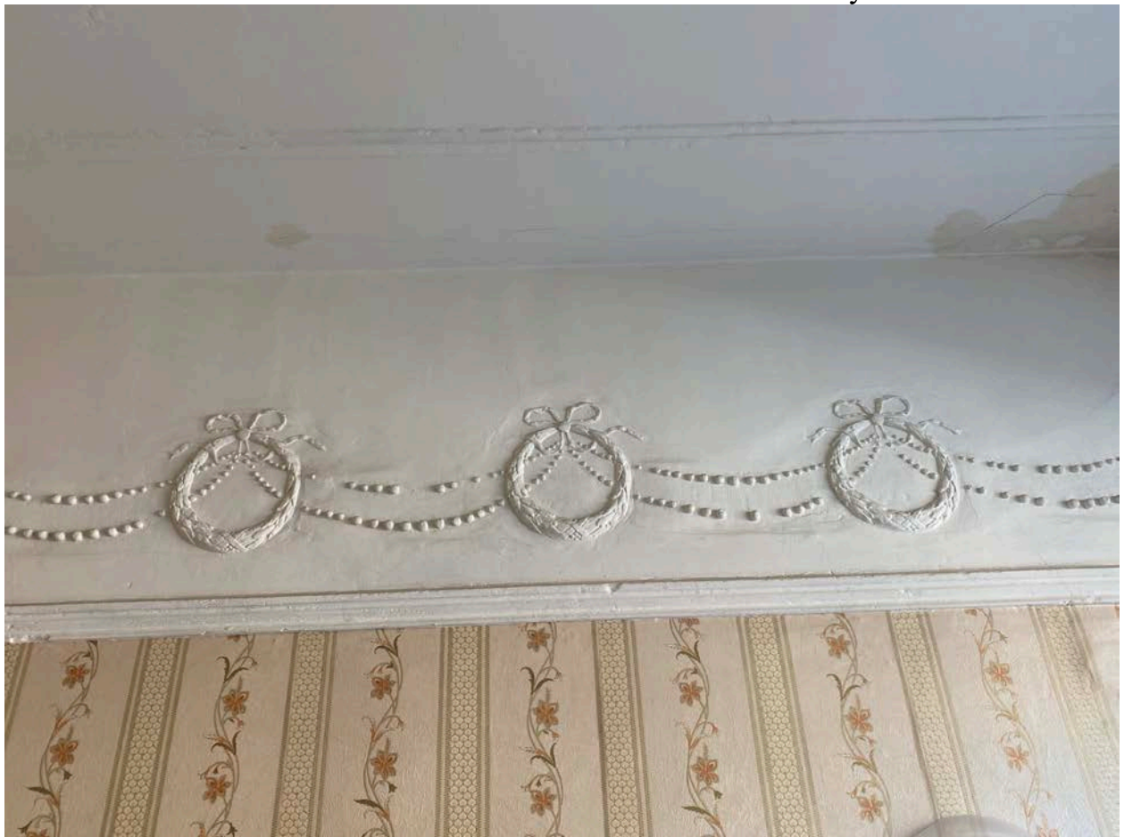
Фото 11. Помещение № 2. Комната. в верхней части стен комнаты лепной фриз из лавровых венков, перехваченных бантами, соединенных между собой «жемчужником»; по периметру потолка штукатурная профилированная тяга. Вид с юго-востока.
