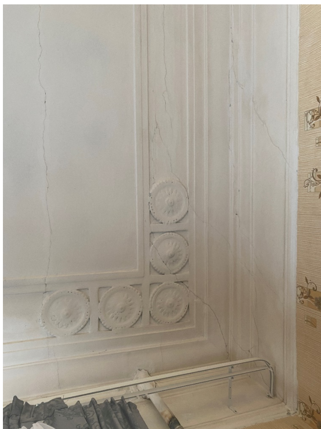
Фото 23. Помещение № 4. Комната. Фрагмент лепной отделки в виде профилированной штукатурной тяги по периметру потолка в виде рамы, по углам вставки из пяти круглых патер с рисунком растительного характера.
