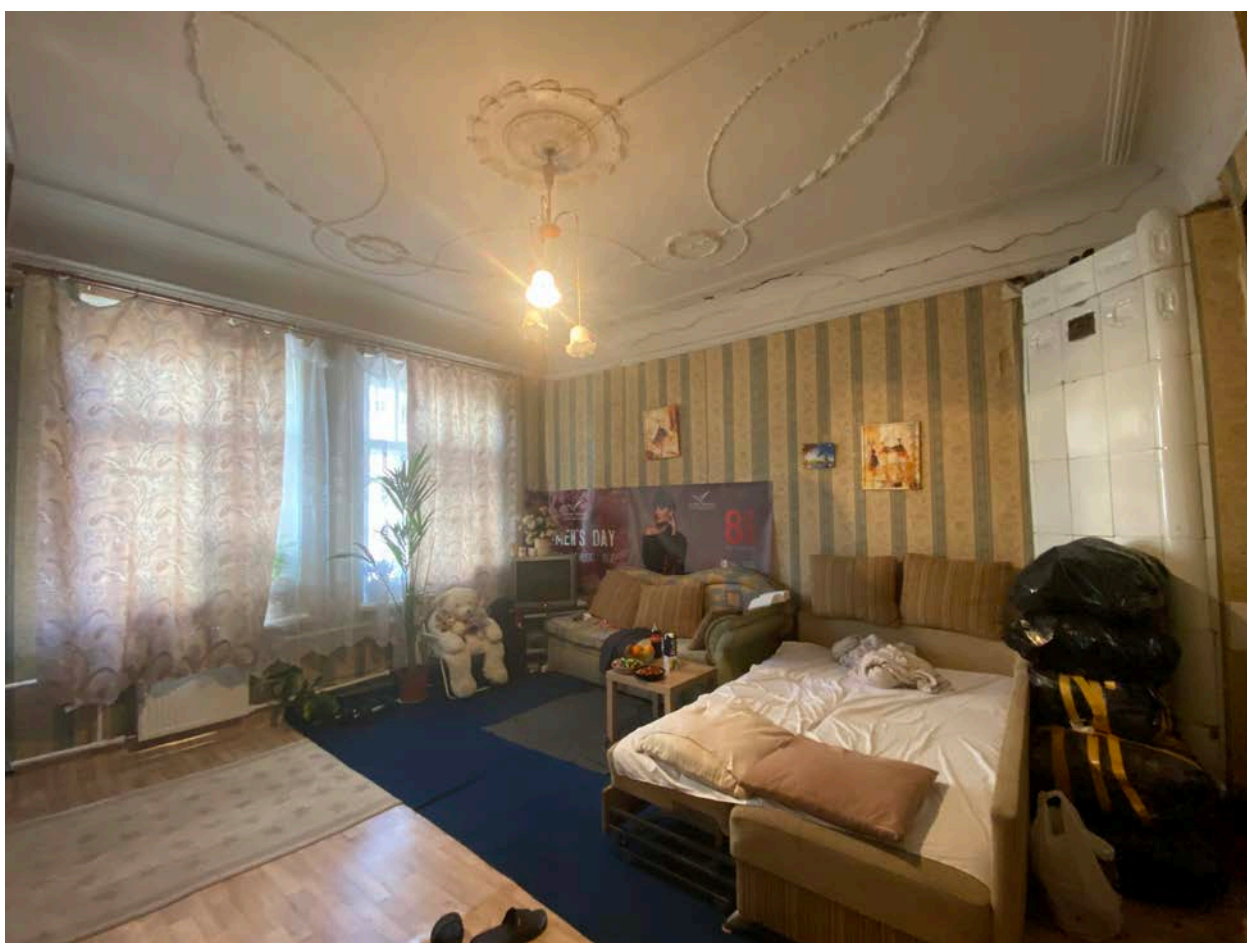
Фото 14. Помещение № 3. Комната. Печь угловая, одноярусная, облицованная белыми гладкими изразцами. Вид с запада.
