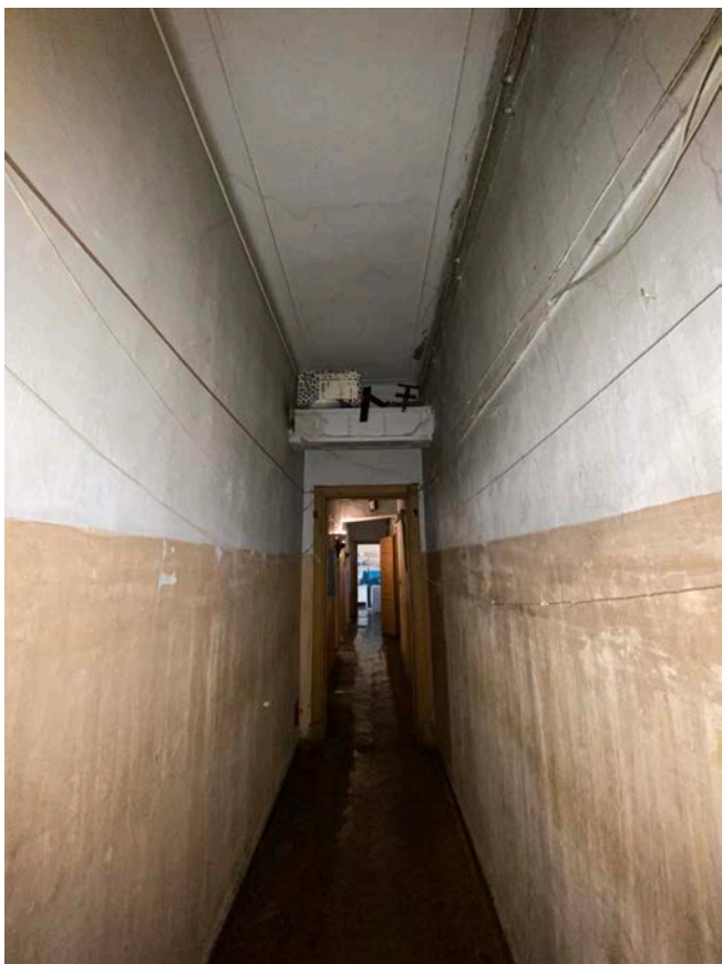
Фото 17. Помещение № 6. Коридор. Вид с северо-запада.
