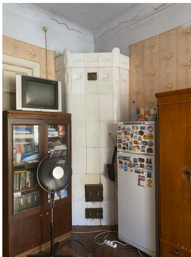
Фото 26. Помещение № 5. Комната. Печь угловая, одноярусная, облицованная белыми гладкими изразцами.
