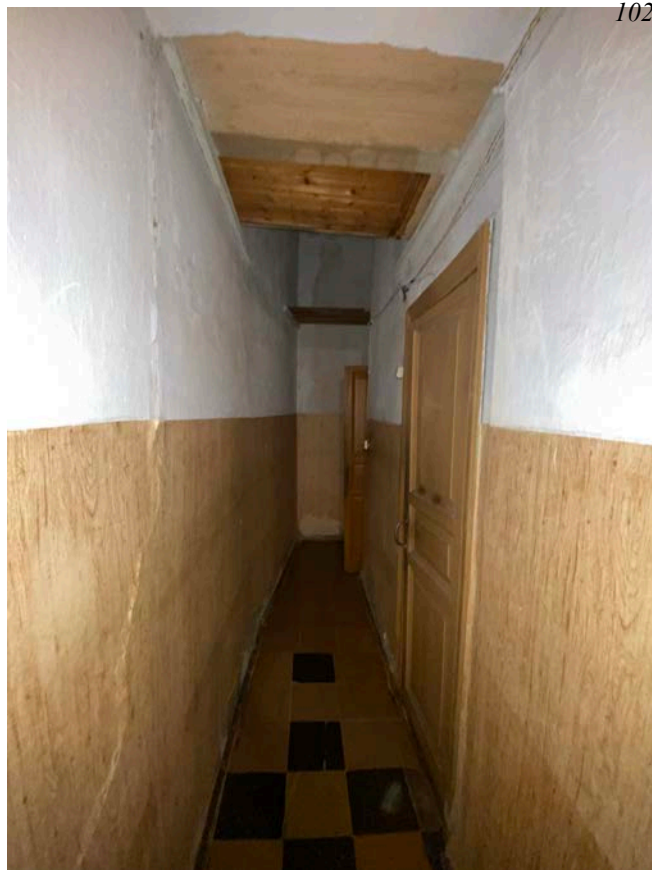
Фото 18. Помещение № 9. Коридор. Вид с северо-востока.
