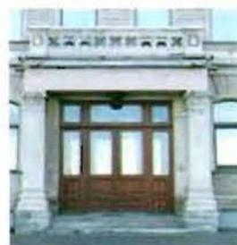
историческое дверное заполнение с двустворчатыми дверьми и верхней застекленной секцией: материал (стекло, красное дерево), рисунок, историческая дверная фурнитура;
