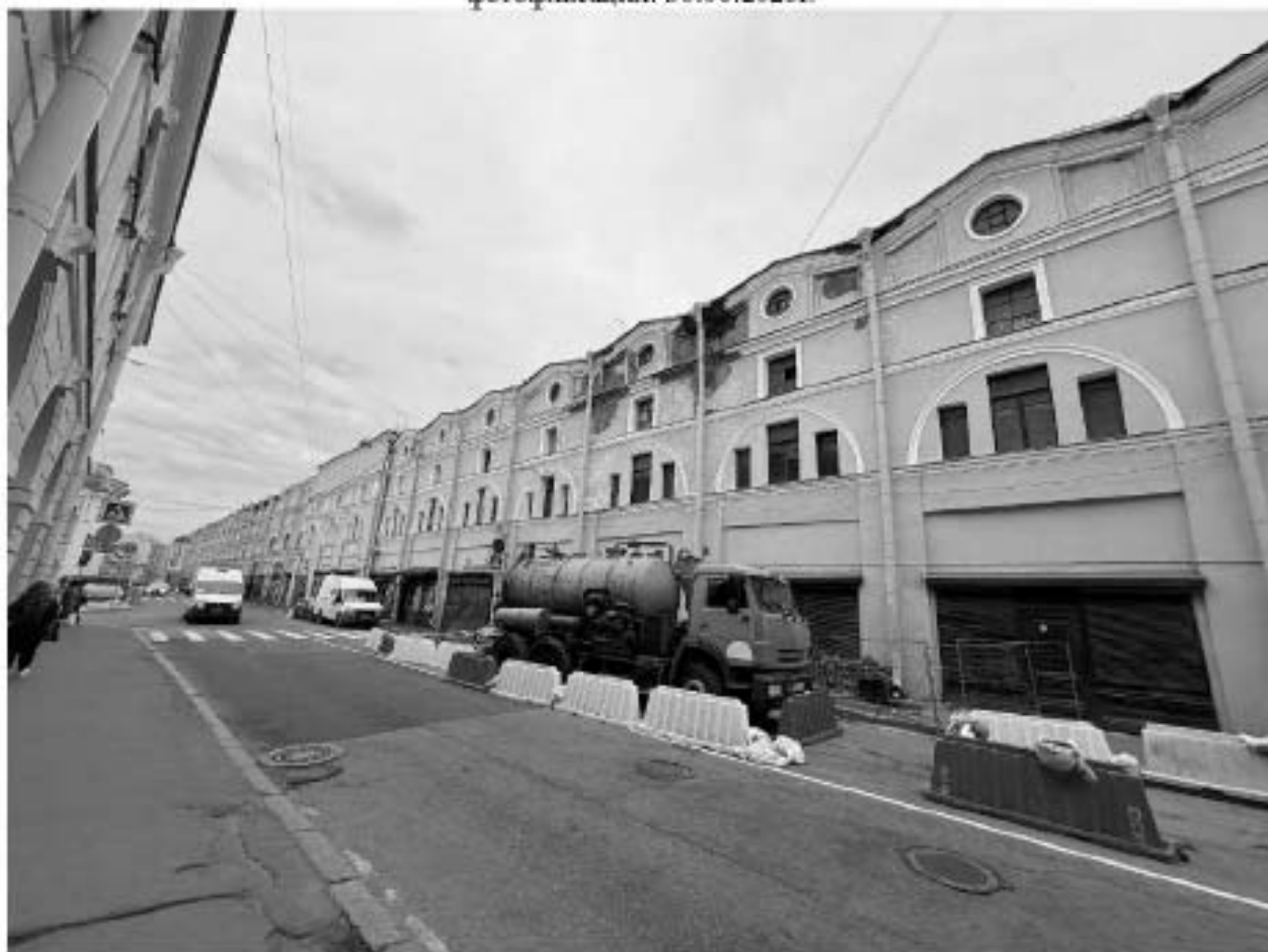
Фото 14. Общий вид на ОКН «Малый Гостиный двор, Новая Банковская линия». Дата фотофиксации: 30.06.2025г.
