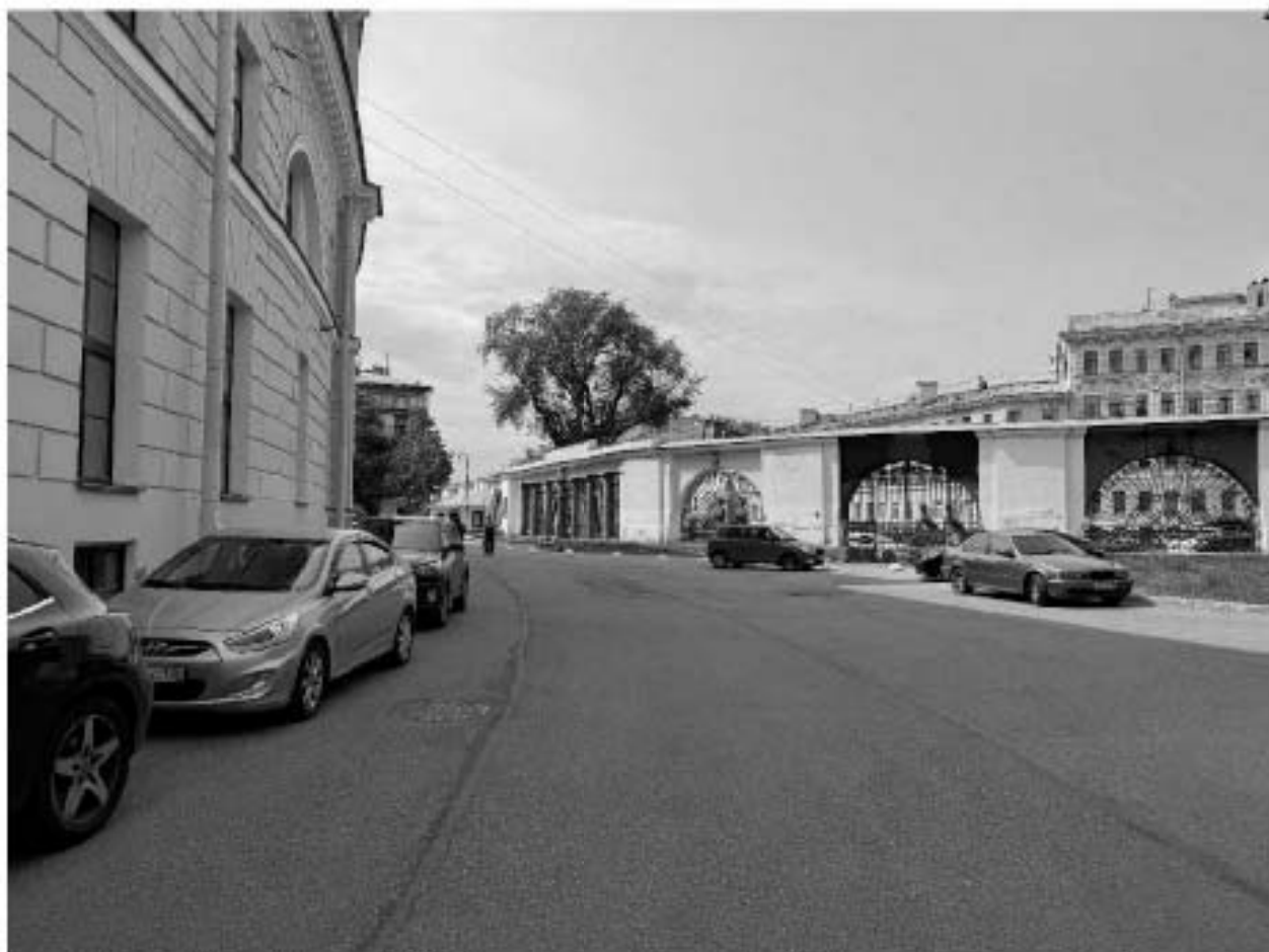
Фото 5. Общий вид на ОКН «Банк Ассигнационный» (ограда, сад со стороны наб. кан. Грибоедова). Дата фотофиксации: 30.06.2025г.
