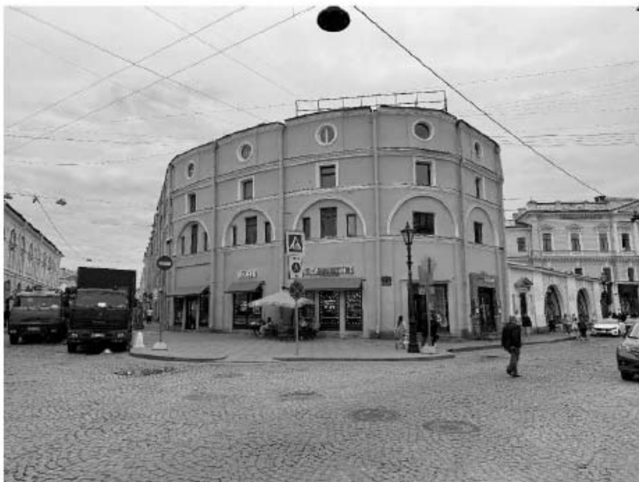
Фото 13. Общий вид на ОКН «Малый Гостиный двор, Новая Банковская линия». Дата фотофиксации: 30.06.2025г.
