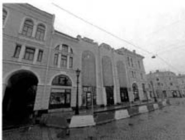
3. Фасад по набережной канала Грибоедова.
