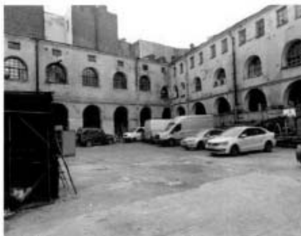
10. Вид на территорию объекта с юго-восточной стороны.
