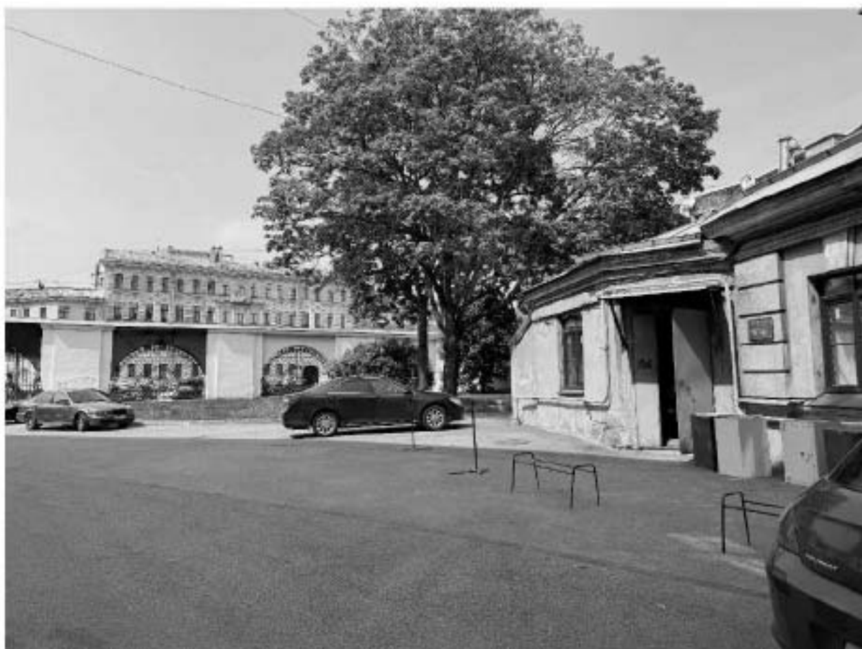
Фото 7. Общий вид на ОКН «Банк Ассигнационный» (ограда, сад со стороны наб. кан. Грибоедова). Дата фотофиксации: 30.06.2025г.
