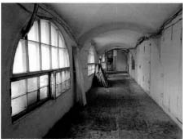
19. Галерея в уровне 3-го этажа.
