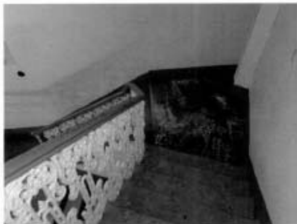
21. Лестница в помещении 24-Н.
