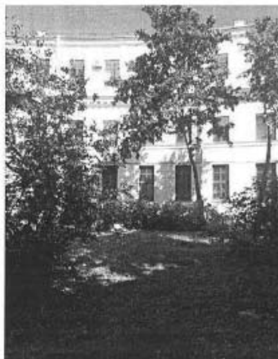
6. Фрагмент внутреннего двора. Вид на восточную часть.
