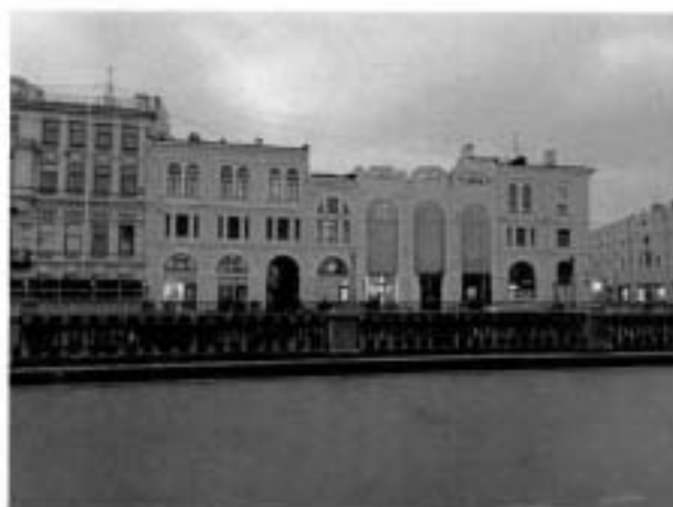
4. Фасад по набережной канала Грибоедова.
