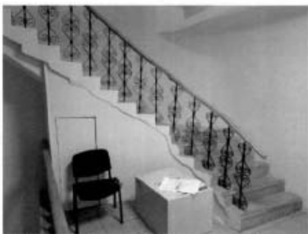
20. Междуетажная лестница в помещении 1-Н.
