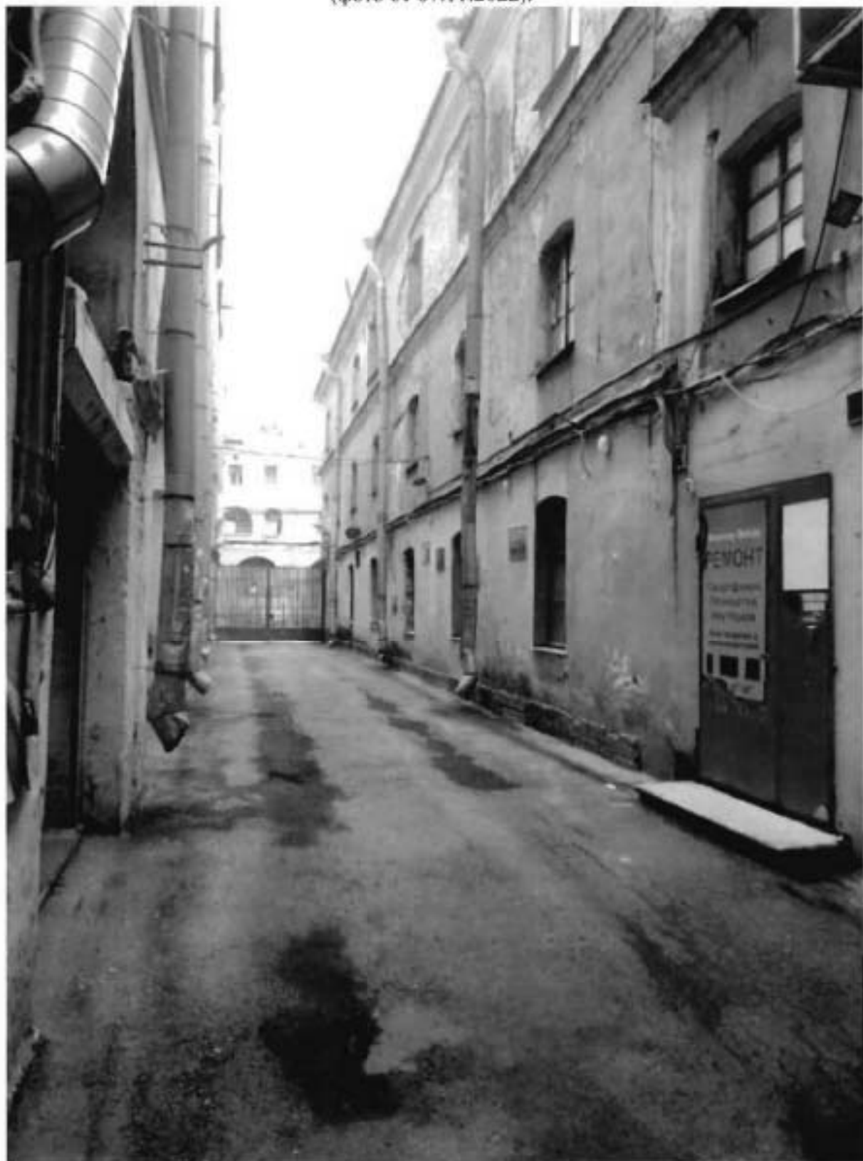
7. Въезд на внутридворовую территорию со стороны набережной канала Грибоедова (фото от 07.11.2022).
