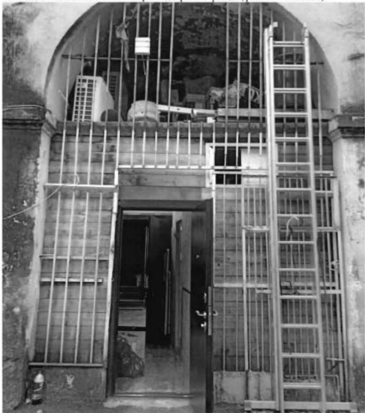
15. Вход в помещение 54-Н со стороны дворового фасада (фото от 14.11.2022).
