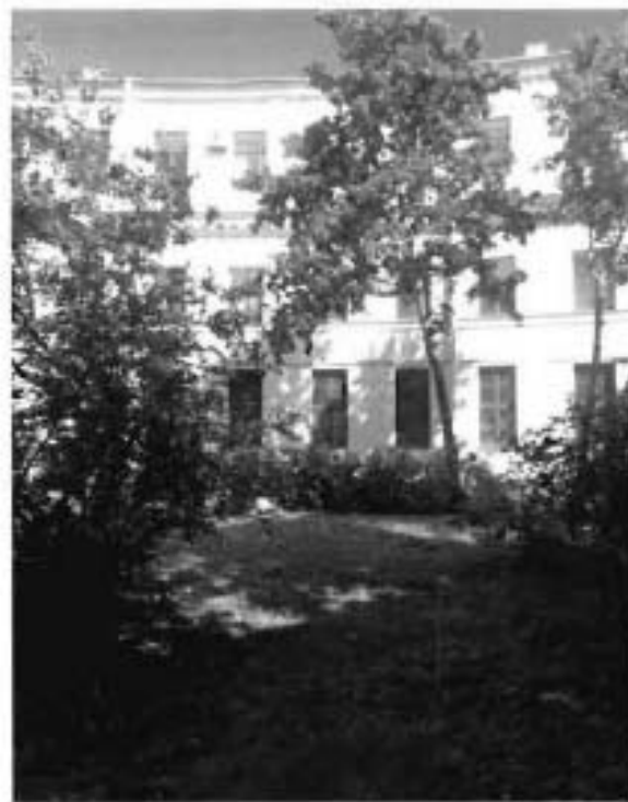
6. Фрагмент внутреннего двора. Вид на восточную часть.
