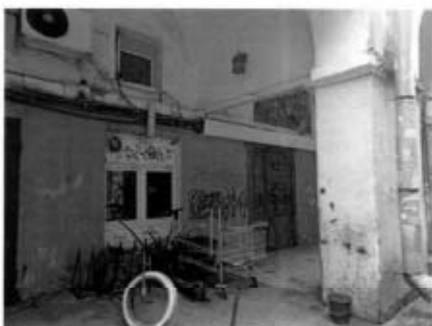
11. Северный дворовой фасад.
