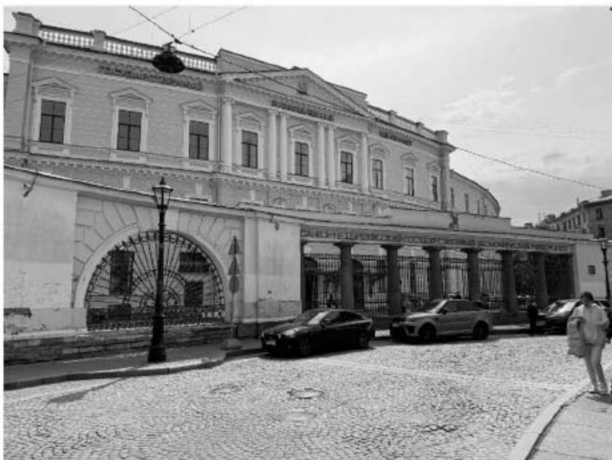
Фото 3. Общий вид на ОЖН «Банк Ассигнационный» (ограда со стороны наб. кан. Грибоедова). Дата фотофиксации: 30.06.2025г.
