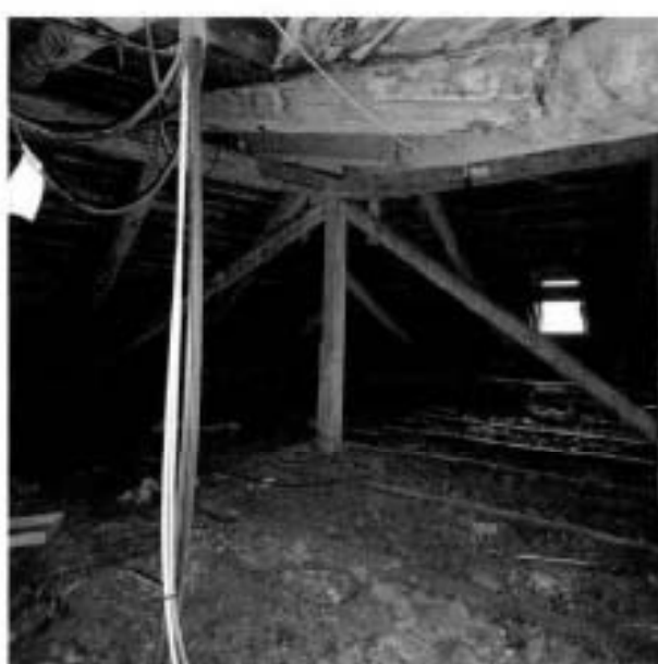
30. Стропильная система.
