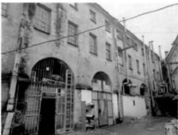
13. Южный дворовой фасад.
