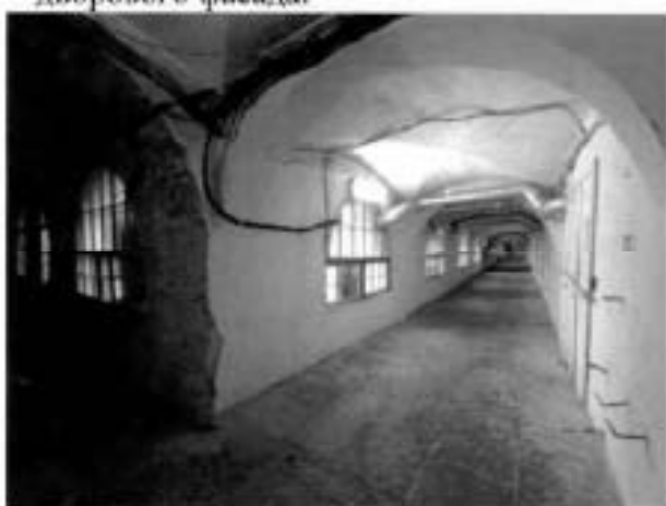
18. Галерея в уровне 3-го этажа.
