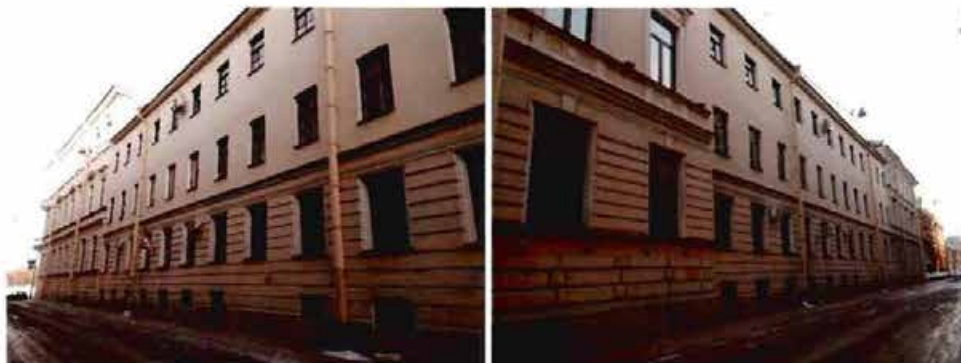
9, 10. Внутренний двор. Северный и южный фасады
