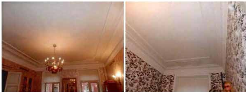
27, 28. Сводчатые потолки в уровне 1 этажа здания (кв. 24)
