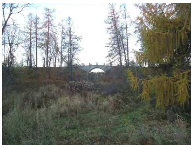
Мост-плотина. Вид от Нижней дороги. Фотография. 2015
