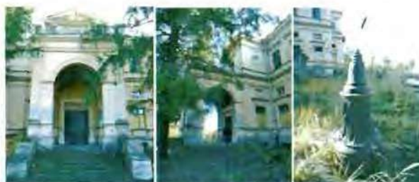
Главный подъезд Большого дворца. Тумба фонаря. Фотография, 2015
