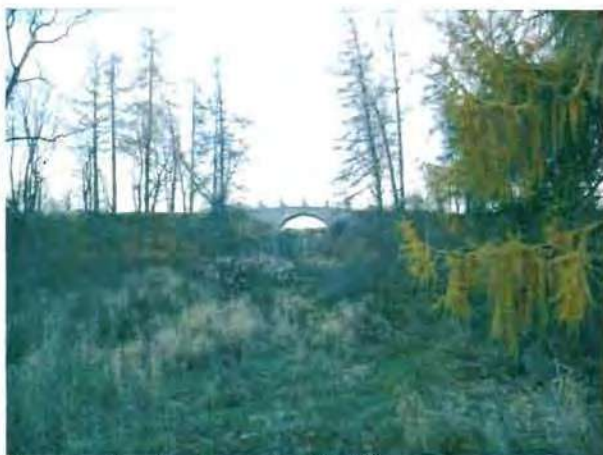
Мост-плотина. Вид от Нижней дороги. Фотография. 2015
