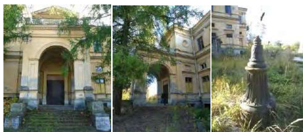
Главный подъезд Большого дворца. Тумба фонаря. Фотография. 2015
