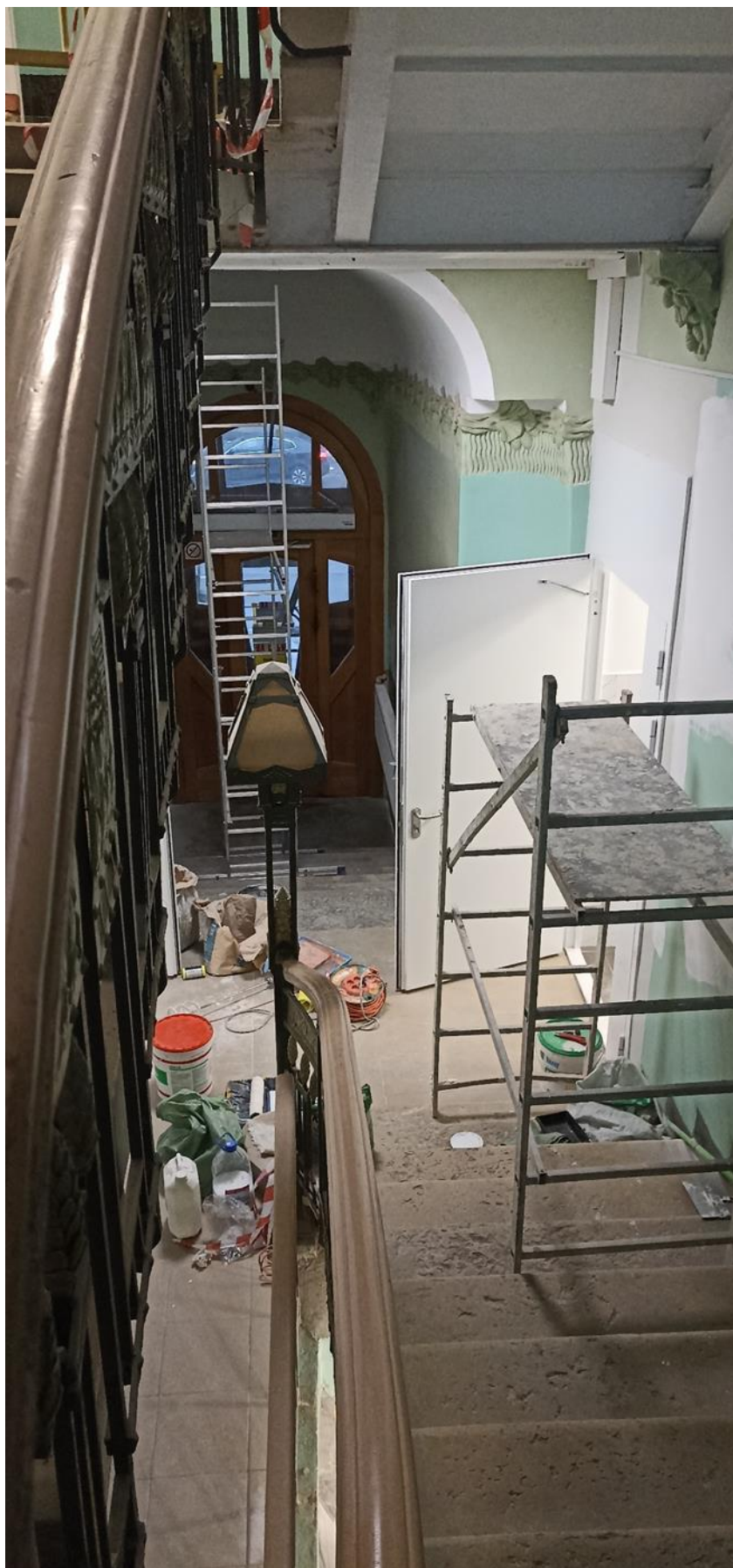
22. Вид сверху на площадку 1-го этажа парадной лестницы.
