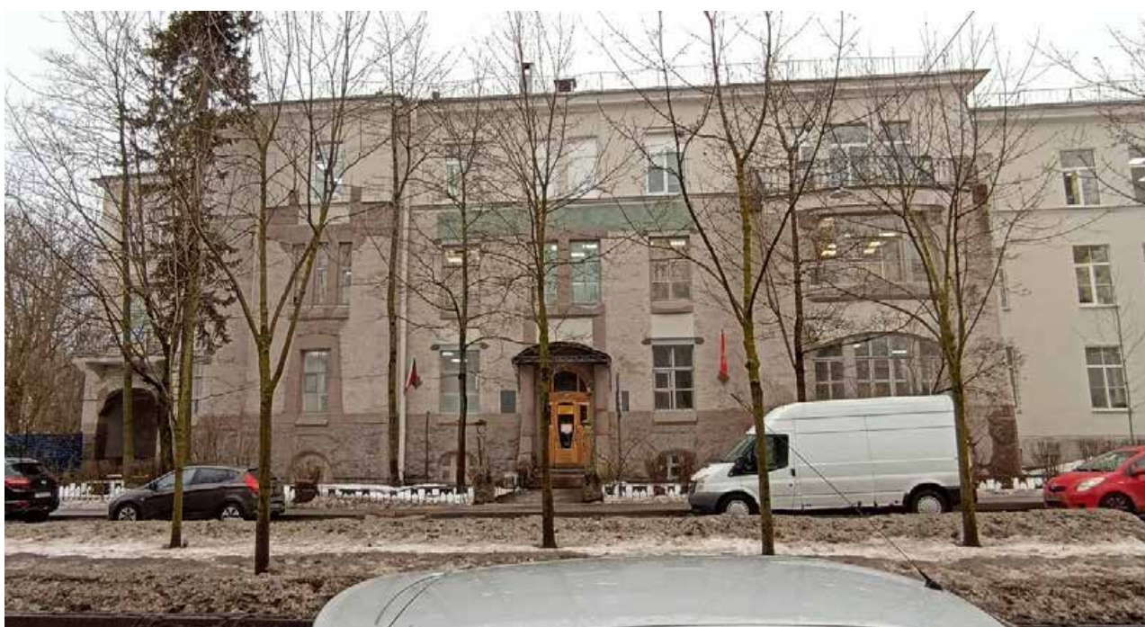
4. Вид на лицевой фасад старого корпуса.
