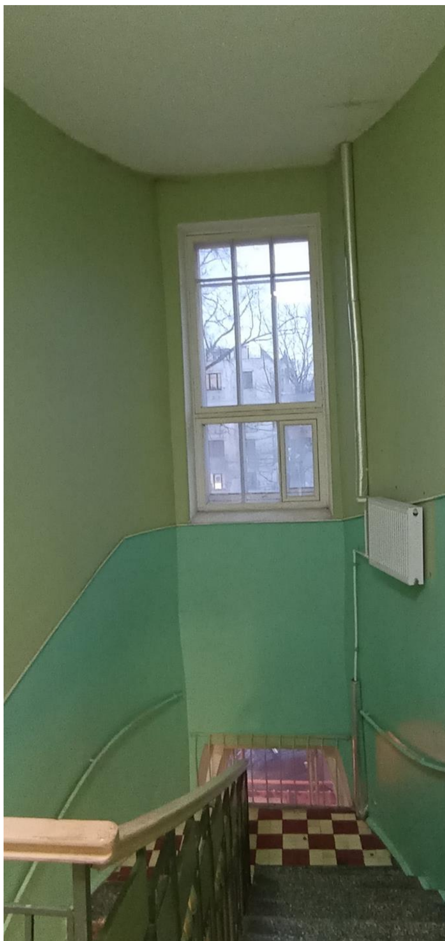
44. Вид сверху на марш между 2-м и 3-м этажами парадной лестницы.
