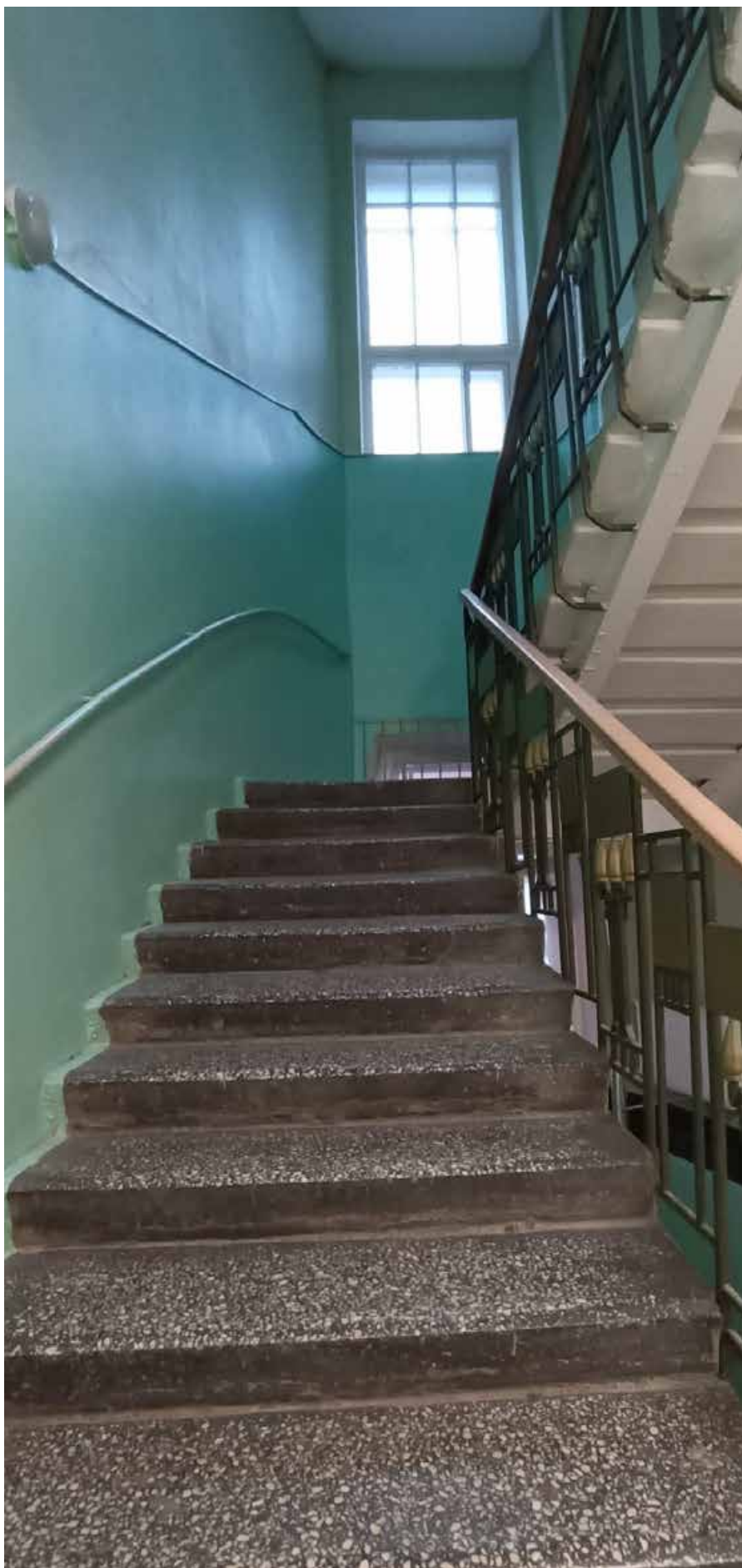
32. Марш парадной лестницы между 1-м и 2-м этажами.
