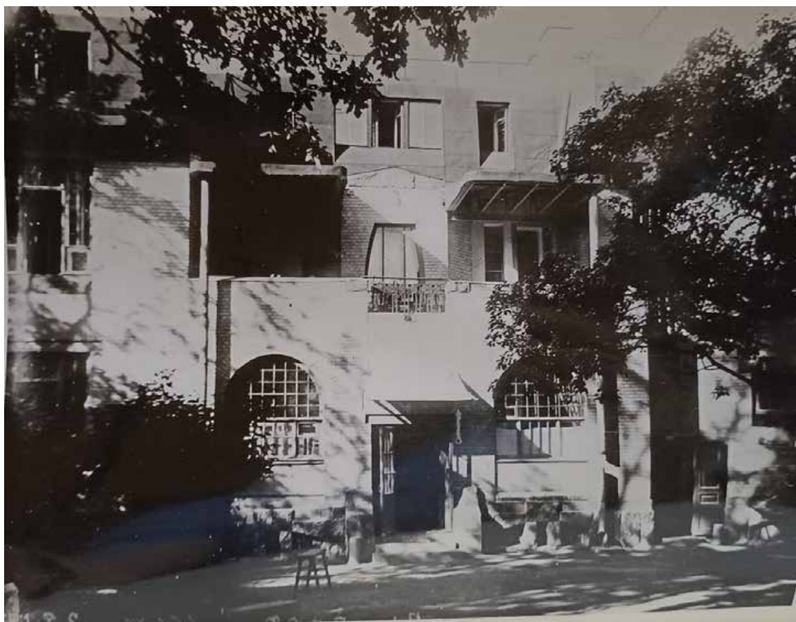
31. Фрагмент дворового фасада старого корпуса. Фото 1989 г. Л.37.
