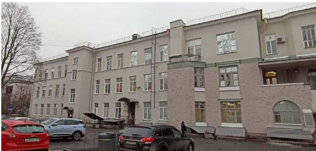
9. Вид на дворовой фасад нового корпуса с юго-востока.
