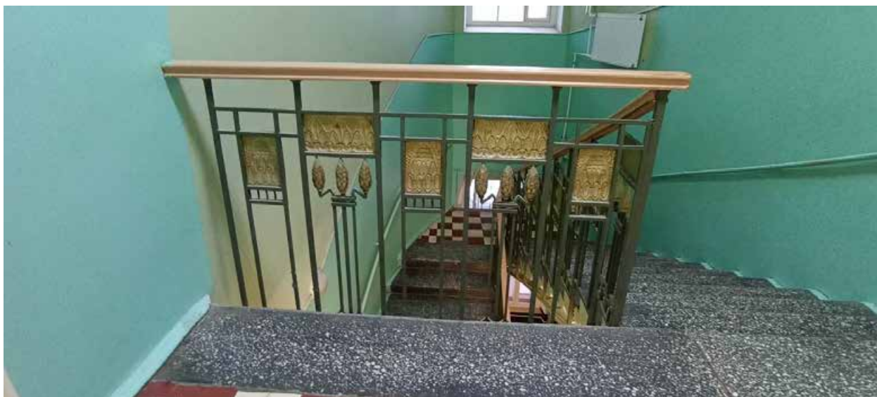
45. Вид на парадную лестницу с площадки 3-го этажа. Фрагмент исторического ограждения парадной лестницы.
