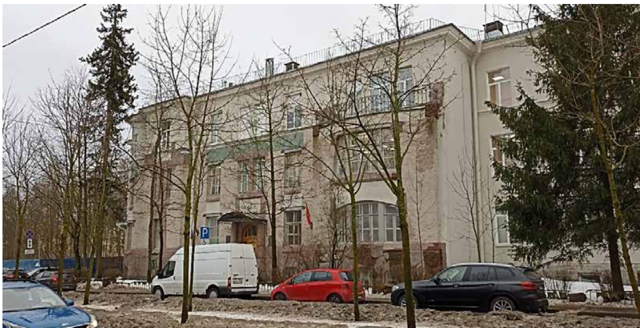
5. Вид на лицевой фасад старого корпуса с северо-запада.
