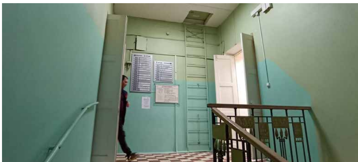
43. Вид снизу на площадку 3-го этажа парадной лестницы.
