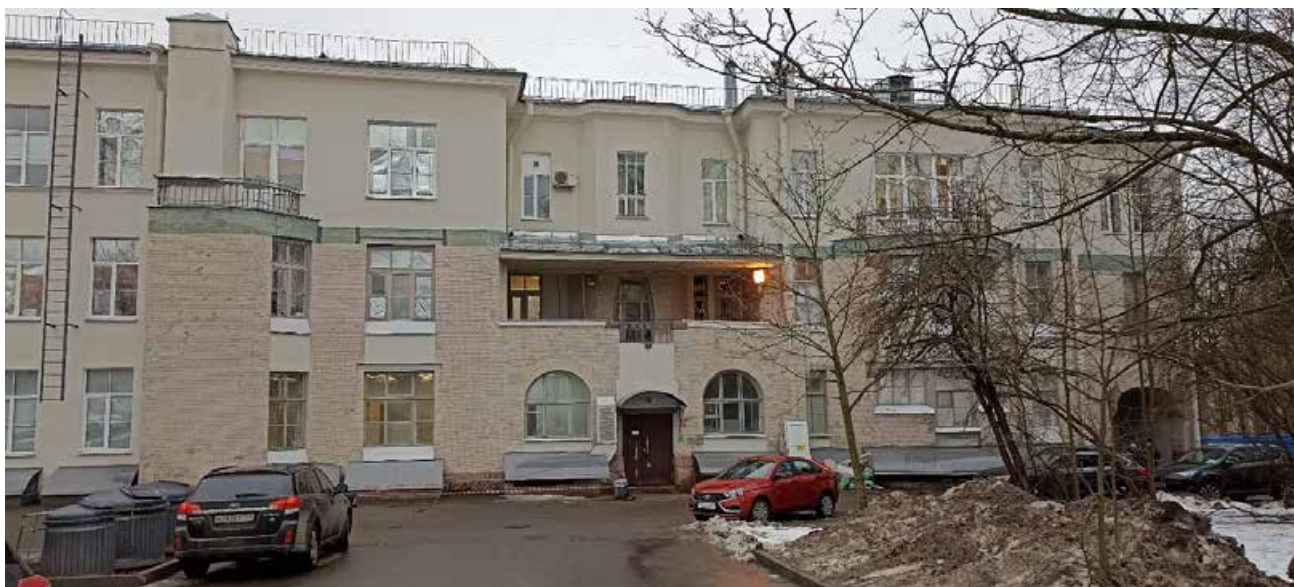
10. Вид на дворовой фасад старого корпуса с юго-запада.
