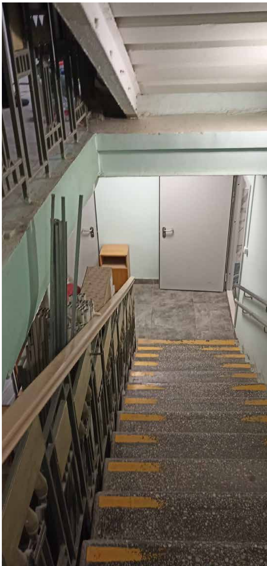
20. Парадная лестница, вид сверху на подвальный этаж.
