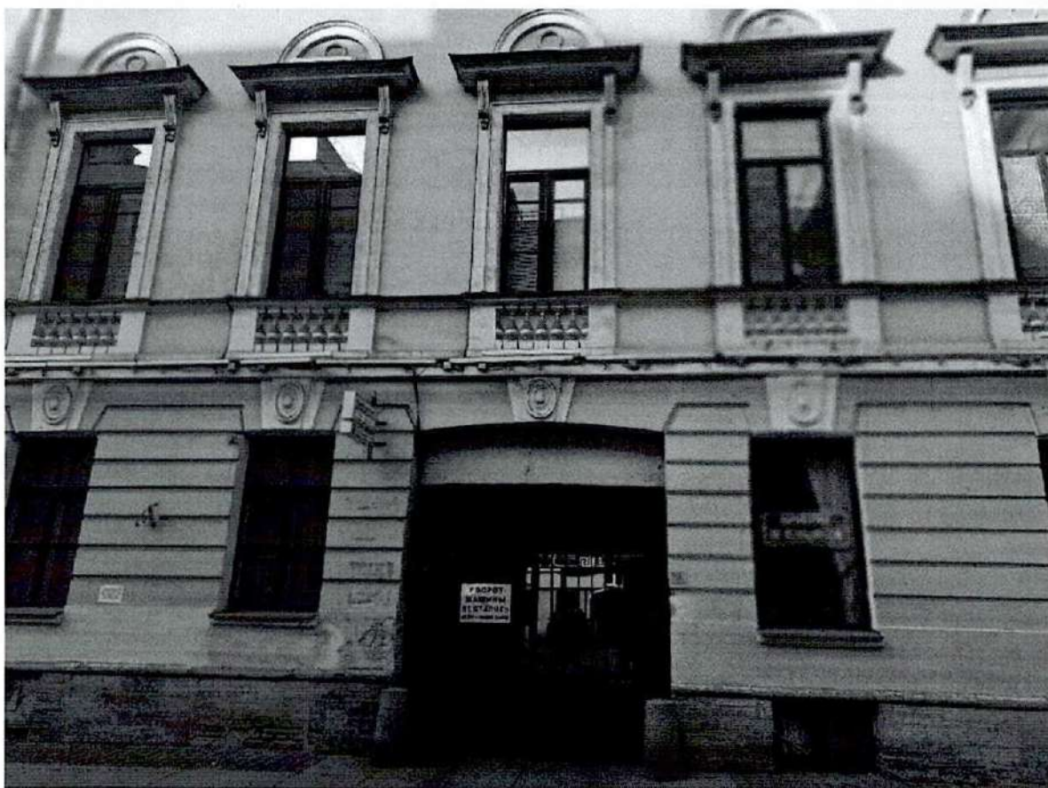
5. Фрагмент лицевого фасада Итальянская улица
