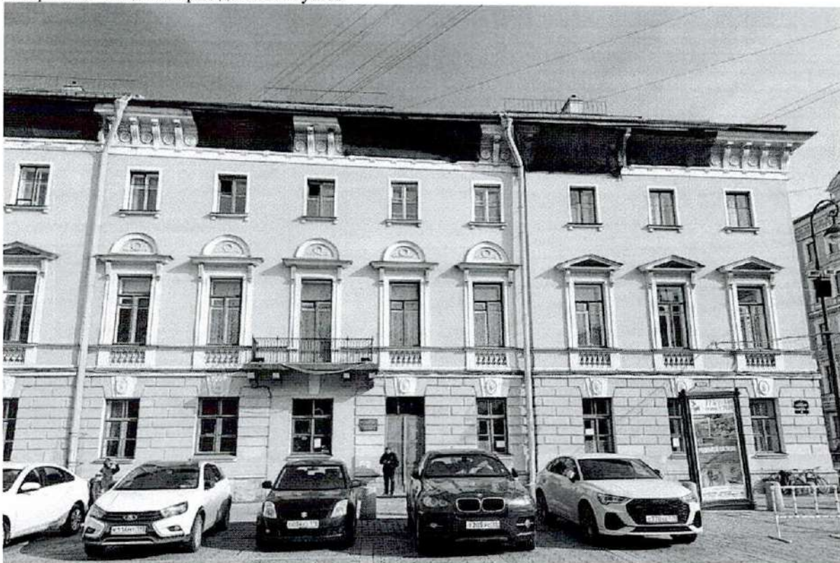
9. Фрагмент лицевого фасада пл. Искусств
