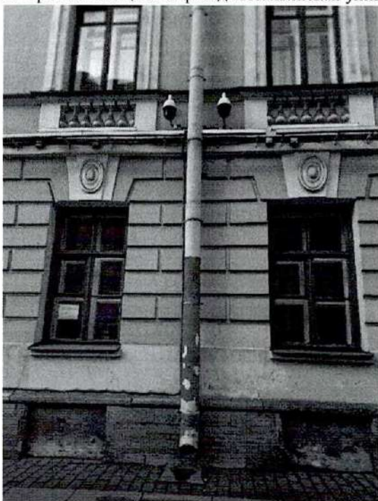
6. Фрагмент лицевого фасада Итальянская улица
