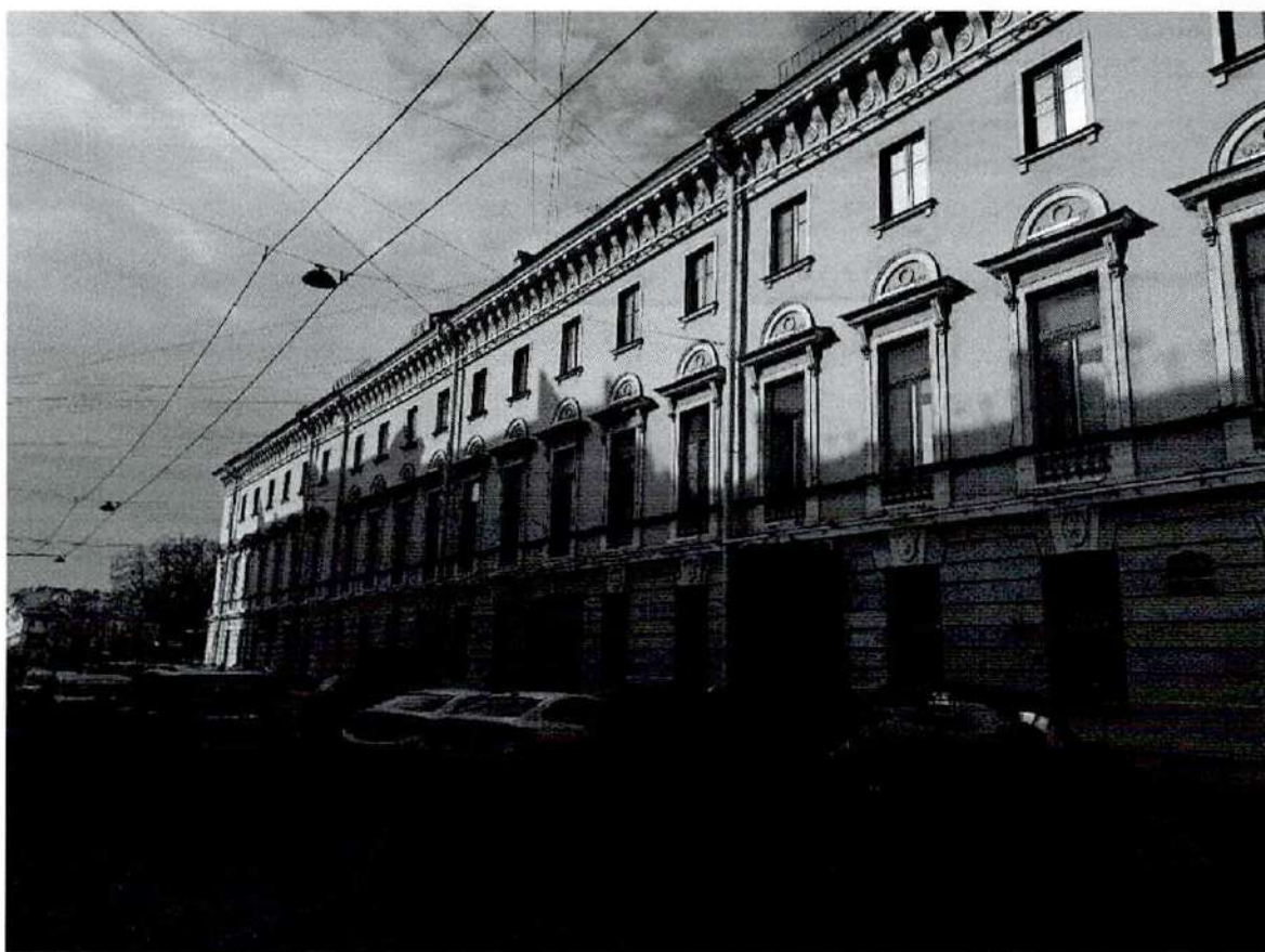
1. Фрагмент лицевого фасада Итальянская улица
