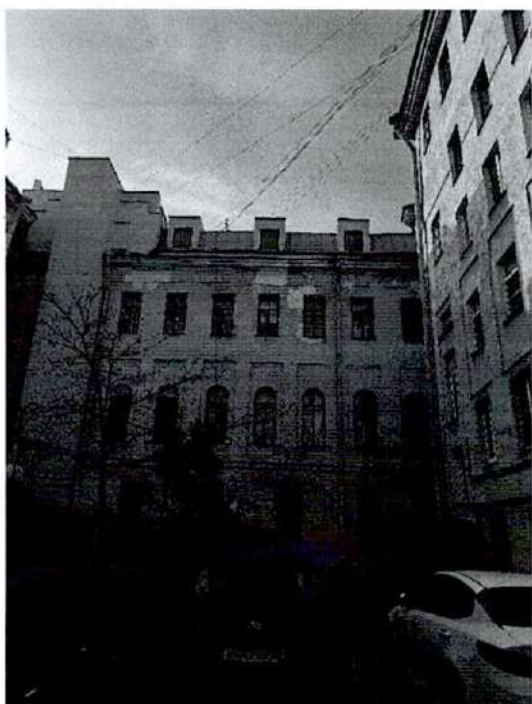
21. Фрагмент фасадов западного внутреннего двора
