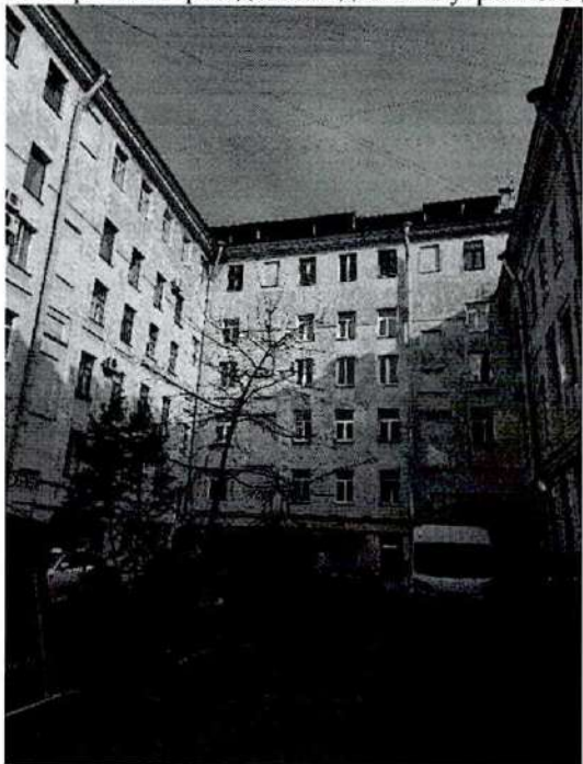
23. Фрагмент фасадов западного внутреннего двора
