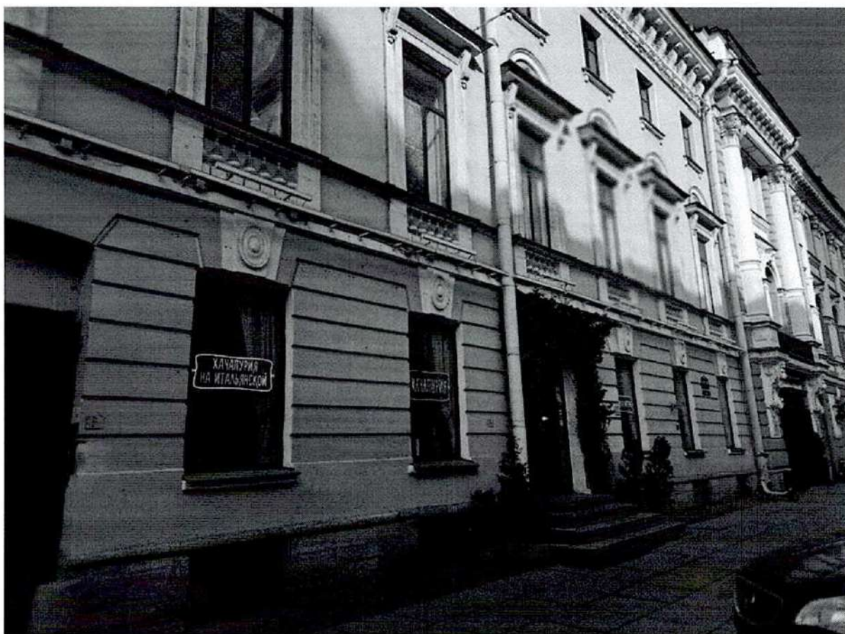
3. Фрагмент лицевого фасада Итальянская улица
