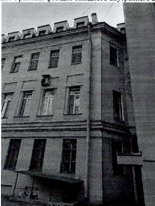
27. Фрагмент фасадов западного внутреннего двора
