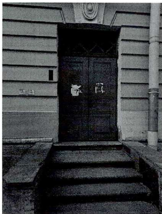
7. Фрагмент лицевого фасада Итальянская улица
