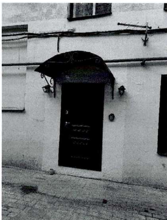
25. Фрагмент фасадов западного внутреннего двора
