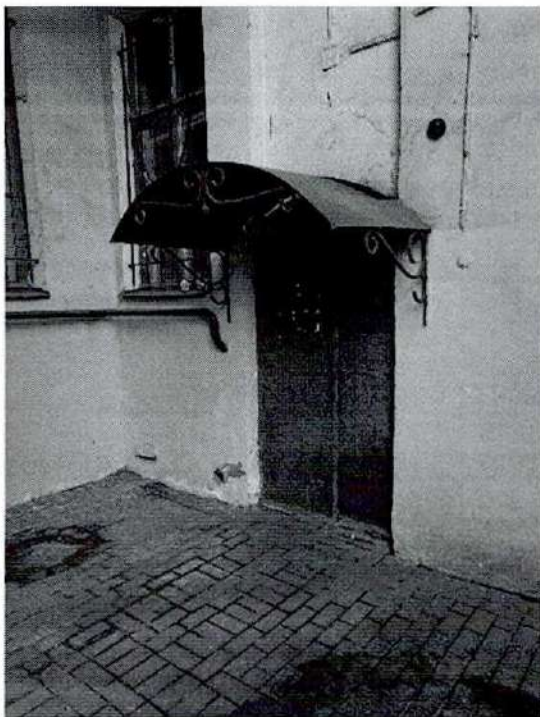
29. Фрагмент фасадов западного внутреннего двора
