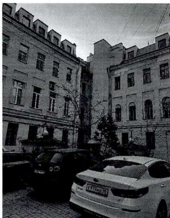
22. Фрагмент фасадов западного внутреннего двора
