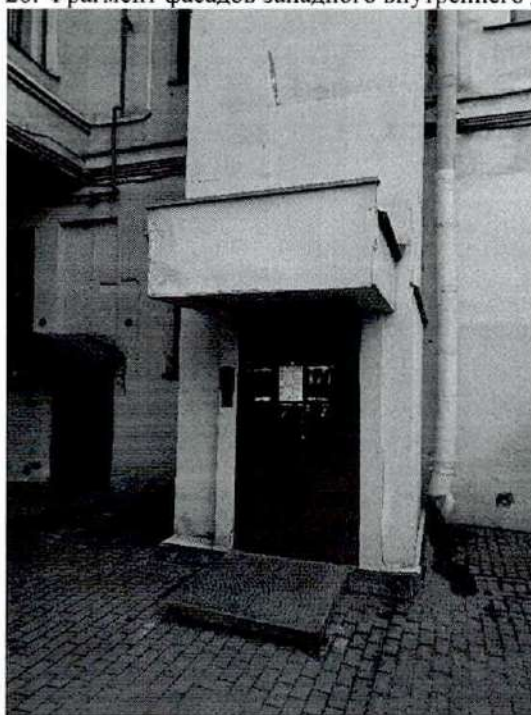
28. Фрагмент фасадов западного внутреннего двора
