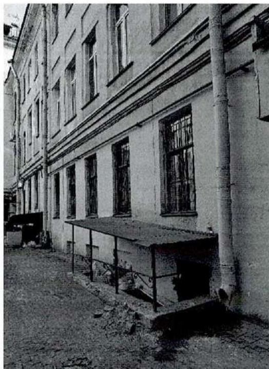
30. Фрагмент фасадов западного внутреннего двора
