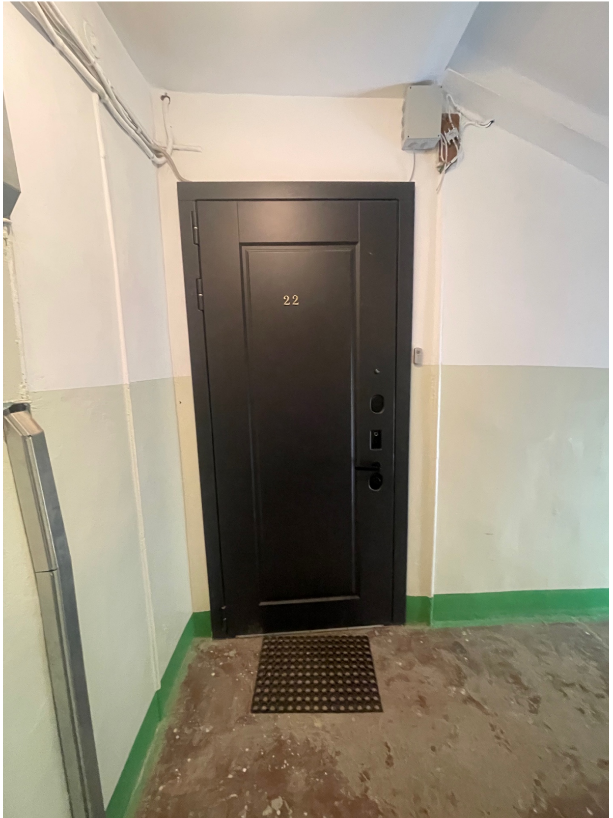
3. Входная дверь в квартиру №22.
