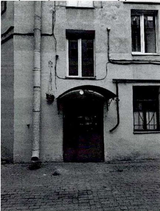
31. Фрагмент фасадов западного внутреннего двора
