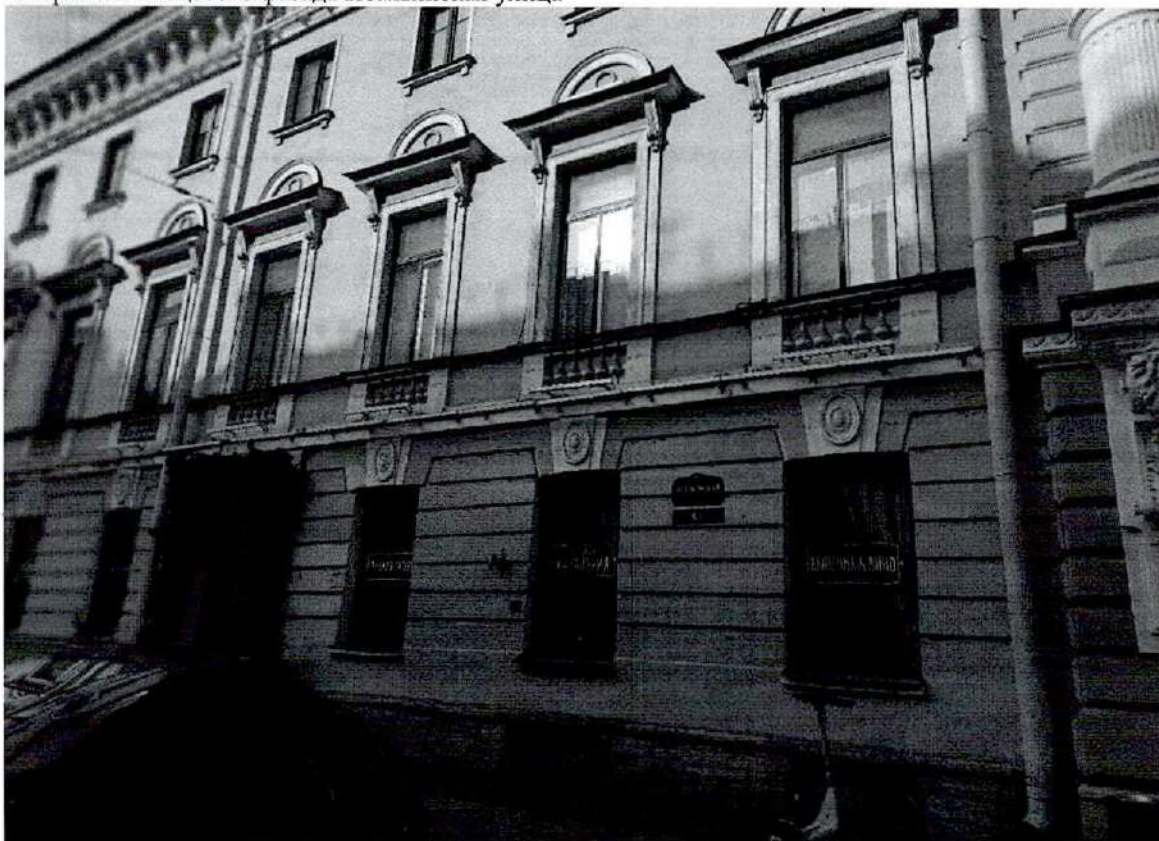
2. Фрагмент лицевого фасада Итальянская улица
