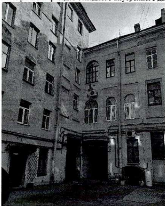
24. Фрагмент фасадов западного внутреннего двора
