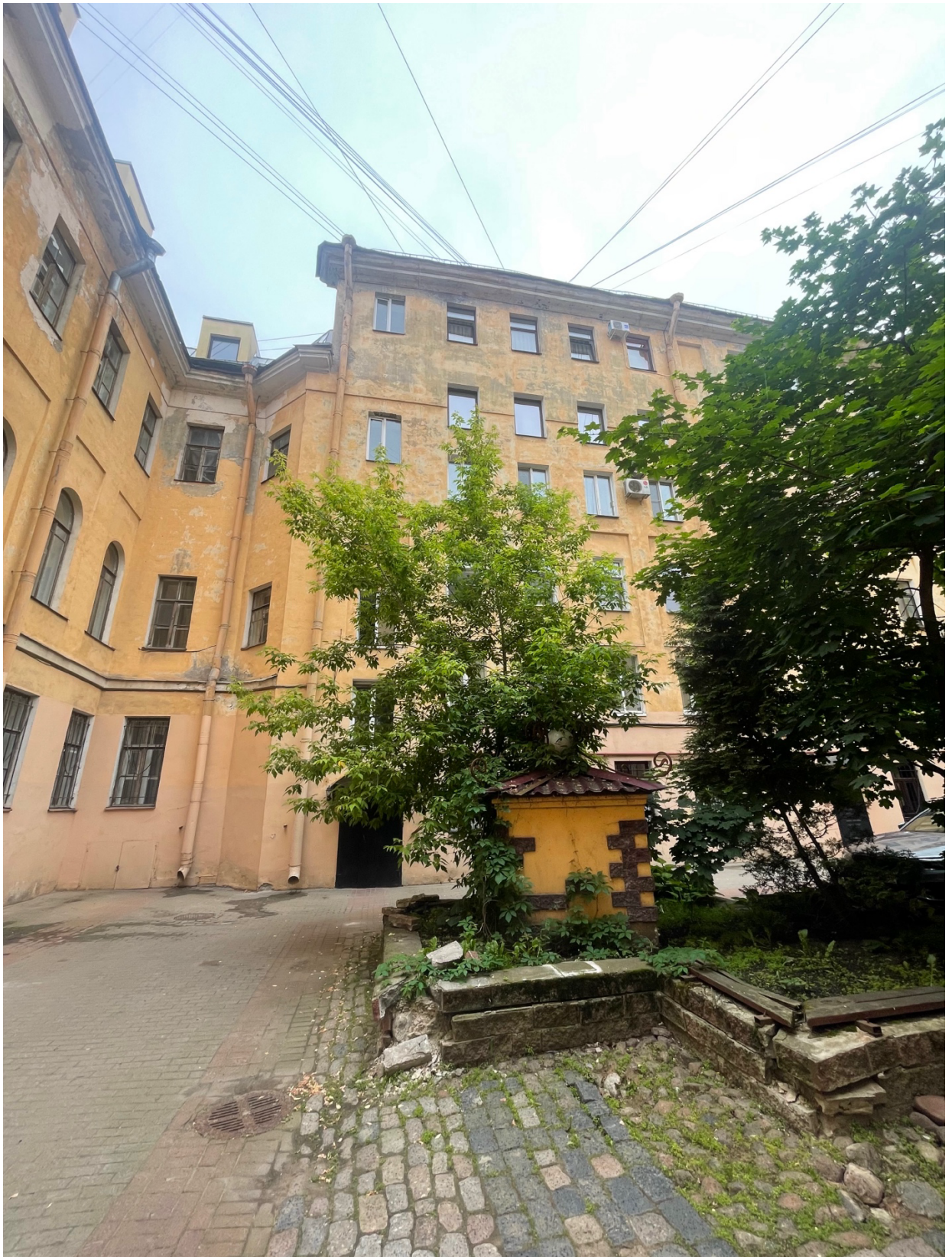
1. Фрагмент дворового фасада.
