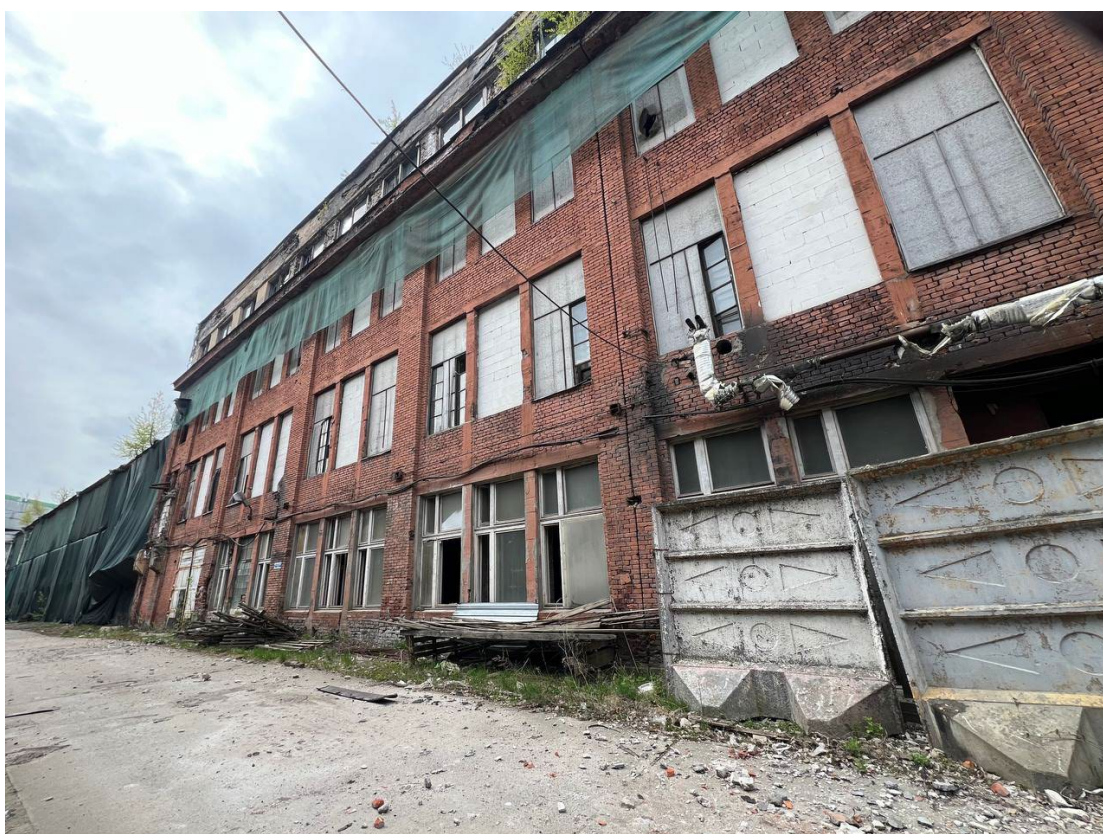
8. Вид от выявленного объекта культурного наследия «Кожевенный завод А.А. Парамонова. Котельная», по адресу: г. Санкт-Петербург, Кожевенная линия, д. 1-3, литера Д, на зону производства работ. 14.04.2025
