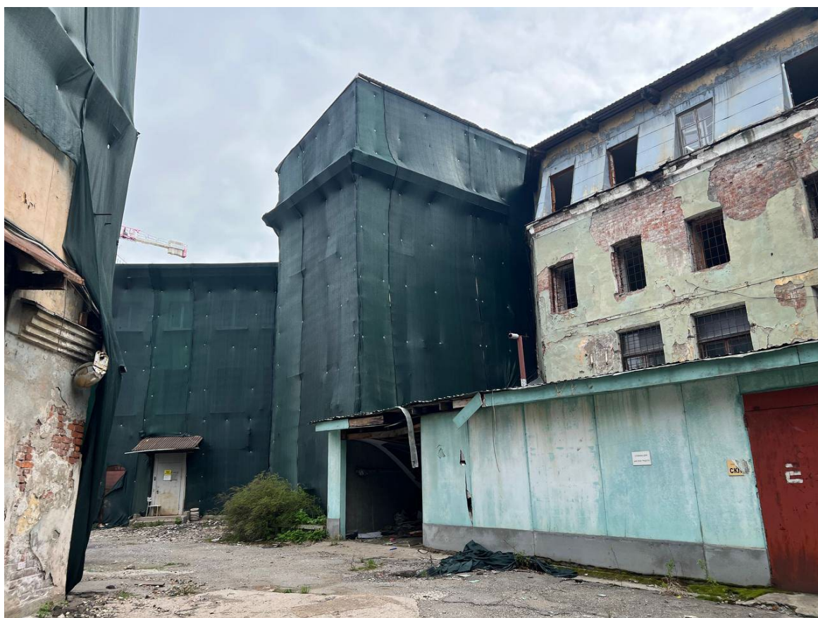
10. Вид на выявленный объект культурного наследия «Кожевенный завод А.А. Парамонова. Особняк владельца», по адресу: г. Санкт-Петербург, Кожевенная линия, д. 1-3, литера Р, от зоны производства работ. 14.04.2025
