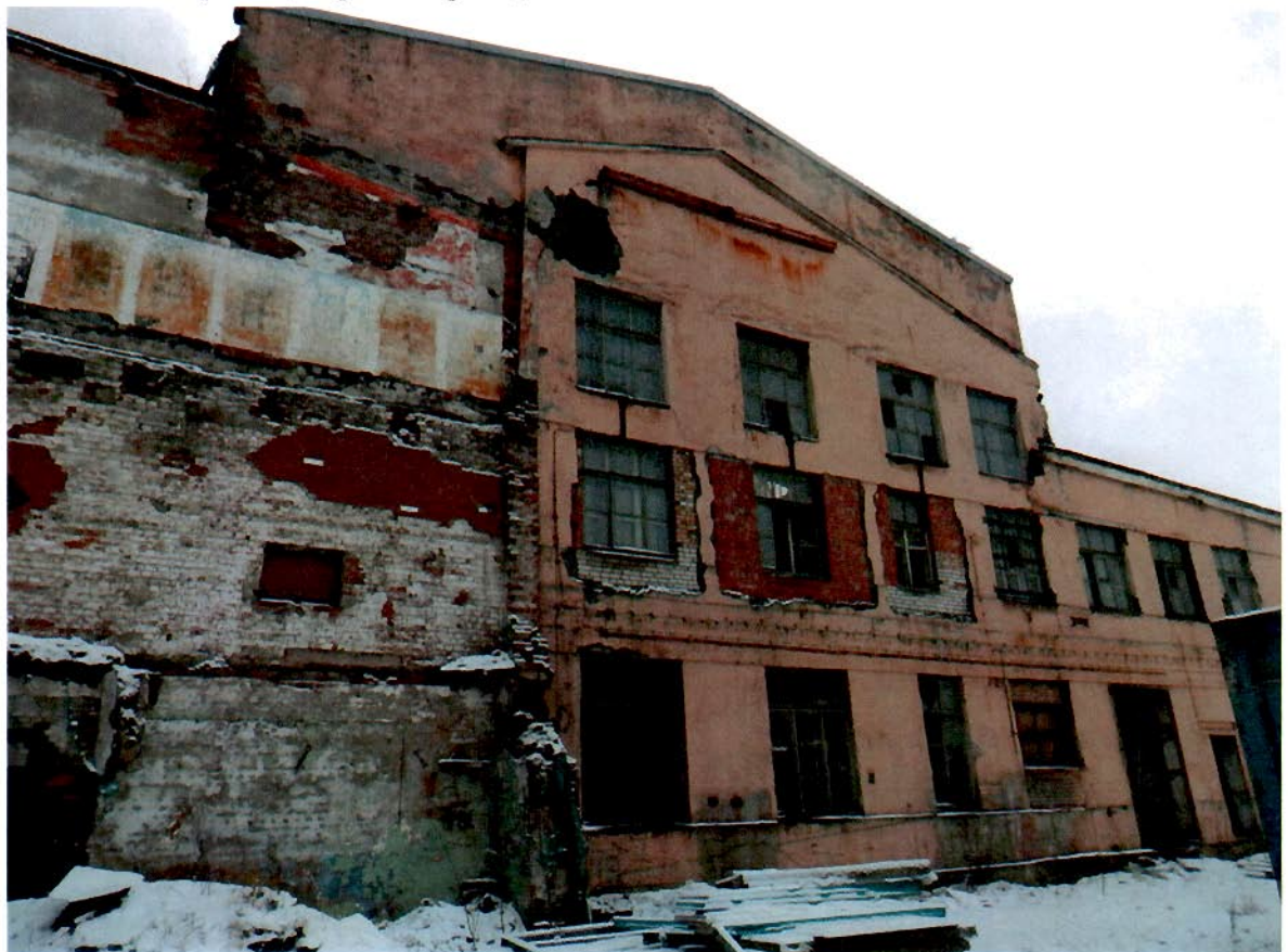
4. Северный дворовый фасад
