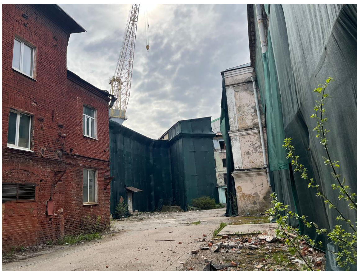
11. Вид на выявленный объект культурного наследия «Кожевенный завод А.А. Парамонова. Особняк владельца», по адресу: г. Санкт-Петербург, Кожевенная линия, д. 1-3, литера Р, от зоны производства работ. 14.04.2025
