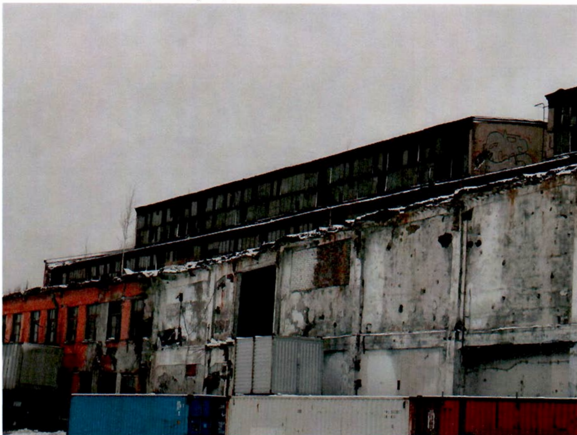
5. Западный дворовый фасад
