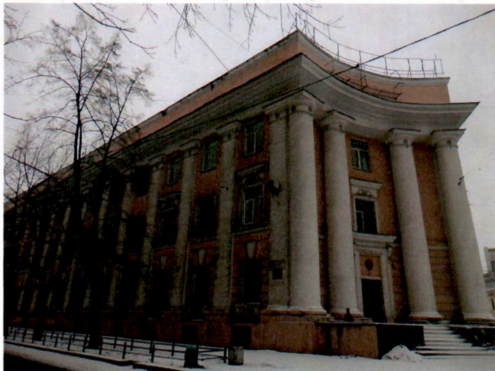
1. Северо-восточный лицевой фасад (со стороны 25-й линии В.О.)
