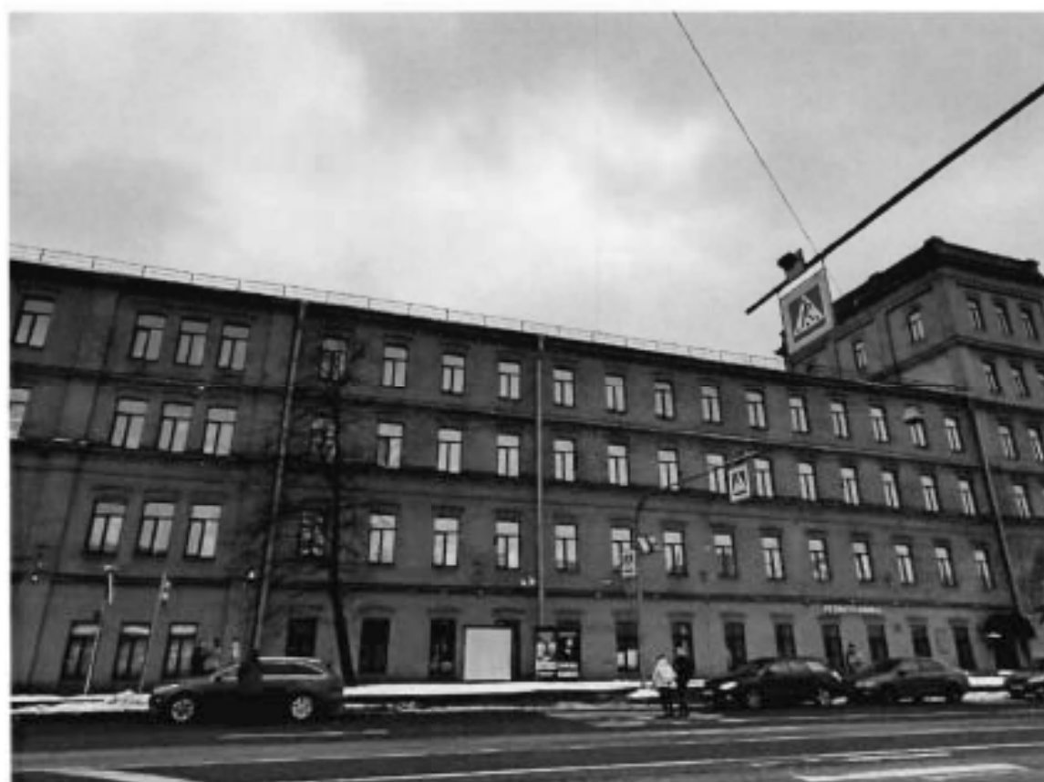
1. Северный лицевой фасад объекта культурного наследия.
