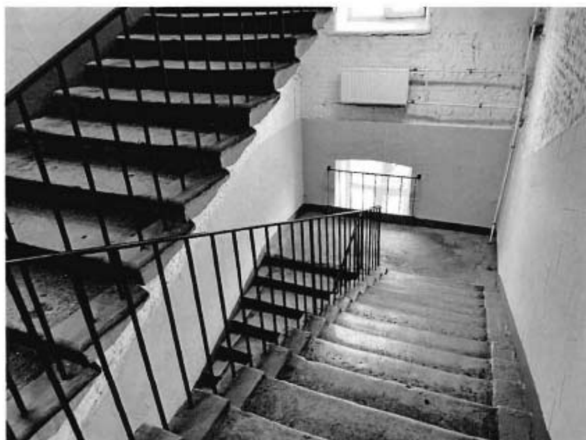
3. Межэтажная лестница объекта культурного наследия.
