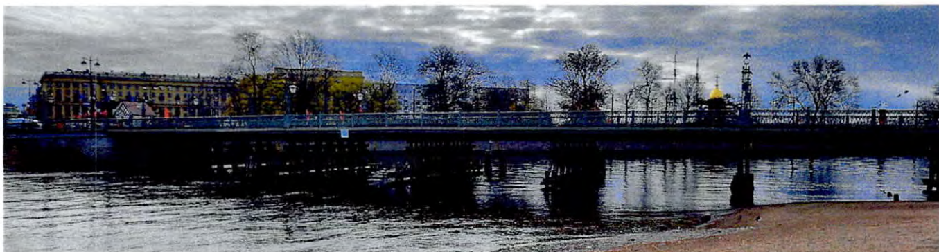
Иоанновский мост низовая сторона.
