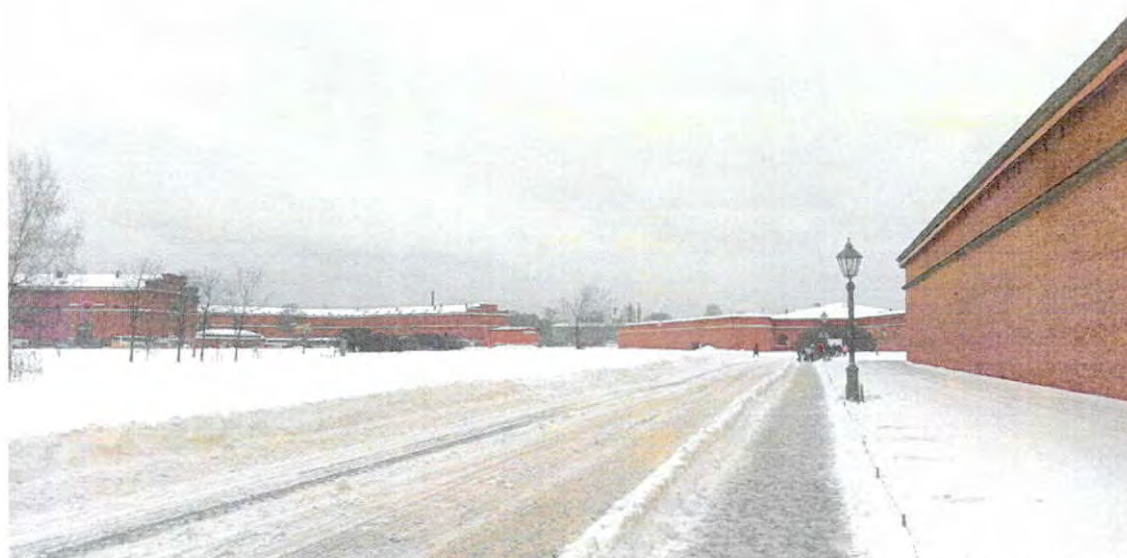
9,10,11. Фрагменты покрытий дорожно-тропиночной сети, ограждений и элементов наружного освещения территории.
