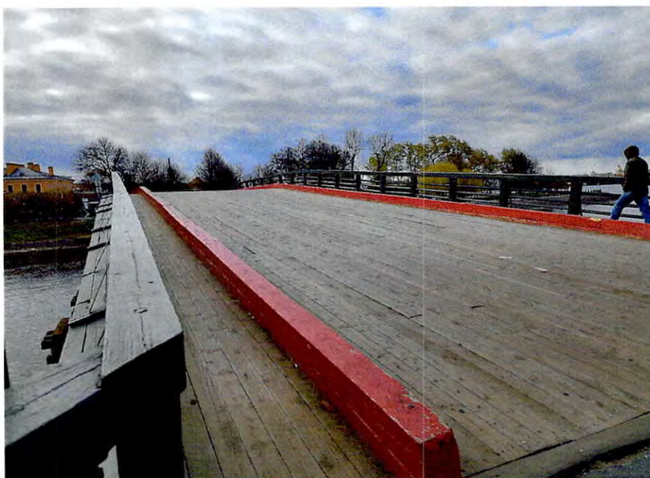
Деревянный настил Кронверкского моста.
