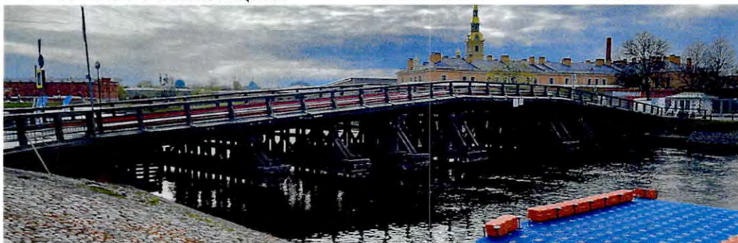
Кронверкский мост низовая сторона.
