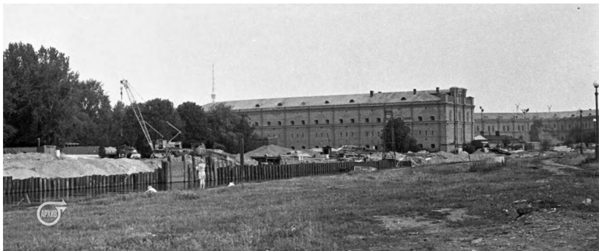
17. Строительство Кронверкской набережной. 1975-1977 гг. // pastvu URL: https://pastvu.com/ ;
