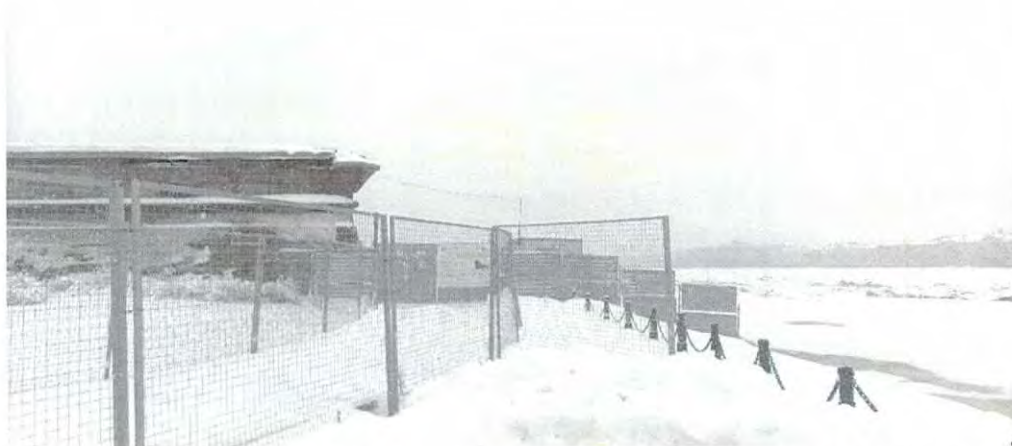
15,16,17. Информационный щит, временное ограждение зоны работ на территории объекта культурного наследия.
