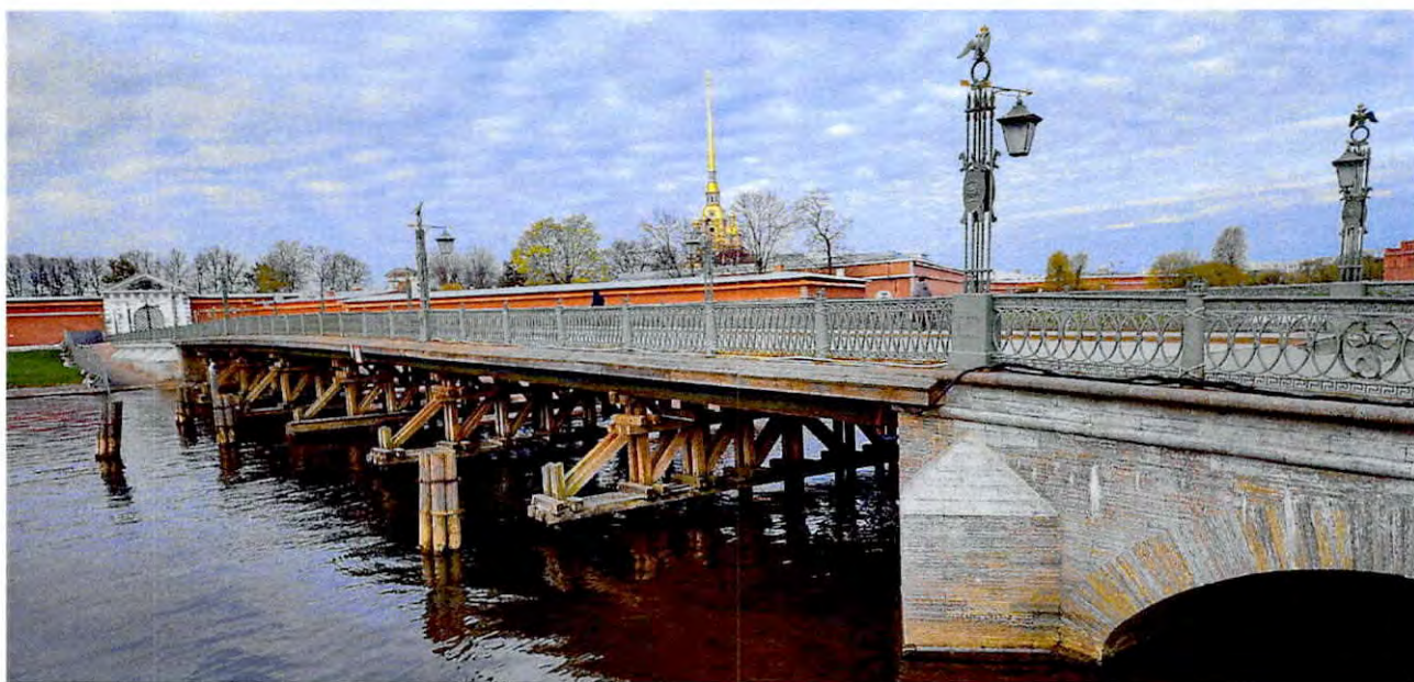
Верховая сторона Иоанновского моста.
