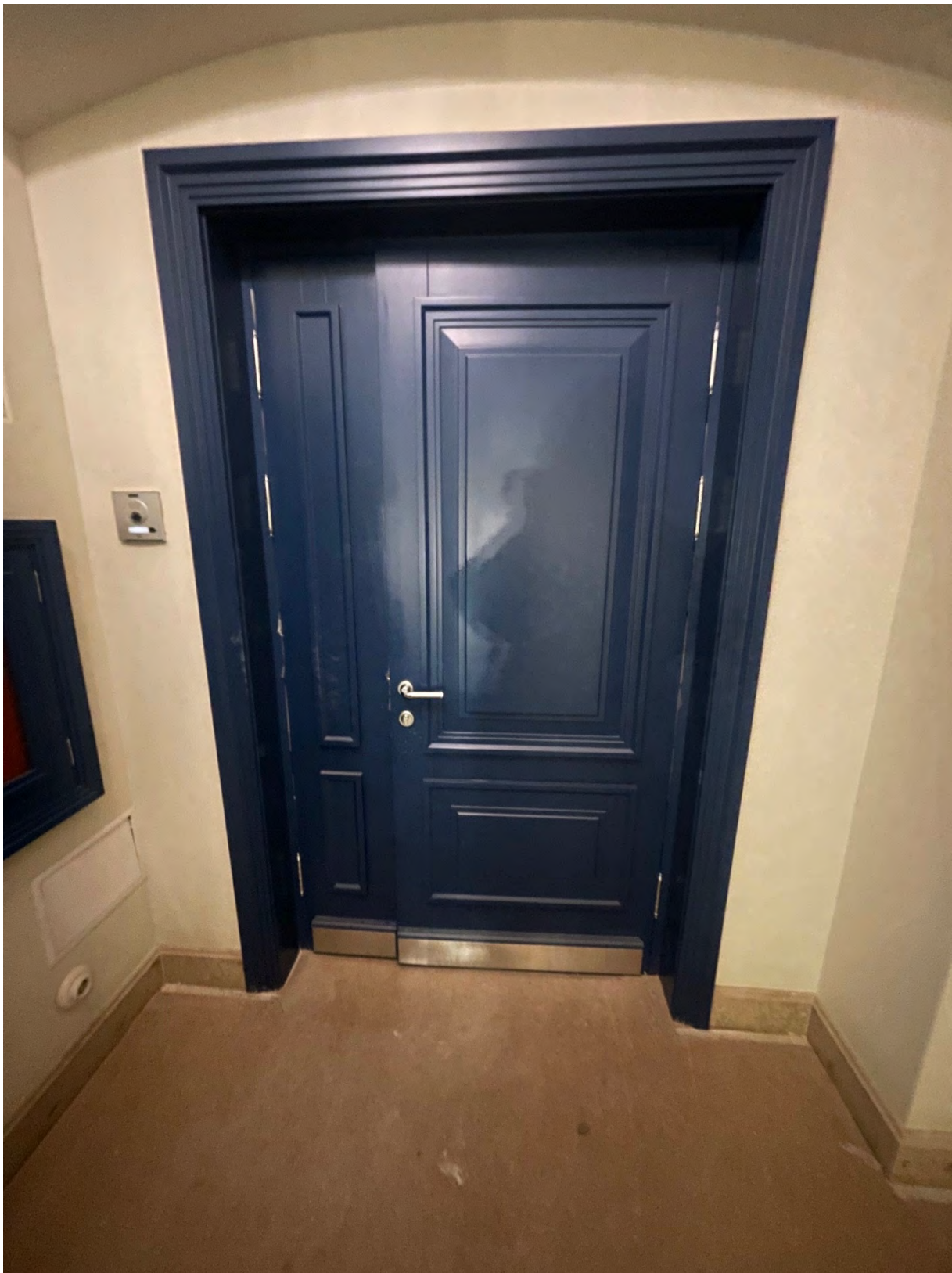
15. Входная дверь помещения 97-Н.
