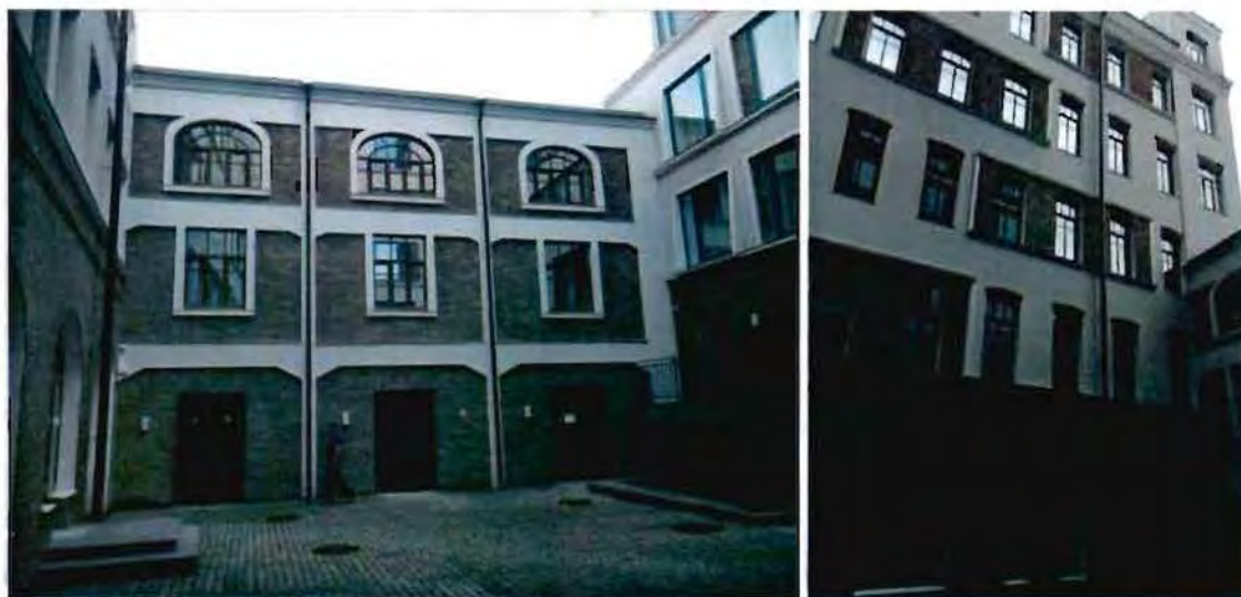
7, 8. Фасад лицевого корпуса по наб. Адмиралтейского канала
