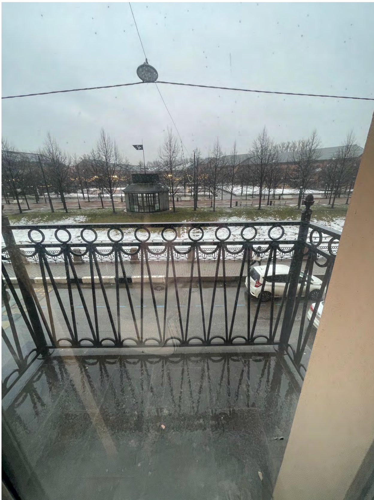
19.Балкон со стороны лицевого фасада, помещение 97-Н.
