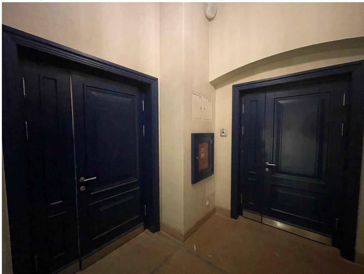
6. Входные двери в помещения 96-Н и 97-Н.
