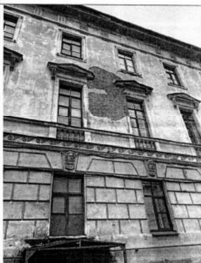
Фото 6. Фрагмент северного дворового фасада объекта культурного наследия.
