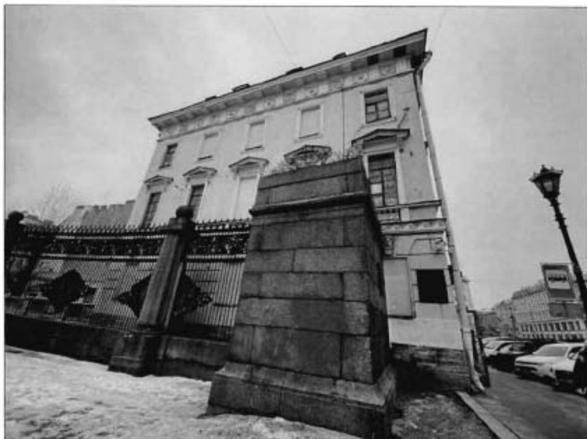
2. Южный лицевой фасад объекта культурного наследия.
