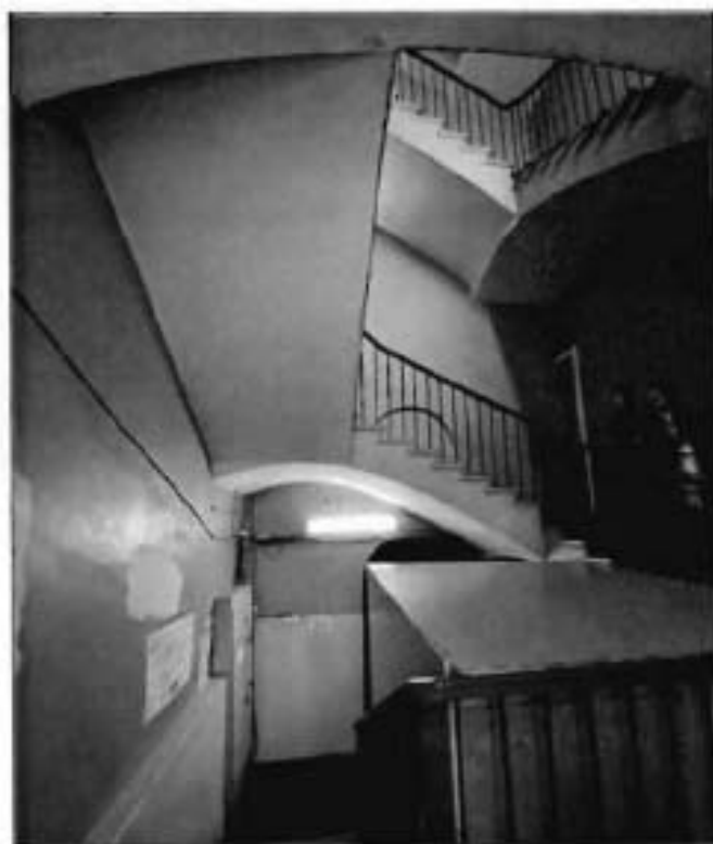
5. Лестница (Л-1) объекта культурного наследия.
