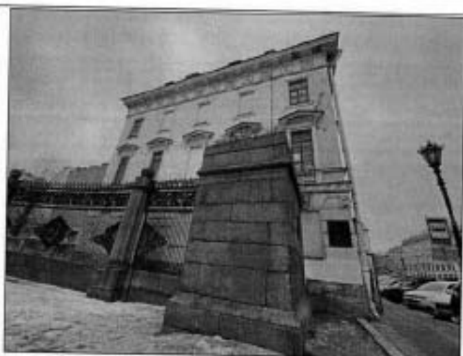
Фото 2. Южный лицевой фасад объекта культурного наследия.
