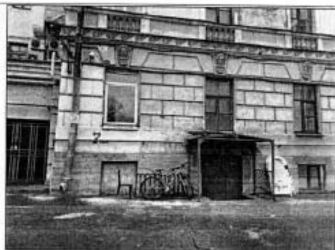
Фото 4. Фрагмент северного дворового фасада объекта культурного наследия.
