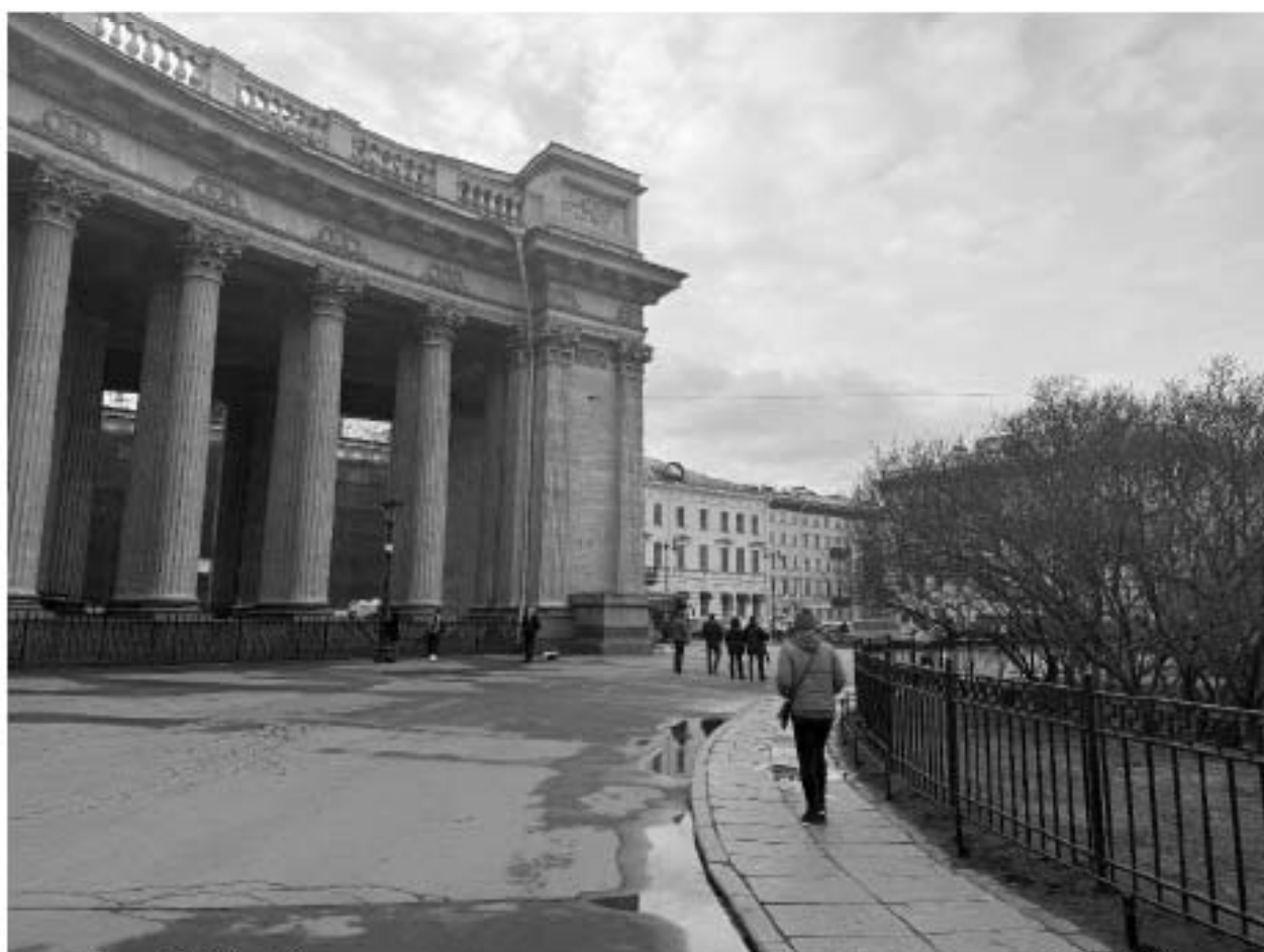
Фото 11. Общий вид на территорию проектирования. Дата фотофиксации: 09.04.2025г.
