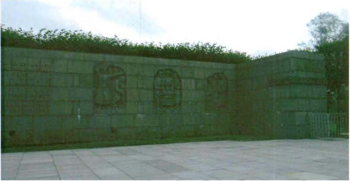
Западная часть стены главного мемориала с барельефами «Пьета», «Ополченцы» и «Прорыв блокады».
