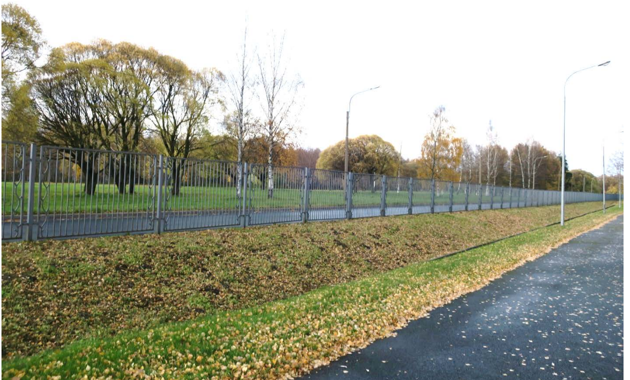
14. Западная часть ограды объекта культурного наследия федерального значения «Кладбище Пискаревское», расположенного по адресу: г. Санкт-Петербург, пр. Непокоренных, д. 72 литера А. 15.10.2021
