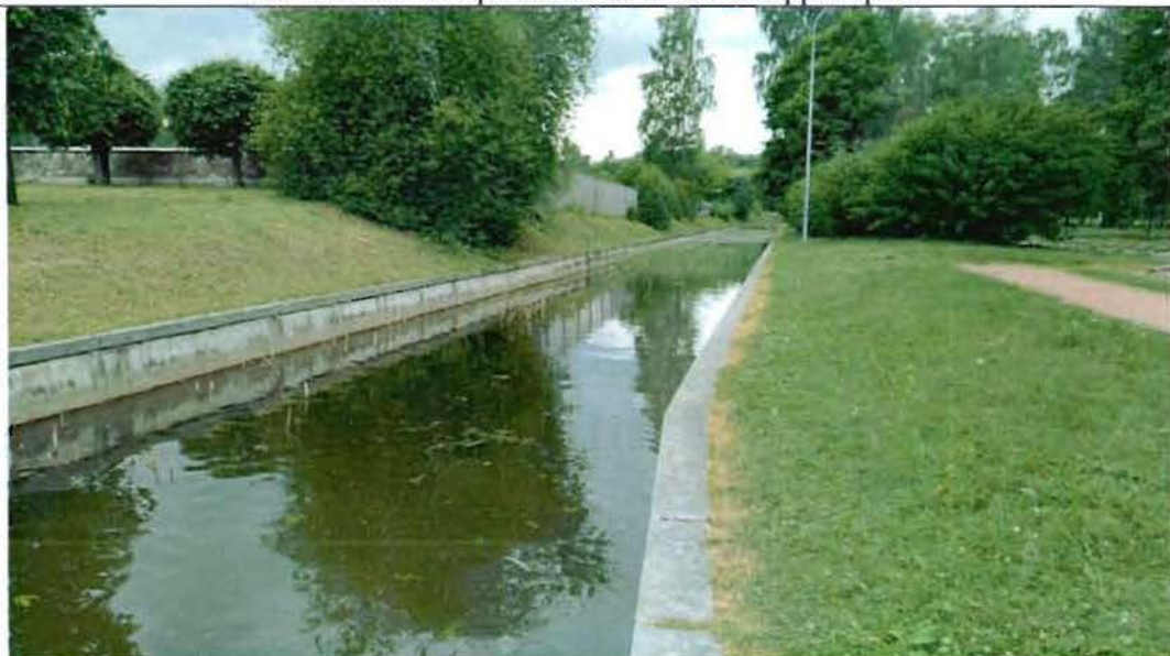
22. Водоотводной канал в юго-западной части территории.
