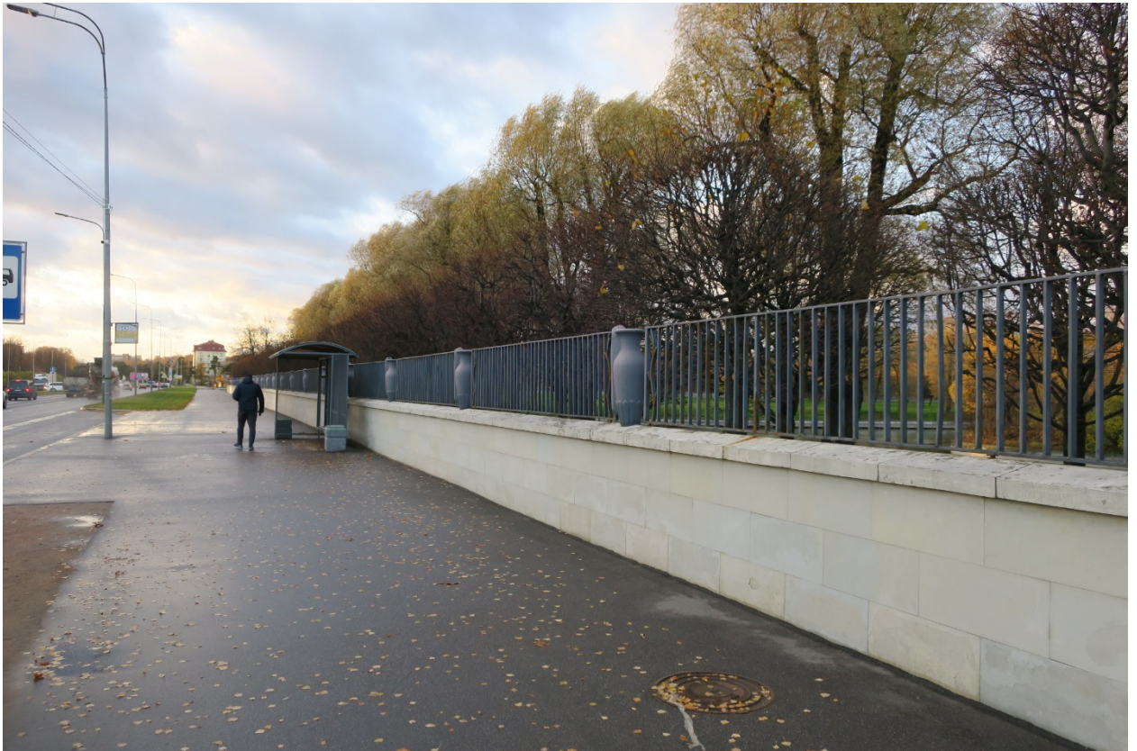
9. Южная часть ограды объекта культурного наследия федерального значения «Кладбище Пискаревское», расположенного по адресу: г. Санкт-Петербург, пр. Непокоренных, д. 72 литера А. Западная сторона. 15.10.2021
