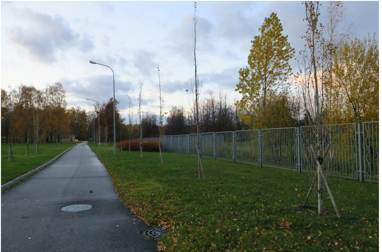
16. Северная часть ограды объекта культурного наследия федерального значения «Кладбище Пискаревское», расположенного по адресу: г. Санкт-Петербург, пр. Непокоренных, д. 72 литера А. 15.10.2021
