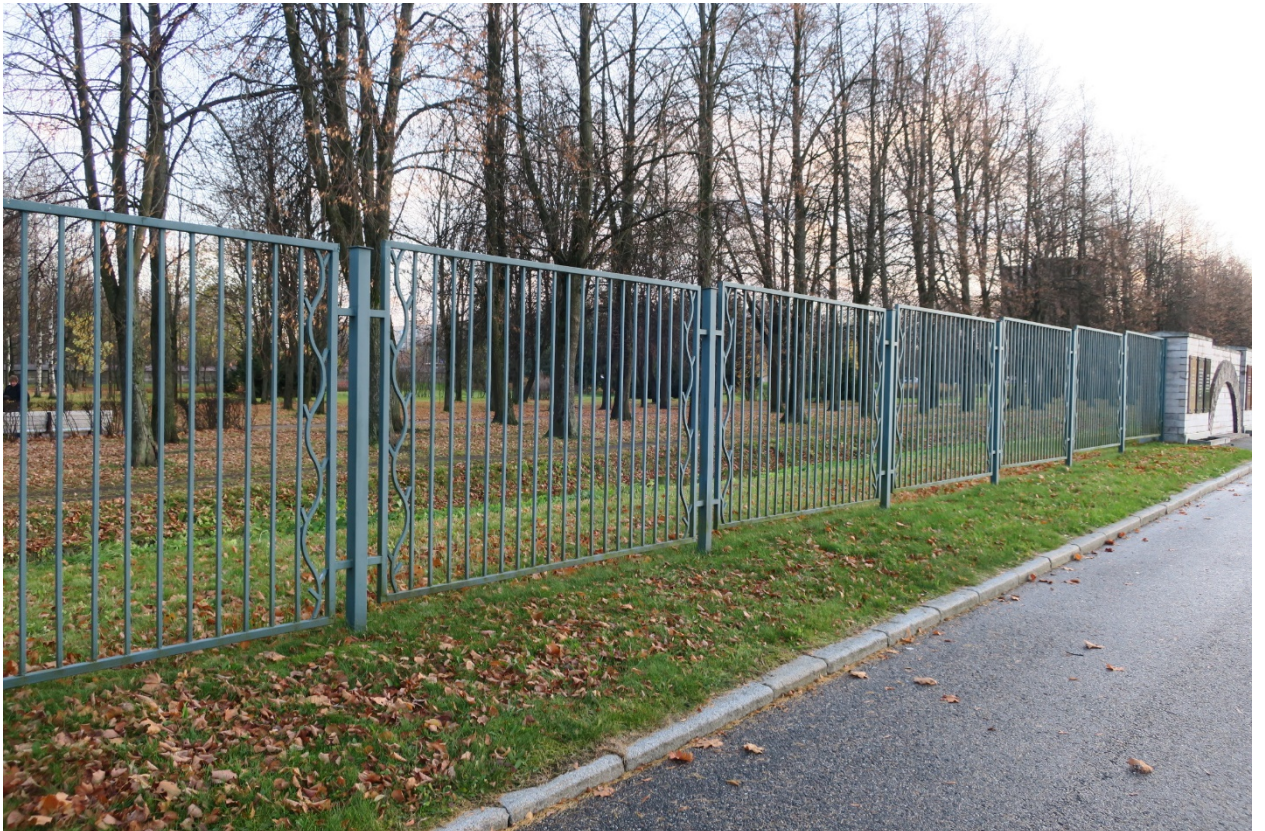
22. Восточная ограда вдоль аллеи Памяти объекта культурного наследия федерального значения «Кладбище Пискаревское», расположенного по адресу: г. Санкт-Петербург, пр. Непокоренных, д. 72 литера А. Фрагмент. 15.10.2021
