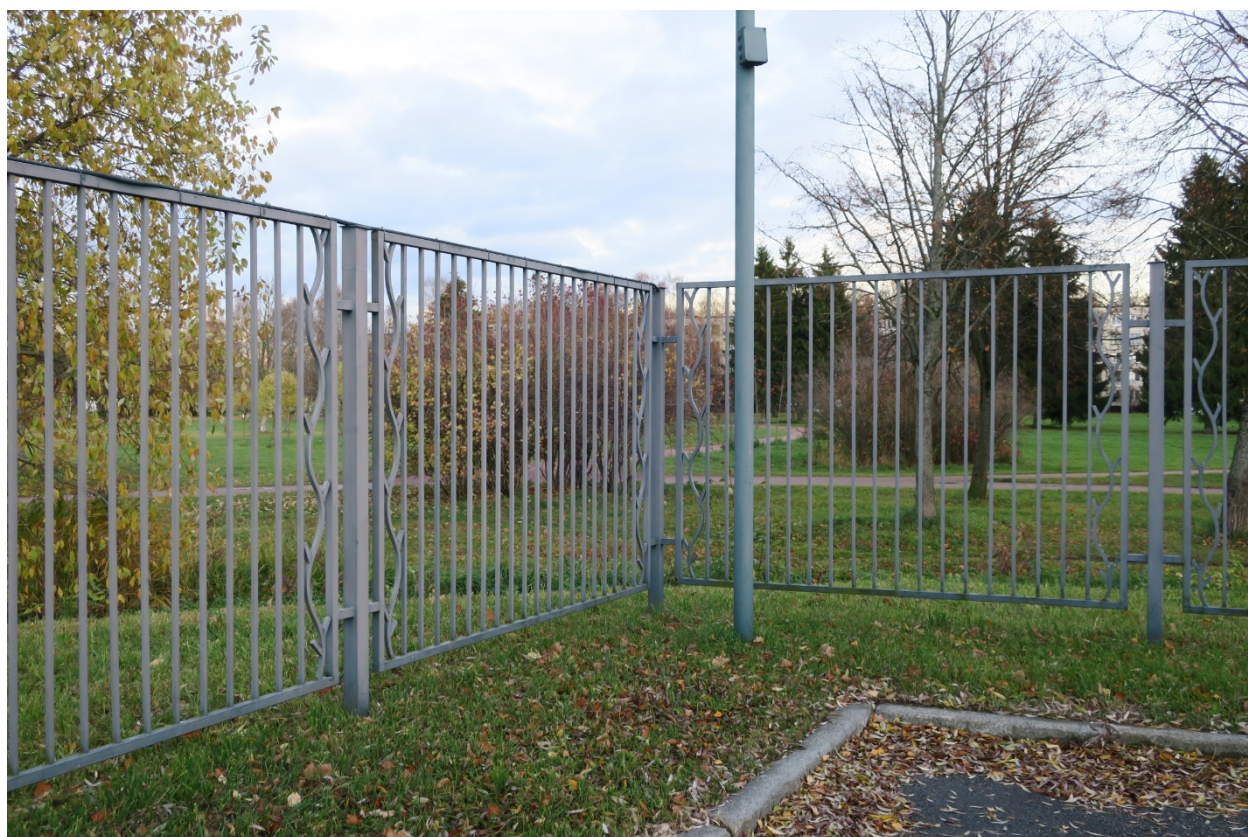
19. Примыкание восточной ограды к северной ограде вдоль аллеи Памяти объекта культурного наследия федерального значения «Кладбище Пискаревское», расположенного по адресу: г. Санкт-Петербург, пр. Непокоренных, д. 72 литера А. 15.10.2021
