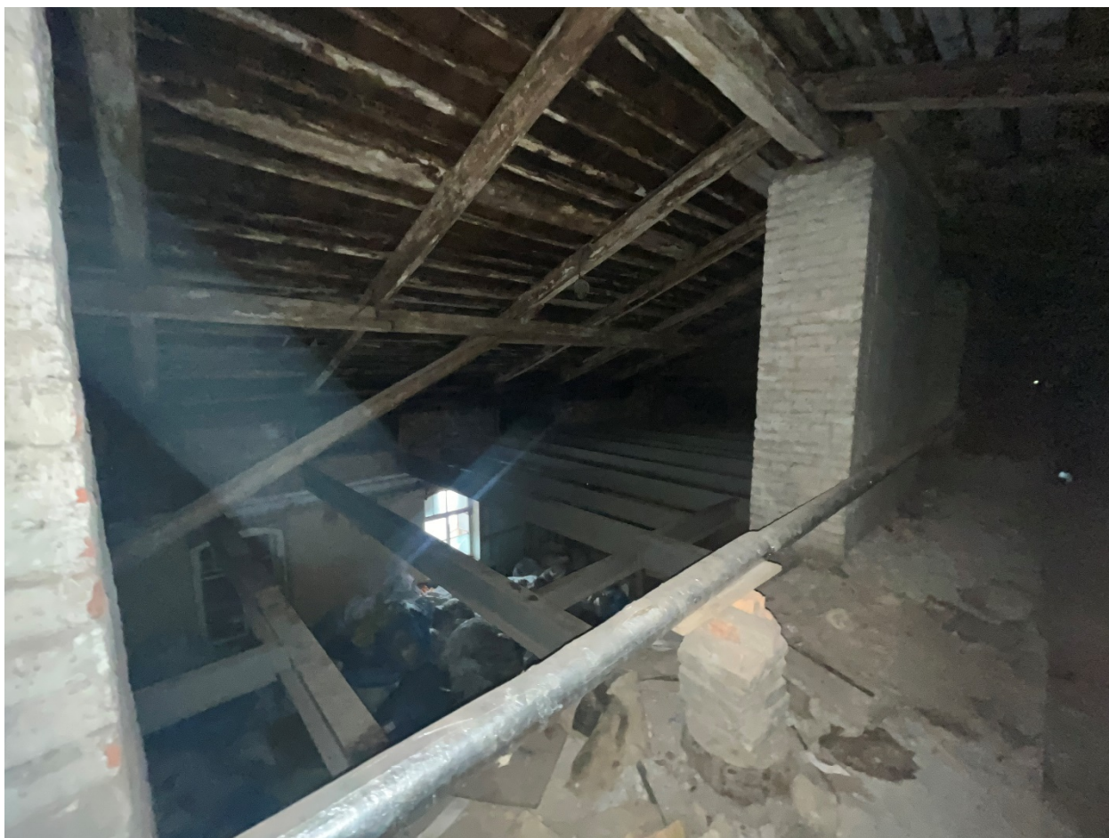
Фото №21. Чердачное пространство, фрагмент стропильной системы.
