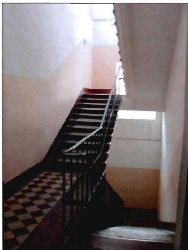
12. Лестница в южном корпусе по ул. Почтамтской.
