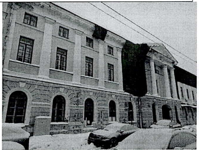
Северный лицевой фасад. Вид с запада
