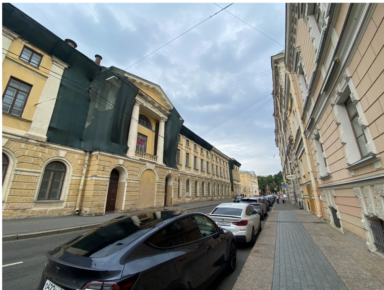
Фото №2. Фрагмент северо-восточного фасада.
