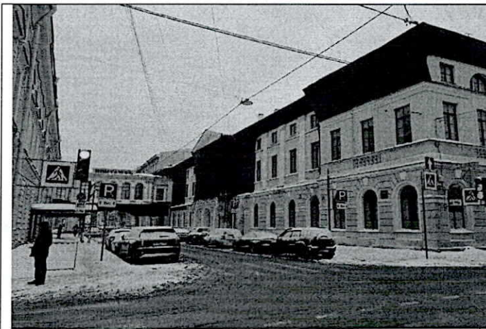
Южный лицевой фасад с переходной галереей
