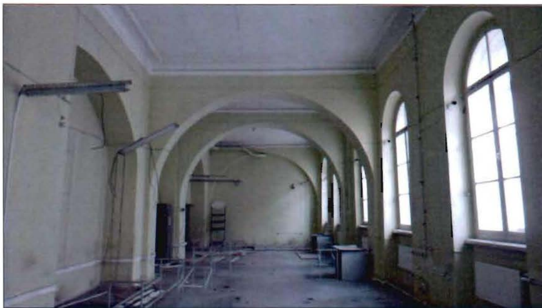
10. Перекрытие на арках. Первый этаж.
