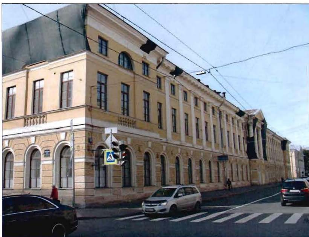
2. Восточный лицевой фасад. Вид с юго-востока.
