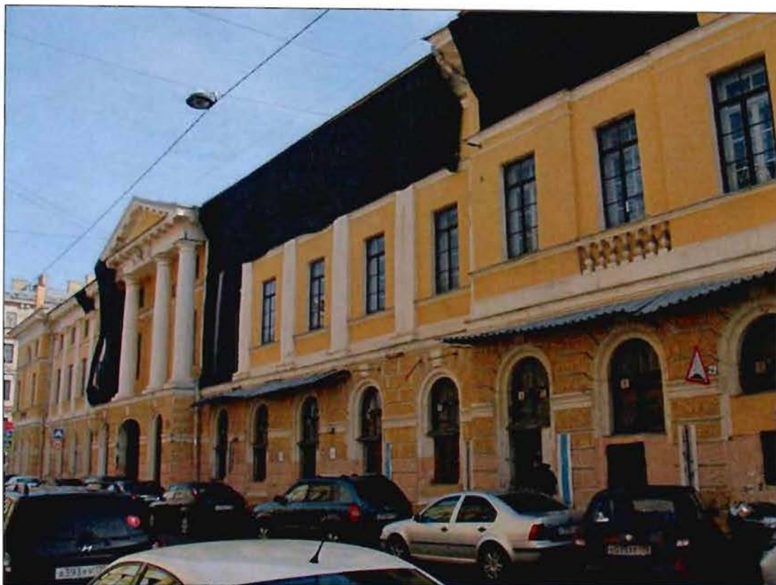
3. Северный лицевой фасад. Вид с запада.
