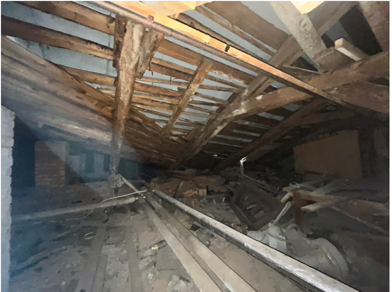
Фото №22. Чердачное пространство, фрагмент стропильной системы.
