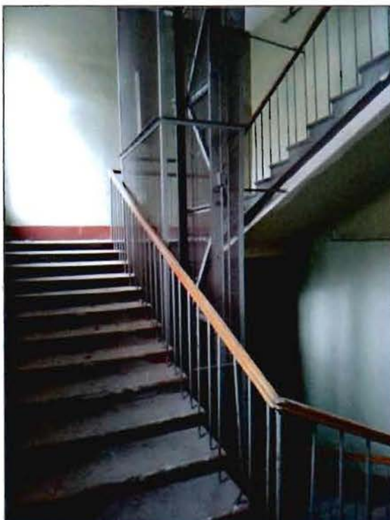
14. Лестница в западном корпусе по ул. Якубовича.
