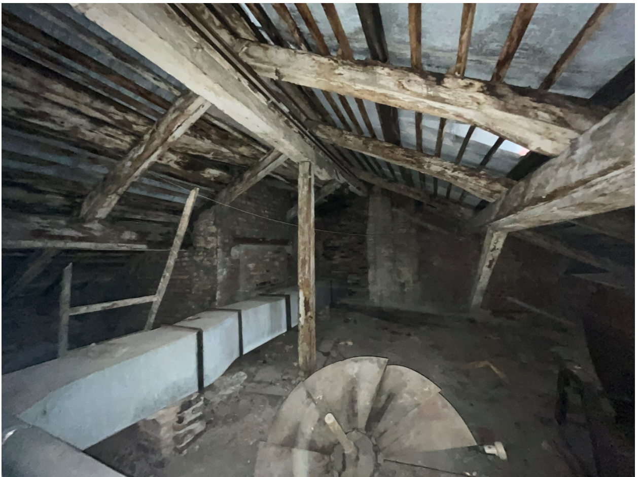
Фото №10. Чердачное пространство, фрагмент стропильной системы.
