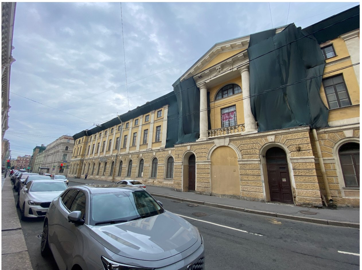
Фото №3. Фрагмент северо-восточного фасада.
