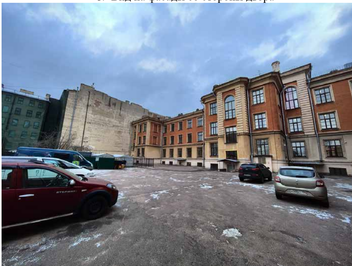
9. Вид на фасады со стороны двора
