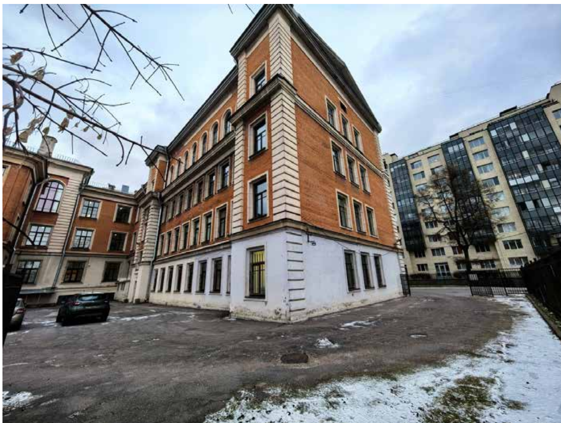
8. Вид на фасады со стороны двора
