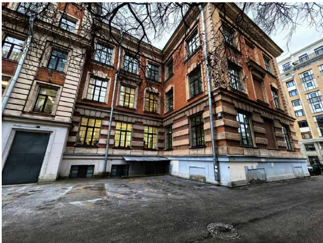
6. Вид на фасады со стороны двора
