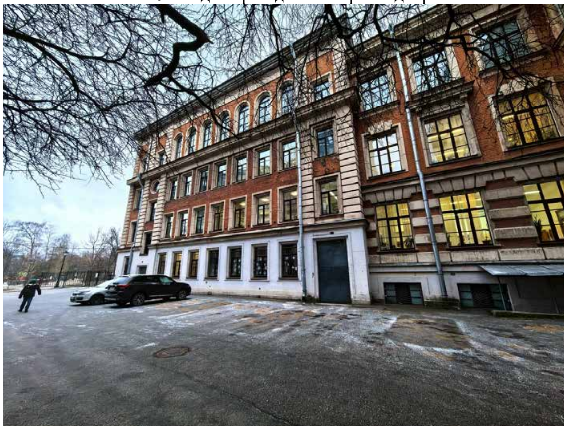
7. Вид на фасады со стороны двора
