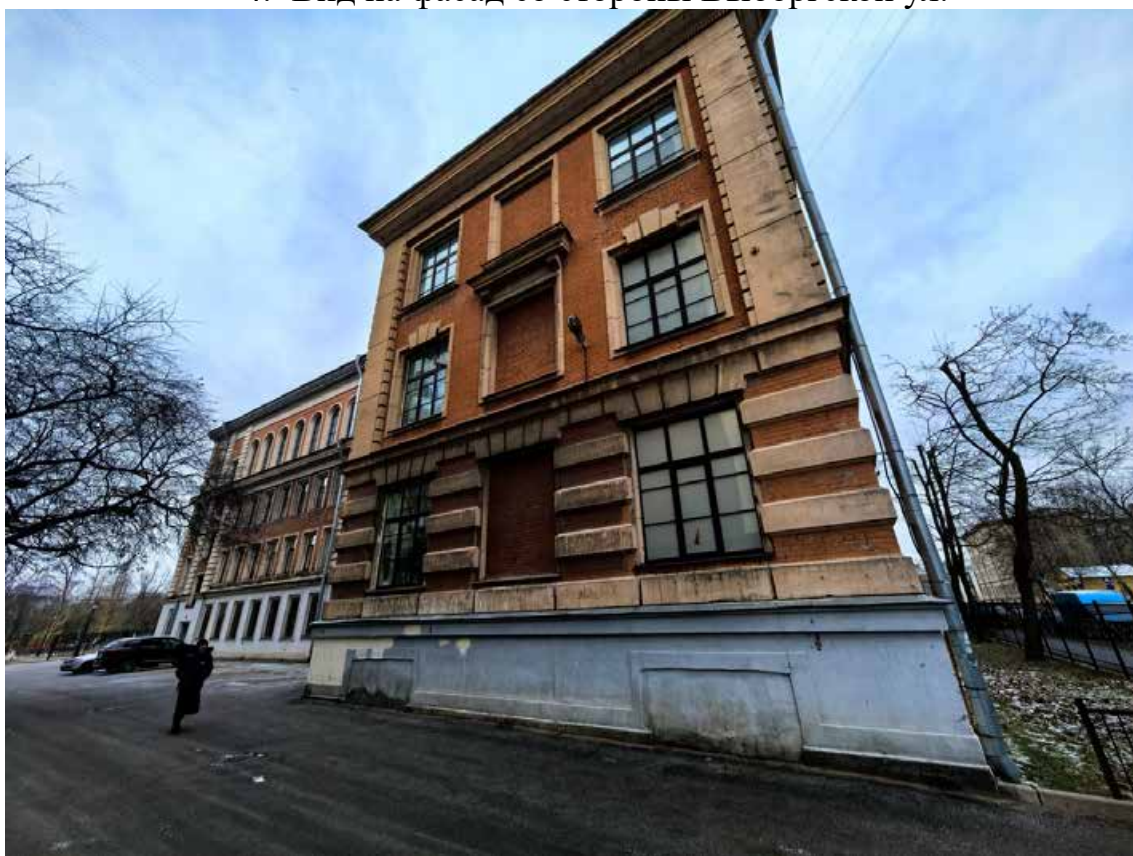
5. Вид на фасады со стороны двора
