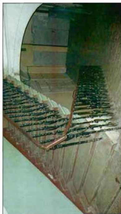
12. Лестница (5 ЛК). Корпус по ул. Якубовича.
