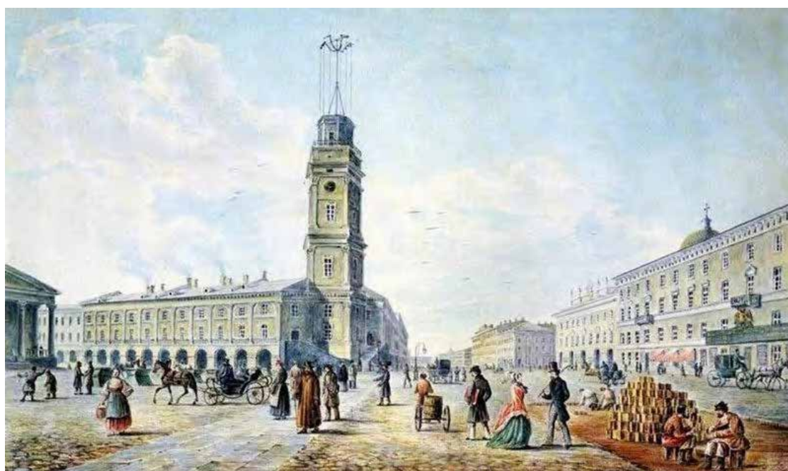
Илл. 12. Укладка торцевой мостовой на Невском проспекте. 1820-е гг. https://architectstyle.livejournal.com/164041.html
