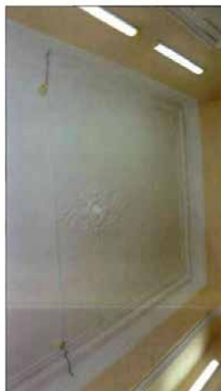
30. Оформление потолка в пом. 52-Н (8).
