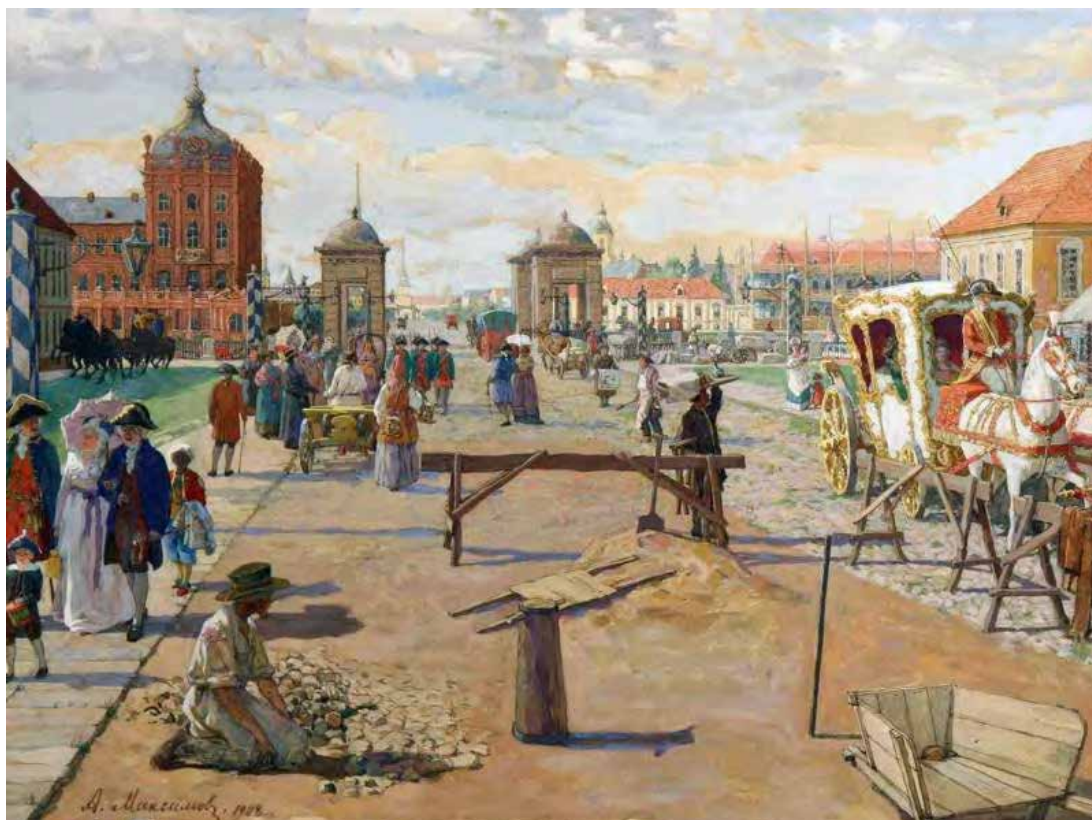
Илл. 9. Невский проспект. Укладка булыжной мостовой. XVIII в.
