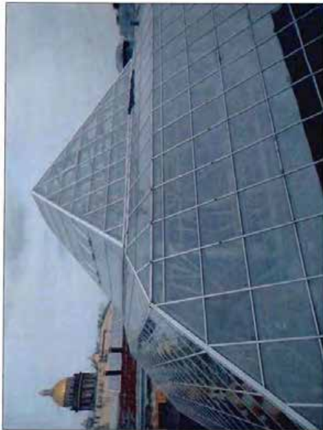
7. Конструкция светового фонаря над операционным залом.
