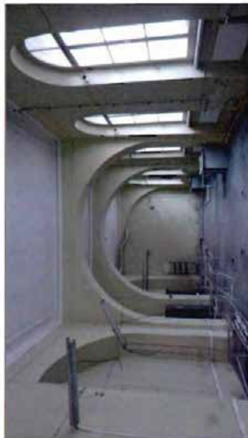
10. Перекрытие на арках. Первый этаж.
