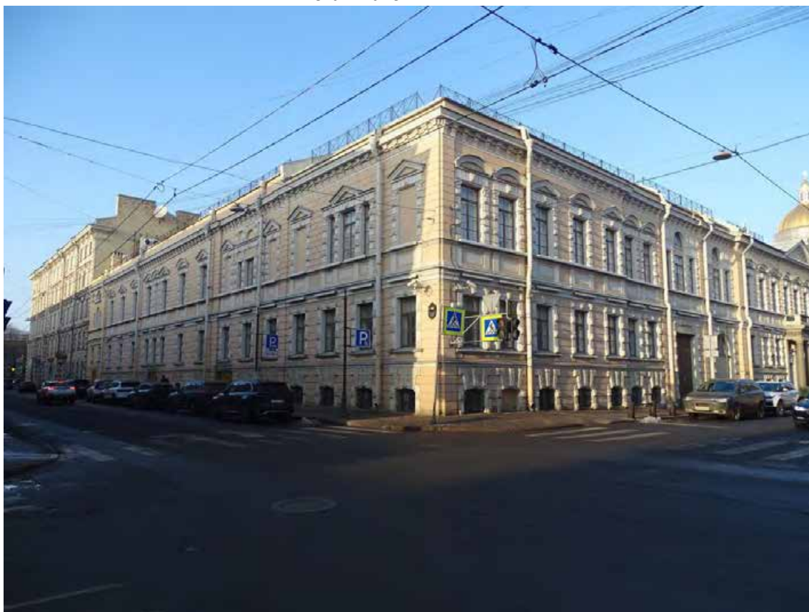
Фото 427. Объект культурного наследия федерального значения «Дворец Безбородко А. А.» (Почтамтская ул., д. 7, лит. А). Западный и южный фасады. Общий вид. Съемка 28.02.2025 г. Полетайкин В.В.
