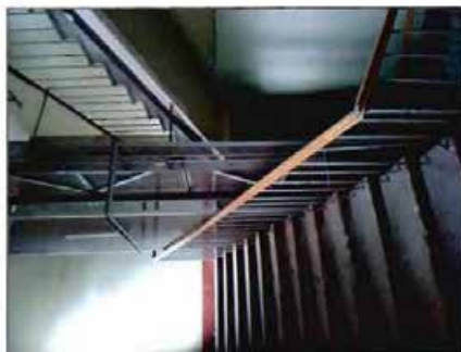
14. Лестница в западном корпусе по ул. Якубовича.
