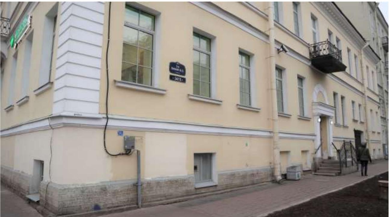
Фото 4. Вид на существующие оконные проемы подвала, расположенные по фасаду со стороны 3-ей линии В.О.
