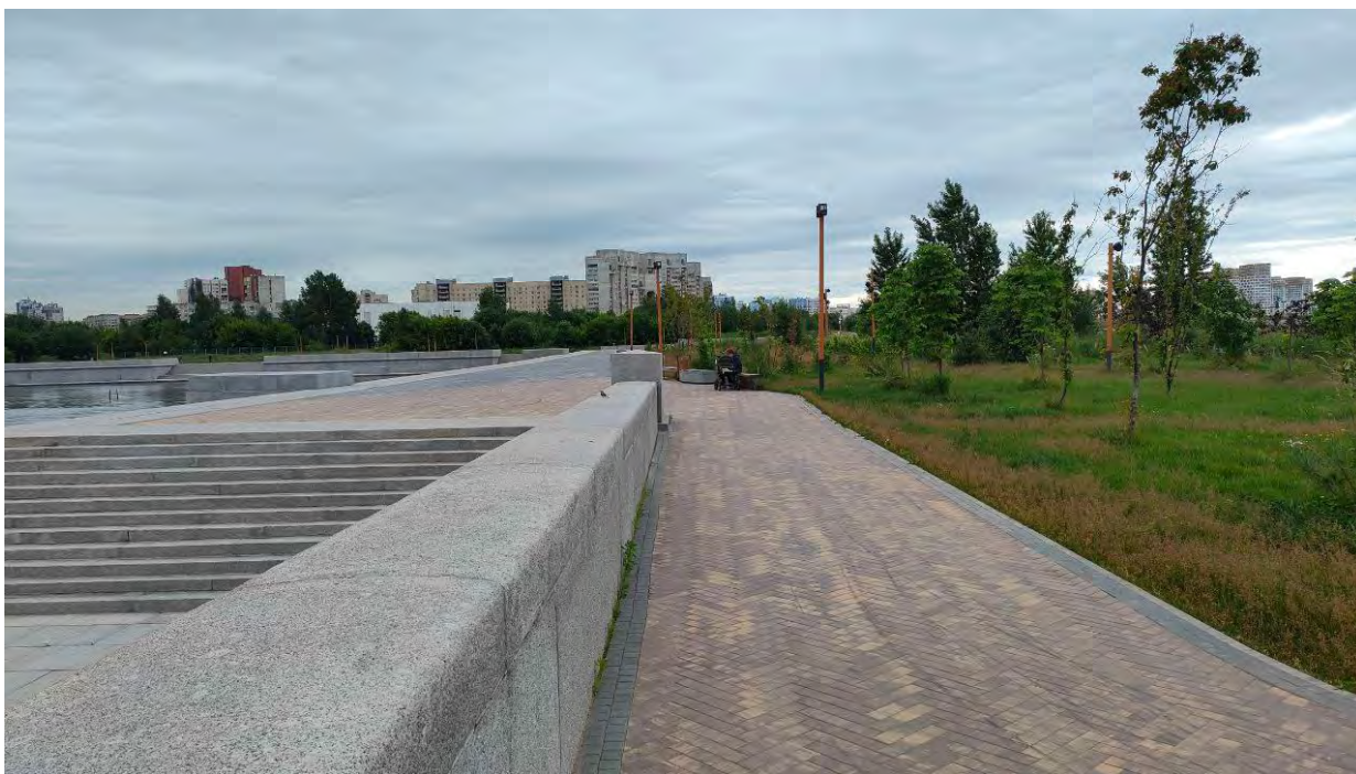
Точка фотофиксации 6. Общий вид на центральную часть территории обследования с С.
