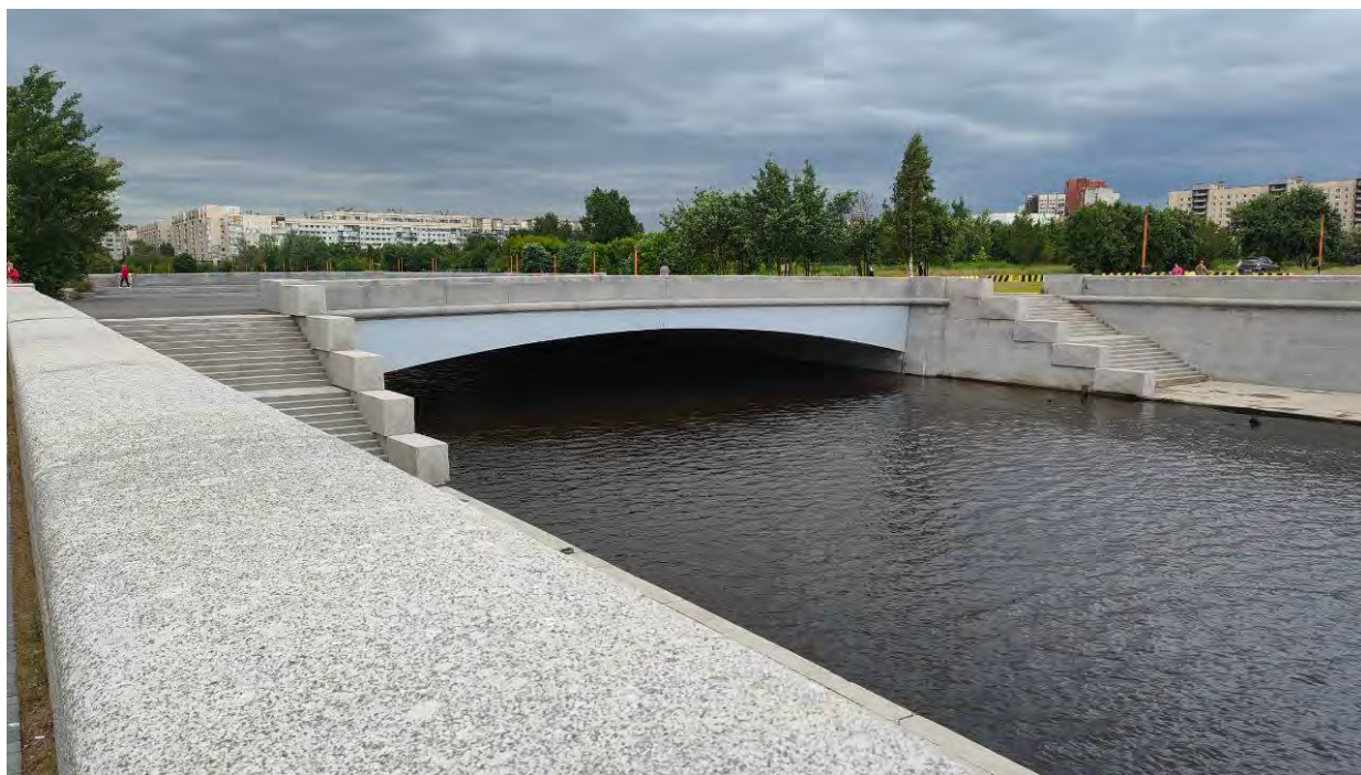
Точка фотофиксации 19. Общий вид на центральную часть территории обследования с СЗ.
