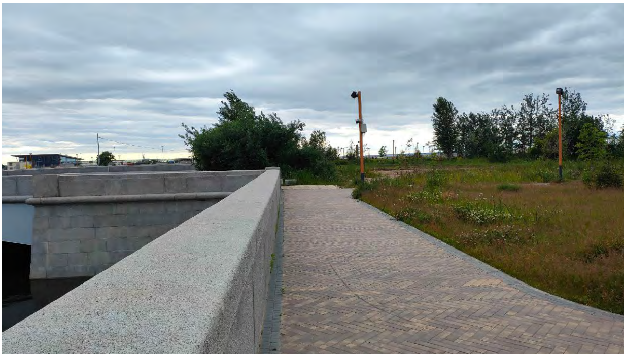
Точка фотофиксации 9. Общий вид на центральную часть территории обследования с В.
