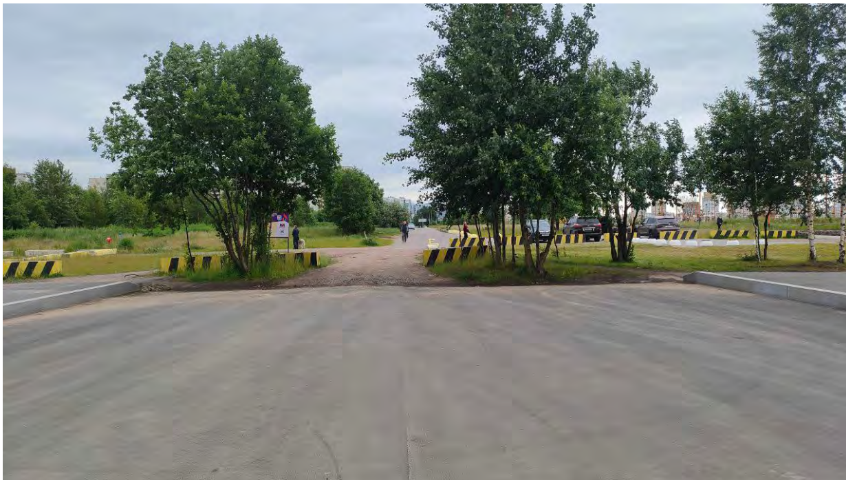
Точка фотофиксации 11. Общий вид на центральную часть территории обследования с С.
