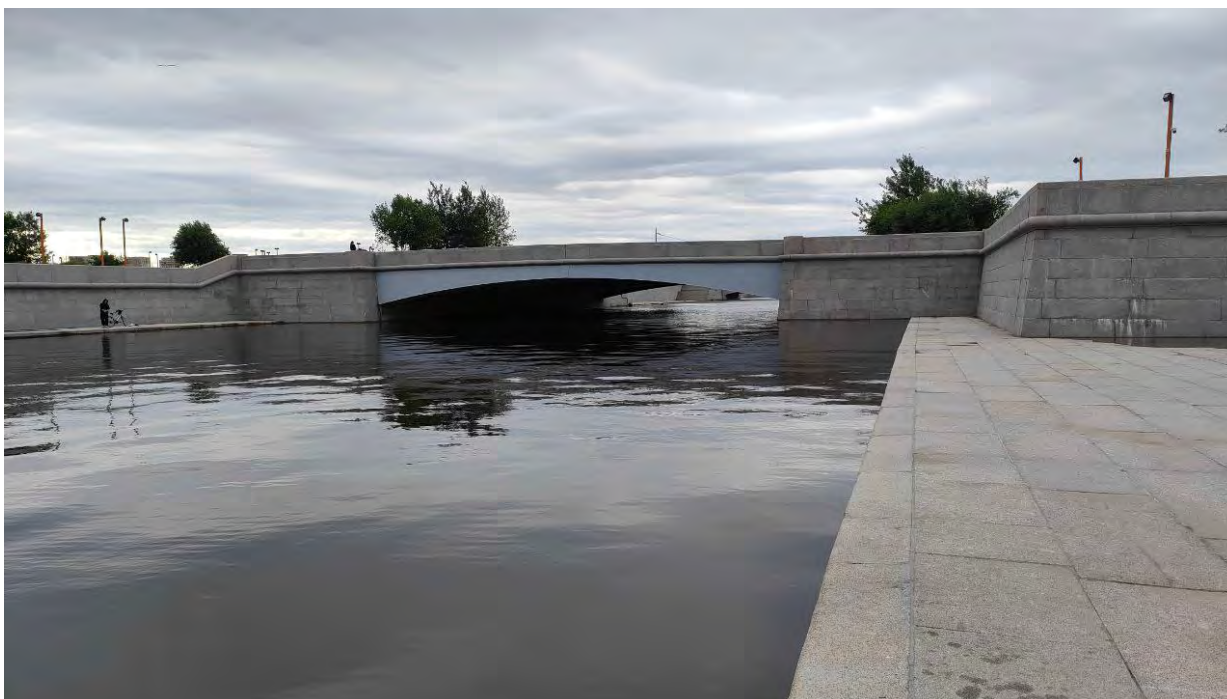
Точка фотофиксации 8. Общий вид на центральную часть территории обследования с В 1-й Смоленский мост.
