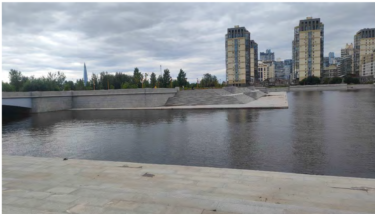
Точка фотофиксации 12. Общий вид на центральную часть территории обследования с Ю.
