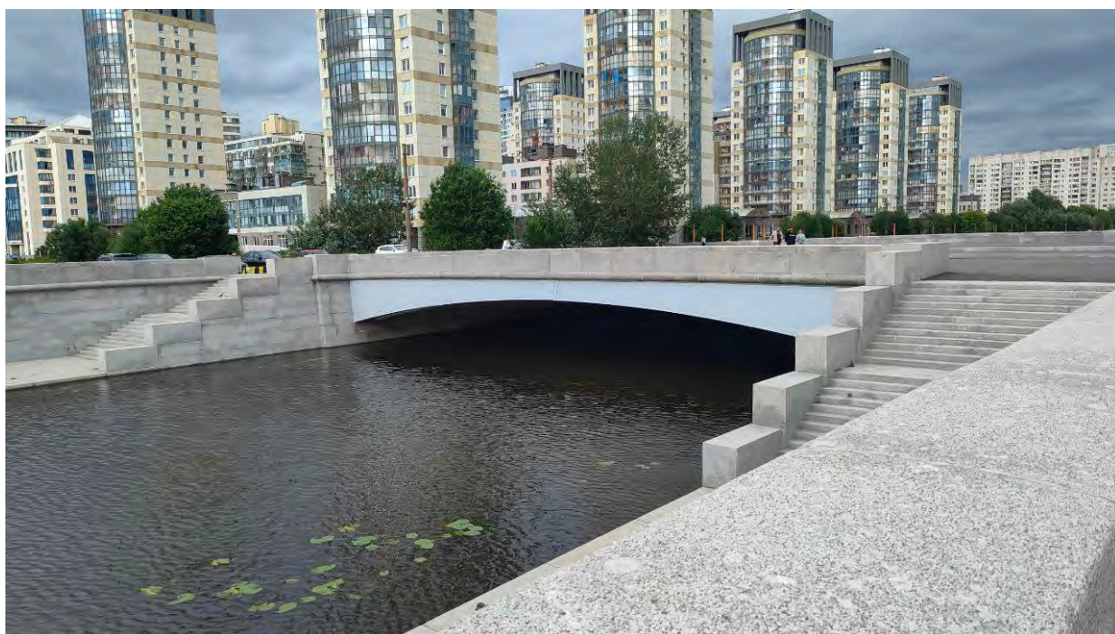
Точка фотофиксации 20. Общий вид на центральную часть территории обследования с ЮЗ.
