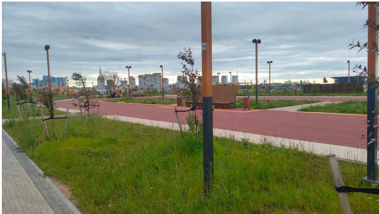
Точка фотофиксации 13. Общий вид на южную часть территории обследования с СВ.
