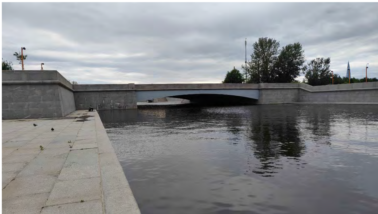
Точка фотофиксации 7. Общий вид на центральную часть территории обследования с В.
