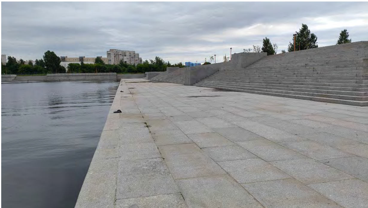
Точка фотофиксации 7. Общий вид на центральную часть территории обследования с С.
