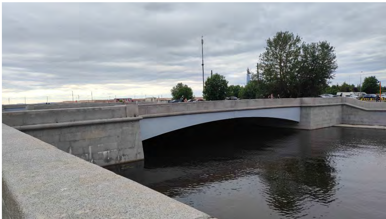
Точка фотофиксации 6. Общий вид на центральную часть территории обследования с ЮВ 2-й Смоленский мост.
