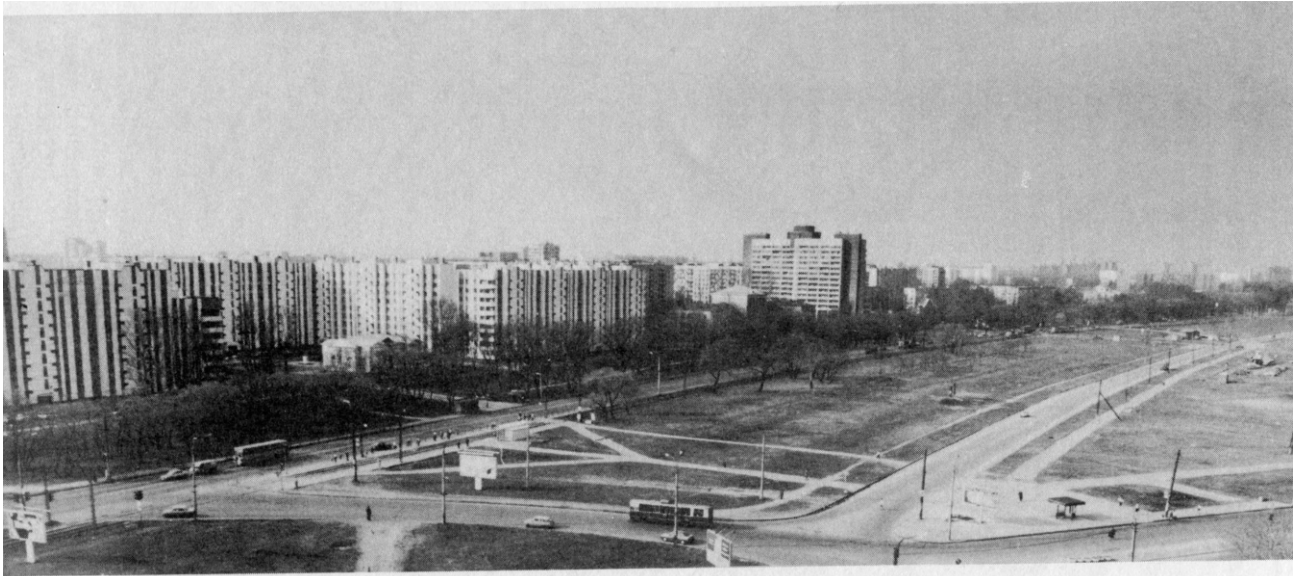
8. «Дача Чернышева И.Г. «Александрино». Панорама Петергофской дороги (пр. Стачек) с дачи Воронцова, «Ульянкой», Шереметевых и «Александринном». Фото С. Шмидта. 1998 г. (Горбатенко С.Б. Петергофская дорога: Историко-архитектурный путеводитель. СПб., 2001, С.126).
