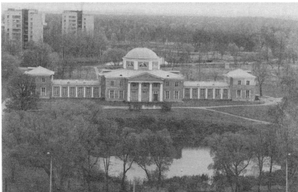
12. «Дача Чернышева И.Г. «Александрино». Фото П. Платонова. 2000 г. (Горбатенко С.Б. Петергофская дорога: Историко-архитектурный путеводитель. СПб., 2001, С.149).
