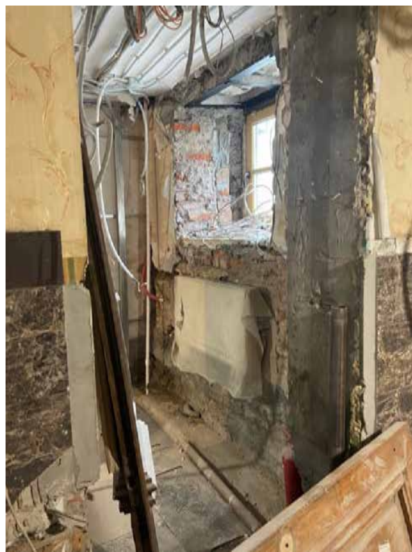
Фото 14. Вид на помещение лестницы Л-1 (II).
