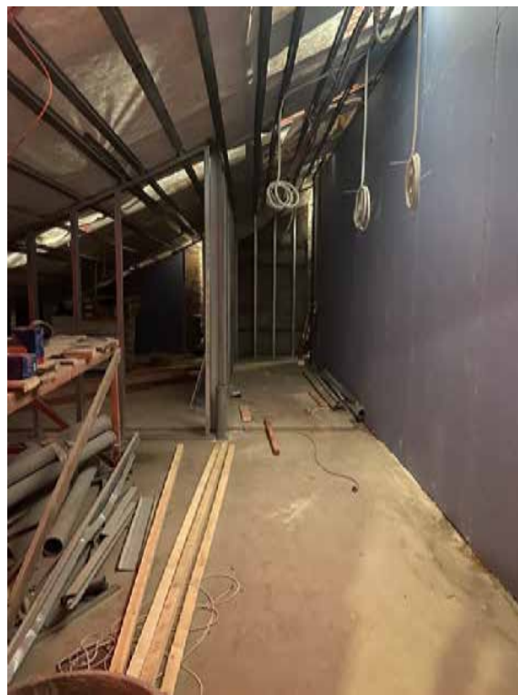
Фото 40. Вид на чердачное пространство.
