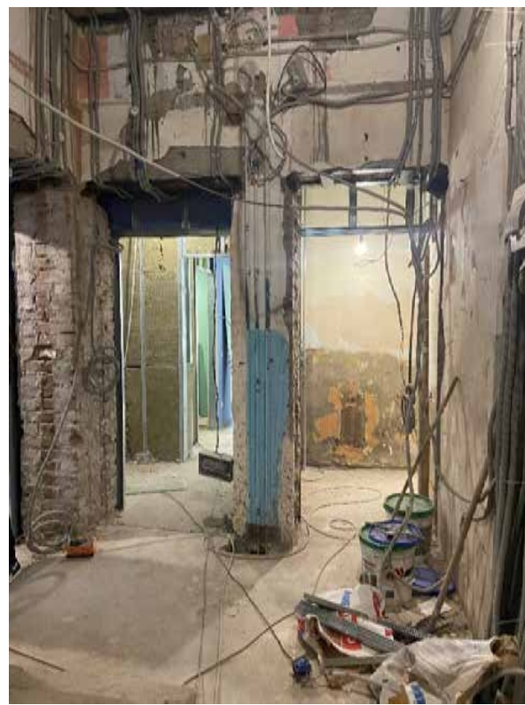
Фото 29. Помещение лестницы Л-1 (VI).
