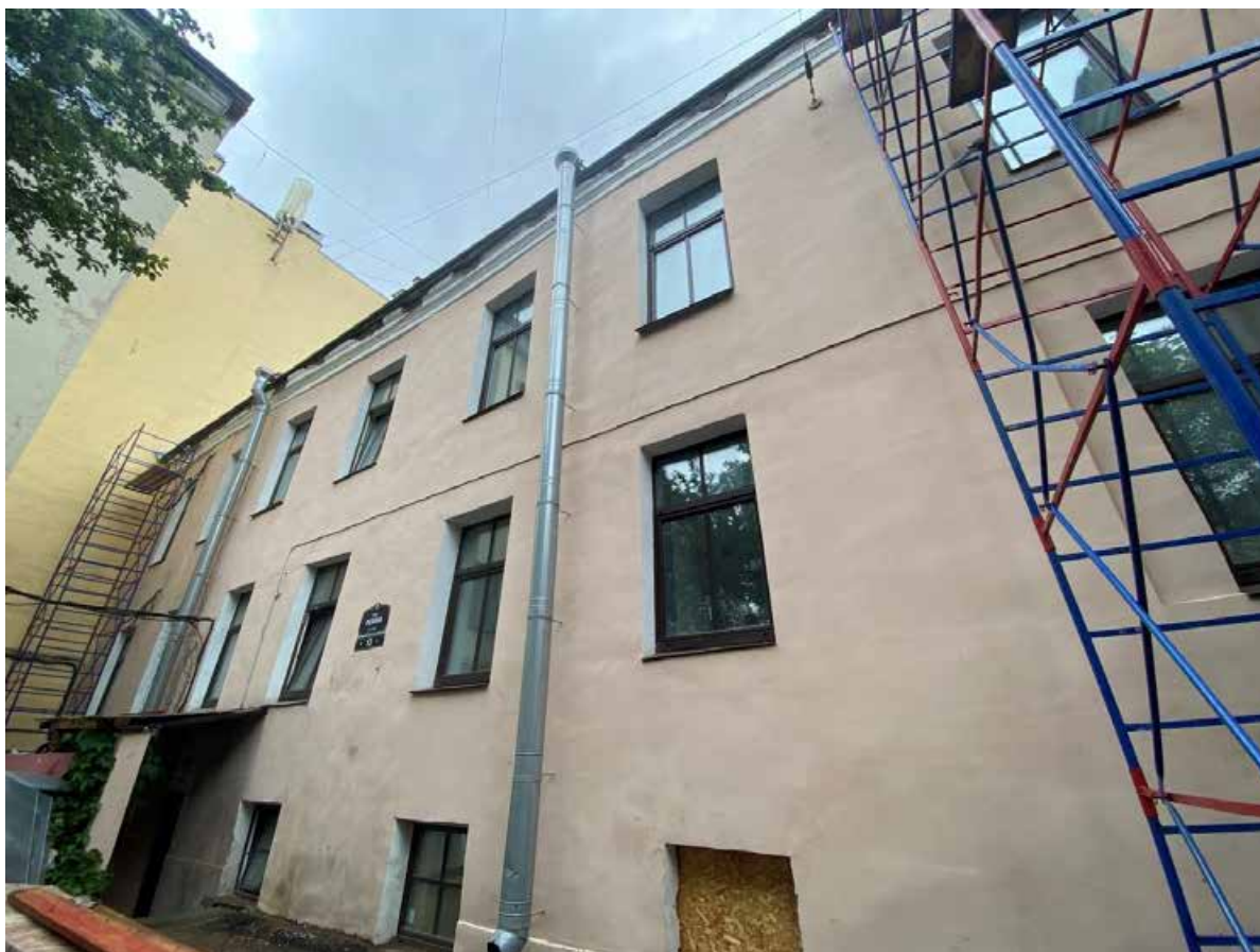
Фото 3. Вид на дворовой фасад.
