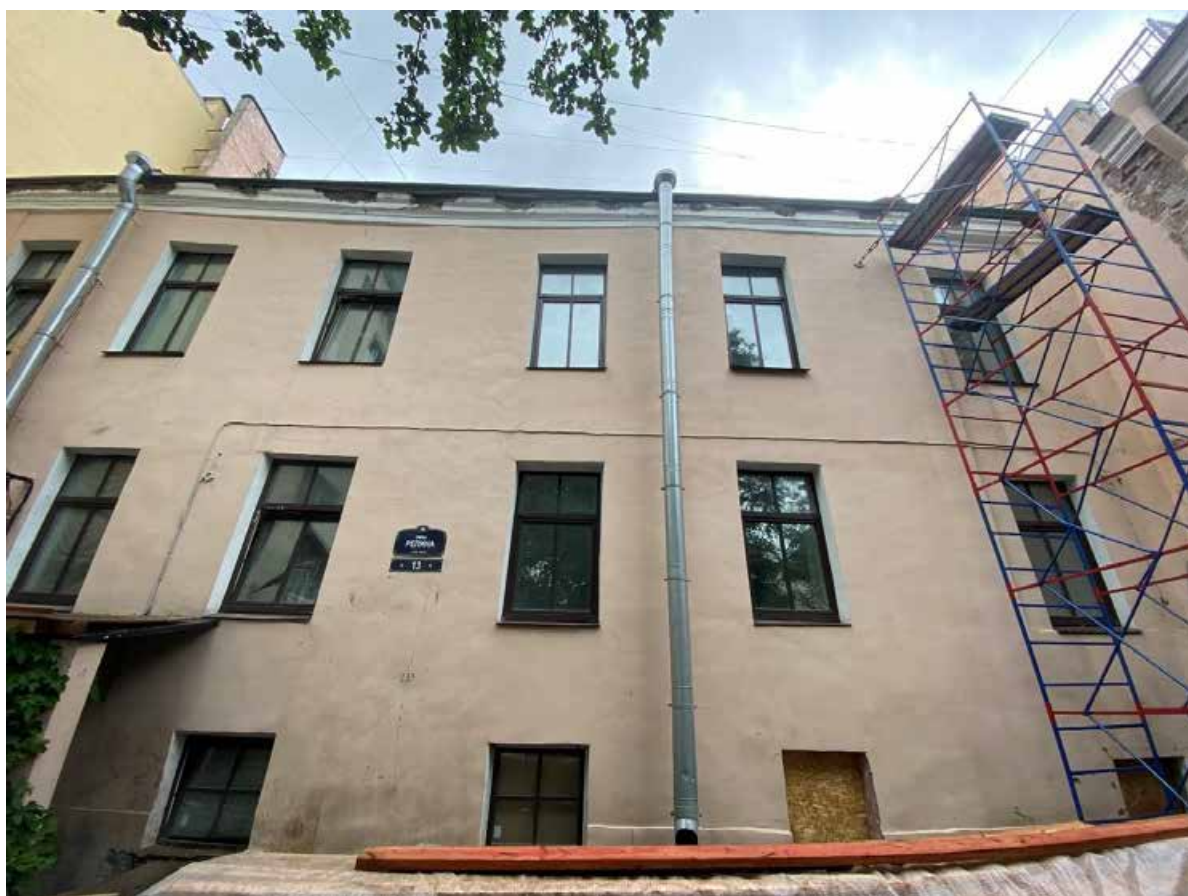
Фото 4. Вид на дворовой фасад.
