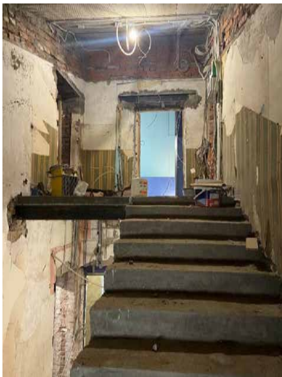
Фото 39. Лестница Л-1. Вид на чердак.
