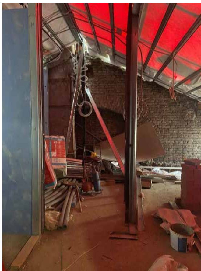
Фото 41. Вид на чердачное пространство.
