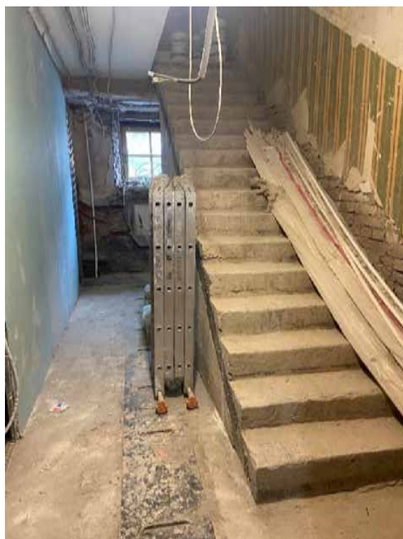
Фото 16. Вид на лестницу Л1.
