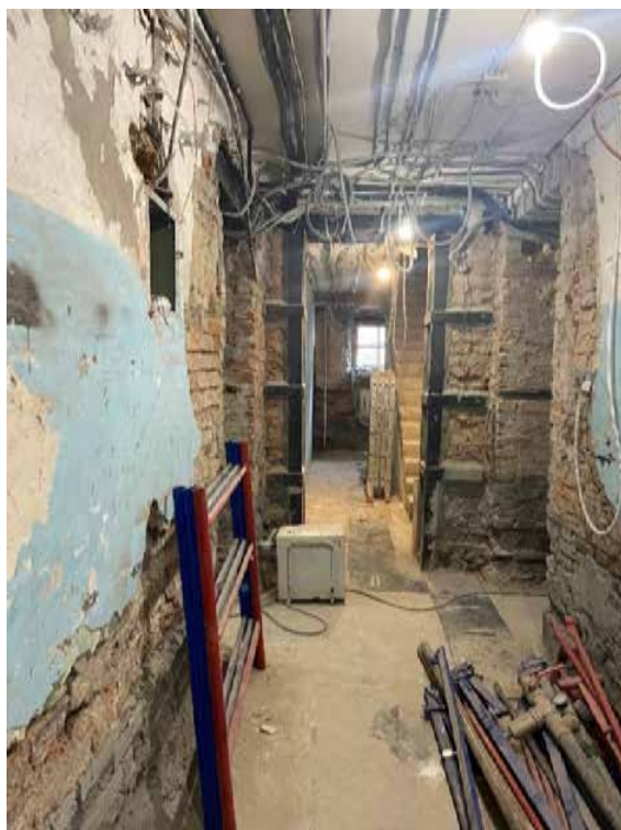
Фото 5. Помещение лестницы Л-1 (IV).
