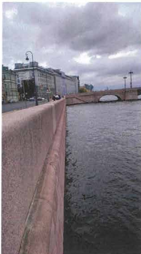
4. Вид на стенку набережной вблизи Сампсониевского моста
