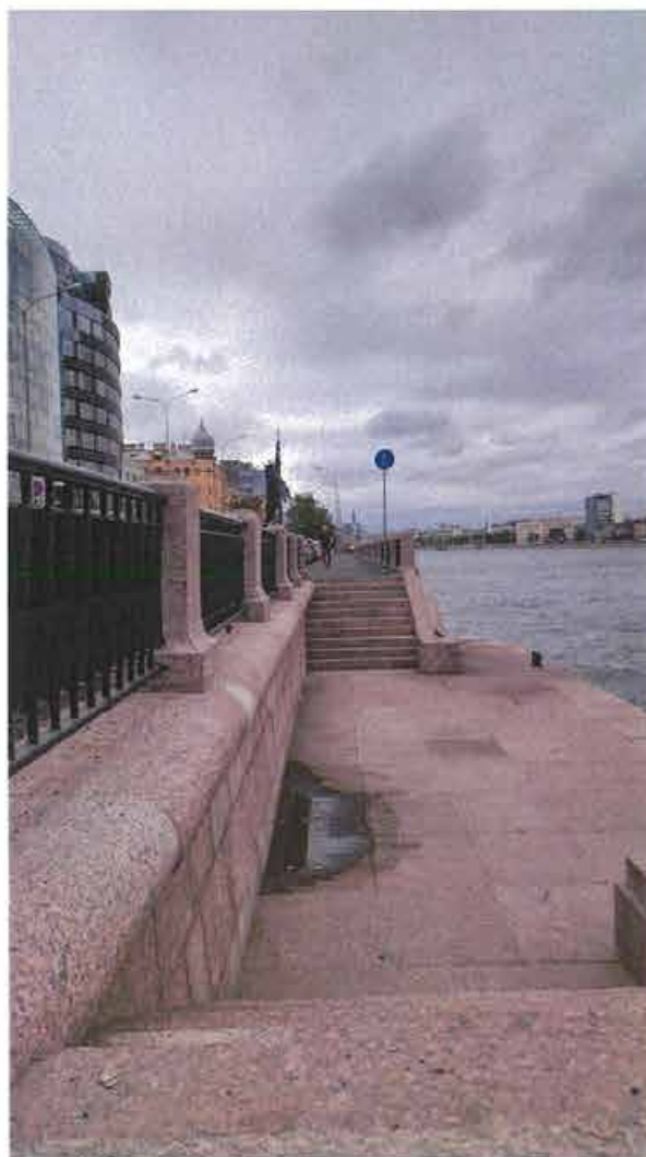
7. Вид на спуск набережной между Сампсониевским и Гренадерским мостами
