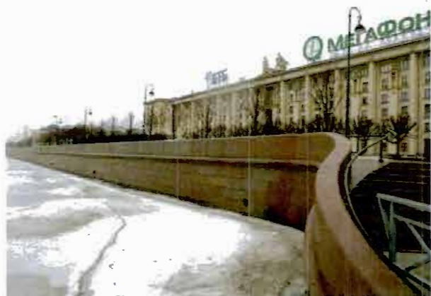
5. Вид стенки набережной
