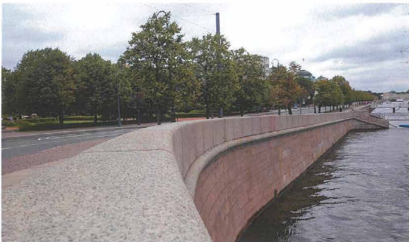
1. Вид на стенку набережной около Троицкого моста
