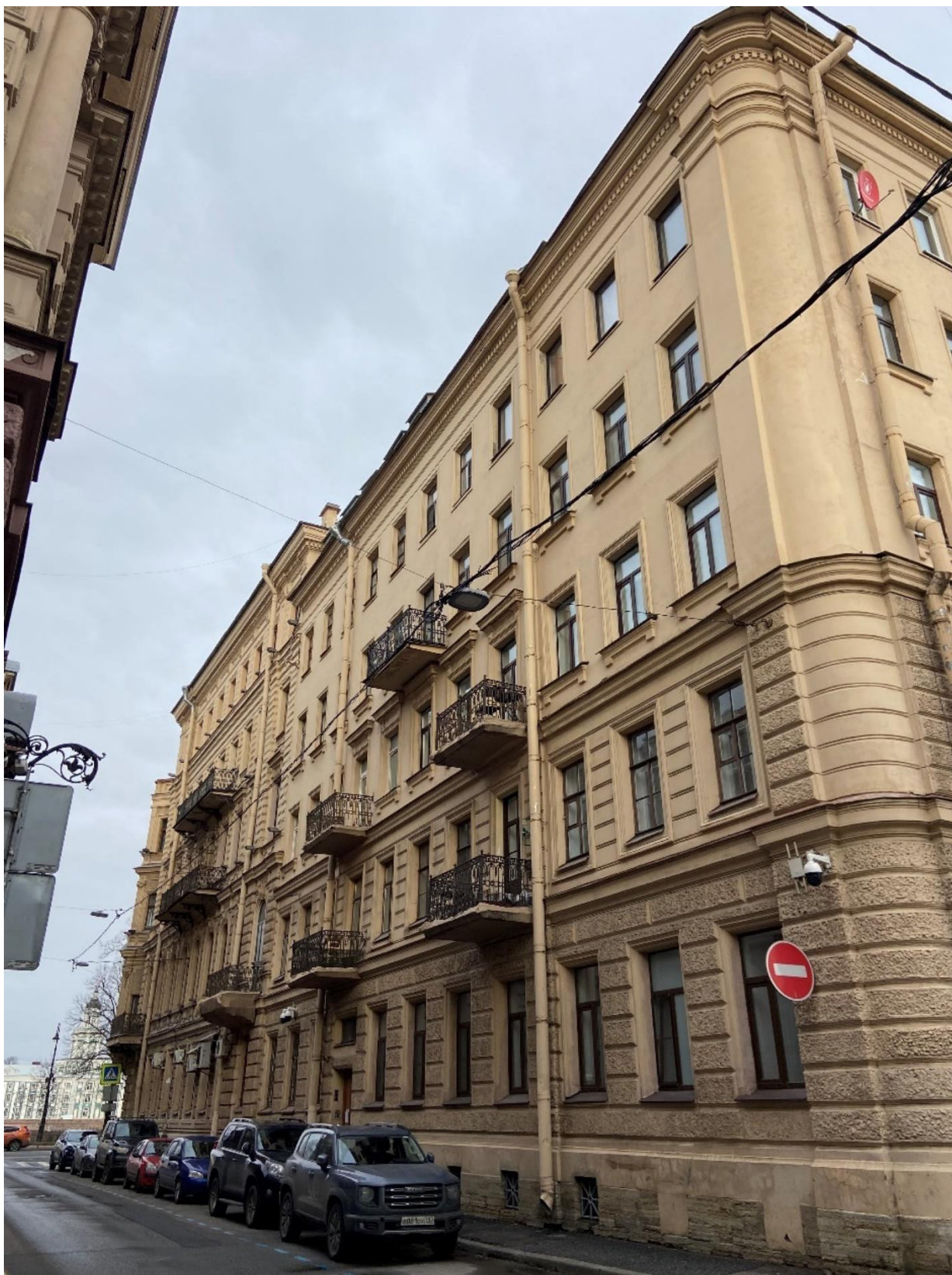
Фото 3. Лицевой фасад исследуемого объекта со стороны Азовского переулка.
