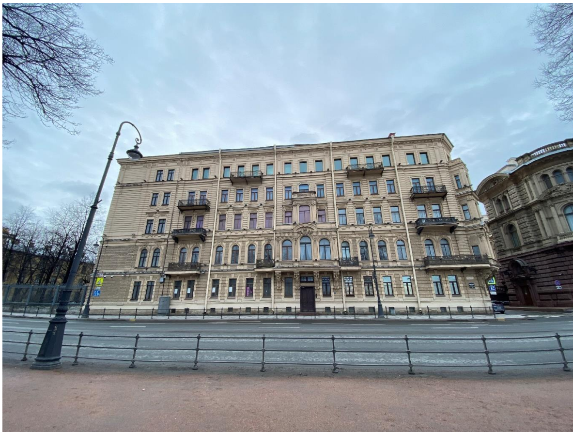
Фото 1. Лицевой фасад дома № 6 по Адмиралтейской наб.
