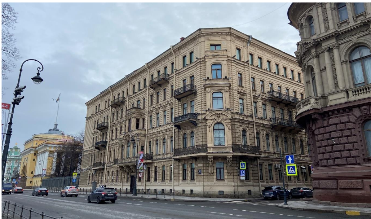
Фото 2. Угол исследуемого объекта на пересечении Адмиралтейской наб. и Азовского пер.
