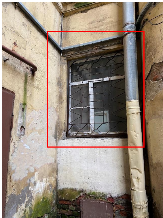
Фото 6. Вид на оконное заполнение со стороны двора.
