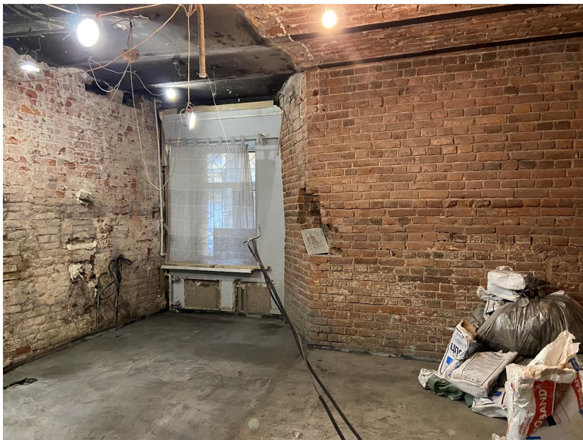
Фото 3. Вид на помещение № 2.
