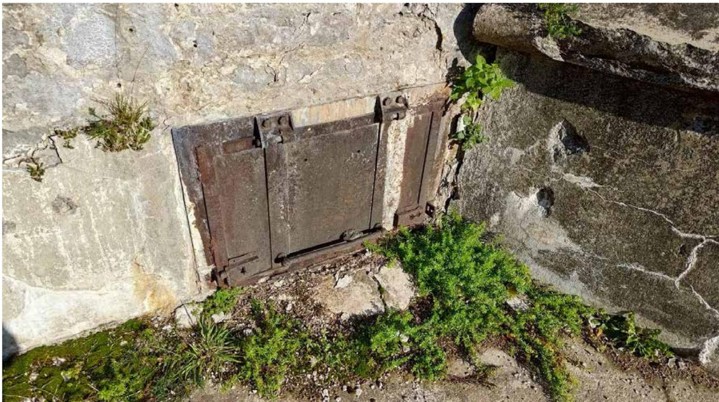
Фото 146. Металлические ставни элеваторов подачи боеприпасов. Общий вид. Дата фотофиксации: 10.10.24
