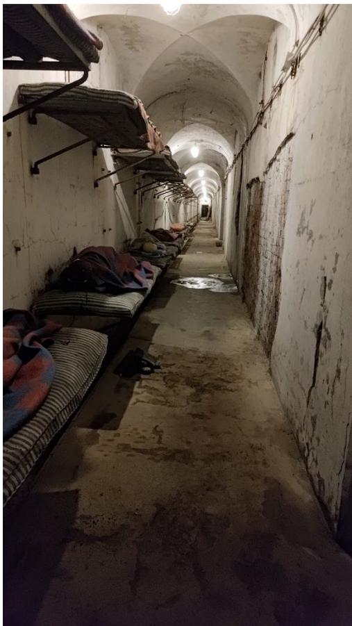
Фото 156. Галереи опытных построек. Своды коробовые с распалубками. Общий вид. Дата фотофиксации: 06.10.24
