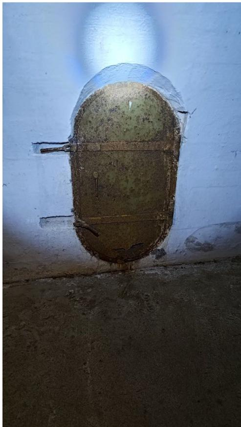
Фото 172. Металлическое овальное в плане дверное заполнение овальных проёмов галерей-потерн на нижнем уровне опытных позиций. Общий вид. Дата фотофиксации: 06.10.24
