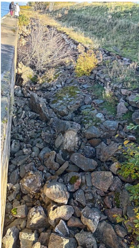
Фото 131. Конструкции основания форта – булыжная засыпка с бетонным ростверком в завершении и свайным основанием под подпорной стенкой. Правый фланг. Фрагмент. Дата фотофиксации: 10.10.24
