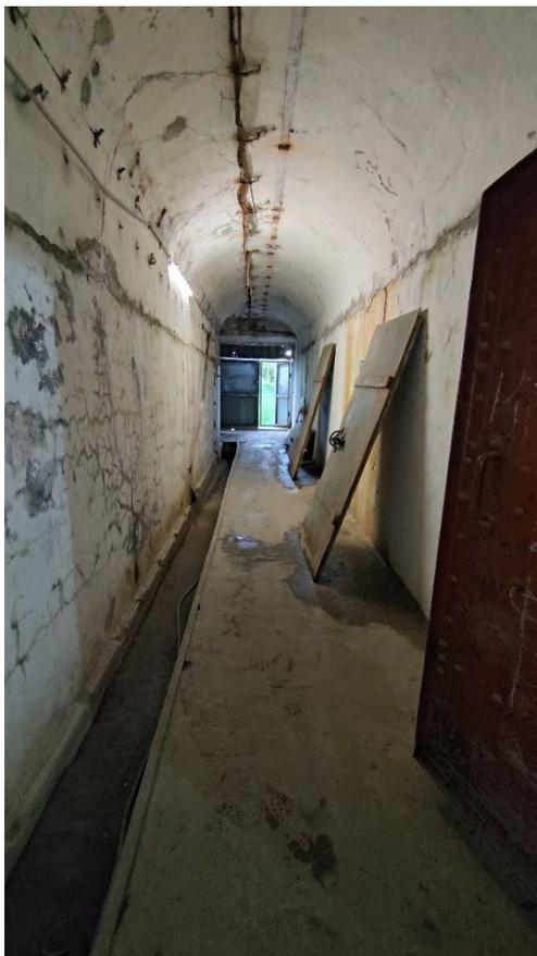
Фото 214. Коридор, соединяющий Главный калибр и опытные сооружения. Свод – коробовый. Фрагмент. Дата фотофиксации: 06.10.24
