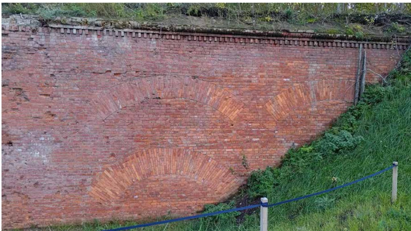
Фото 138. Кирпичная кладка с разгрузочными кирпичными арками. Фрагмент. Дата фотофиксации: 06.10.24
