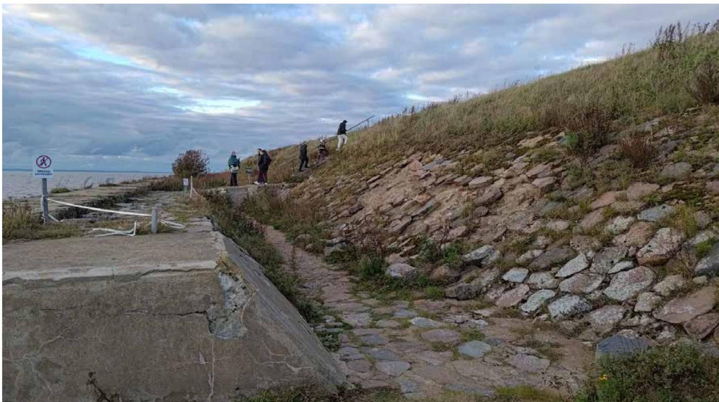
Фото 266. Конструкции основания форта – булыжная засыпка с бетонным ростверком в завершении и свайным основанием под подпорной стенкой. Фрагмент. Дата фотофиксации: 06.10.24
