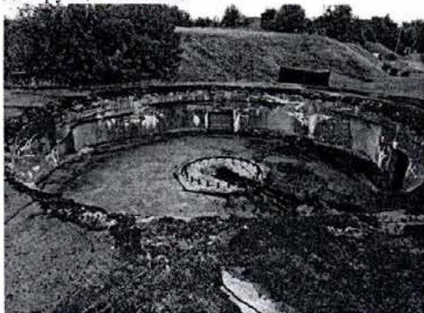
5. Открытая орудийная позиция. Наблюдаются деструкции бетона.
