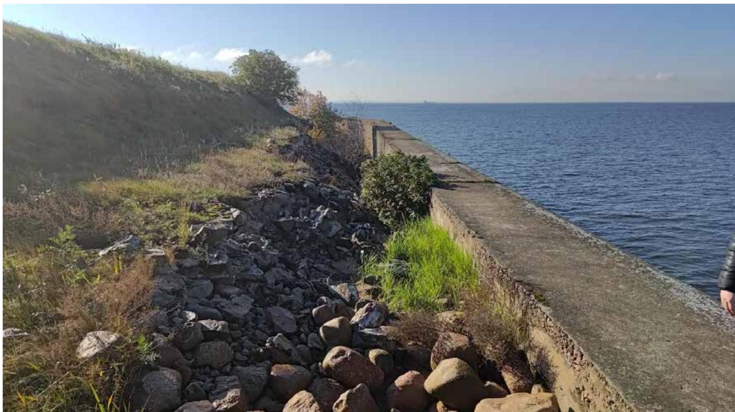
Фото 130. Конструкции основания форта – булыжная засыпка с бетонным ростверком в завершении и свайным основанием под подпорной стенкой. Правый фланг. Фрагмент. Дата фотофиксации: 10.10.24
