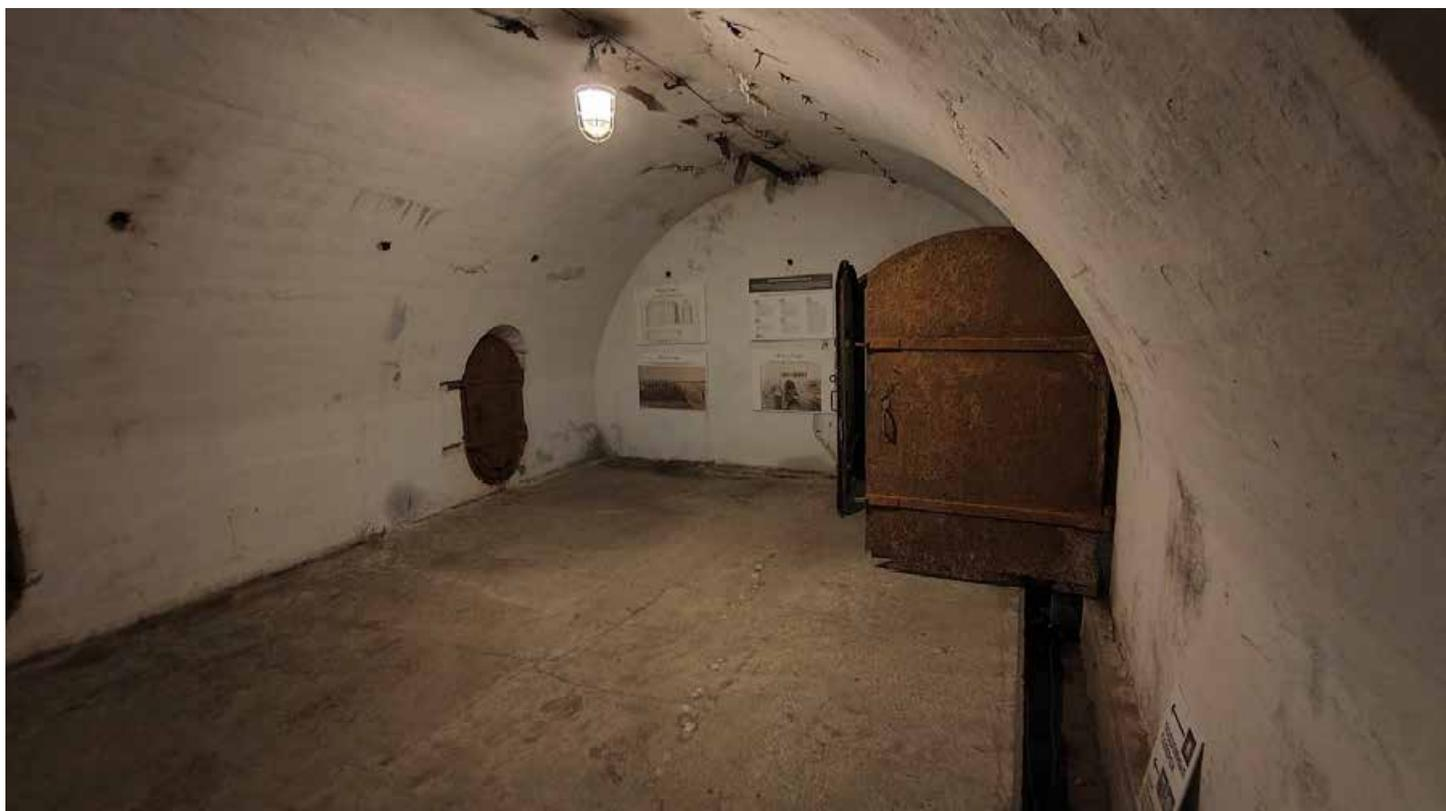
Фото 173. Металлические дверные заполнения одностворчатые с лучковым завершением в проёмах, соединяющих опытные позиции и вспомогательные помещения (казематные помещения). Общий вид. Дата фотофиксации: 06.10.24
