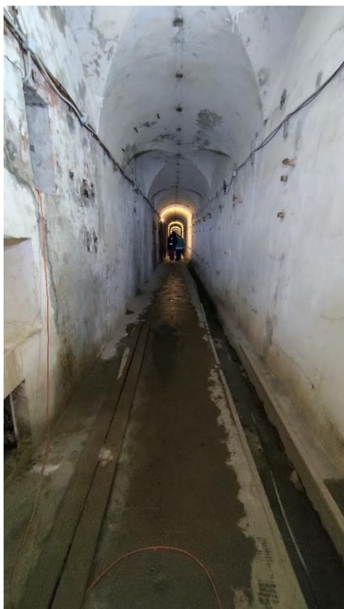
Фото 215. Коридор, соединяющий Главный калибр и опытные сооружения. Своды – коробовые с распалубками. Фрагмент. Дата фотофиксации: 06.10.24
