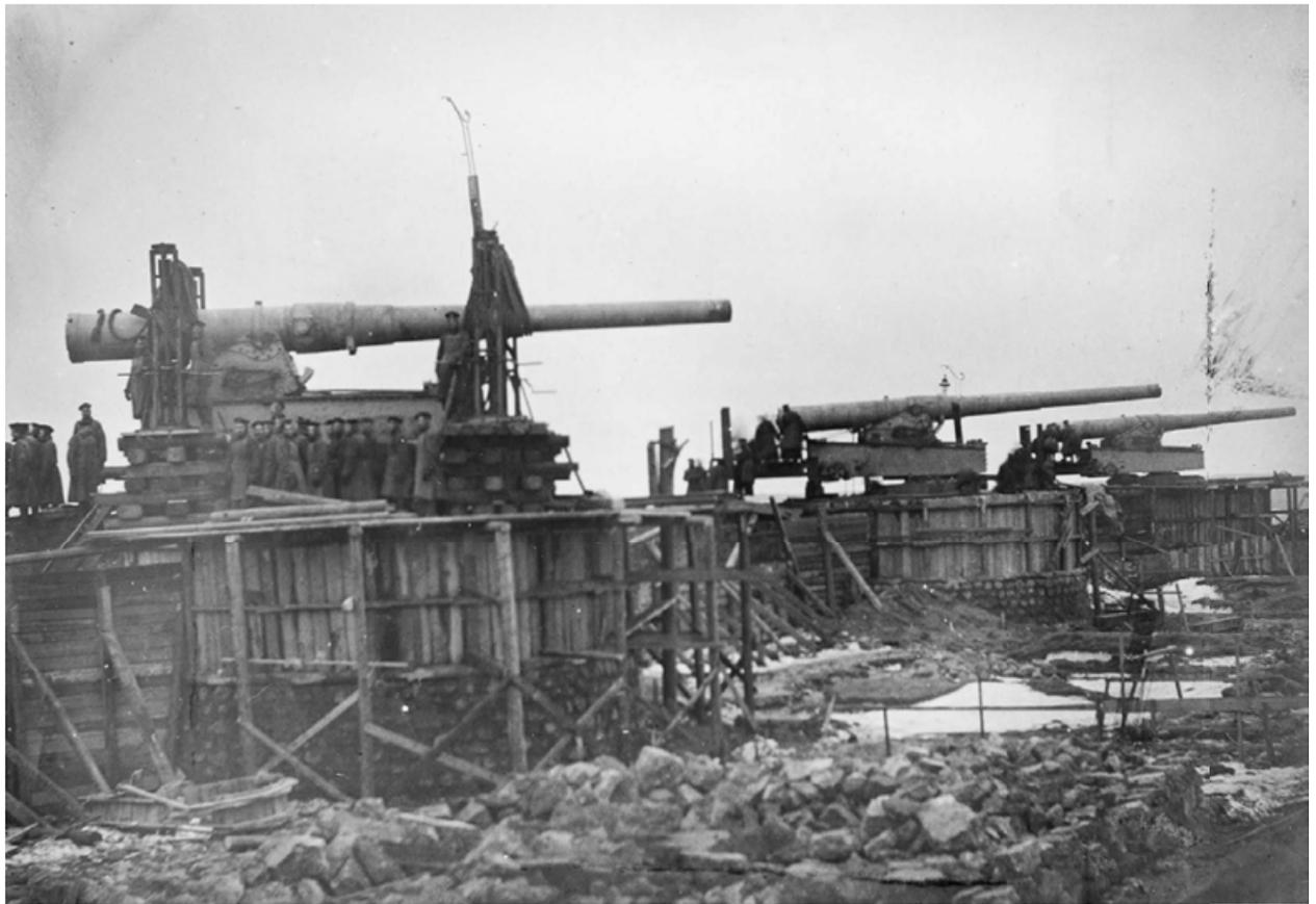
Илл. 93. Установка третьего слева 10-дм. орудия на батарее «Риф». Фотография декабря 1909 г. Из семейного архива потомков Л.П. Капицы. Фотография красноречиво показывает спешность работ: орудия устанавливались на бетонные основания, с которых еще не была убрана опалубка.
