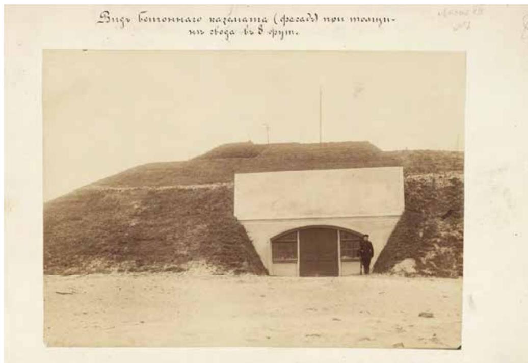
Илл. 17. Вид бетонного каземата (фасад) при толщине свода в 8 фут. (Каземат А с деревянной тыльной стенкой до обстрела.). (РГАВМФ. Ф. 1341. Оп. 3. Д. 588).
