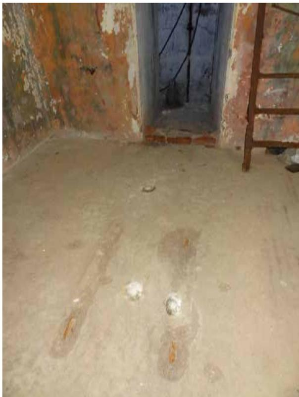
Фото 325. Фрагменты конструкций прожекторной шахты в бетонном полу помещения 18 правого фланга. Дата фотофиксации: 10.10.24
