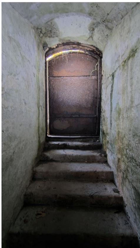
Фото 289. Металлическая одностворчатая прямоугольная дверь с лучковым завершением. Общий вид.
