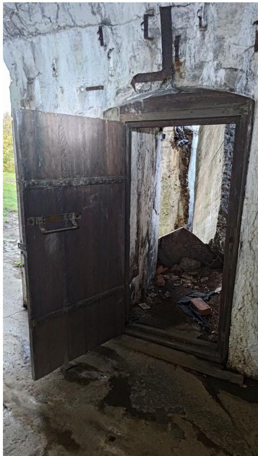
Фото 259. Металлическая прямоугольная одностворчатая дверь во входной галерее Левого фланга. Общий вид. Дата фотофиксации: 06.10.24
