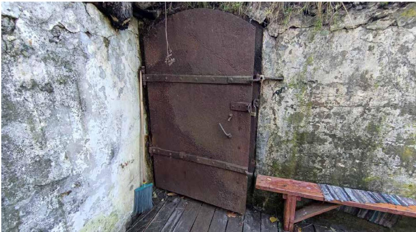
Фото 290. Металлическая одностворчатая прямоугольная дверь с лучковым завершением. Общий вид. Дата фотофиксации: 10.10.24
