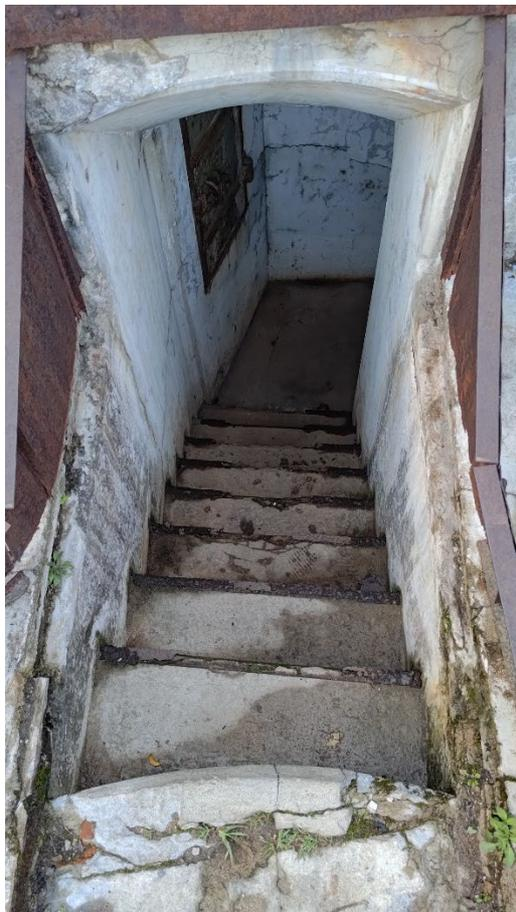
Фото 150. Двойная бетонная лестница опытных построек. Фрагмент. Дата фотофиксации: 06.10.24
