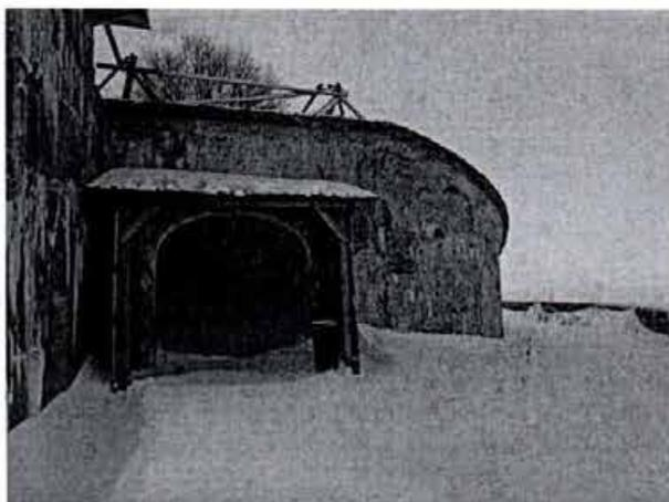
4. Казематированный траверс. Наблюдаются деструкции бетона.
