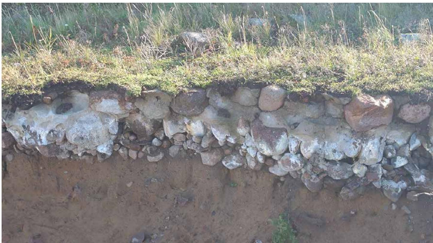
Фото 132. Конструкции основания форта – булыжная засыпка с бетонным ростверком в завершении и свайным основанием под подпорной стенкой. Правый фланг. Фрагмент. Дата фотофиксации: 10.10.24
