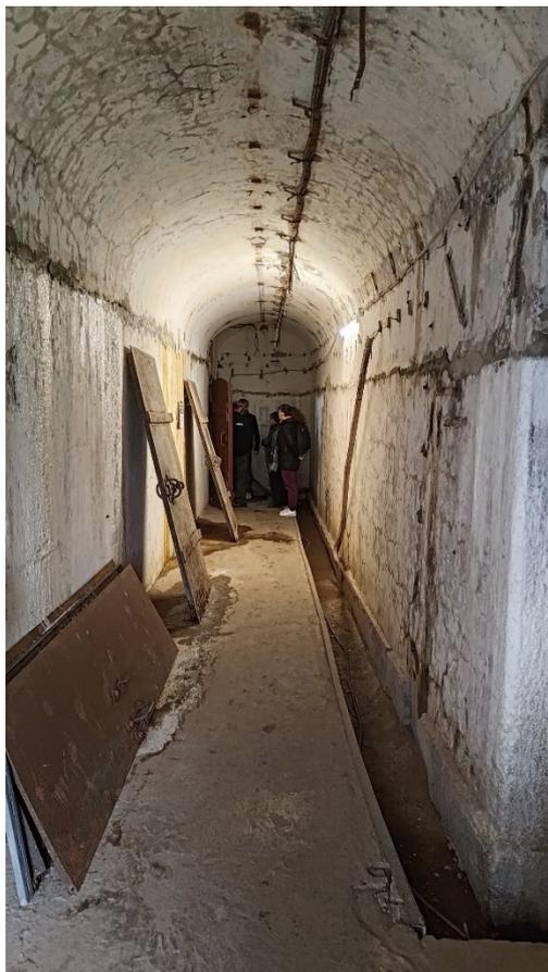
Фото 212. Коридор, соединяющий Главный калибр и опытные сооружения Свод – коробовый. Фрагмент. Дата фотофиксации: 06.10.24
