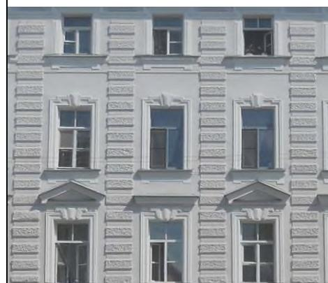
подоконный штукатурный профилированный карниз с металлическим покрытием в уровне второго этажа;
