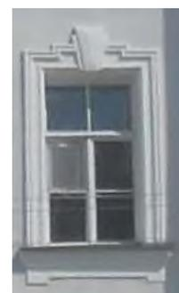
подоконный штукатурный профилированный карниз с металлическим покрытием в уровне четвертого этажа;
