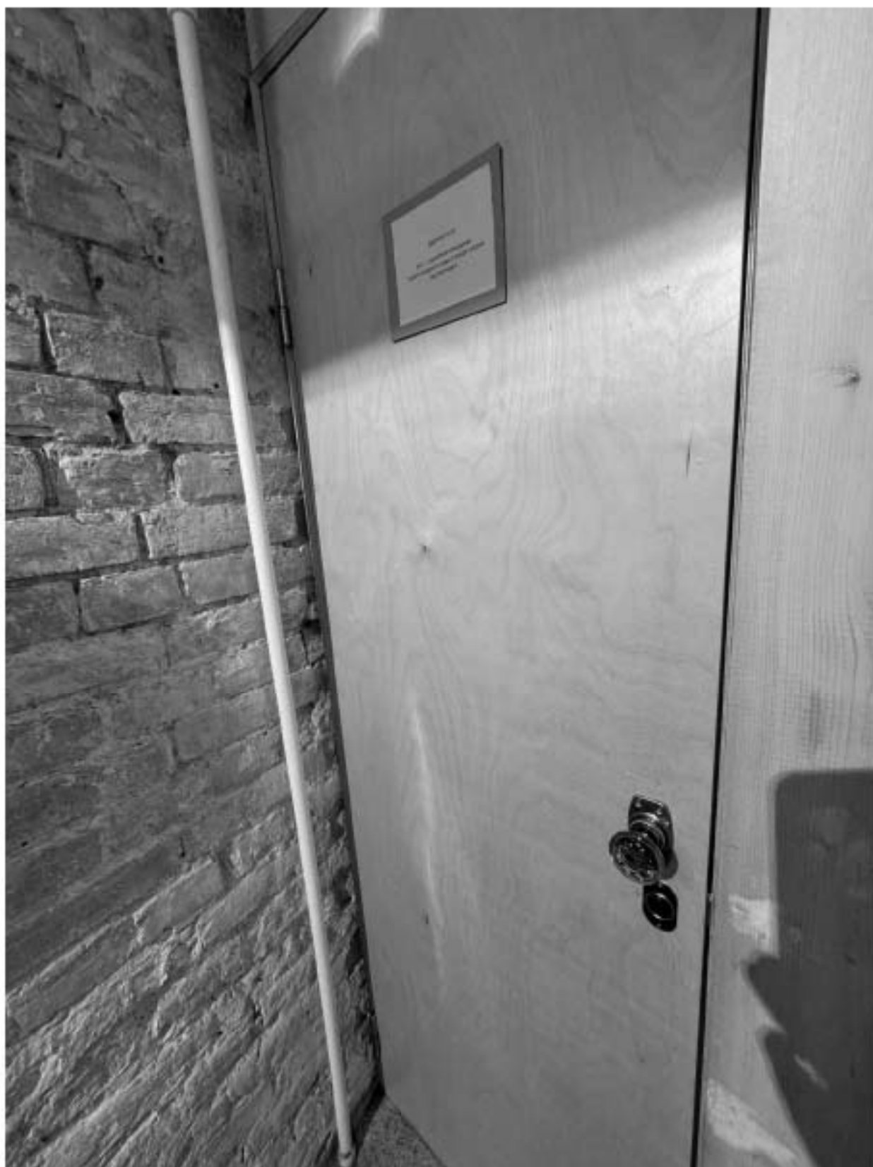
Фото 15. Интерьер помещения 35-Н объекта культурного наследия.
