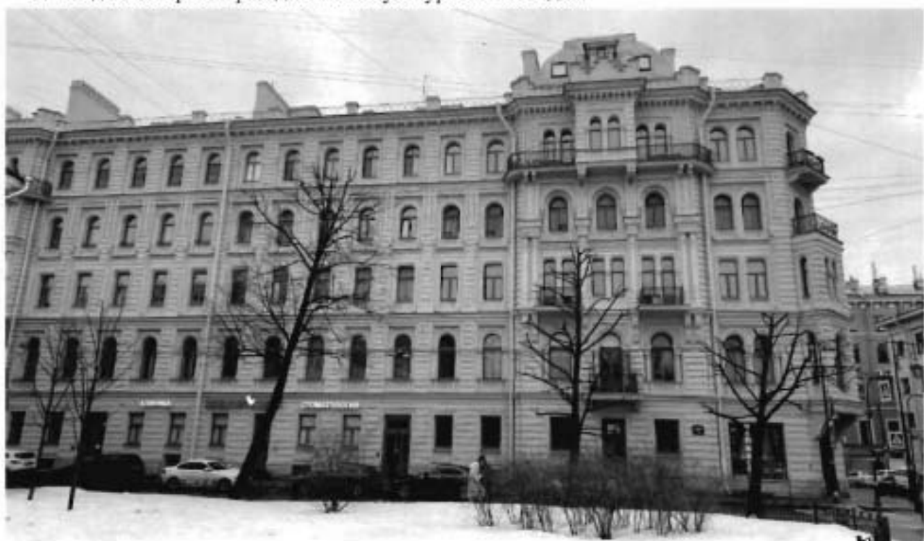
3. Вид на северный фасад объекта культурного наследия.
