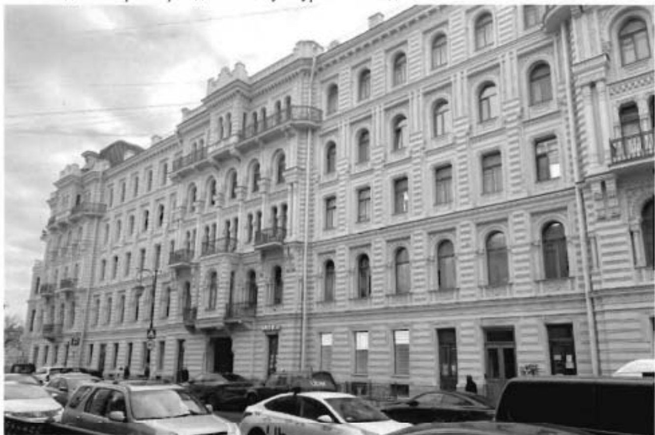
2. Вид на северный фасад объекта культурного наследия.
