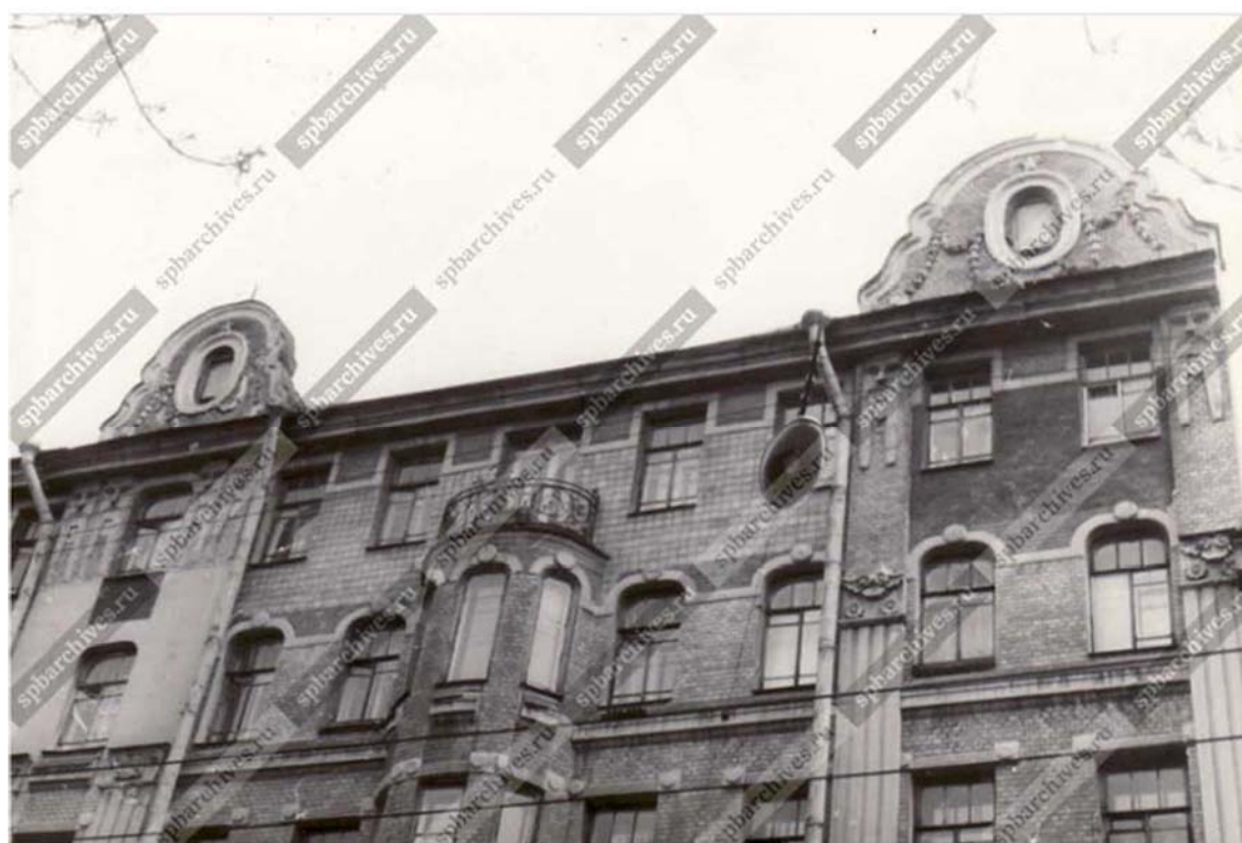
Илл. 12. Дом П.М. Станового. Западный фасад. Фрагмент. 1991 г. Источник: ЦГАКФФД СПб. Ар 214881.
