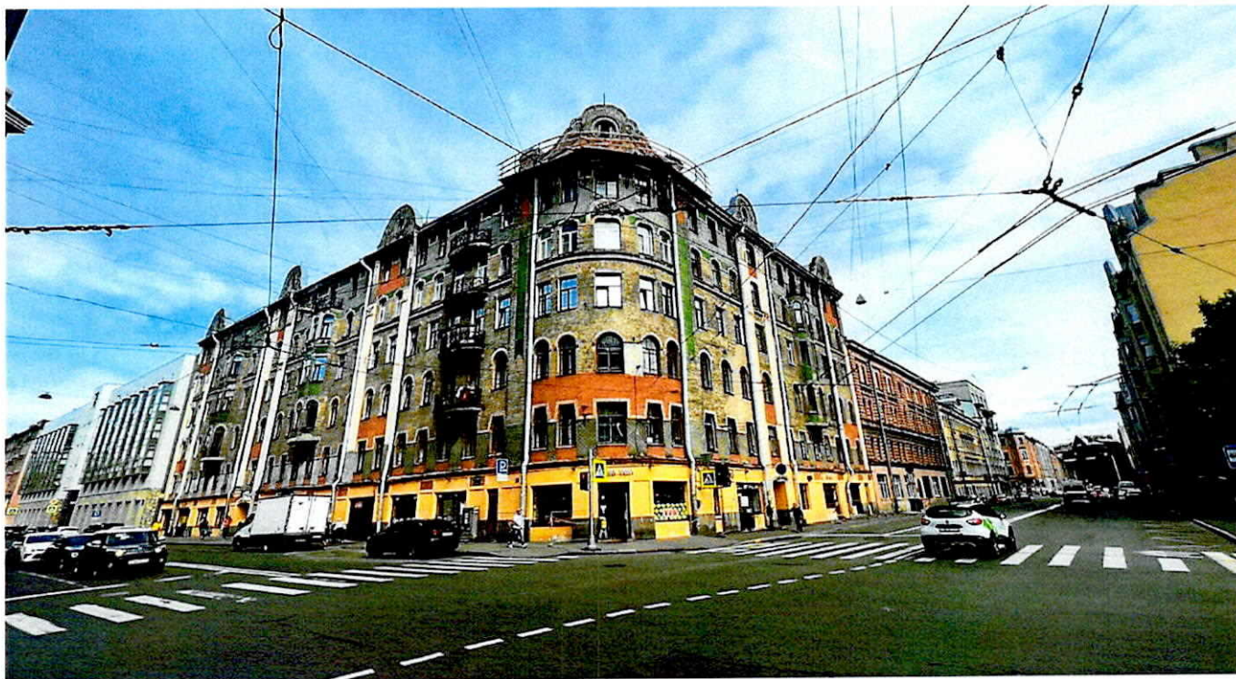
Фото 1 Общий вид объекта
