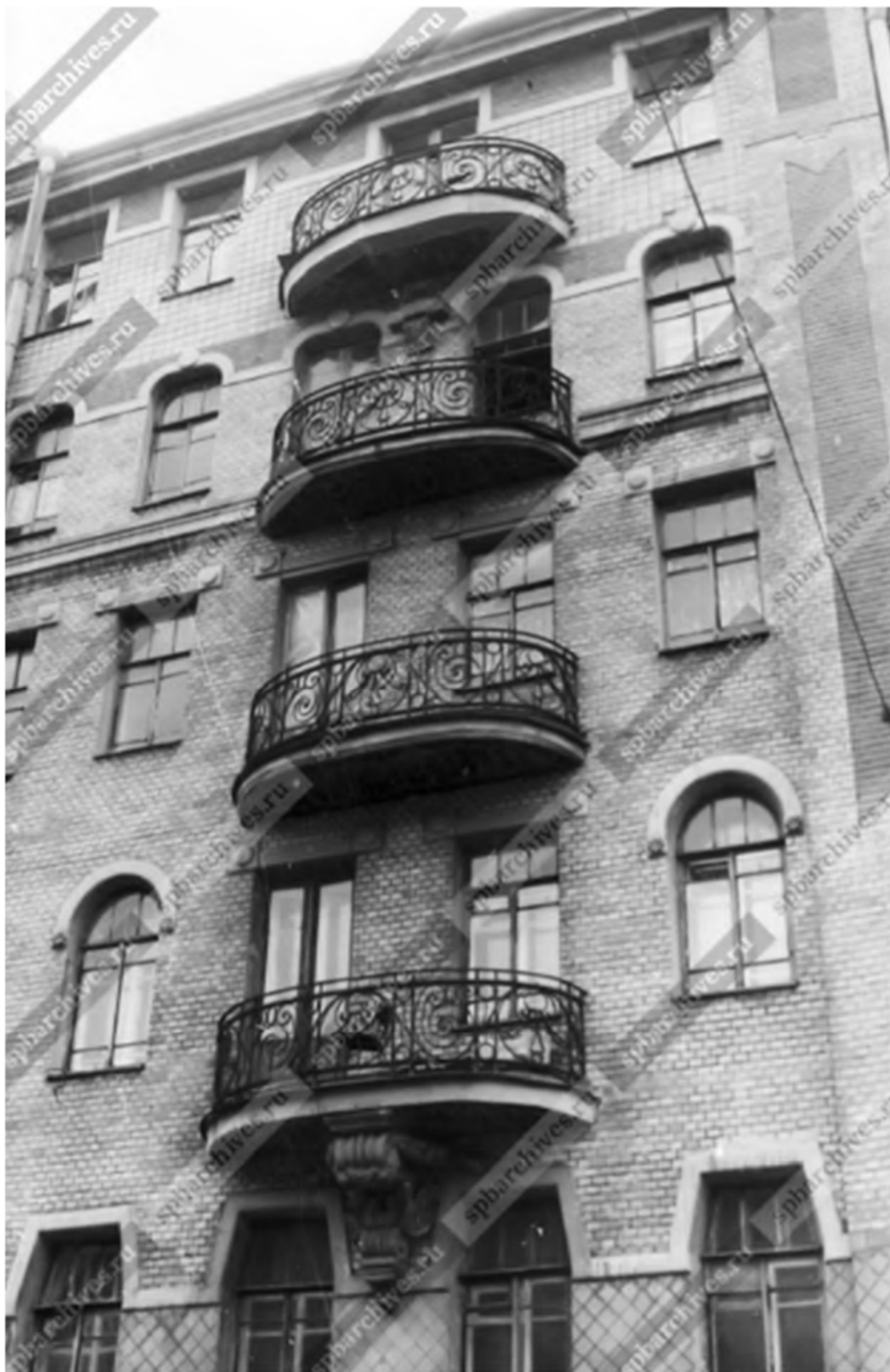
Илл. 14. Дом П. М. Станового. Западный фасад. Фрагмент. 1991 г. Источник: ЦГАКФФД СПб. Ар 225893.
