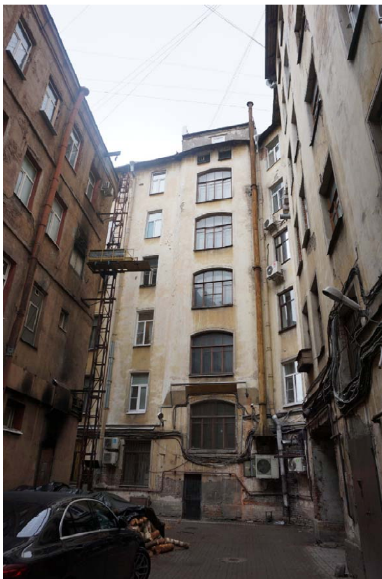
Фото №2. Дворовый фасад.
