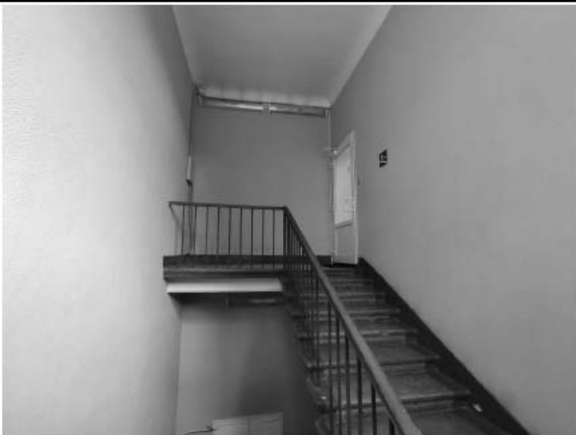
9. Общий вид верхней площадки лестницы в южной части корпуса по Софийскому бульвару (пом. 5-Н (24)).
