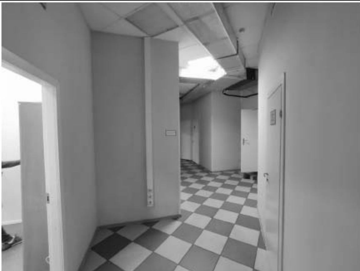
25. Фрагмент коридора (пом. 5-Н (17)).
