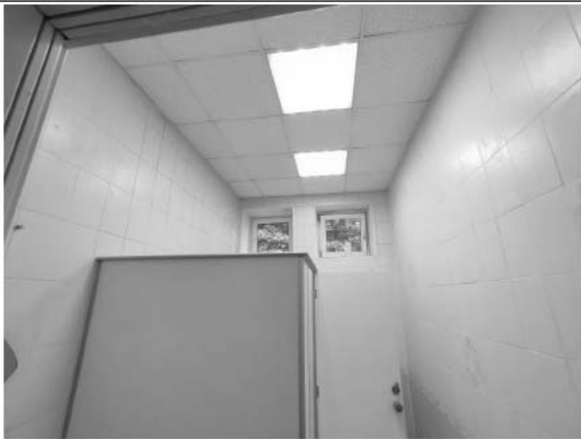
32. Общий вид пом. 5-Н (12).
