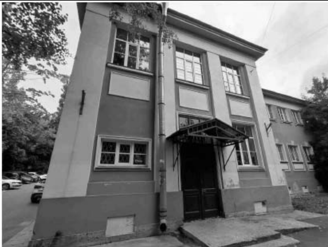
5. Общий вид ризалита на 3 световые оси в левой части лицевого фасада по Софийскому бульвару объекта культурного наследия регионального значения «Лазарет для офицеров».
