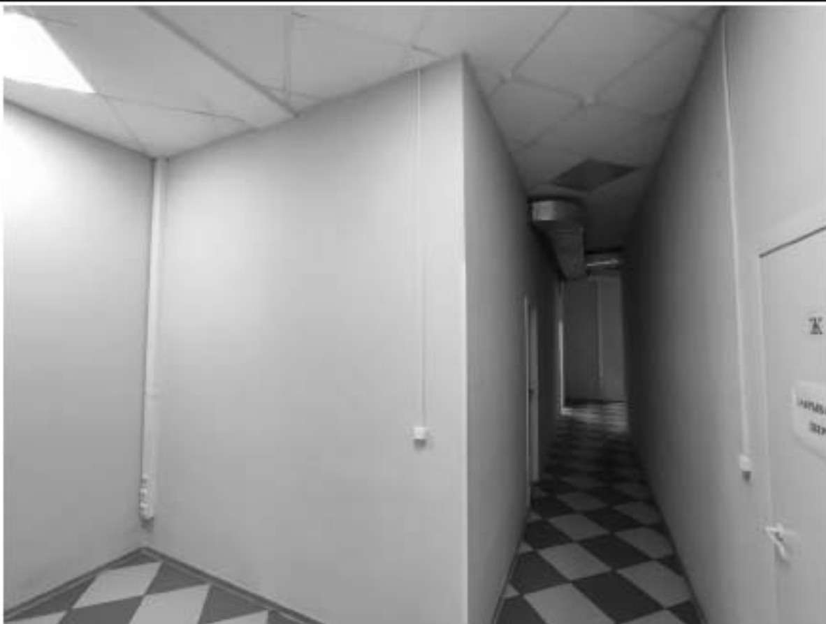
27. Фрагмент коридора (пом. 5-Н (17)).
