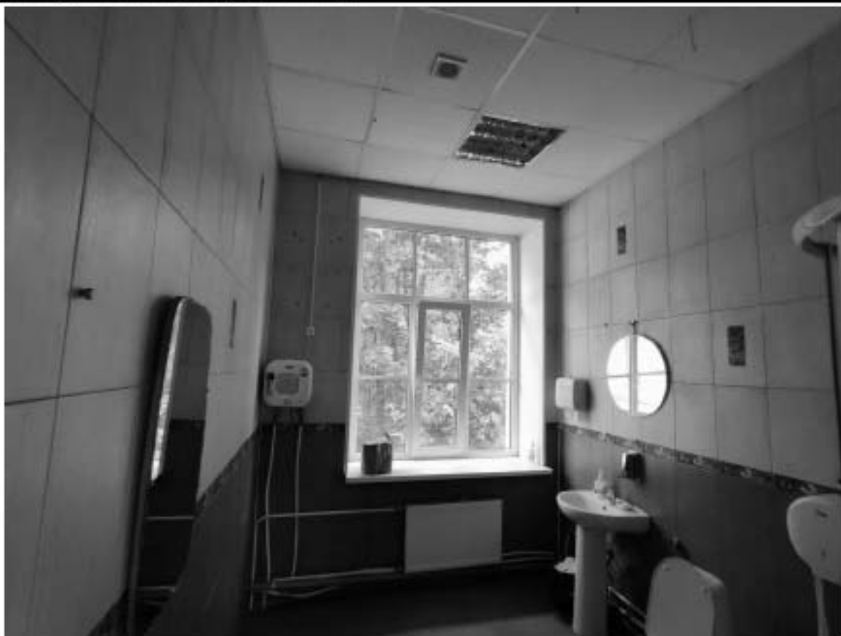
26. Общий вид пом. 5-Н (11).
