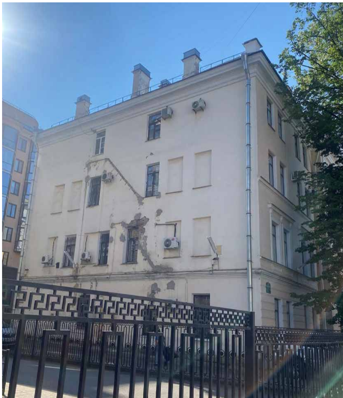
Фото 3, Фрагмент южного фасада
