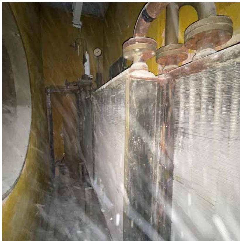
Фото 19. Чердак, вентиляционная камера
