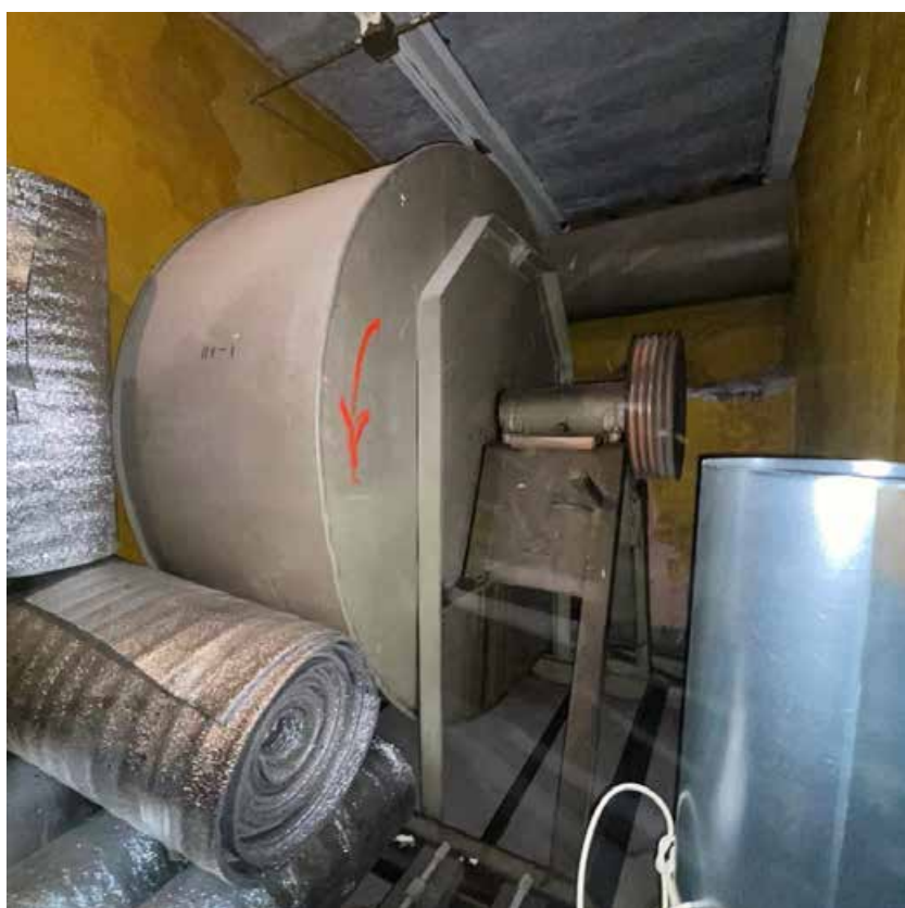
Фото 20. Чердак, вентиляционная камера
