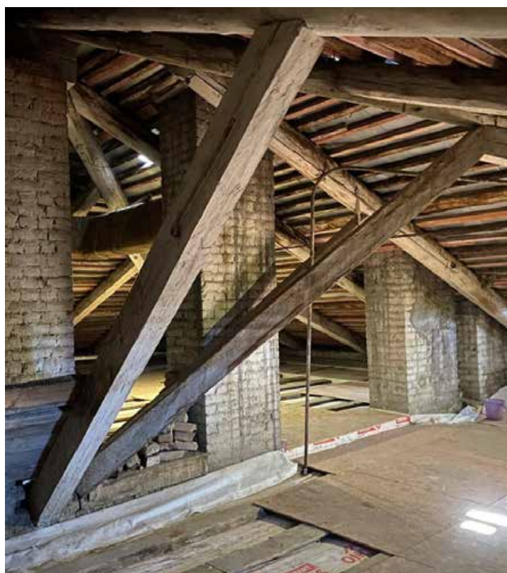
Фото 18. Чердак, стропильная система
