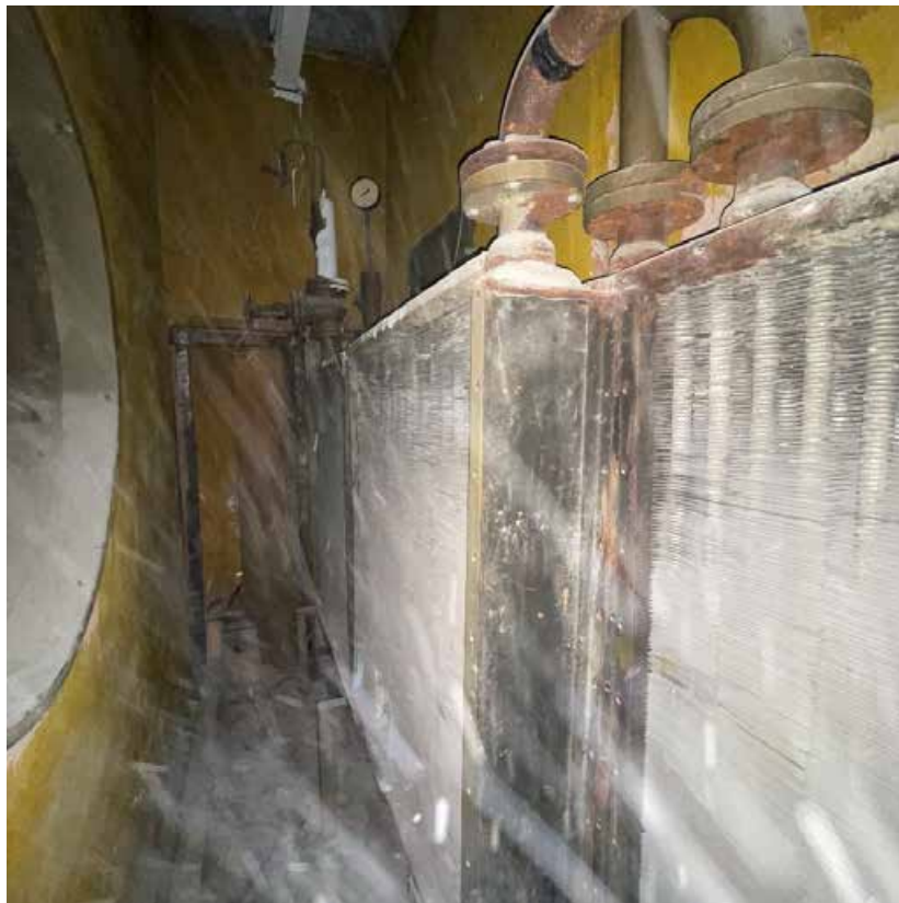
Фото 19. Чердак, вентиляционная камера
