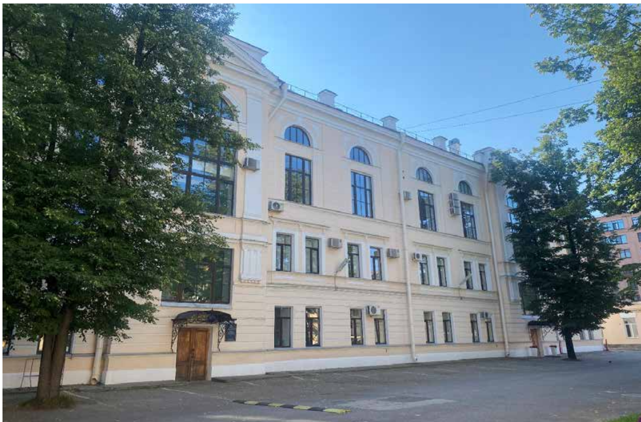
Фото 1, Фрагмент западного фасада
