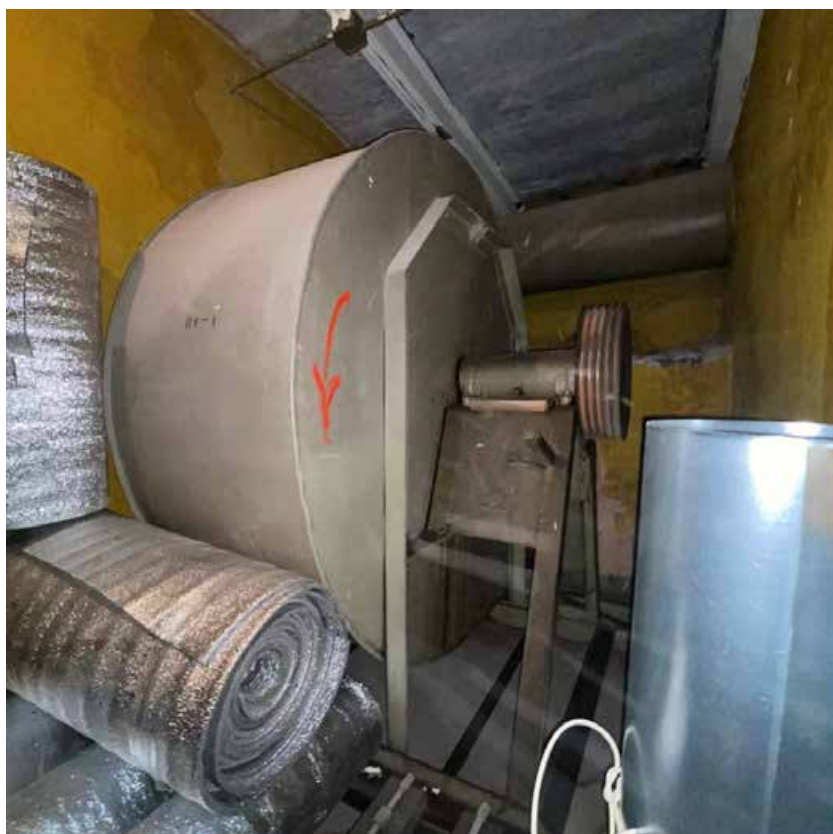
Фото 20. Чердак, вентиляционная камера
