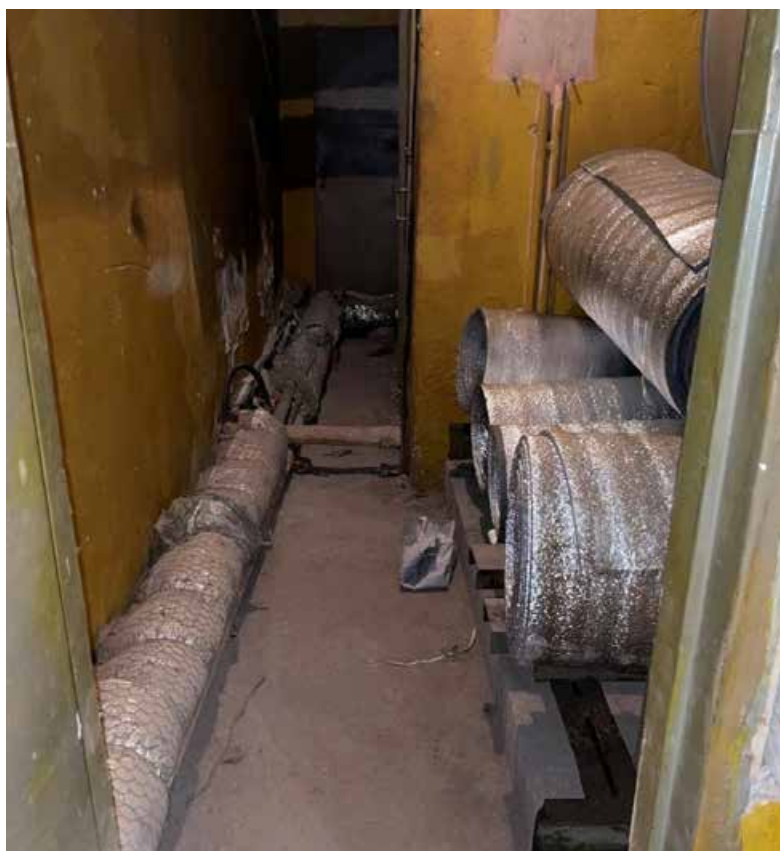
Фото 14. Чердак, вид на проход в вентиляционную камеру
