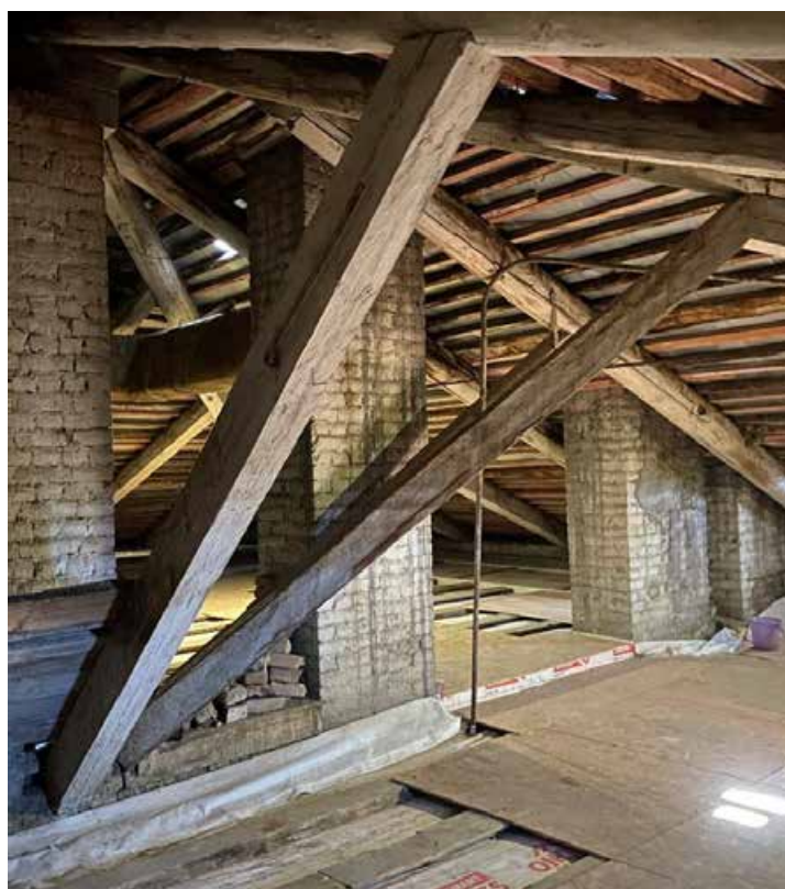
Фото 18. Чердак, стропильная система
