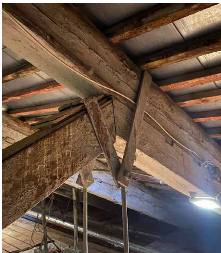
Фото 4. Чердак, опирание металлической стяжки стропильной ноги на скобу
