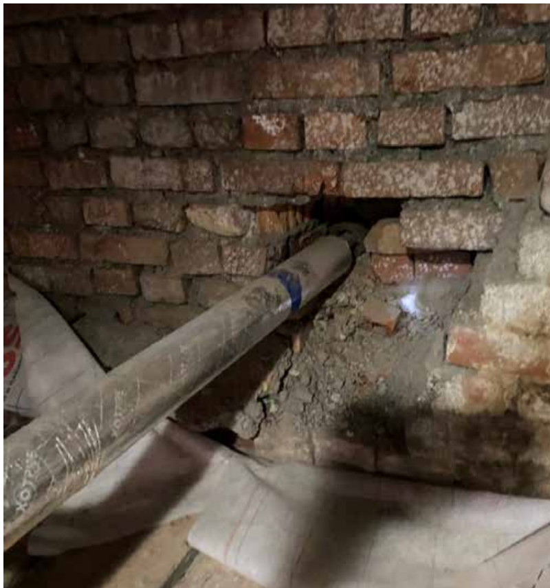
Фото 13. Чердак, проход инженерных коммуникаций через вентиляционную камеру
