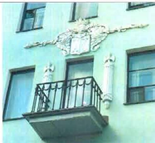
профилированная тяга между 1-м и 2-м этажами; профилированная тяга с гладким фризом и листовым орнаментом над оконными проемами 4-го этажа;
