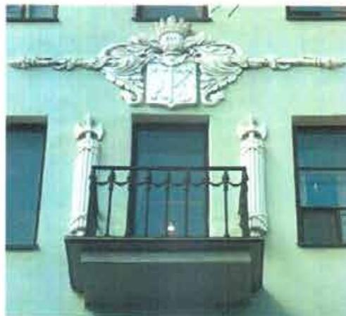
ограждение балкона – материал (металл), рисунок (вертикальные стойки со стрельчатым завершением);
