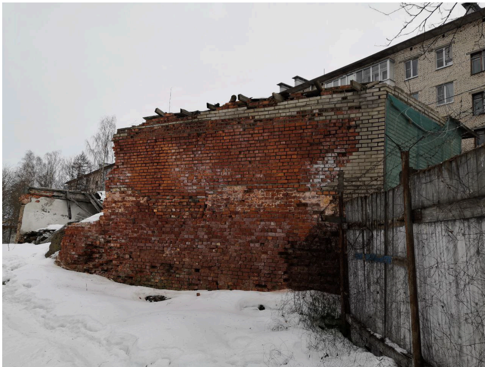
4. Фрагмент южного фасада здания по адресу: Санкт-Петербург, г. Ломоносов, Владимирская улица, д. 27а, литера Б.
