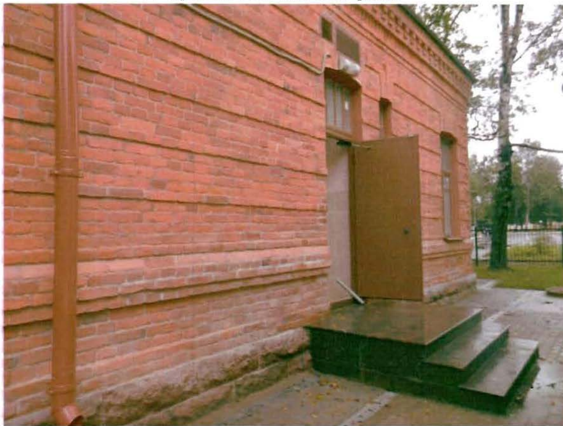
7. Фрагмент восточной части фасада
