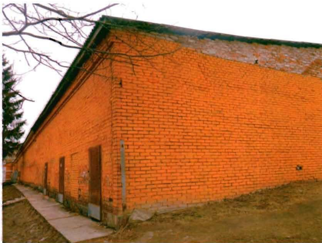
25. Фрагмент юго-западной части фасада
