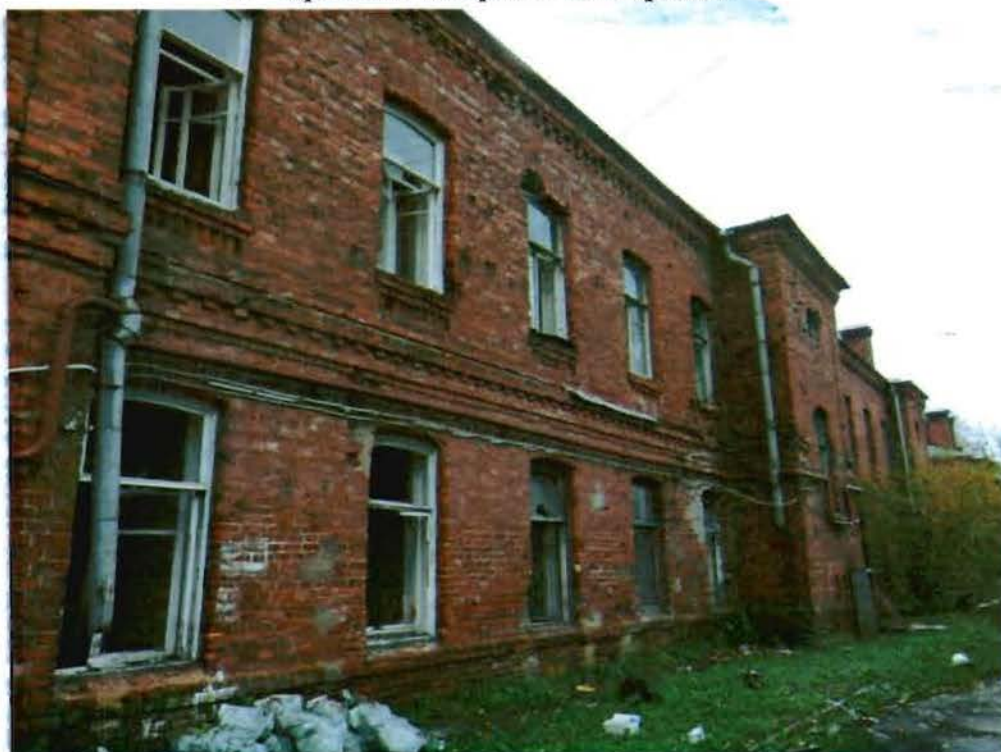
2. Фрагмент северной части фасада
