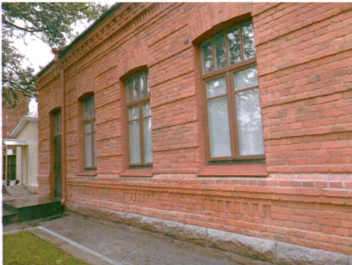
8. Фрагмент северной части фасада
