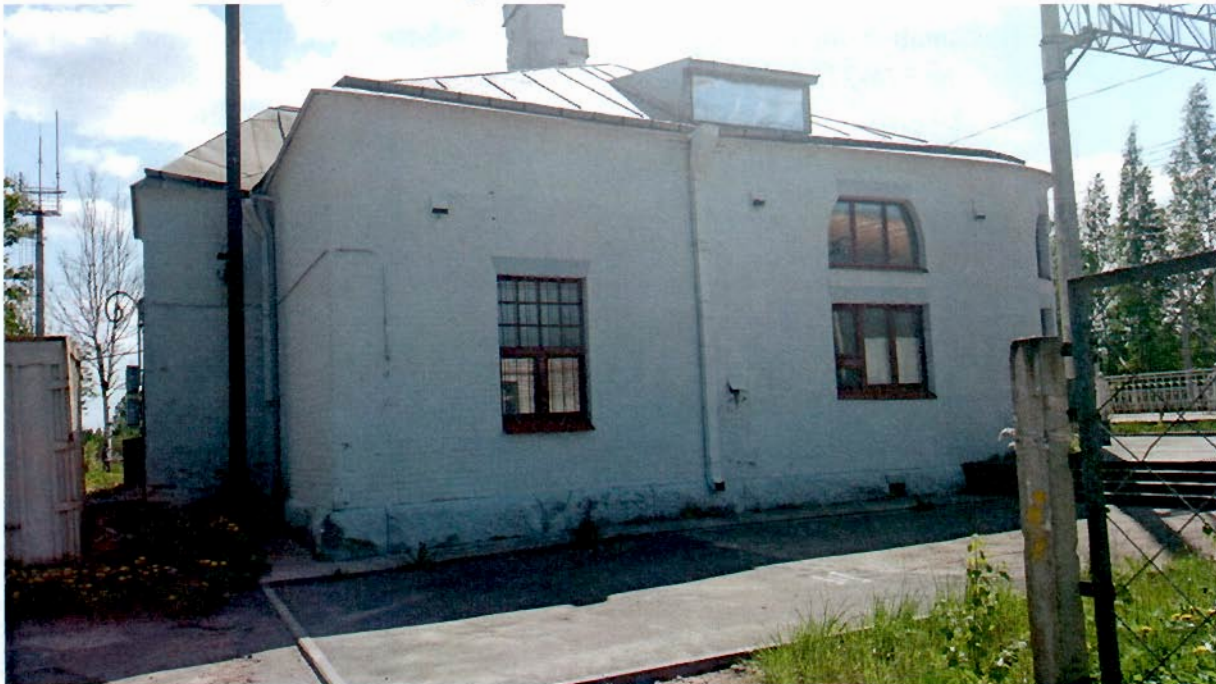
3. Здание вокзала (западный фасад).
