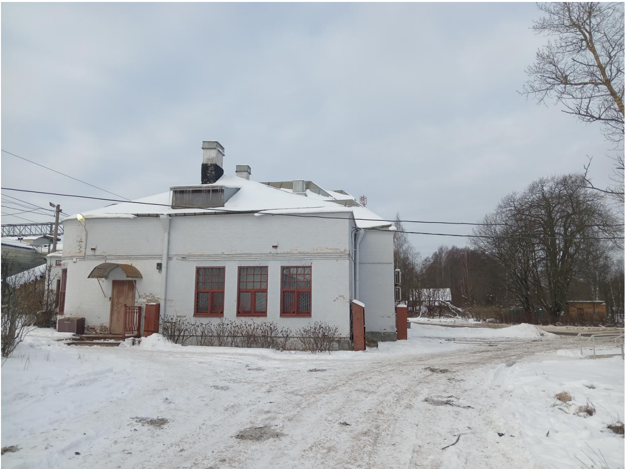
Фото 5. Юго-восточный фасад. Вокзал. Санкт-Петербург, пос. Левашово, Железнодорожная ул., д.7, литера А.
