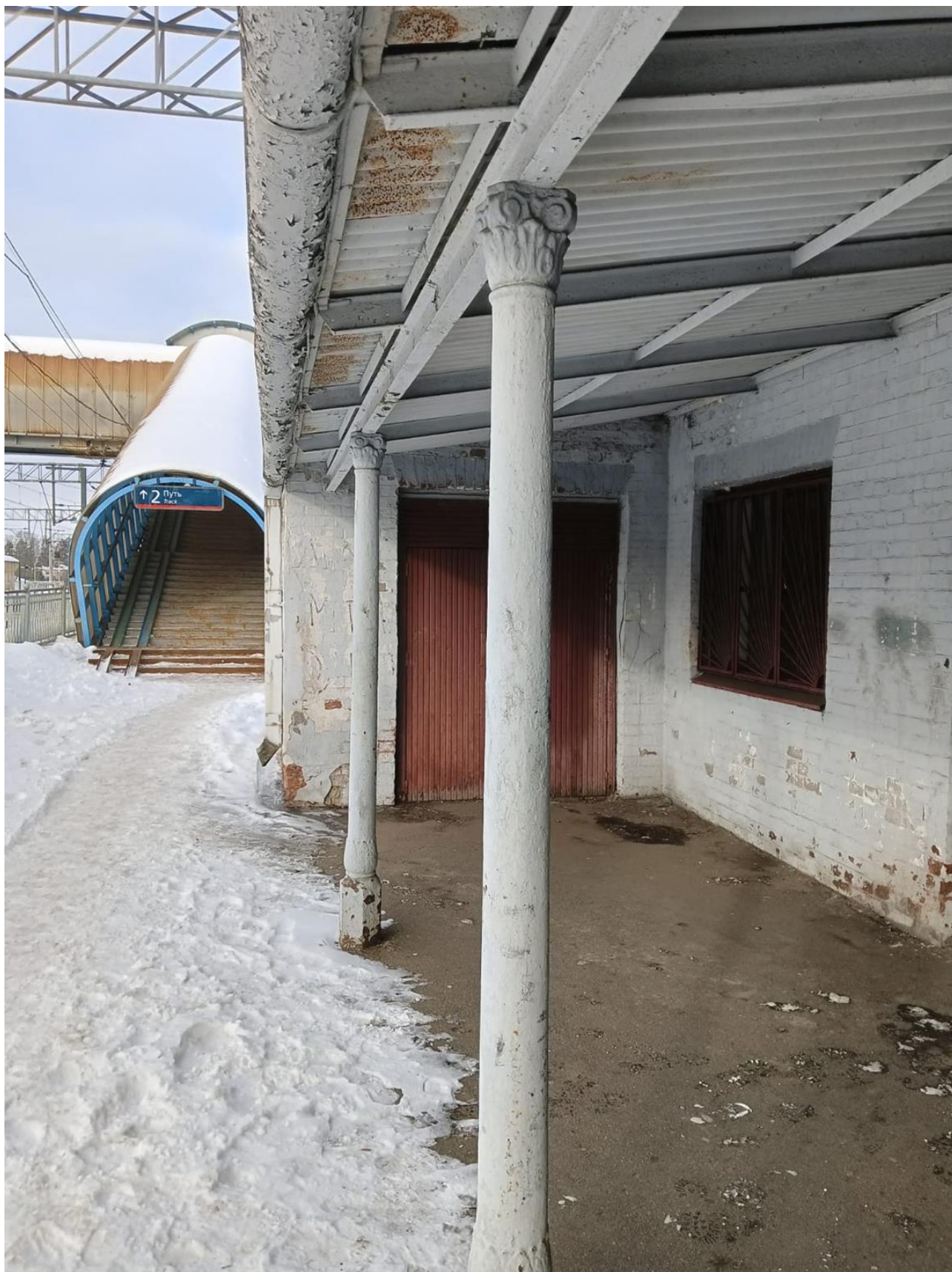
Фото 4. Фрагмент северо-западного фасада. Металлический козырек над главным входом. на металлических балках с двумя литыми опорными столбами со стилизованными капителями и базами Вокзал. Санкт-Петербург, пос. Левашово, Железнодорожная ул., д.7, литера А.
