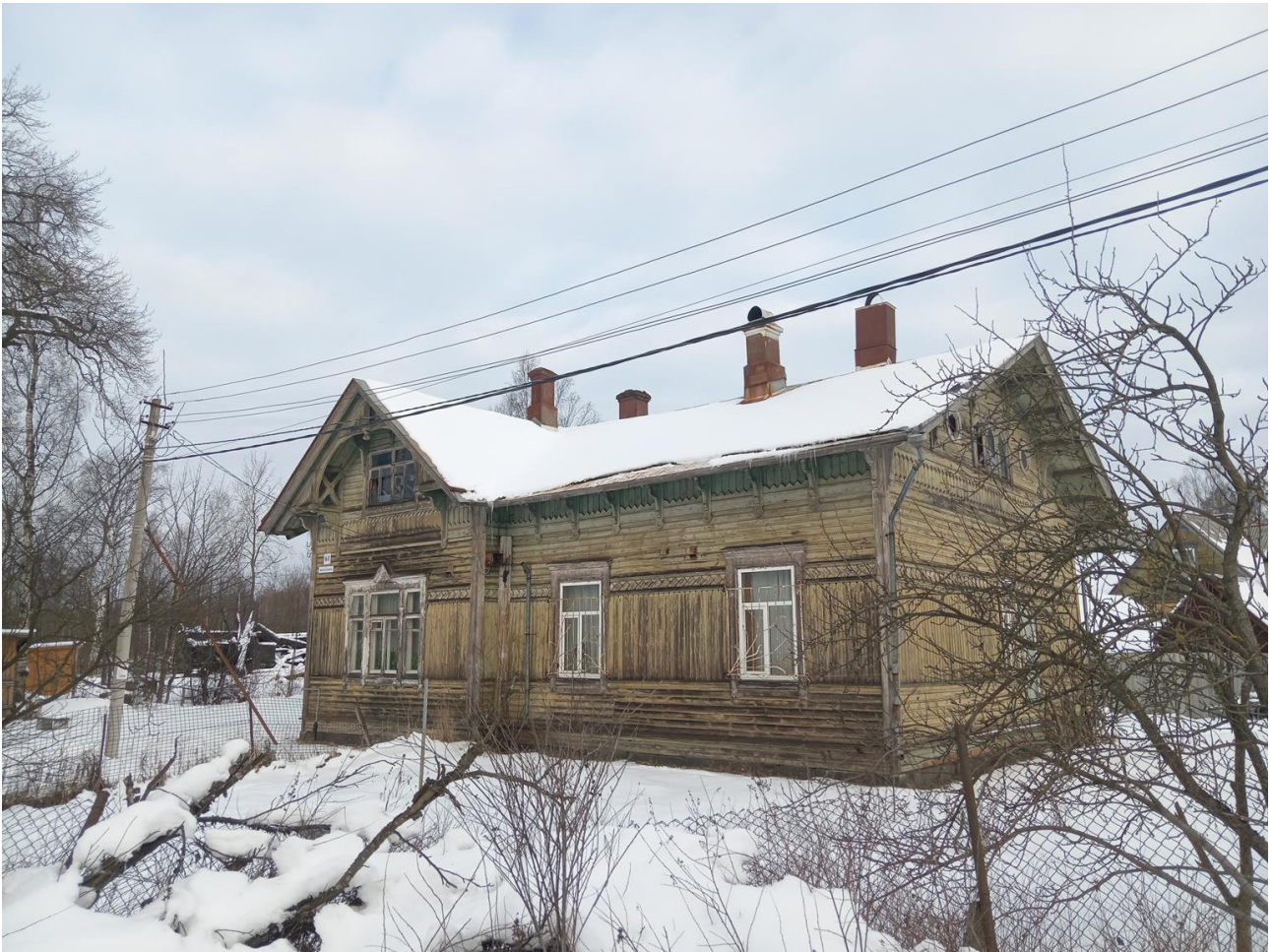
Фото 9. Юго-западный и юго-восточный фасад жилого дома. Санкт-Петербург, пос. Парголово, Осиновая роща, Вокзальное шоссе, д. 61, литера А.
