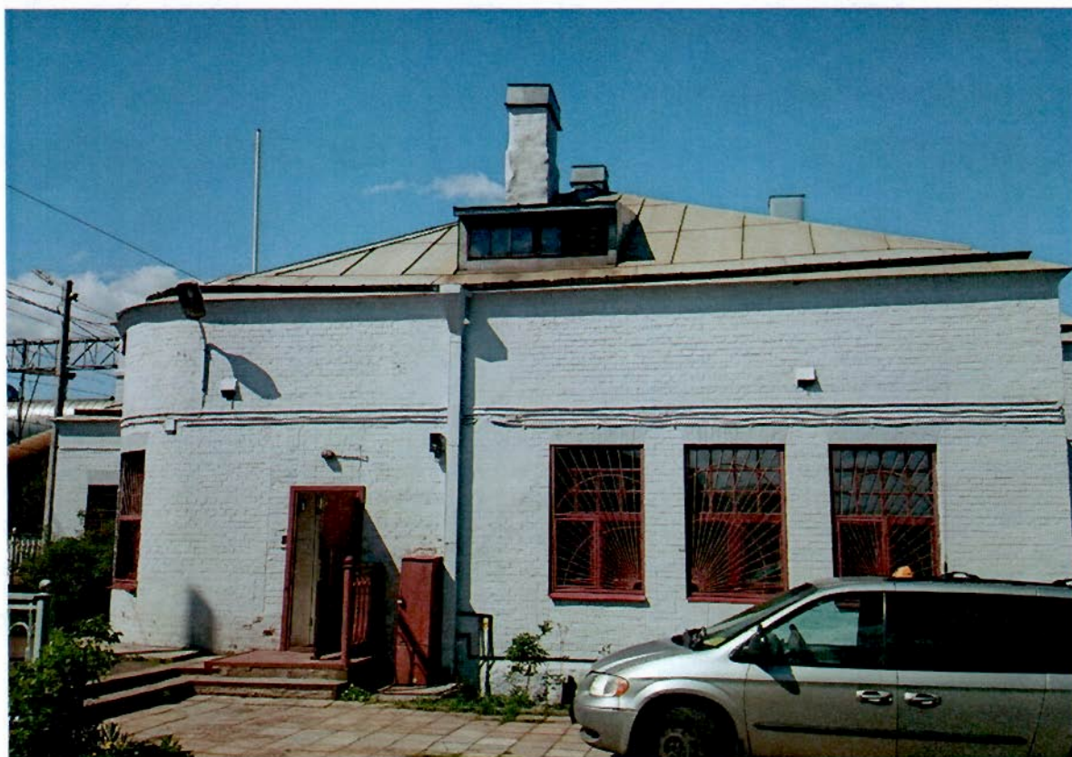
4. Здание вокзала (восточный фасад).
