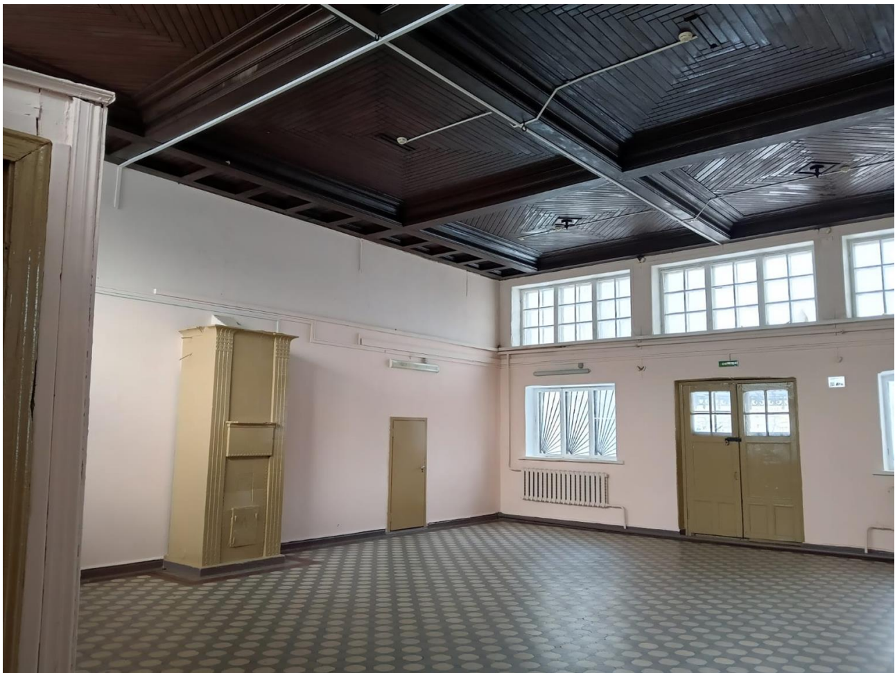
Фото 7. Зал ожидания. вид на северо-западную часть. Вокзал. Санкт-Петербург, пос. Левашово, Железнодорожная ул., д.7, литера А.
