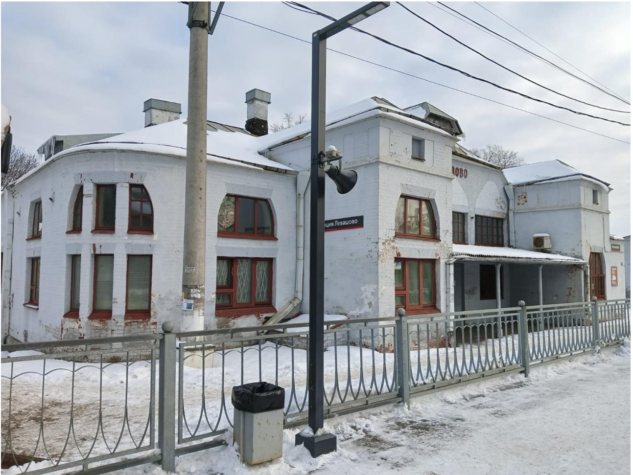
Фото 3. Северо-западный и юго-западный фасад. Вокзал. Санкт-Петербург, пос. Левашово, Железнодорожная ул., д.7, литера А.
