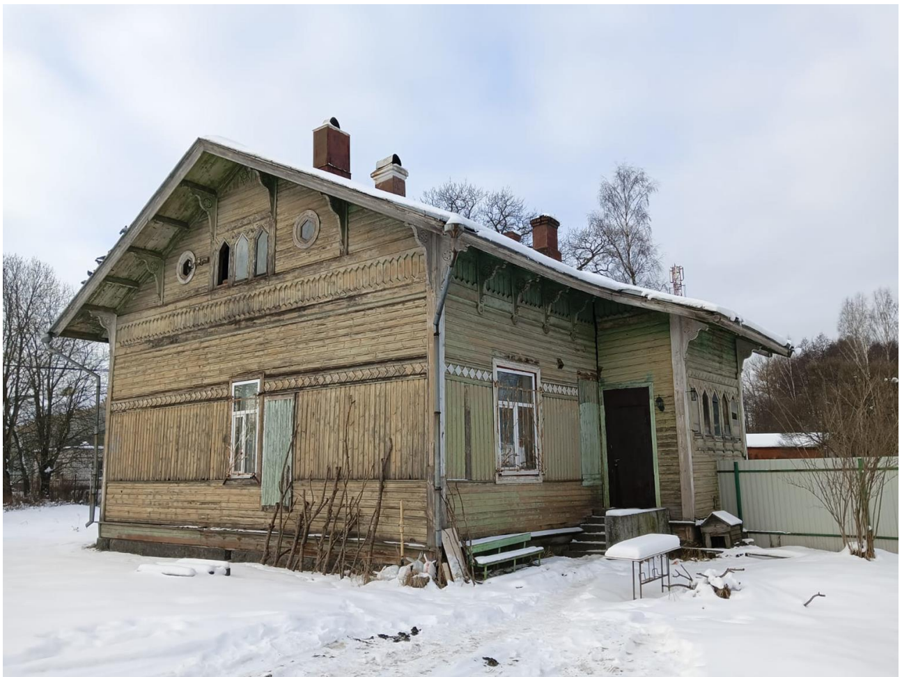
Фото 10. Юго-восточный и северо-восточный фасад жилого дома. Санкт-Петербург, пос. Парголово, Осиновая роща, Вокзальное шоссе, д. 61, литера А.
