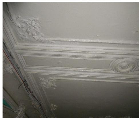
оформление подъезда дворового корпуса выполнено в приемах, близких оформлению подъезда лицевого корпуса; межэтажная лестница известняковой плиты на косоурах, с металлическим ограждением; лепная отделка потолка: профилированная тяга по периметру, филенки геометрического характера с «вынутыми» углами и профилем по периметру;
