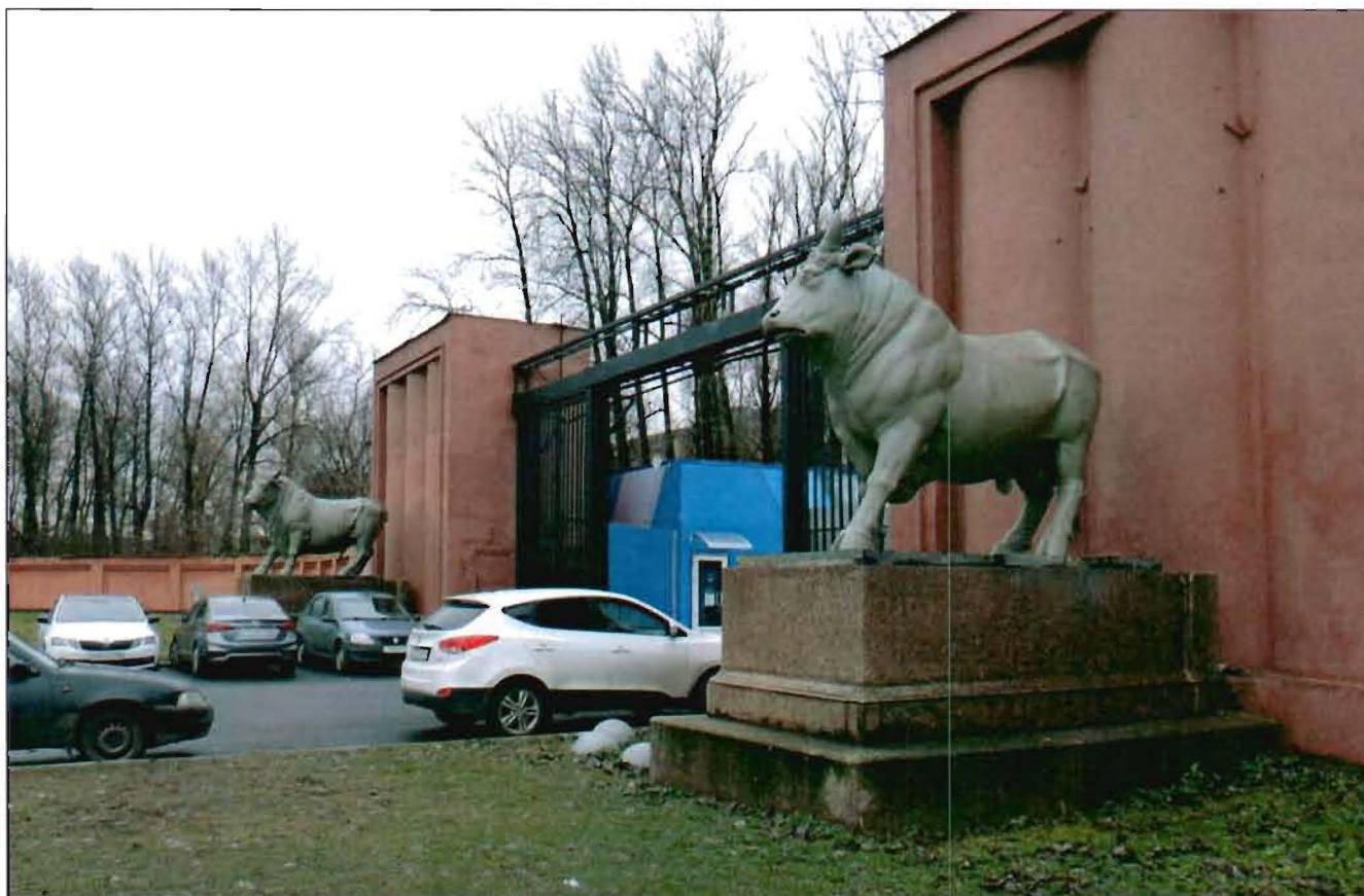
1. Общий вид с севера.
