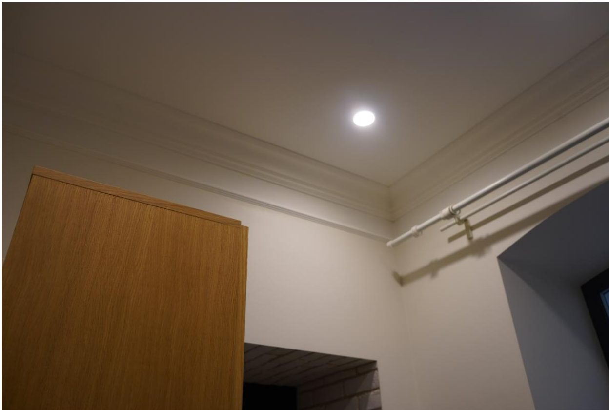
7. Квартира №13. Фрагмент карнизных тяг потолка в прихожей.
