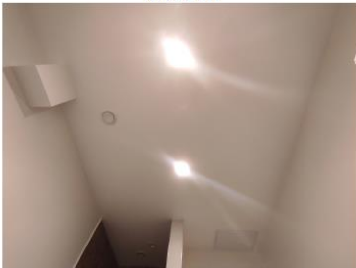
Совмещенный санузел площадью 6,0 м 2 . Потолок.
