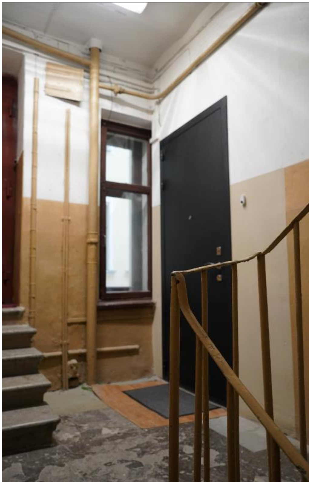
5. Площадка лестничной клетки объекта культурного наследия регионального значения «Дом А.П. Романова», расположенного по адресу: г. Санкт-Петербург, Солдатский переулок, д. 1/23, литера А. Дверь в квартиру №13.
