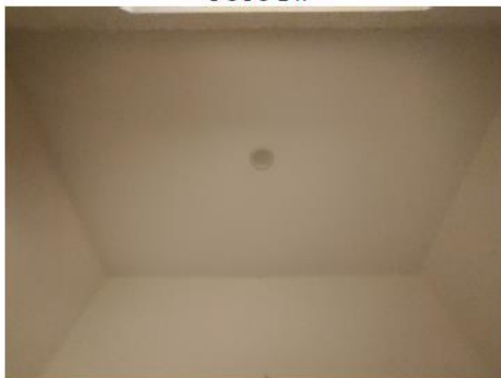
Встроенный шкаф площадью 2,6 м². Потолок.
