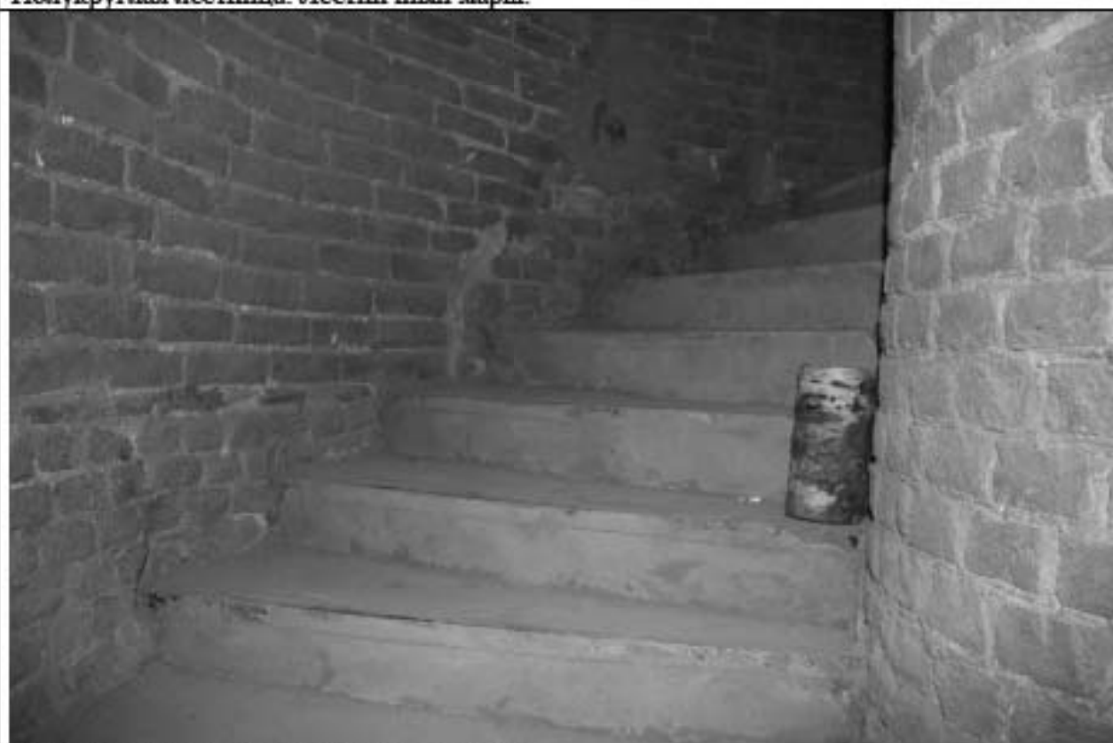
Полукруглая лестница. Лестничный марш.
