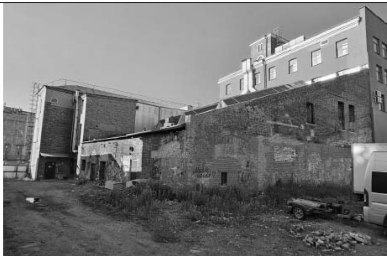
Здание котельной. Вид с юго-запада.
