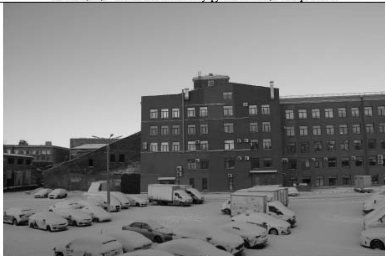
Здание Новой Бумагопрядильни. Фрагмент южного фасада с переходом из Прядильного корпуса в западный флигель (утрачен) и котельной (слева). Январь 2025 г.
