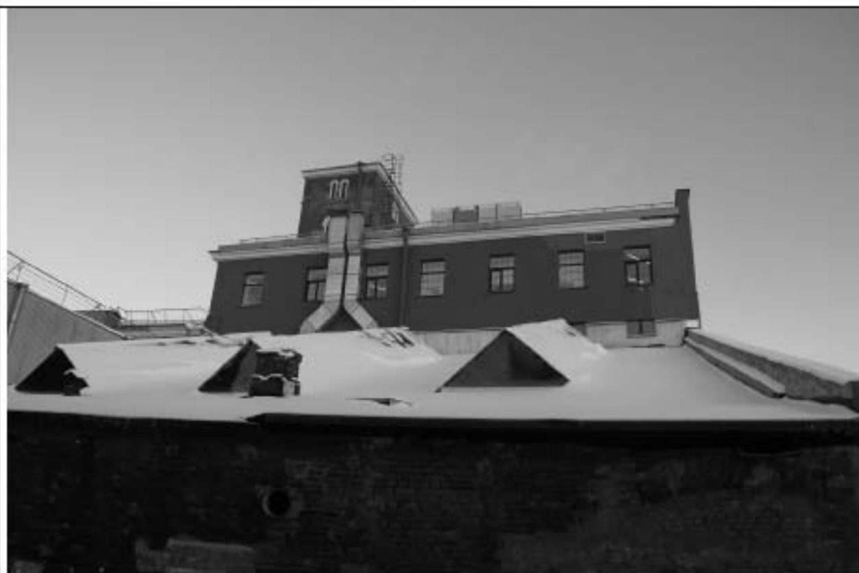
Кочегарка и Прядильный корпус. Западный фасад. Январь 2025 г.
