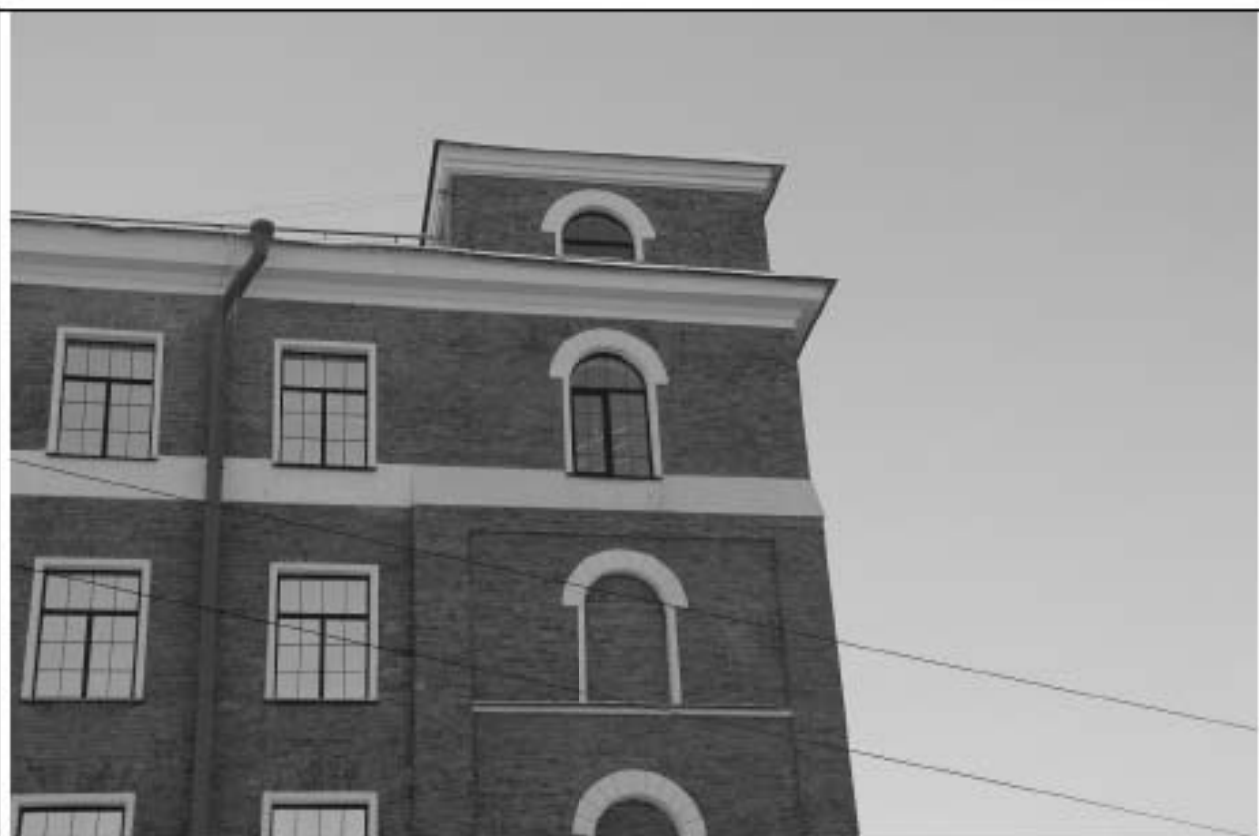
Прядильный корпус. Ризалит с лестничной клеткой.
