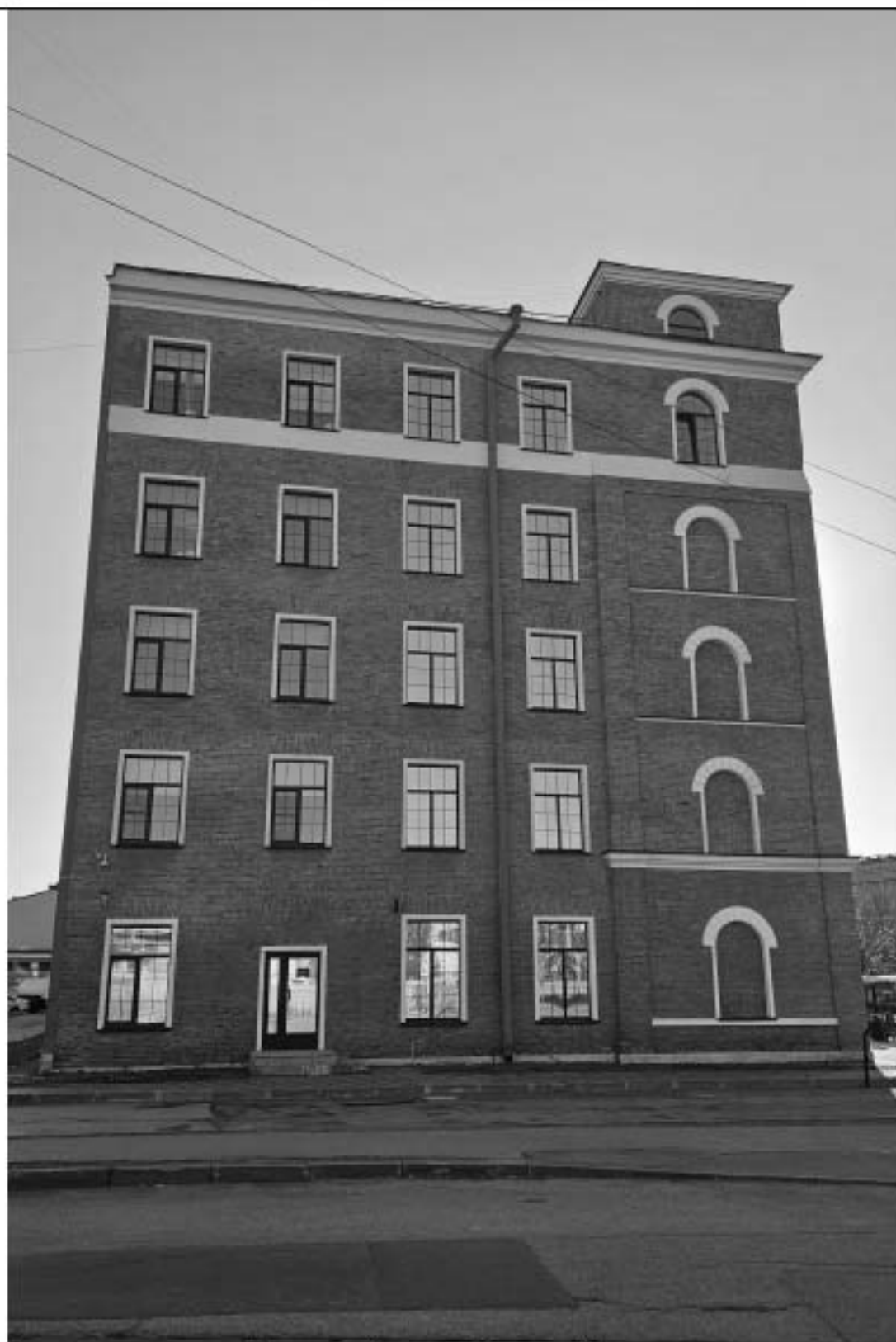
Прядильный корпус. Восточный фасад.
