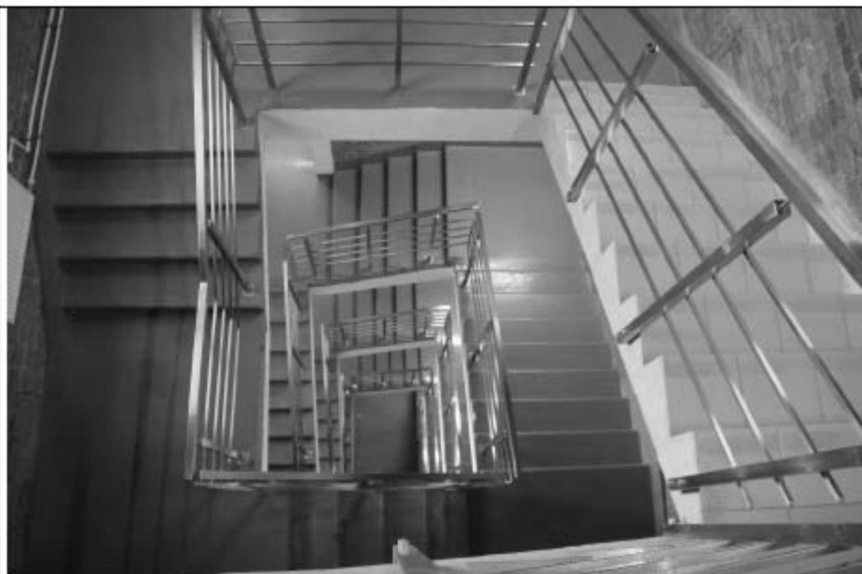
Западная лестница с выходом в башню. Вид сверху.
