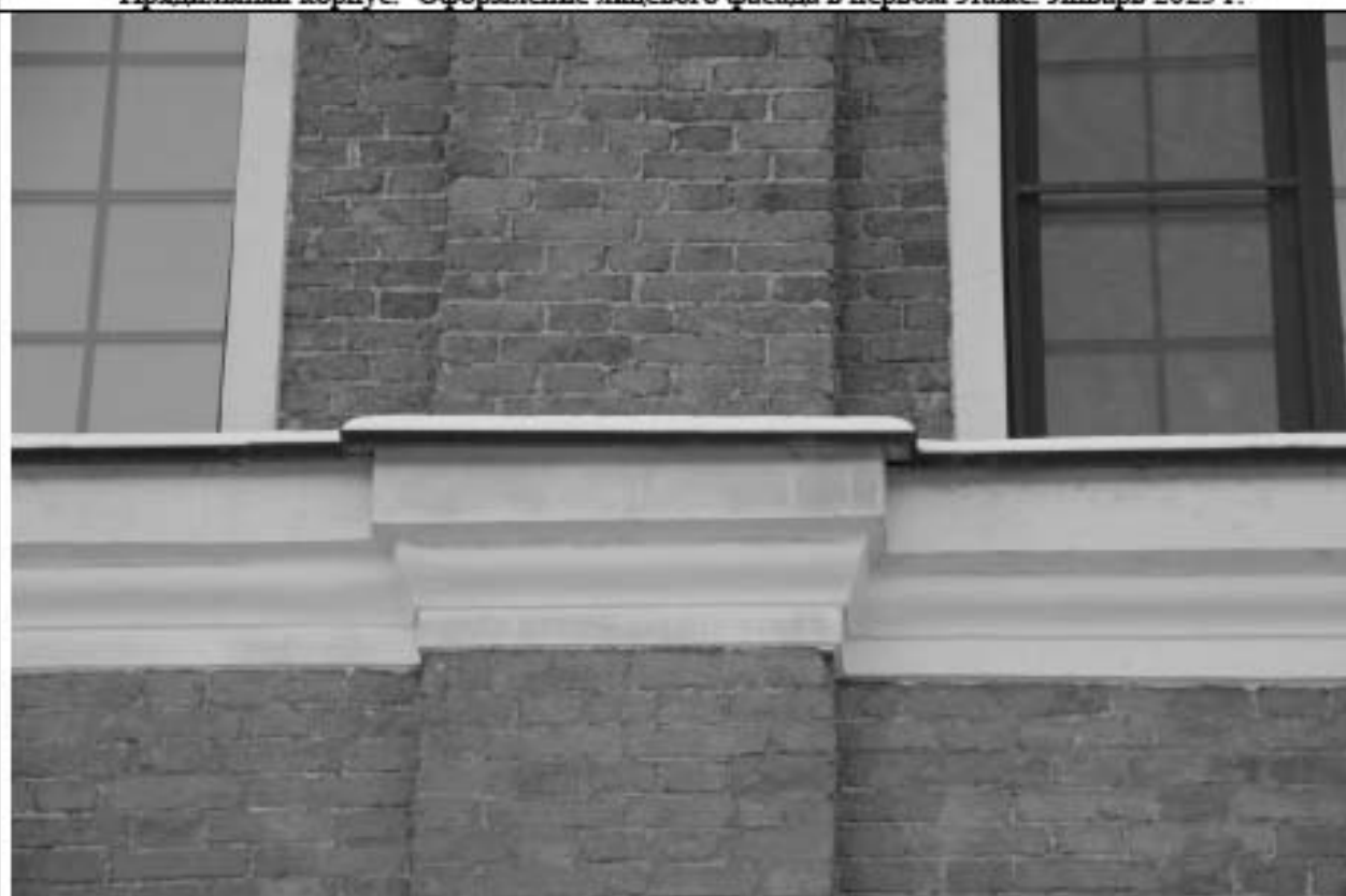
Прядильный корпус. Лицевой фасад. Лопатка ризалита и профилированный подоконный карниз второго этажа.
