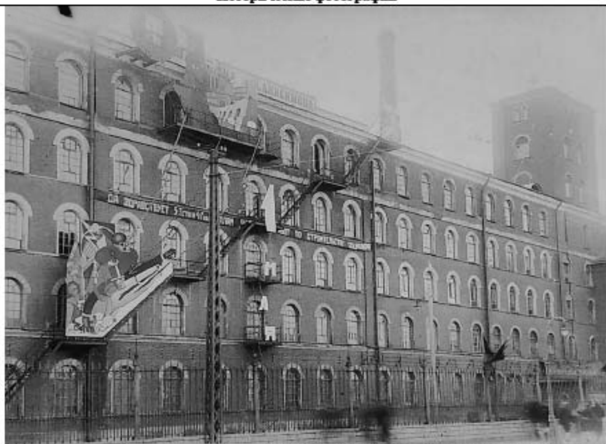
1932 г. Прядильный пех. Лицевой фасад. ЦГАКФФД ГР 19735.; ГМИ СПб Инв.№-П-Б-41915 ф.
