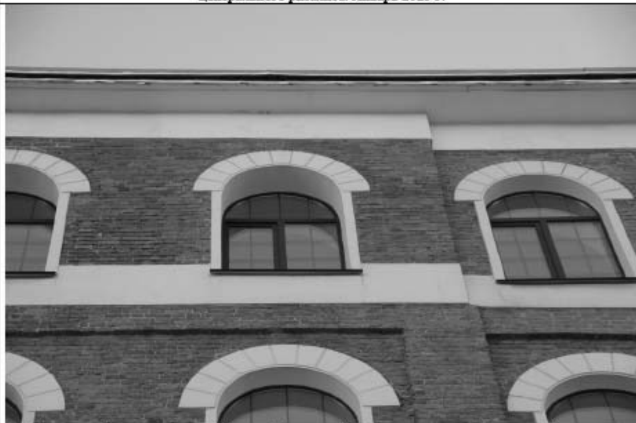
Прядильный корпус. Лицевой фасад. Подоконный фриз пятого этажа. Венчающий карниз с фризом. Январь 2025 г.
