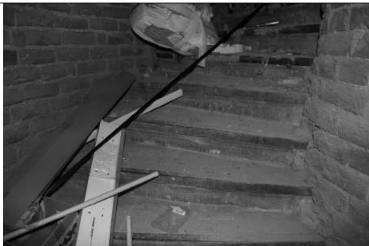
Полукруглая лестница. Лестничный марш.
