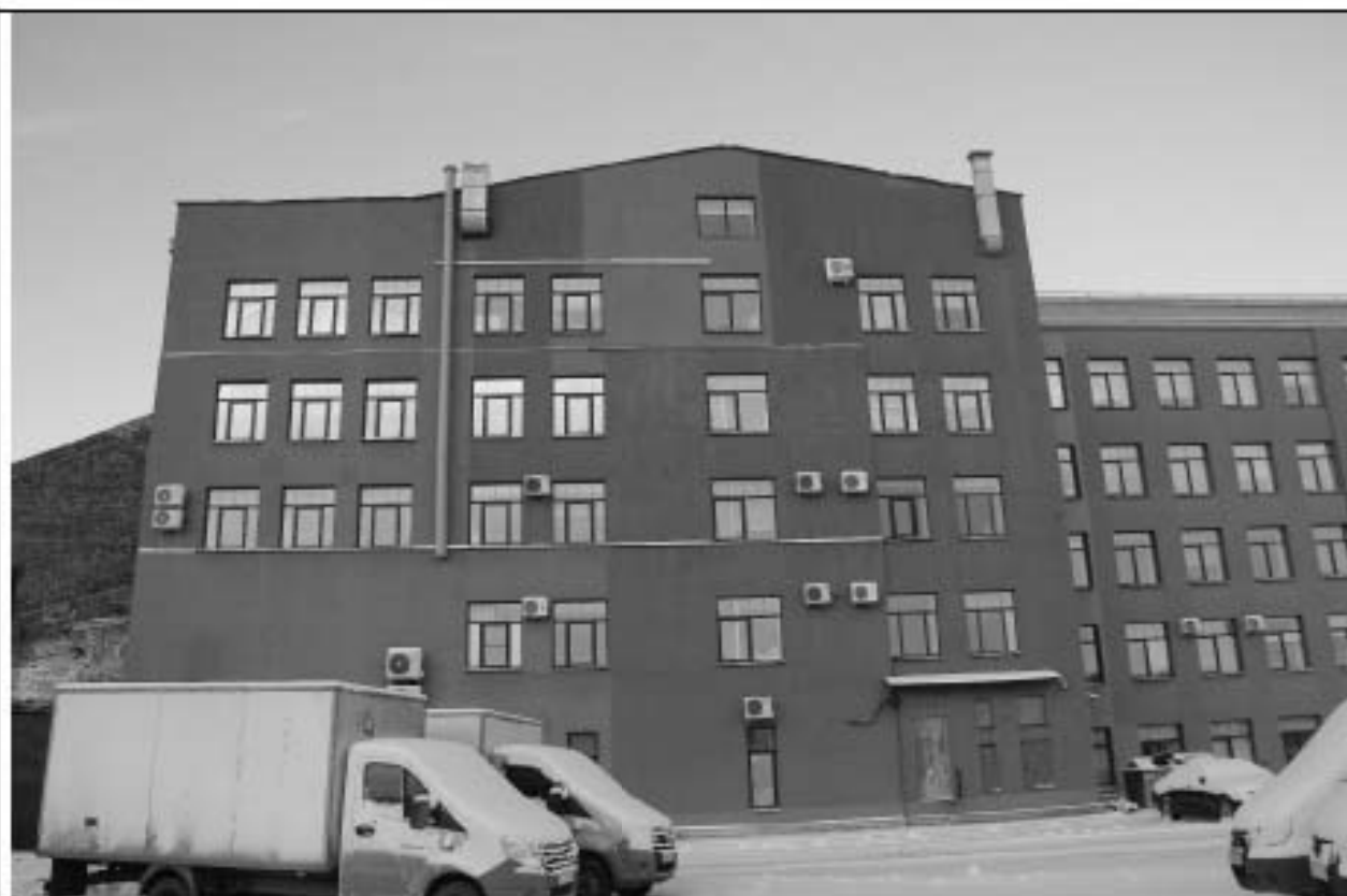
Прядильный корпус. Переход из лицевого корпуса в западный флигель (утрачен). Южный фасад. На оси шпильца – лестничная клетка полукруглой лестницы. Январь 2025 г.
