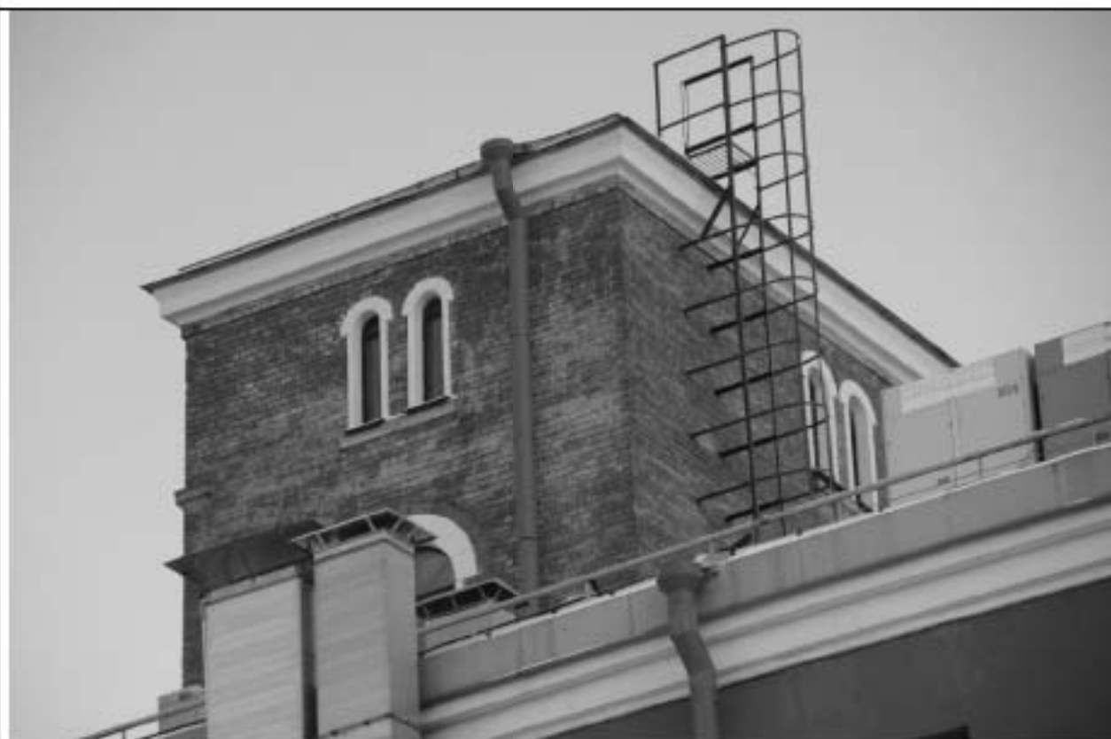
Водонапорная башня. Вид с юго-запада. Январь 2025 г.
