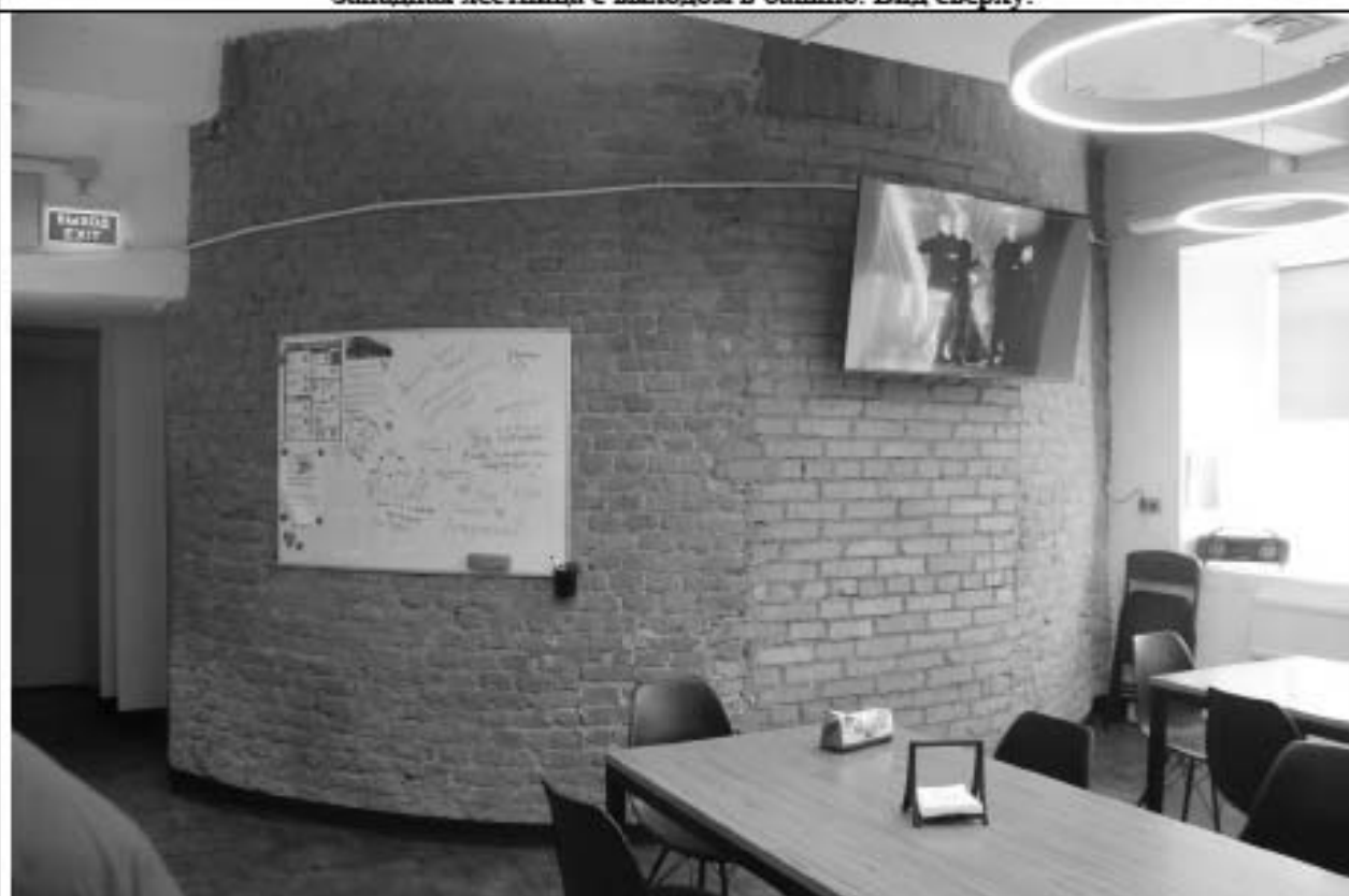
Полукруглая лестница. Стена лестничной клетки. Вид с запада.
