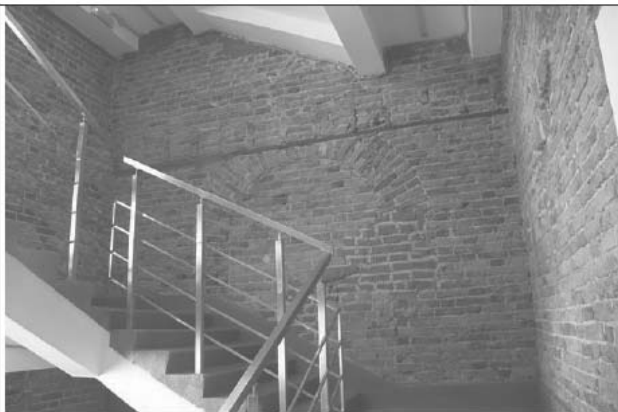
Восточная лестница. Заложенный проем.
