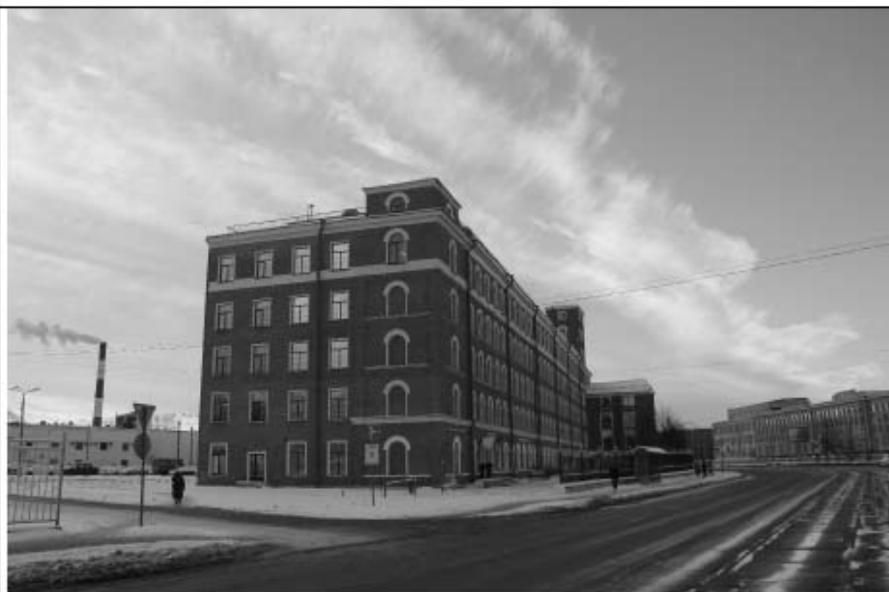
Здание Новой Бумагопрядильни. Вид с востока. Январь 2025 г.
